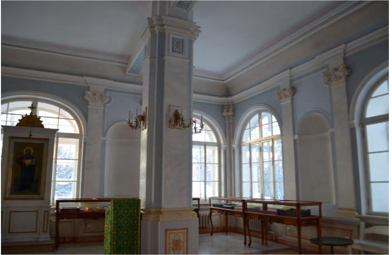
Фото 56. ОКН федерального значения «Церковь святого князя Феодора Новгородского». Лестничный объем второго этажа. Съёмка 10.11.2021 г.
