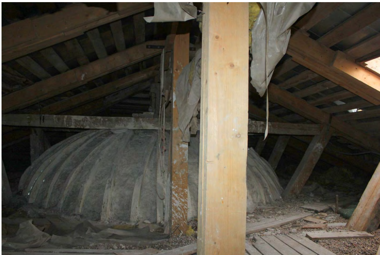
Фото 75. ОКН федерального значения «Церковь святого князя Феодора Новгородского». Чердак. Съёмка 10.11.2021 г.
