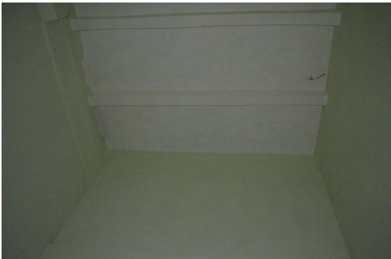
Фото 43. ОКН федерального значения «Церковь святого князя Феодора Новгородского». Первый этаж. Нижняя Фёдоровская церковь. Съёмка 10.11.2021 г.
