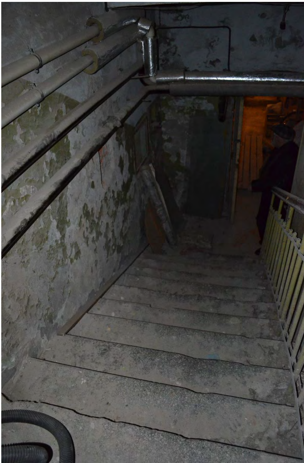
Фото 06. ОКН федерального значения «Церковь святого князя Феодора Новгородского». Лестница в подвальные помещения. Съёмка 10.11.2021 г.
