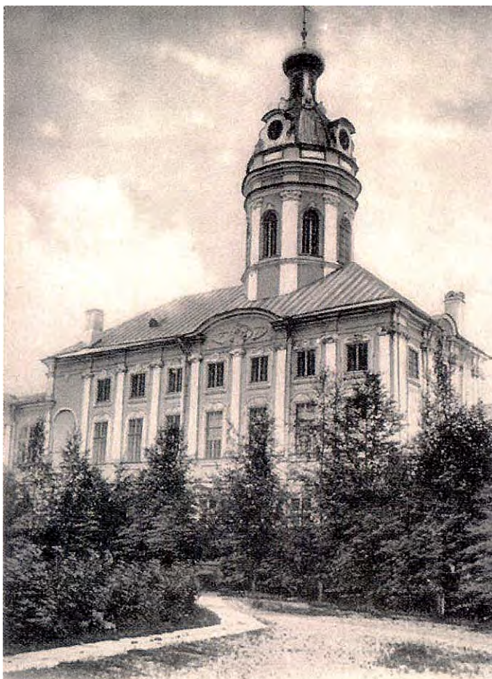
Илл.17. Феодоровская церковь. Вид с юго-востока. 1910-е.
