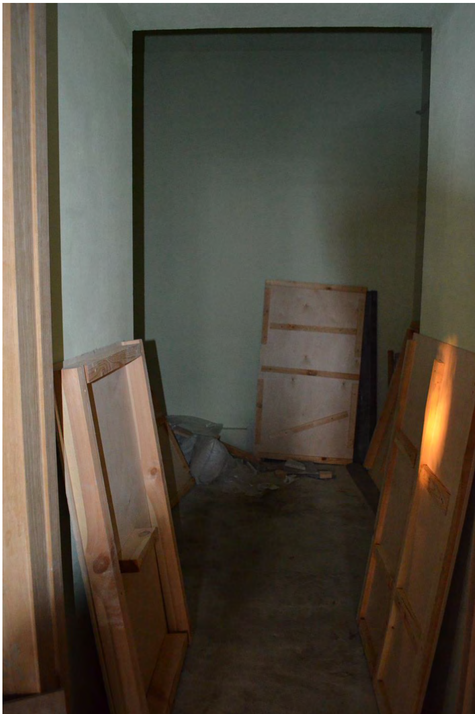
Фото 42. ОКН федерального значения «Церковь святого князя Феодора Новгородского». Первый этаж. Нижняя Фёдоровская церковь. Съёмка 10.11.2021 г.
