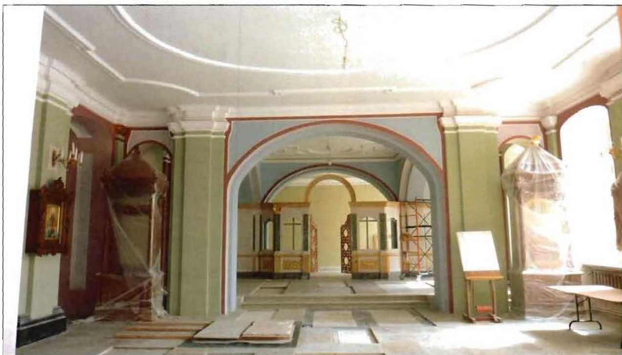
5. Интерьер. Нижняя церковь.
