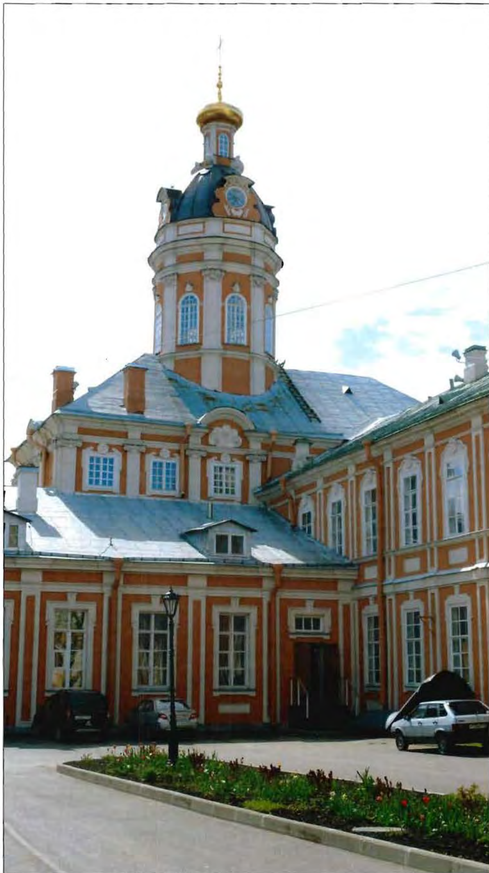
2. Общий вид с северо-востока.
