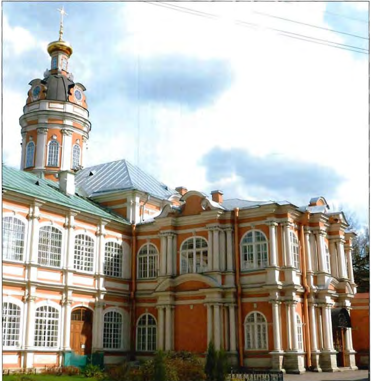
1. Общий вид с северо-запада.
