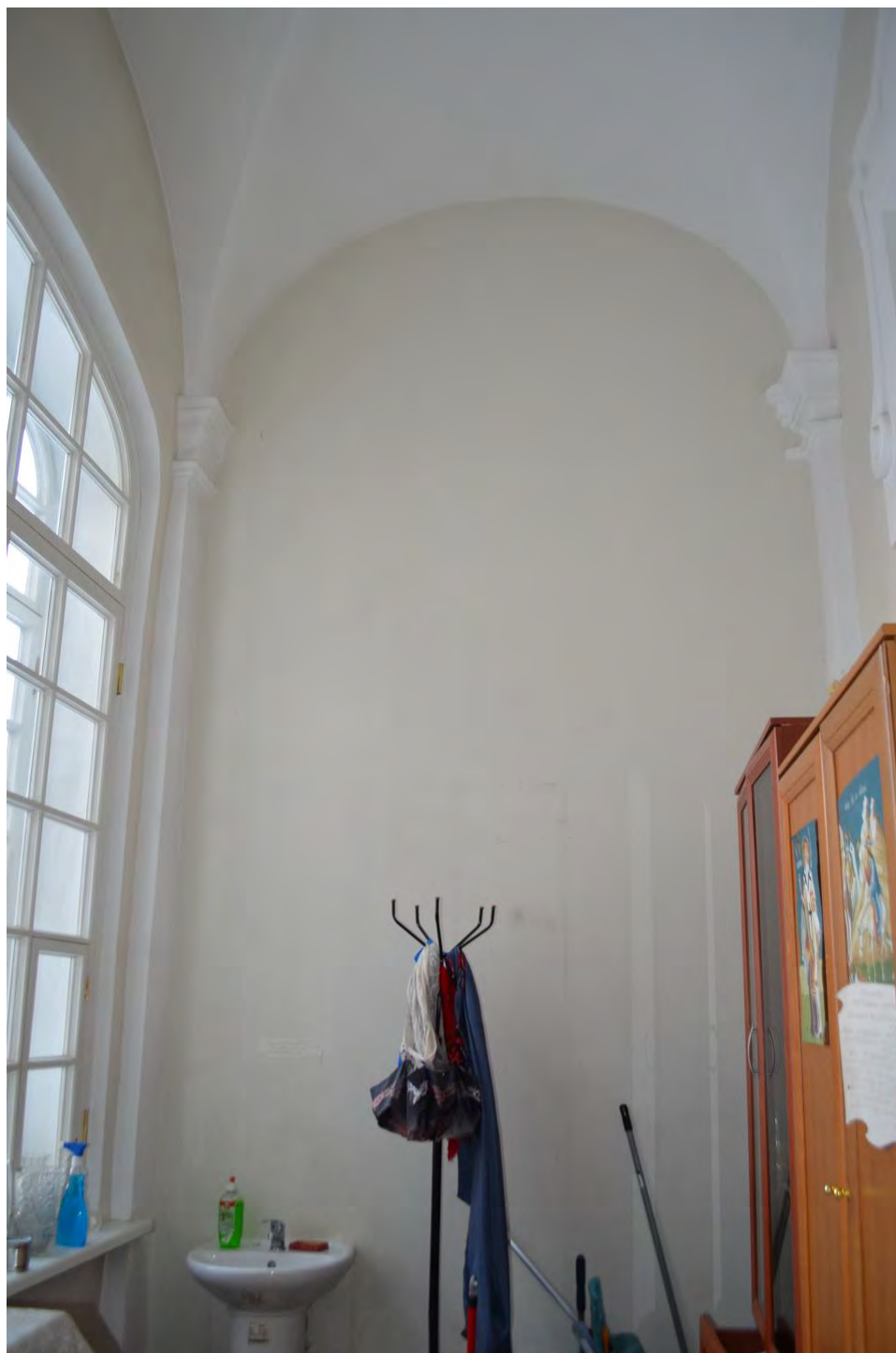
Фото 60. ОКН федерального значения «Церковь святого князя Феодора Новгородского». Помещение второго этажа. Съёмка 10.11.2021 г.
