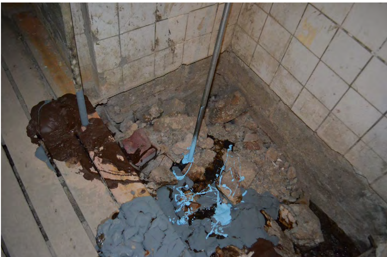
Фото 08. ОКН федерального значения «Церковь святого князя Феодора Новгородского». Подвальное помещение. Съёмка 10.11.2021 г.
