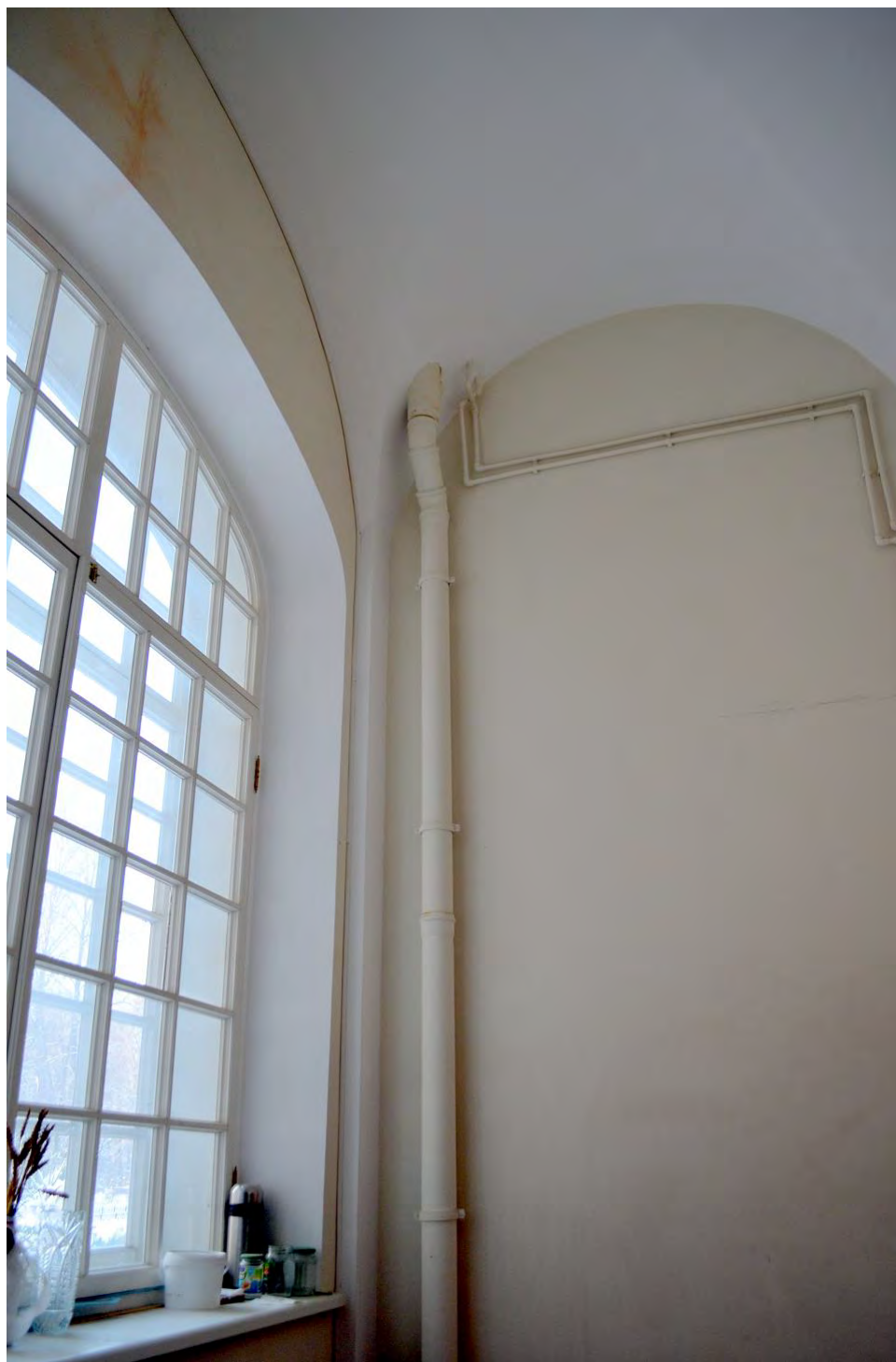
Фото 30. ОКН федерального значения «Церковь святого князя Феодора Новгородского». Помещение первого этажа. Съёмка 10.11.2021 г.
