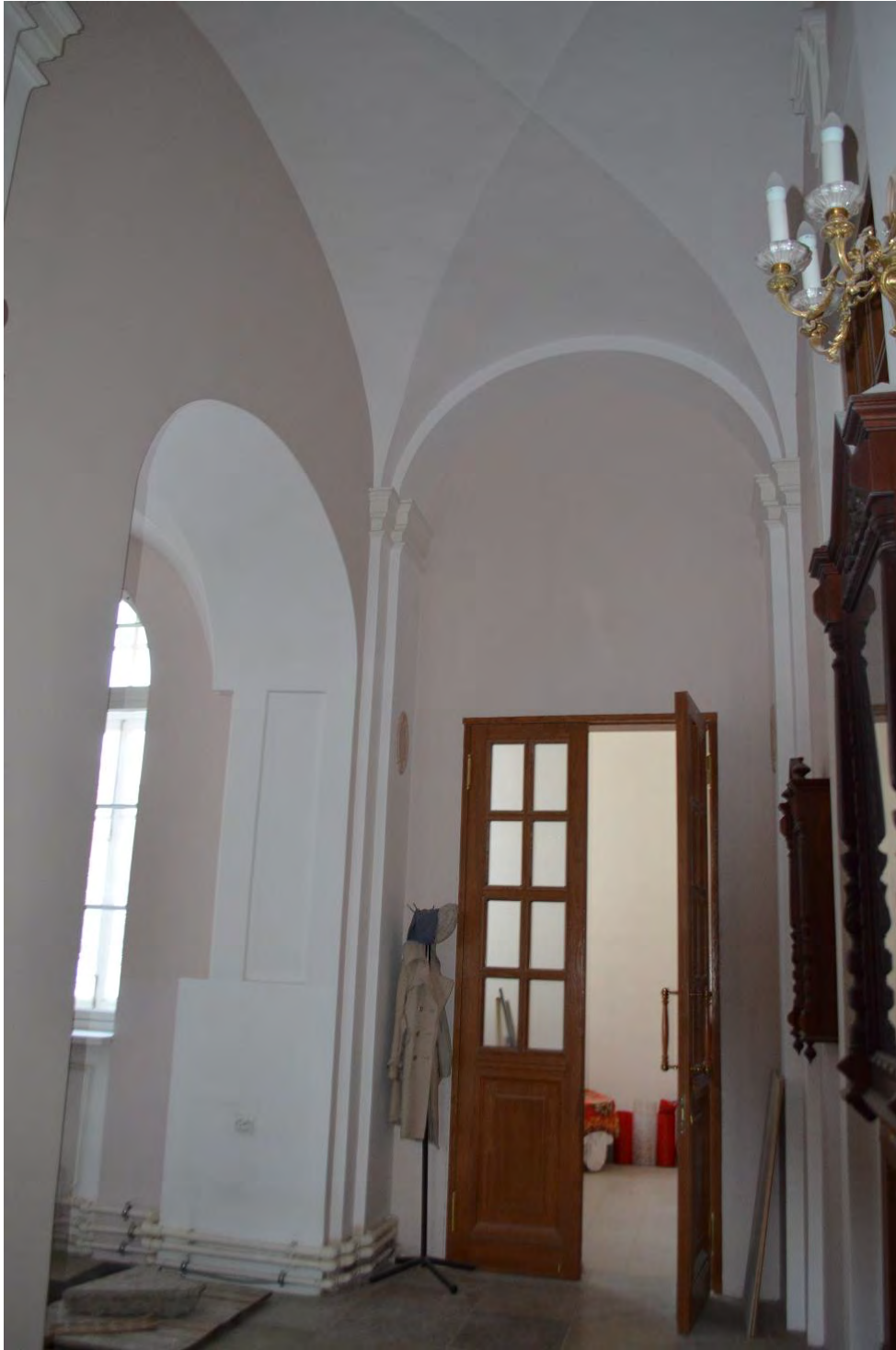
Фото 29. ОКН федерального значения «Церковь святого князя Феодора Новгородского». Помещение первого этажа. Съёмка 10.11.2021 г.
