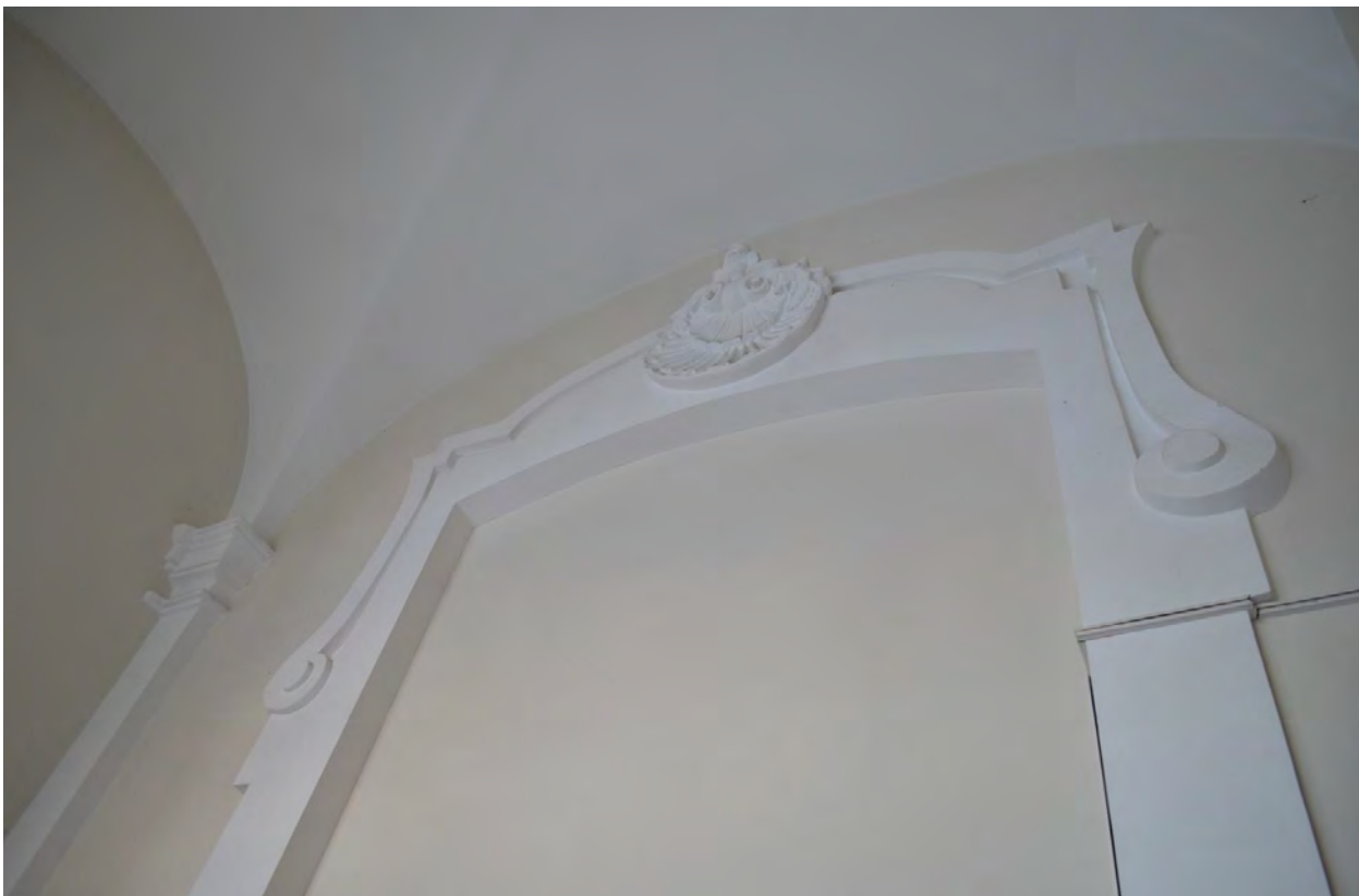
Фото 61. ОКН федерального значения «Церковь святого князя Феодора Новгородского». Помещение второго этажа. Съёмка 10.11.2021 г.
