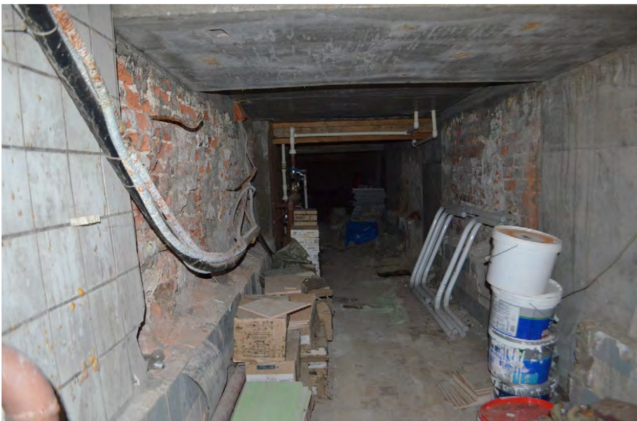
Фото 11. ОКН федерального значения «Церковь святого князя Феодора Новгородского». Подвальное помещение. Съёмка 10.11.2021 г.
