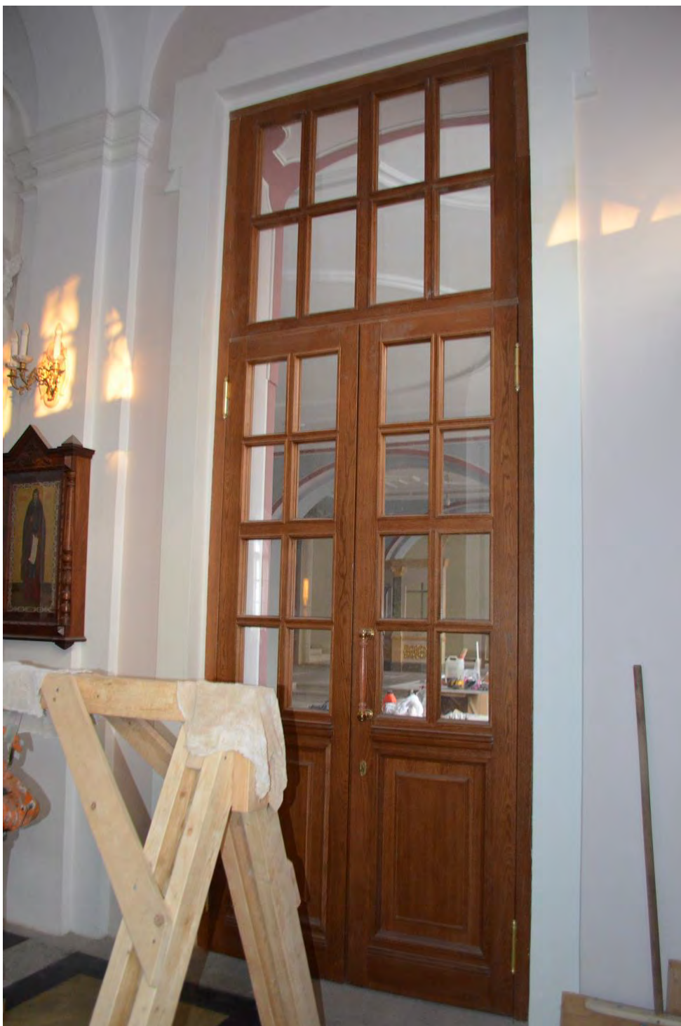
Фото 23. ОКН федерального значения «Церковь святого князя Феодора Новгородского». Помещение первого этажа. Фрагмент. Съёмка 10.11.2021 г.
