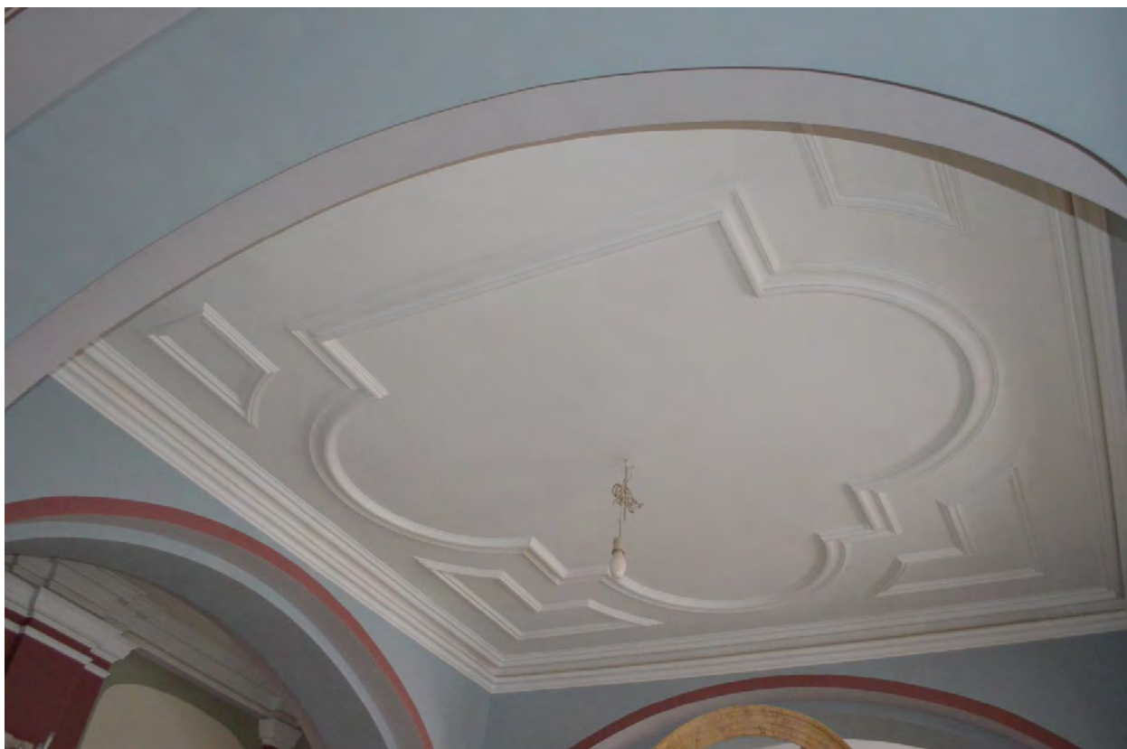
Фото 38. ОКН федерального значения «Церковь святого князя Феодора Новгородского». Первый этаж. Нижняя Фёдоровская церковь. Съёмка 10.11.2021 г.
