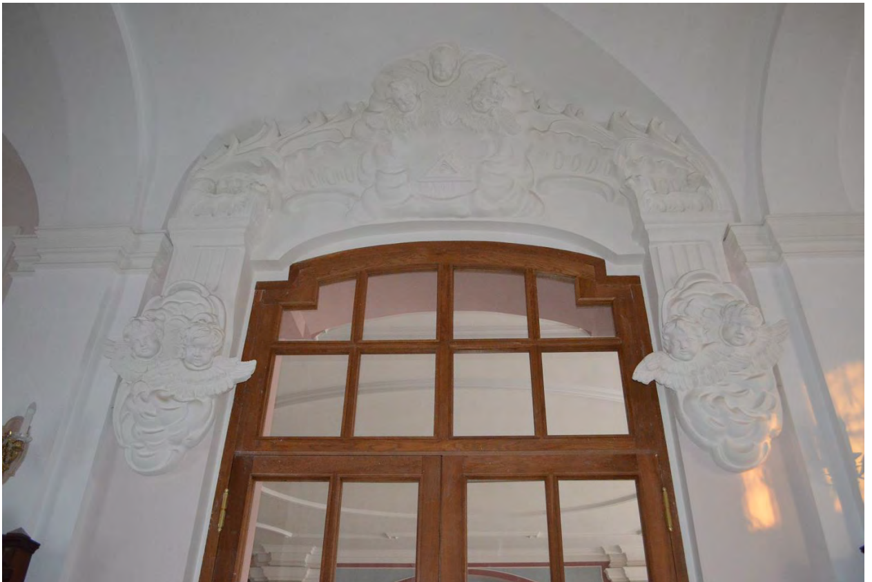
Фото 22. ОКН федерального значения «Церковь святого князя Феодора Новгородского». Помещение первого этажа. Фрагмент. Съёмка 10.11.2021 г.
