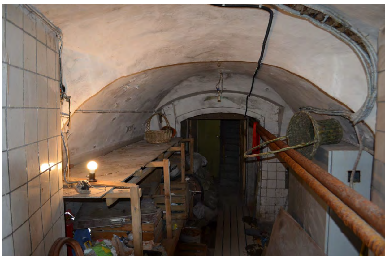
Фото 09. ОКН федерального значения «Церковь святого князя Феодора Новгородского». Подвальное помещение. Съёмка 10.11.2021 г.
