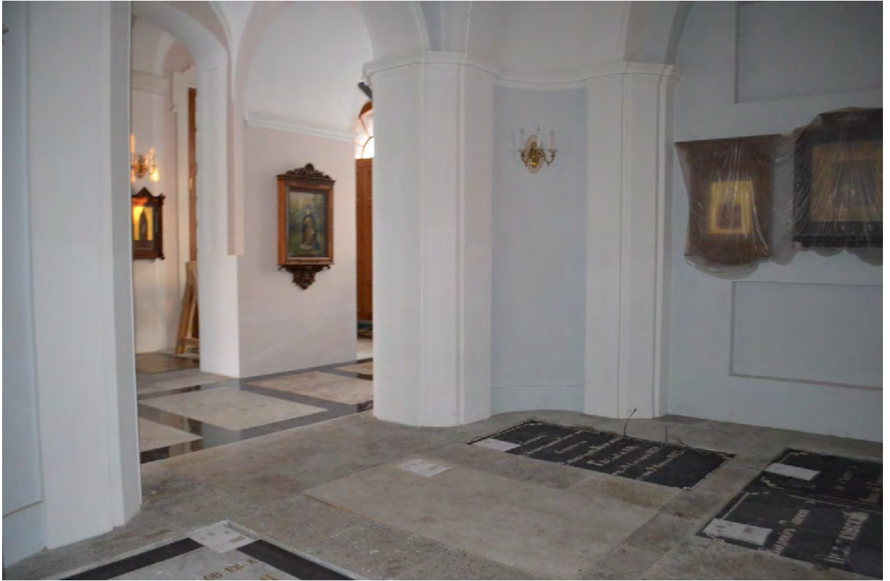
Фото 17. ОКН федерального значения «Церковь святого князя Феодора Новгородского». Помещение первого этажа. Съёмка 10.11.2021 г.
