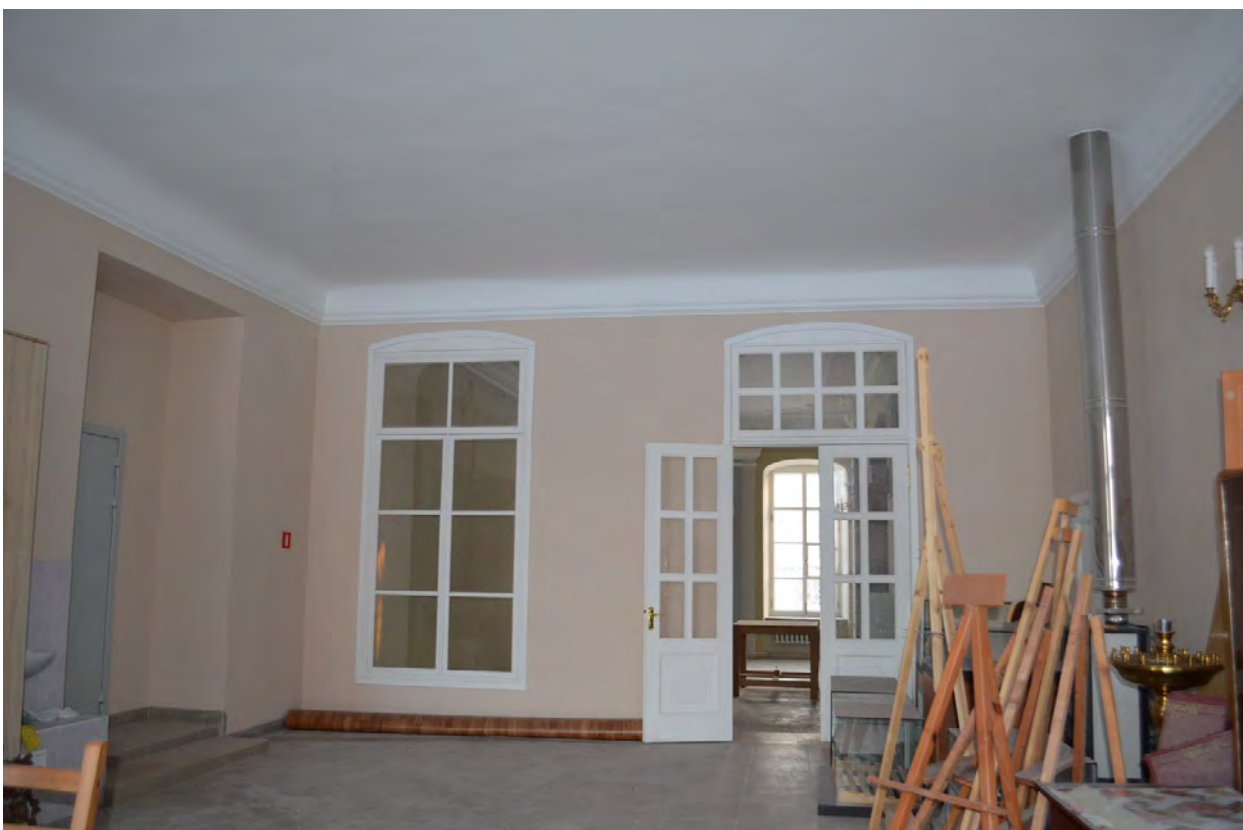
Фото 48. ОКН федерального значения «Церковь святого князя Феодора Новгородского». Помещение первого этажа. Съёмка 10.11.2021 г.
