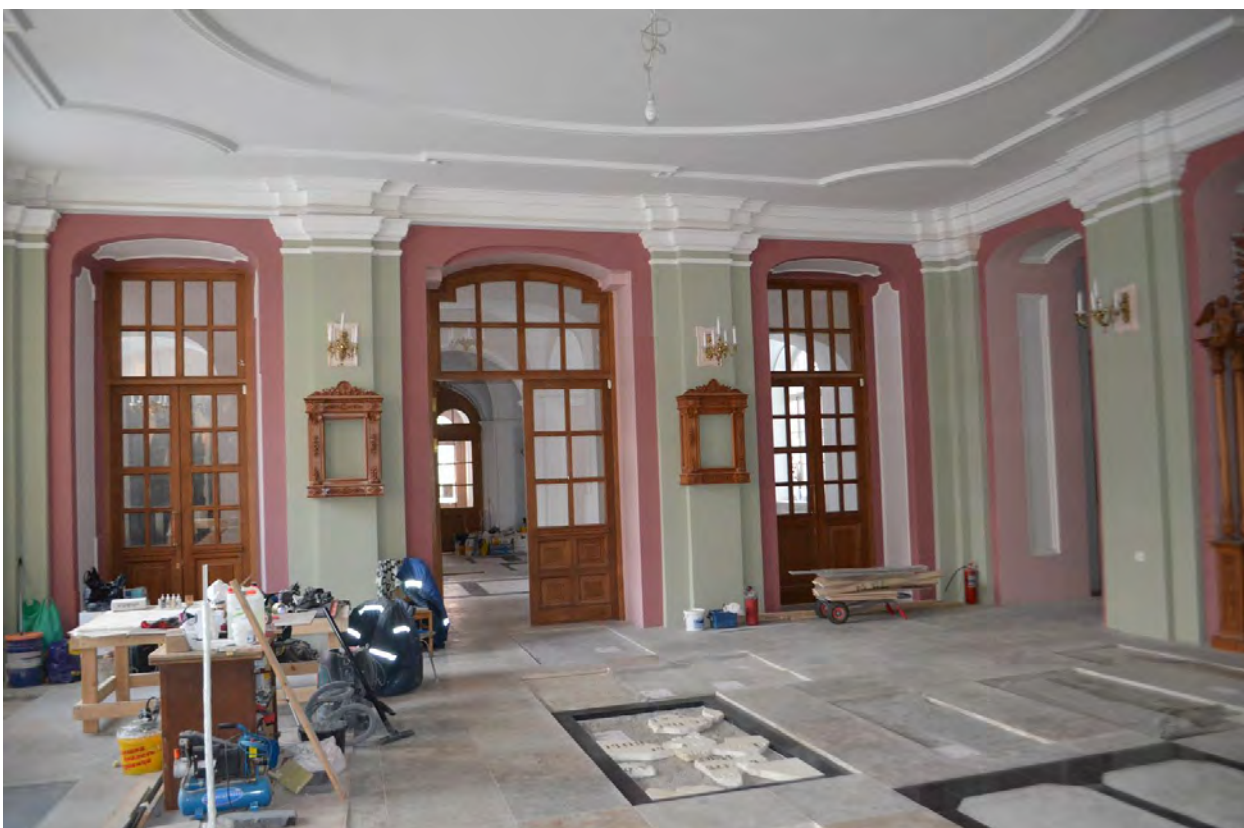
Фото 32. ОКН федерального значения «Церковь святого князя Феодора Новгородского». Первый этаж. Нижняя Фёдоровская церковь. Съёмка 10.11.2021 г.
