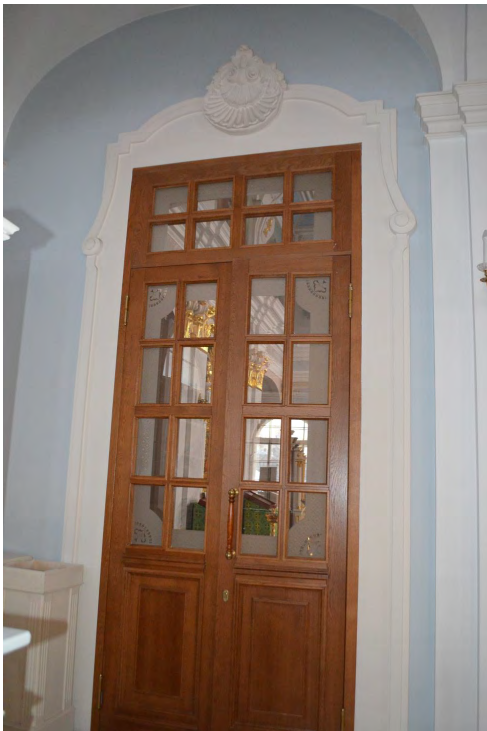
Фото 59. ОКН федерального значения «Церковь святого князя Феодора Новгородского». Лестничный объём второго этажа. Съёмка 10.11.2021 г.
