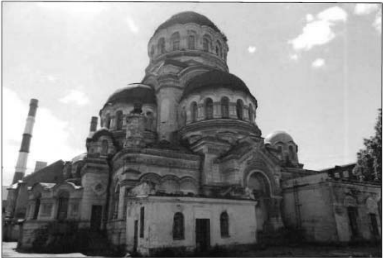
2. Общий вид с северо-востока.
