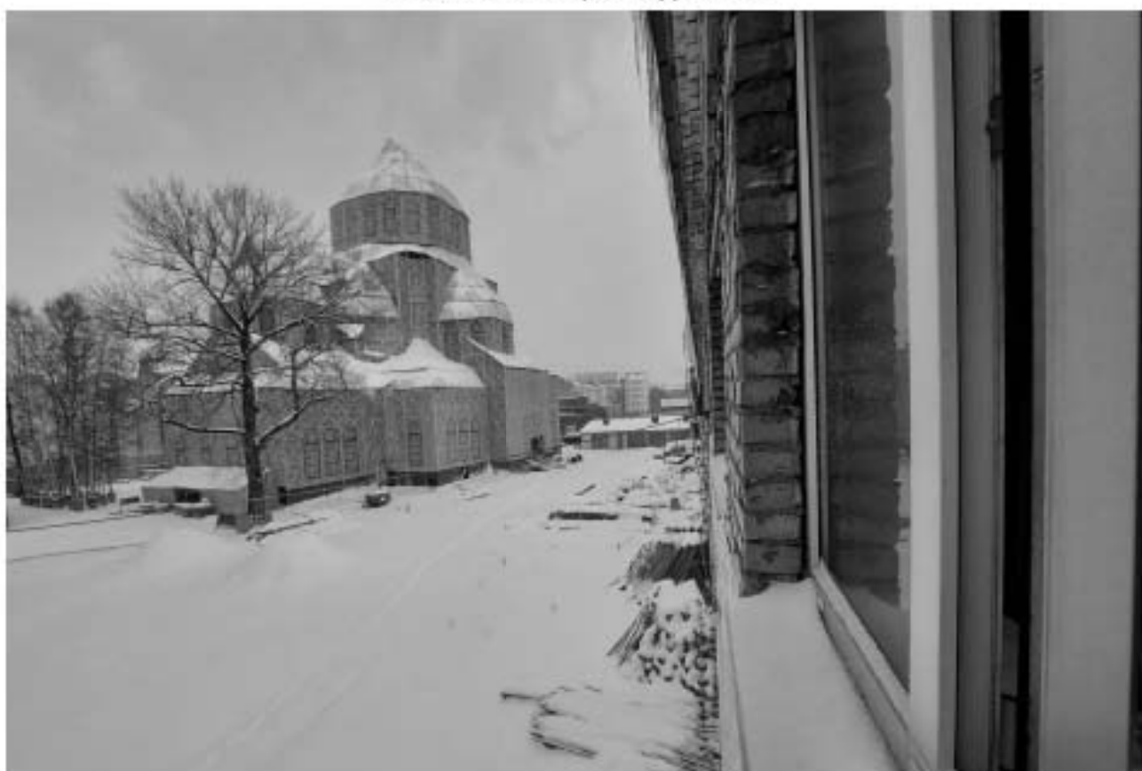
Фото № 8. Вид с юго-запада вдоль северо-западного фасада здания по ул. Кожевенной, д. 39, корп. 8.
