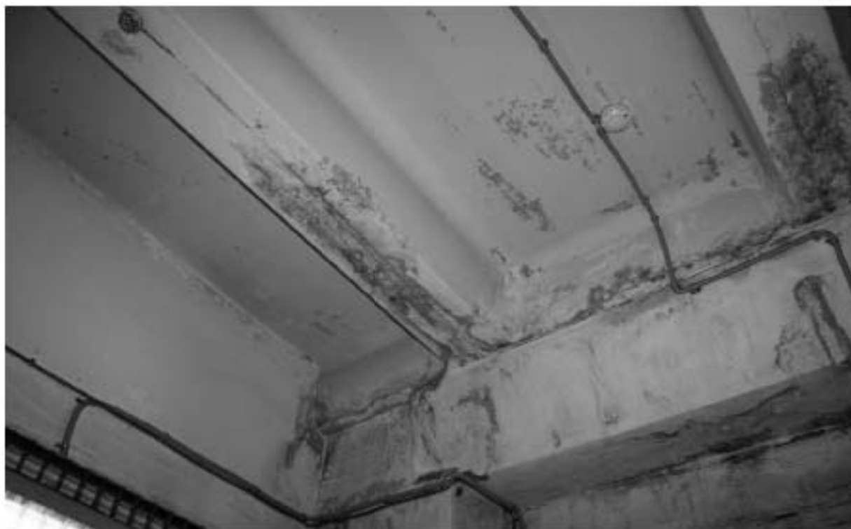
Фото № 29. Конструкция перекрытия 2-го этажа здания по Кожевенной лин. № 39 корп. 8.
