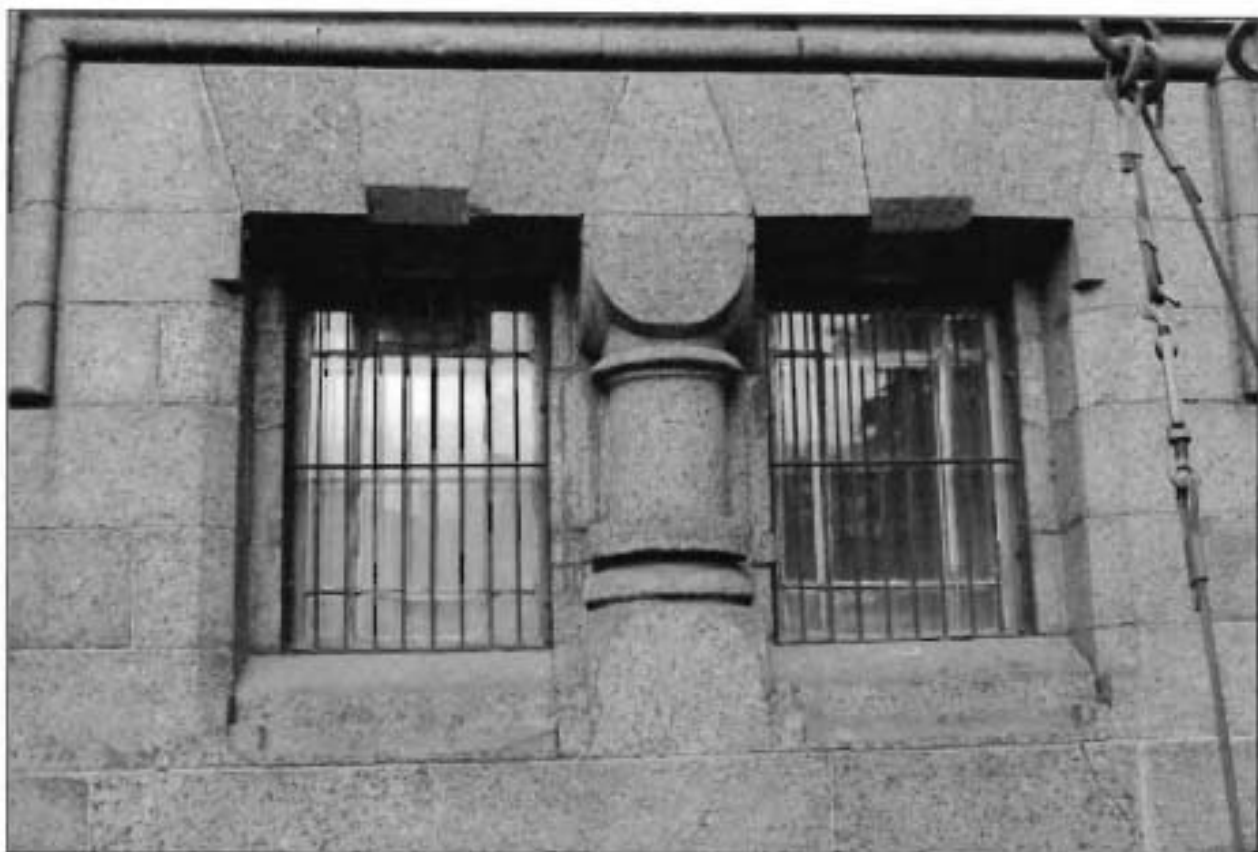
8. Южный фасад. Фрагмент. Окна притвора первого яруса.
