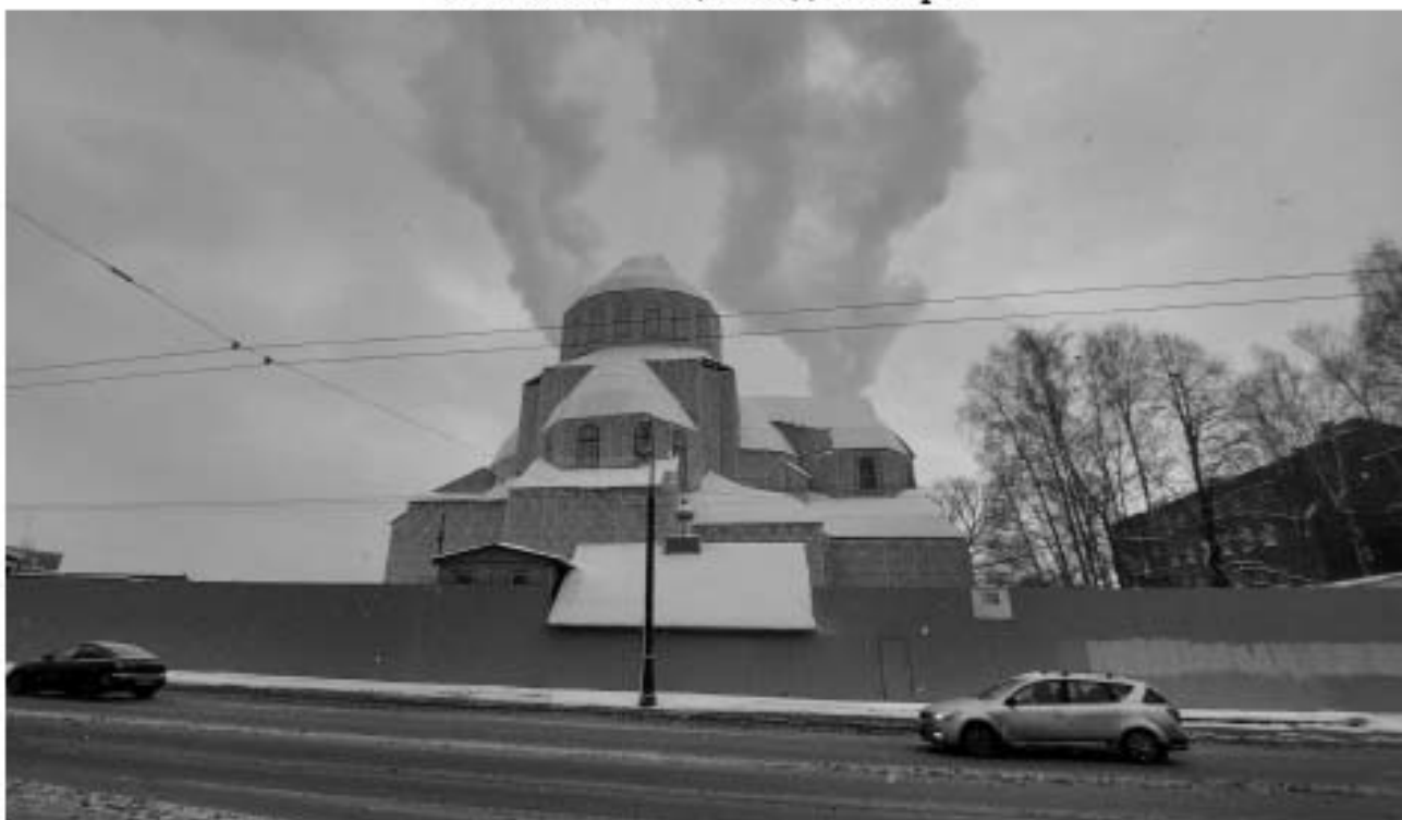
Фото № 2. Вид церкви с северо-запада.
