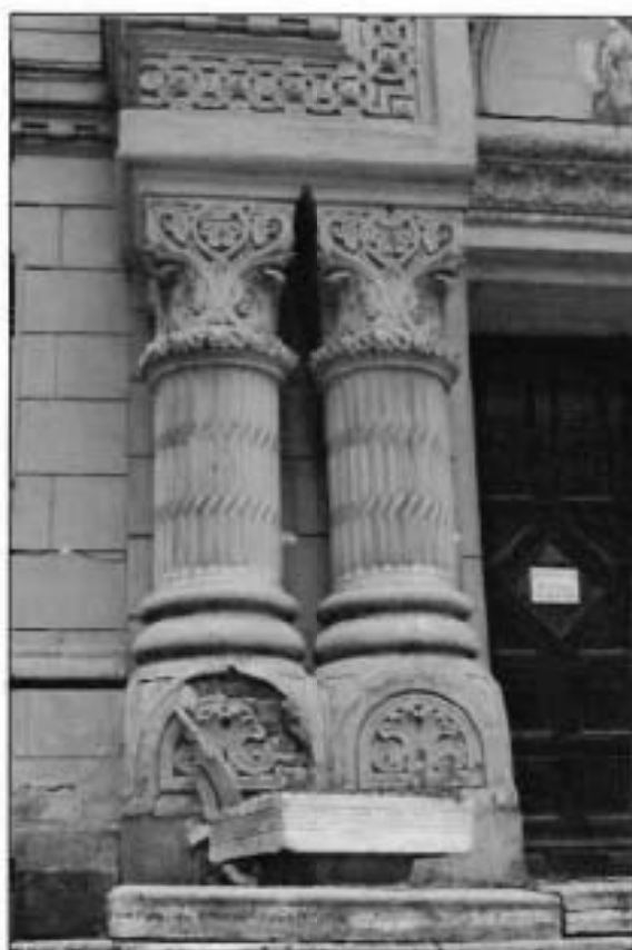
10. Западный фасад. Фрагмент.
