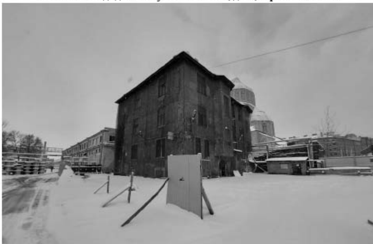
Фото № 18. Общий вид зданий с востока.
