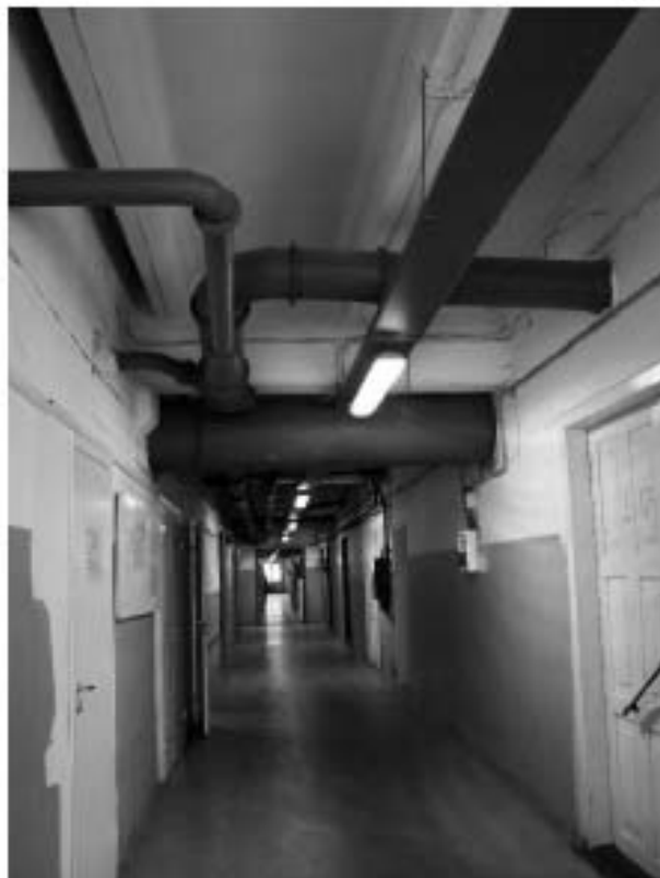
Фото № 32. Вид 2-го этажа с севера здания по Кожевенной лин. № 39 корп. 8.
