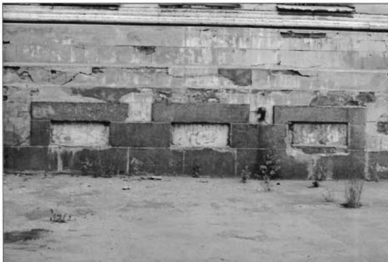
7. Западный фасад. Фрагмент. Цоколь.
