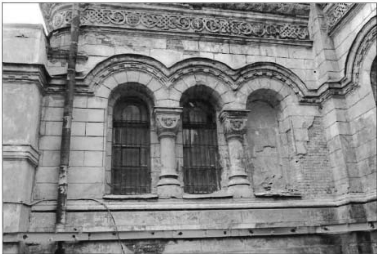
9. Западный фасад. Фрагмент.
