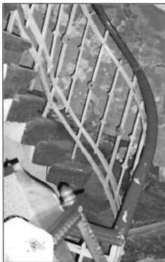
15. Интерьер. Фрагмент. Лестница на хоры
