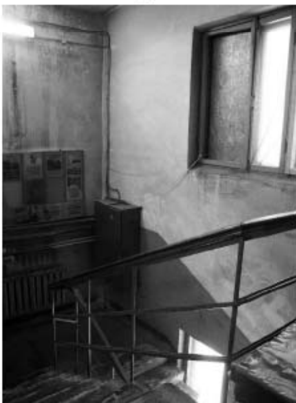
Фото № 33. Северная лестница здания по Кожевенной лин. № 39 корп. 8.
