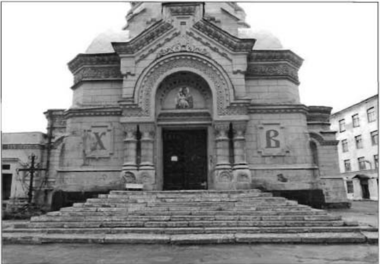
5. Западный фасад. Фрагмент.
