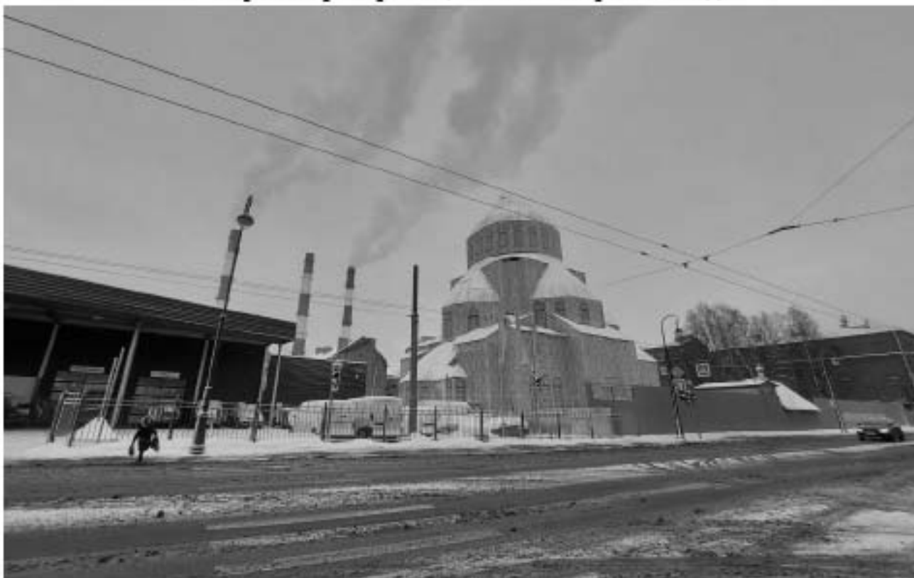
Фото № 1. Общий вид с севера.
