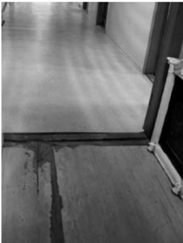
Фото № 31. Покрытие полов 2-го этажа здания по Кожевенной лин. № 39 корп. 8.
