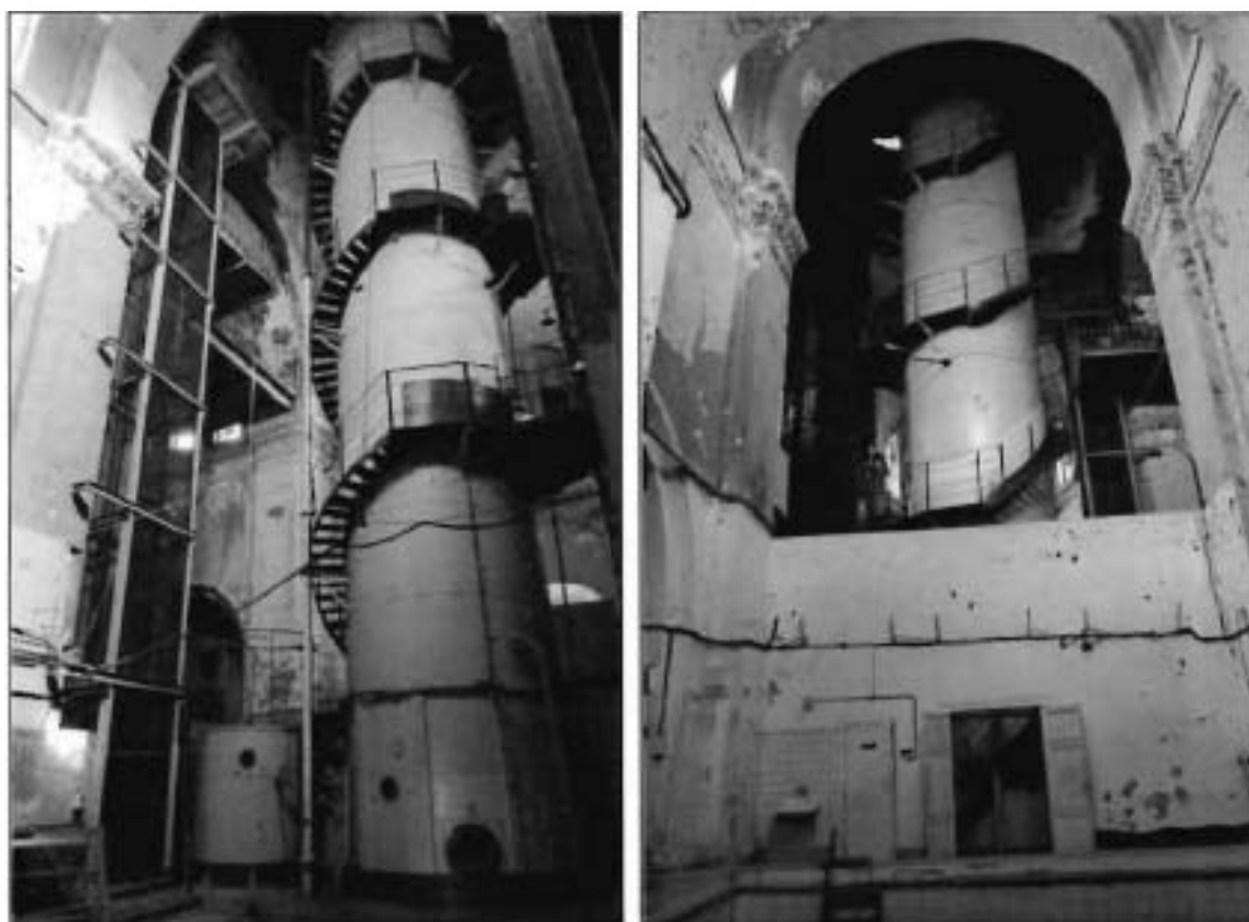
17-18. Интерьер. Шахта глубоководного погружения.
