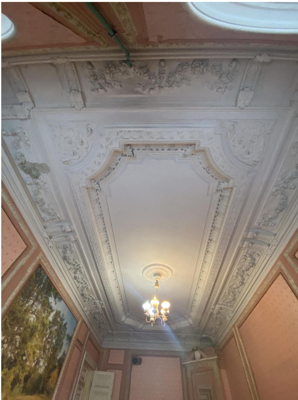
Фото 18. Оформление потолка в помещении № 4.
