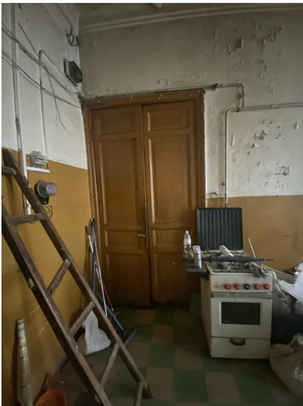
Фото 40. Вид на выход на служебную лестницу.
