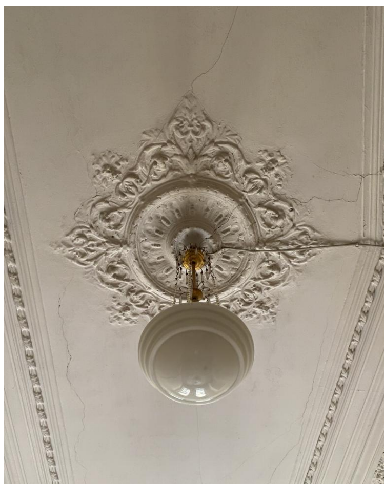
Фото 25. Оформление потолка в помещении № 5.
