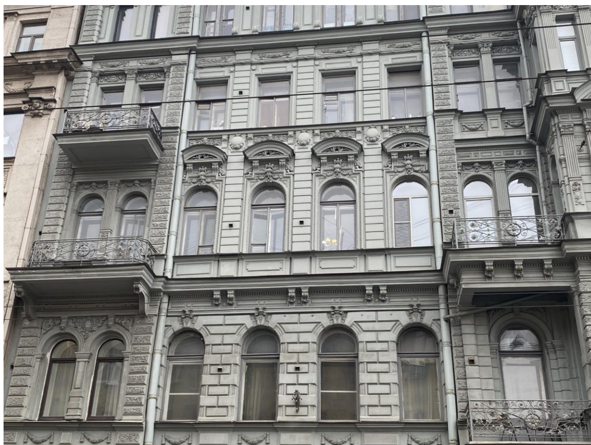
Фото 4. Вид на окна исследуемой квартиры.
