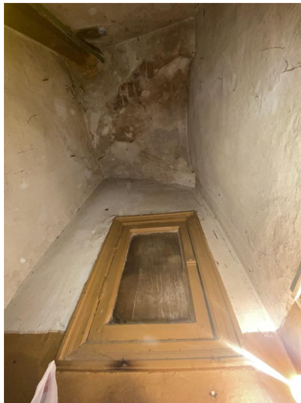
Фото 43. Перекрытие в санузеле.
