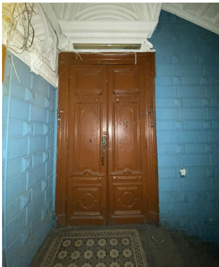
Фото 2. Вид на входную дверь в квартиру № 4.
