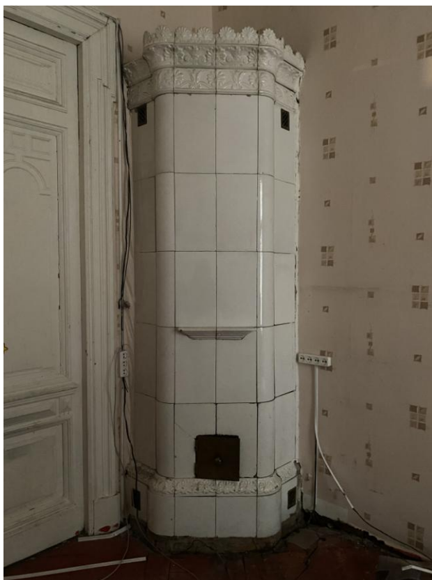
Фото 8. Печь в помещении № 7.
