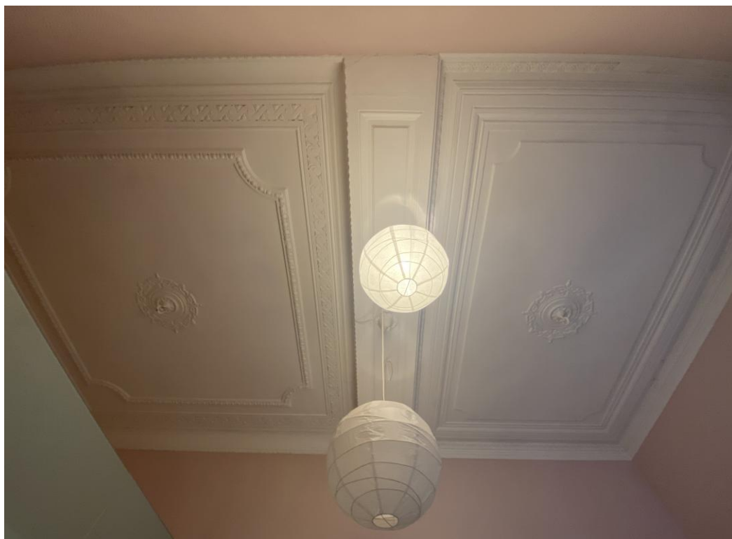
Фото 33. Оформление потолка в помещении № 8.
