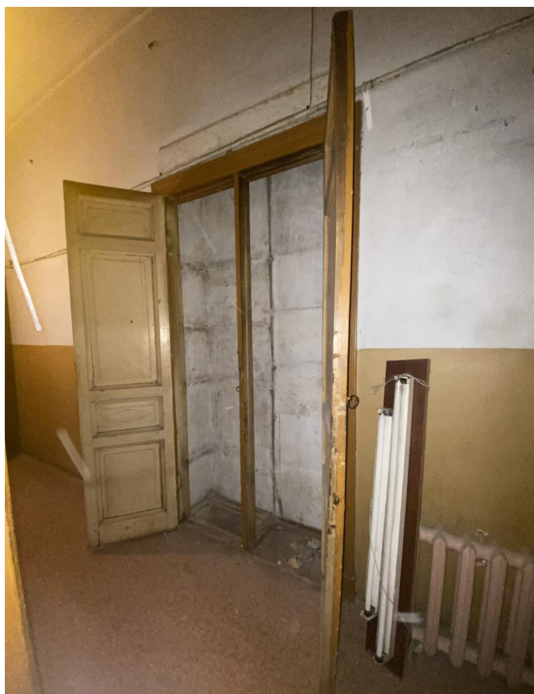
Фото 34. Вид на нишу из коридора.
