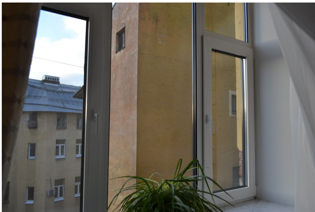
Фото 22. Помещения №3. Холл. (бывшее помещение №11, согласно техническому паспорту №3664/19 от 03.09.2019 г.) Вид на оконное заполнение.
