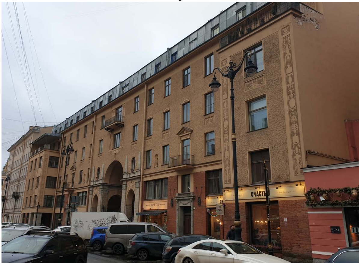
Фото 1. Лицевой фасад по ул. Рубинштейна. Вид. с северо-востока.
