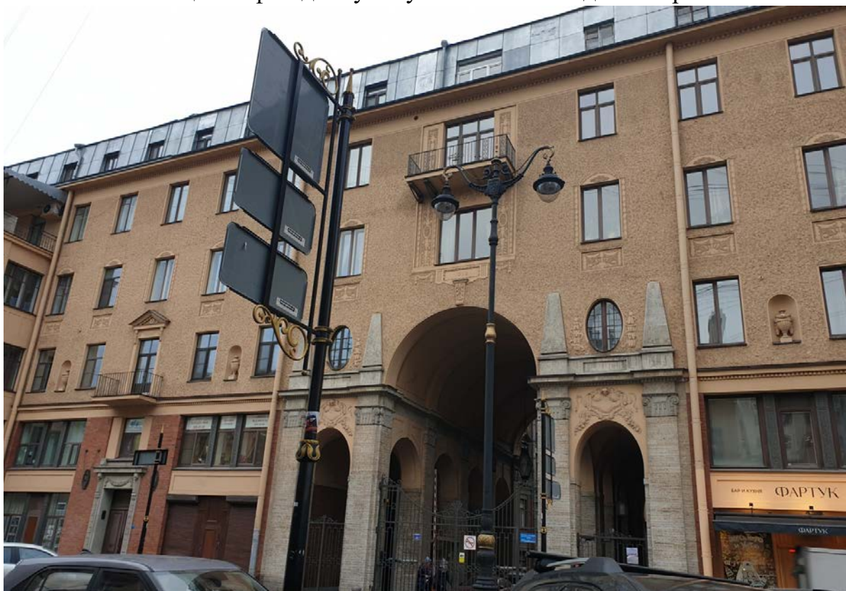
Фото 2. Фрагмент лицевого фасада по ул. Рубинштейна. Вид с востока.
