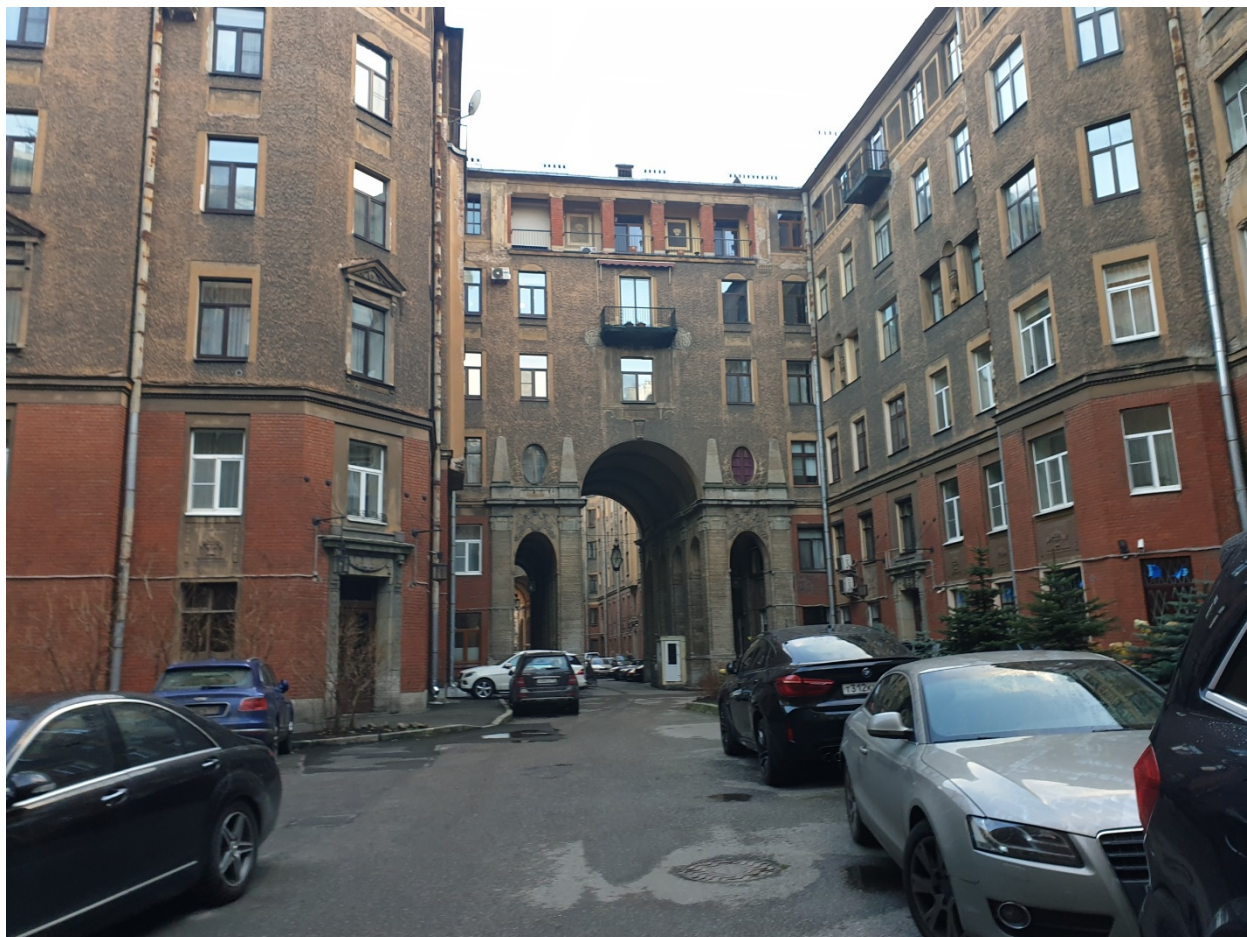
Фото 5. Проезд между средним и восточным дворами. Вид с северо-запада.
