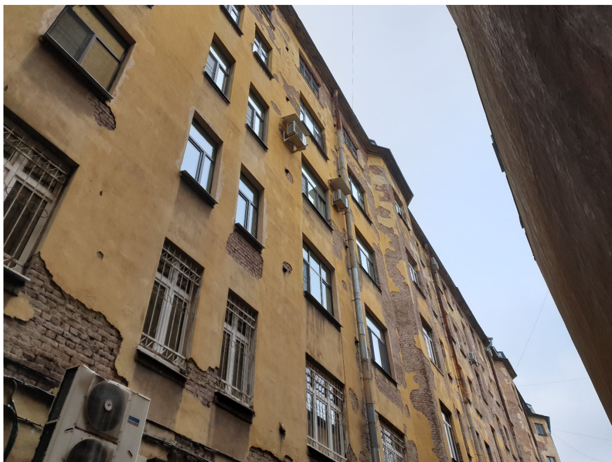
Фото 10. Фрагмент фасада южного «черного» двора. Вид с юго-запада.
