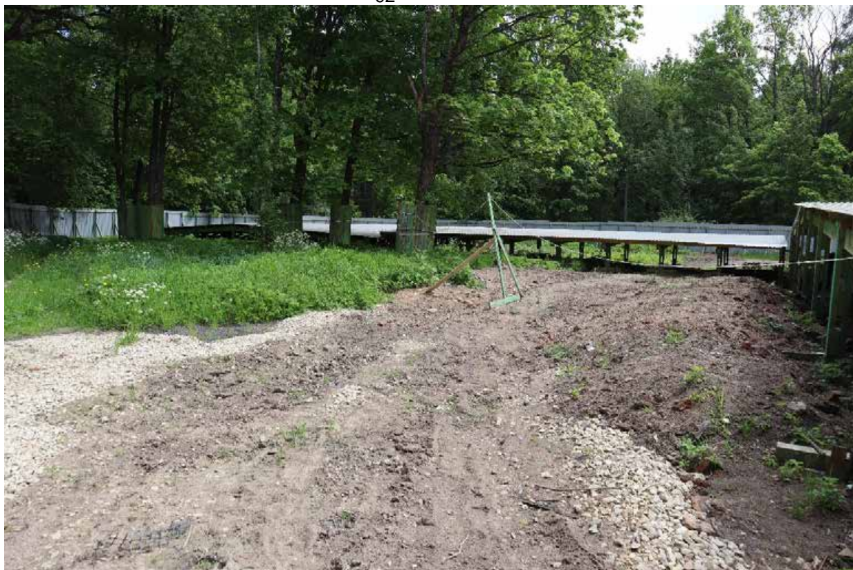
Рис. 27. СПб-2022. Выборгский район, Осиновая роща. Общий вид участка обследования. Точка фотофиксации 16. Вид с запада.
