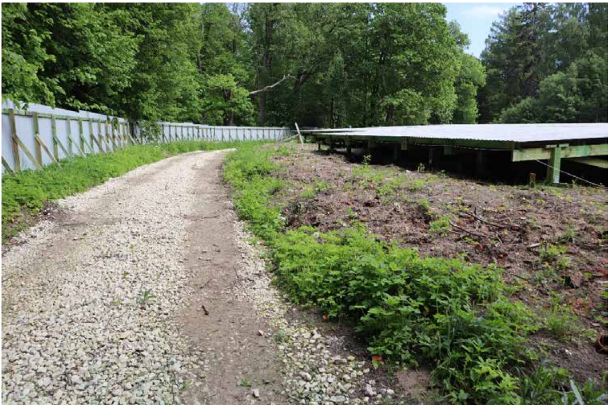
Рис. 26. СПб-2022. Выборгский район, Осиновая роща. Общий вид участка обследования. Точка фотофиксации 15. Вид с запада.
