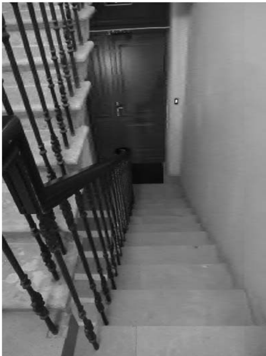
27. ОКН "Усадьба Военного министра", расположенный по адресу: г. Санкт-Петербург, ул. Садовая, д. 4, лит. А. Особняк. Историческая служебная лестница Л-2. Дата фотофиксации: 17.11.2021
