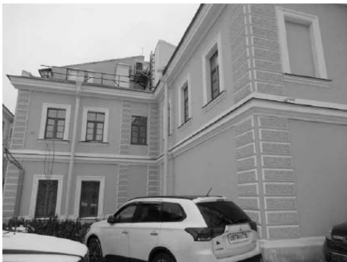
18. ОКН "Усадьба Военного министра", расположенный по адресу: г. Санкт-Петербург, ул. Садовая, д. 4, лит. А. восточный фасад (Флигель служебный). Дата фотофиксации: 17.11.2021
