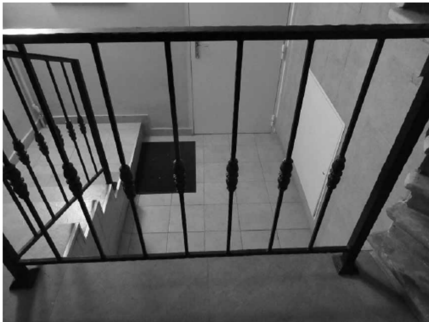
32. ОКН "Усадьба Военного министра", расположенный по адресу: г. Санкт-Петербург, ул. Садовая, д. 4, лит. А. Особняк. Историческая служебная лестница Л-3. Дата фотофиксации: 17.11.2021
