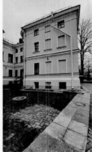
6. Фрагмент дворового фасада
