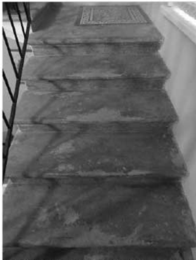
31. ОКН "Усадьба Военного министра", расположенный по адресу: г. Санкт-Петербург, ул. Садовая, д. 4, лит. А. Особняк. Историческая служебная лестница Л-3. Дата фотофиксации: 17.11.2021
