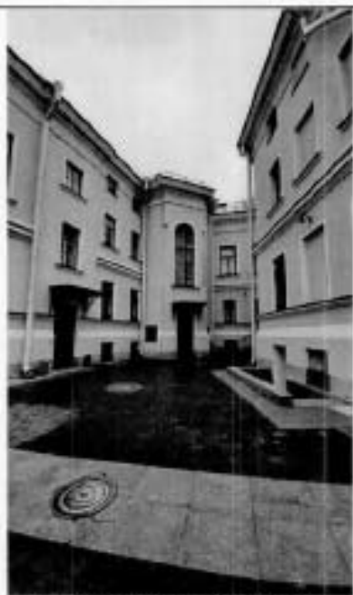
4. Фрагмент дворового фасада
