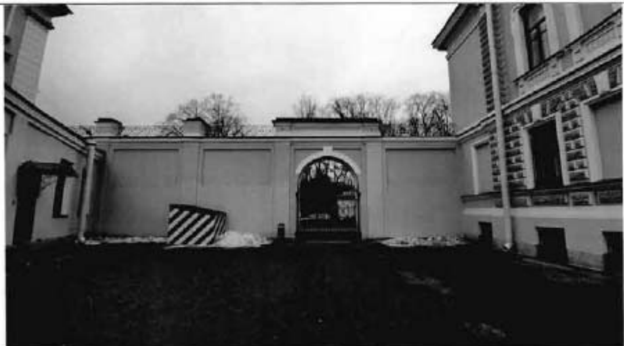
2. Общий вид со стороны двора
