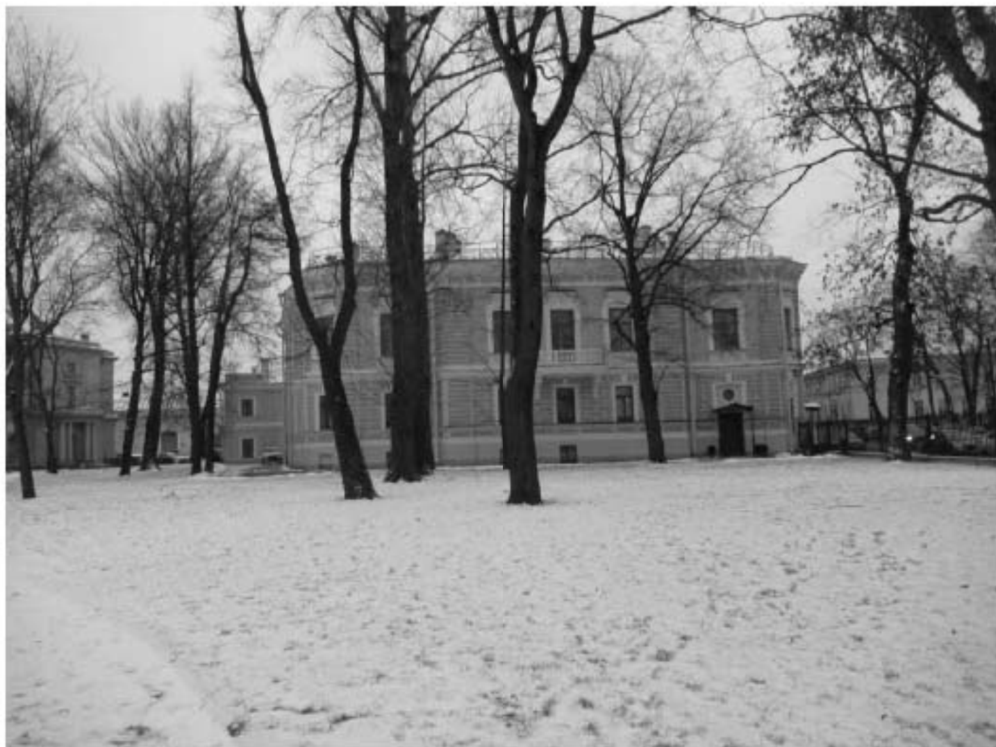
11. ОКН "Усадьба Военного министра", расположенный по адресу: г. Санкт-Петербург, ул. Садовая, д. 4, лит. А. Северный фасад (Особняк). Дата фотофиксации: 17.11.2021
