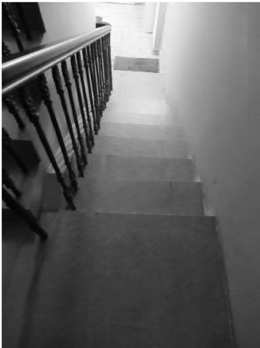
29. ОКН "Усадьба Военного министра", расположенный по адресу: г. Санкт-Петербург, ул. Садовая, д. 4, лит. А. Особняк. Историческая служебная лестница Л-2. Дата фотофиксации: 17.11.2021
