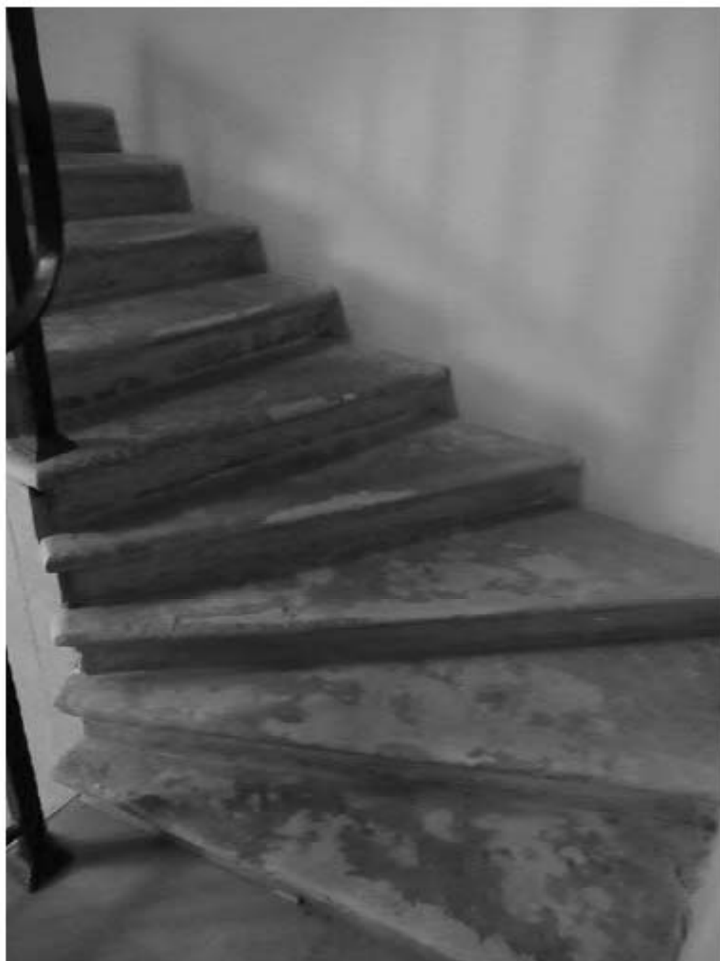
33. ОКН "Усадьба Военного министра", расположенный по адресу: г. Санкт-Петербург, ул. Садовая, д. 4, лит. А. Особняк. Историческая служебная лестница Л-3. Дата фотофиксации: 17.11.2021
