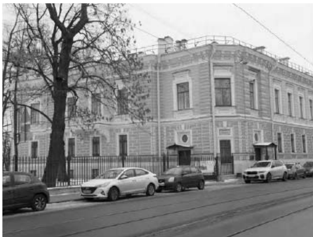
6. ОКН "Усадьба Военного министра", расположенный по адресу: г. Санкт-Петербург, ул. Садовая, д. 4, лит. А. Северный фасад (Особняк). Дата фотофиксации: 17.11.2021
