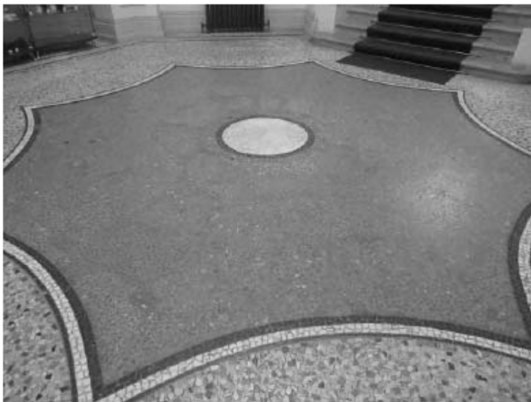
5. ОКН "Усадьба Военного министра", расположенный по адресу: г. Санкт-Петербург, ул. Садовая, д. 4, лит. А. Особняк. Вестибюль. Нижний уровень. Дата фотофиксации: 17.11.2021
