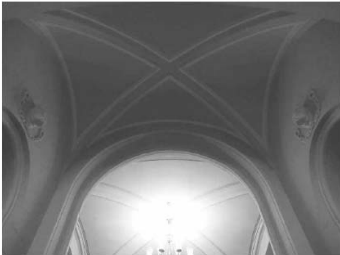
8. ОКН "Усадьба Военного министра", расположенный по адресу: г. Санкт-Петербург, ул. Садовая, д. 4, лит. А. Особняк. Вестибюль. Нижний уровень. Дата фотофиксации: 17.11.2021
