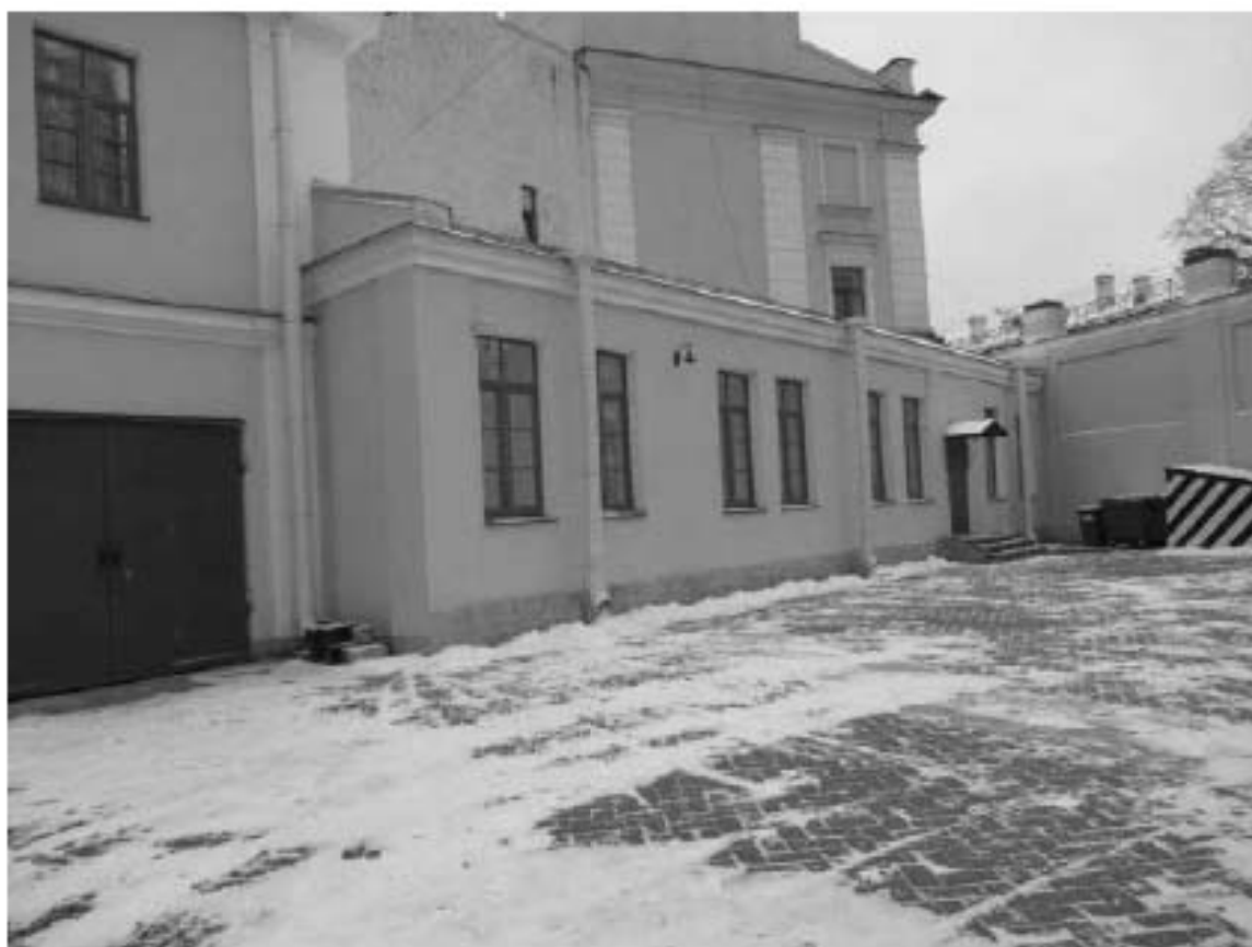
26. ОКН “Усадьба Военного министра”, расположенный по адресу: г. Санкт-Петербург, ул. Садовая, д. 4, лит. А. Северный фасад (Особняк). Дата фотофиксации: 17.11.2021
