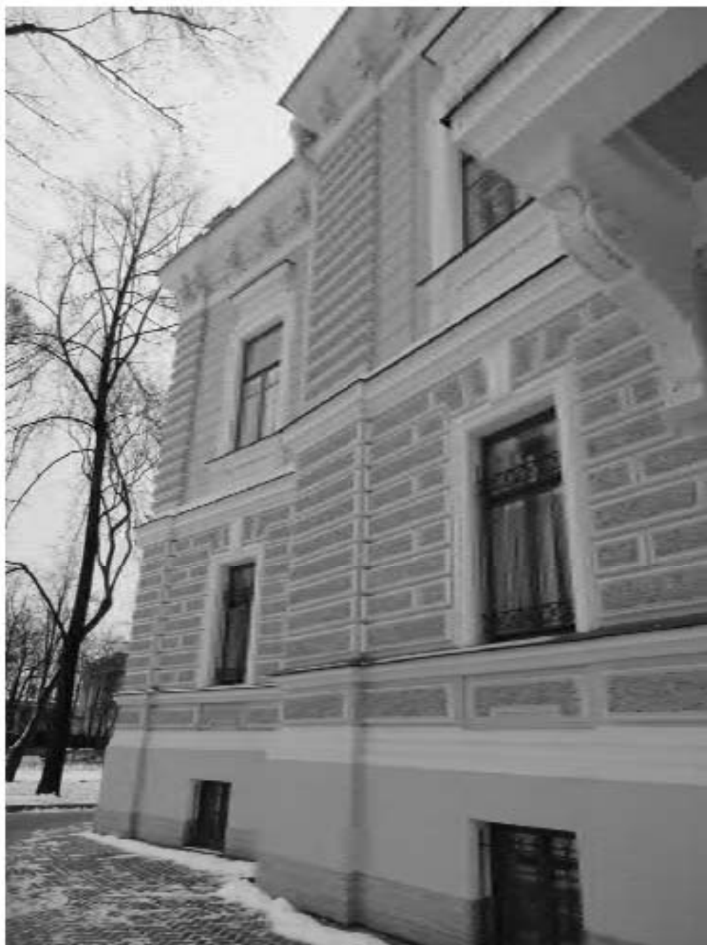
12. ОКН "Усадьба Военного министра", расположенный по адресу: г. Санкт-Петербург, ул. Садовая, д. 4, лит. А. Северный фасад (Особняк). Дата фотофиксации: 17.11.2021
