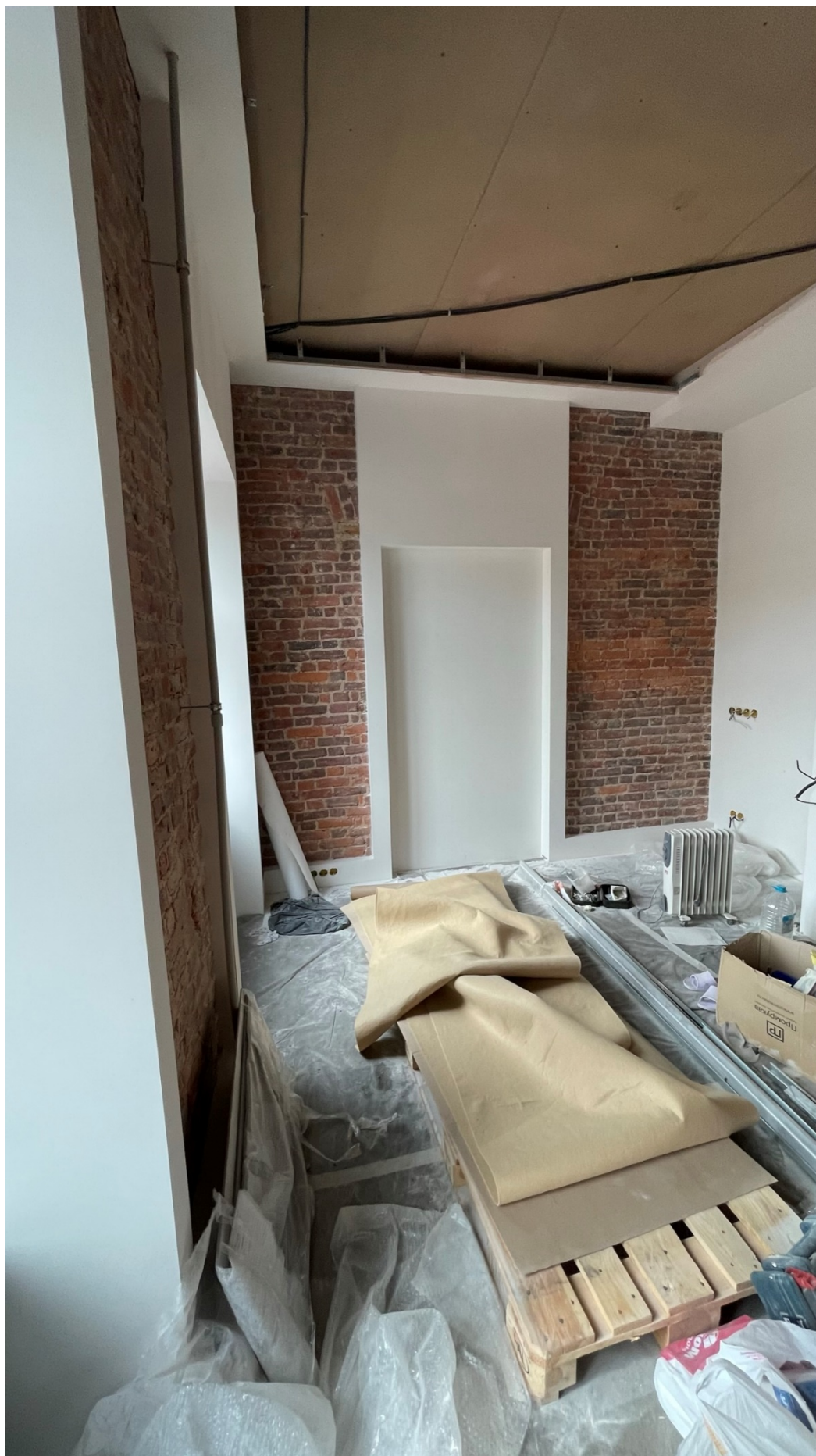
20. Фрагмент интерьера кабинета (помещение №1);
