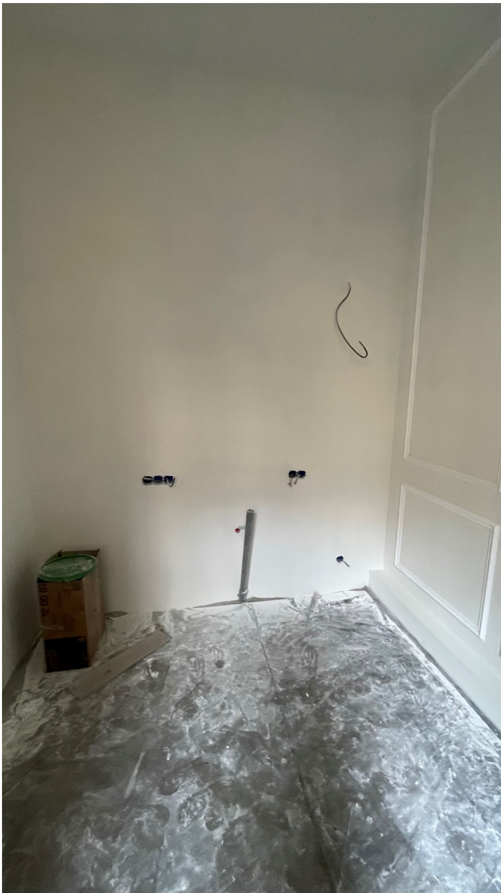
15.Фрагмент интерьера комнаты персонала (помещение №5);
