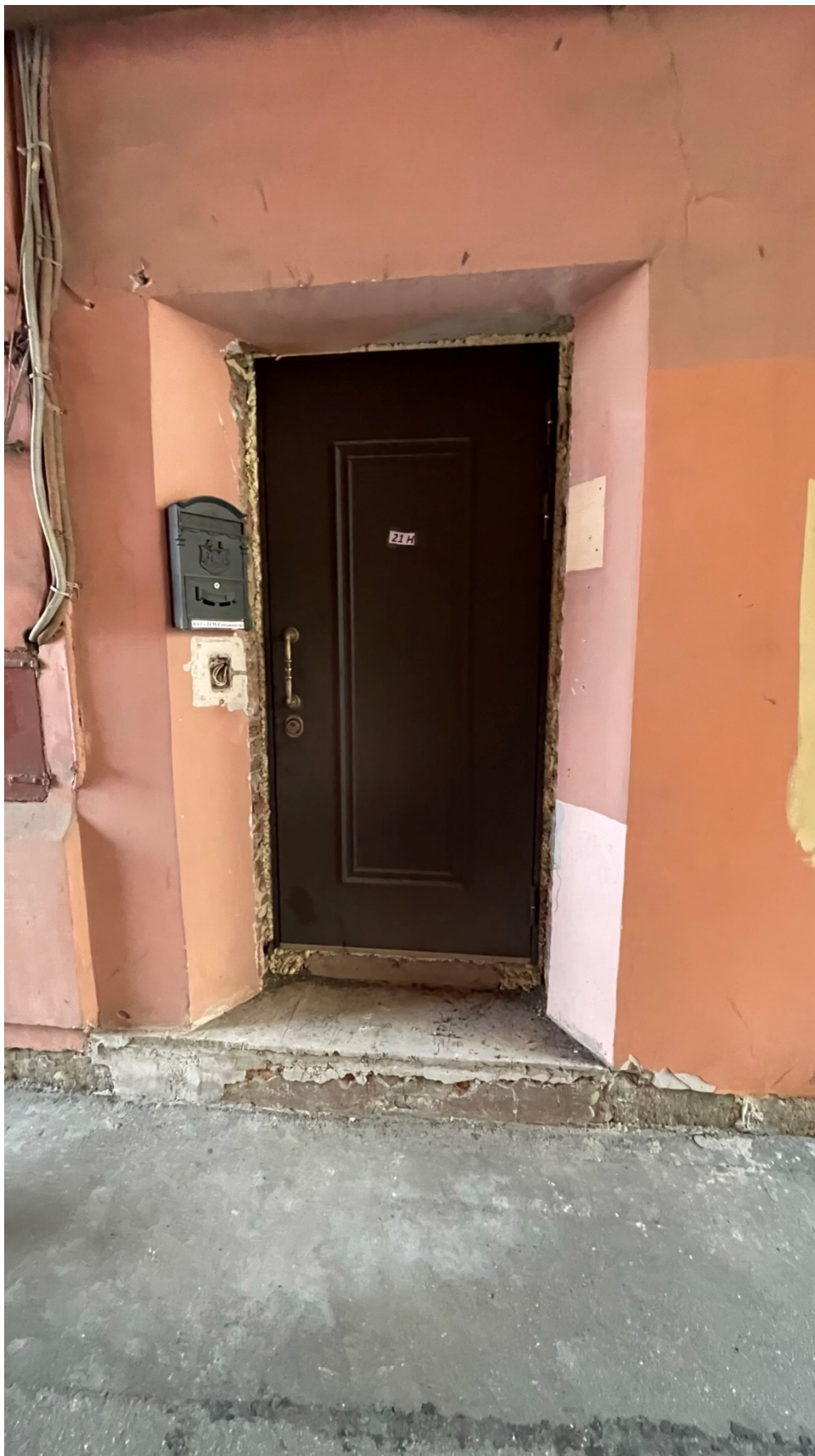
5. Вид на входную дверь в помещение;
