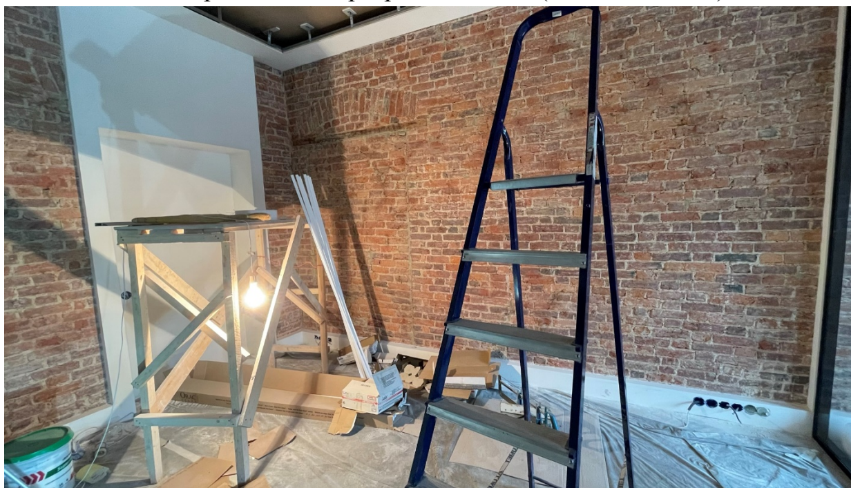
18. Фрагмент интерьера вестибюля (помещение №2);
