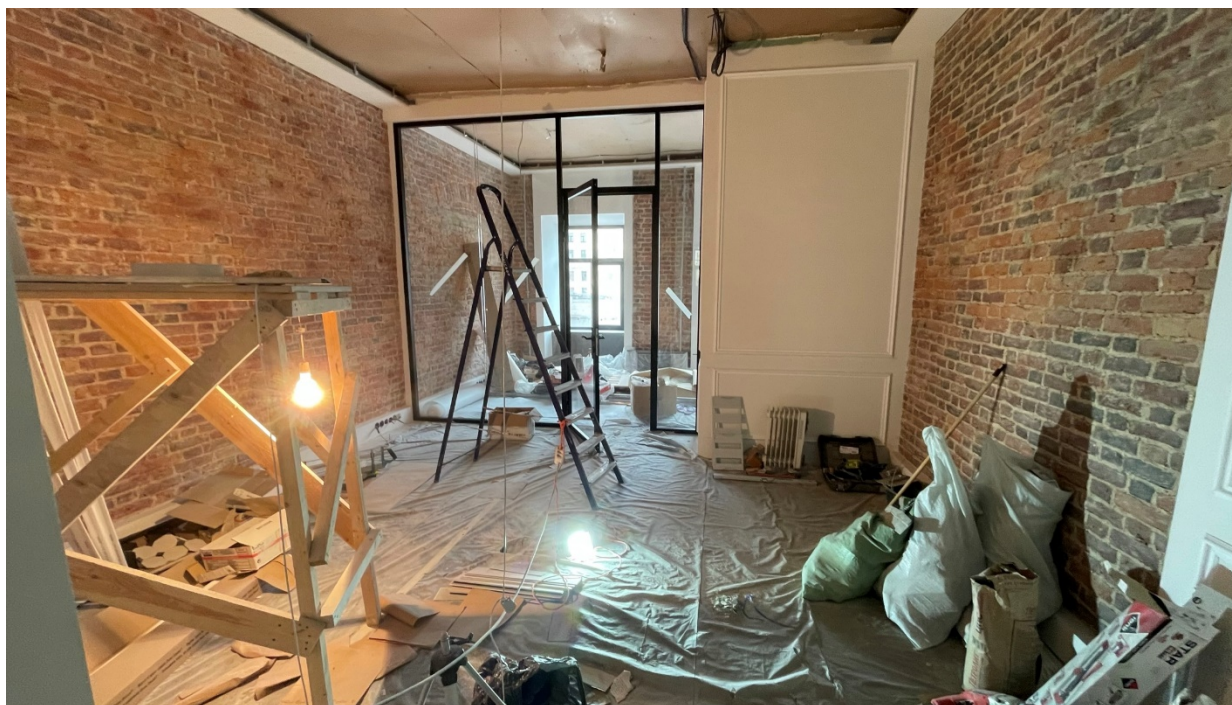
17. Фрагмент интерьера вестибюля (помещение №2);
