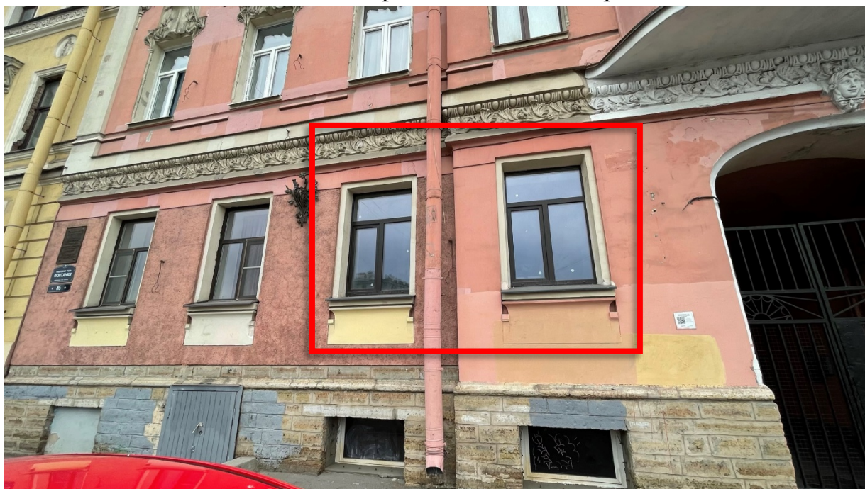
2. Вид на главный фасад здания с наб. р. Фонтанки и окна помещения;
