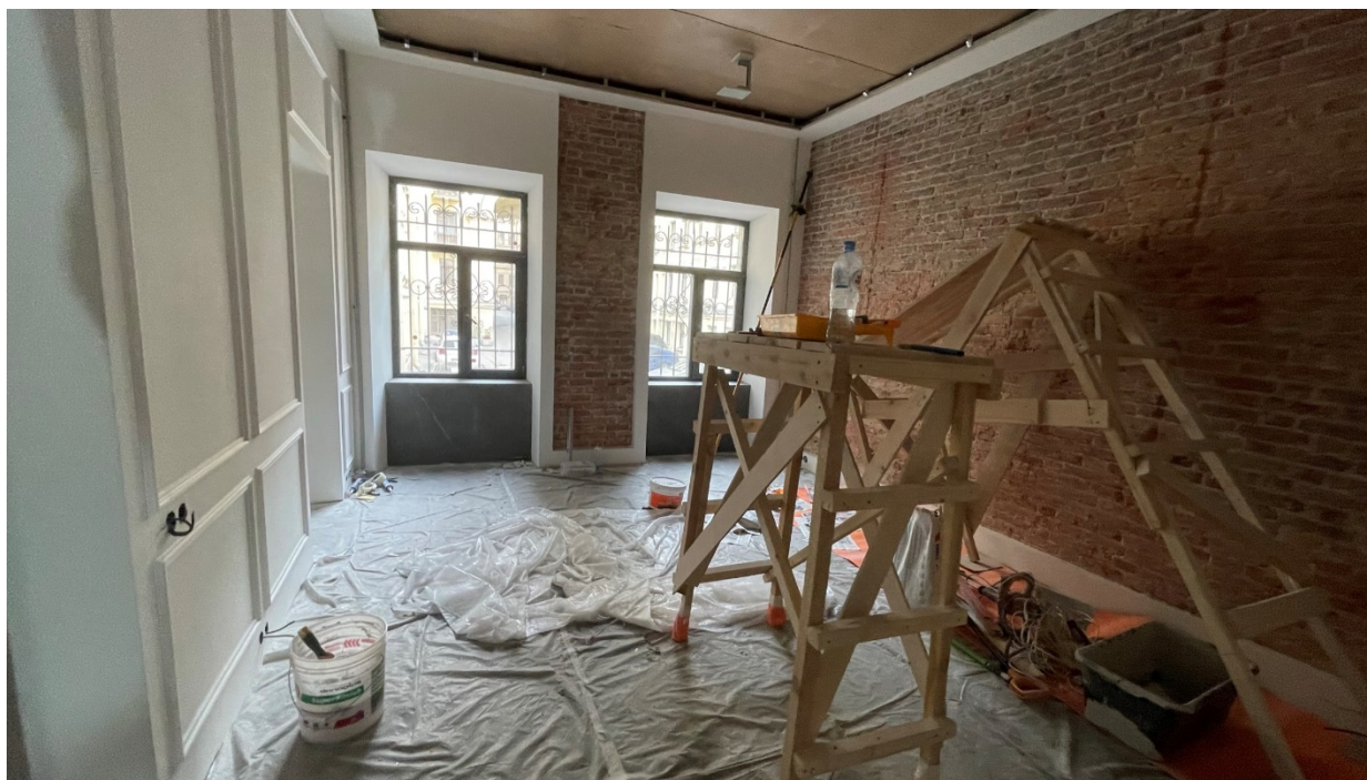
8. Фрагмент интерьера кабинета (помещение №4);
