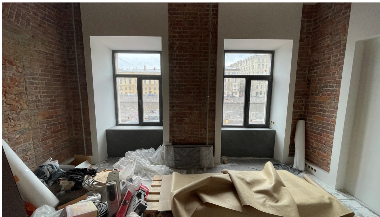
19.Фрагмент интерьера кабинета (помещение №1);
