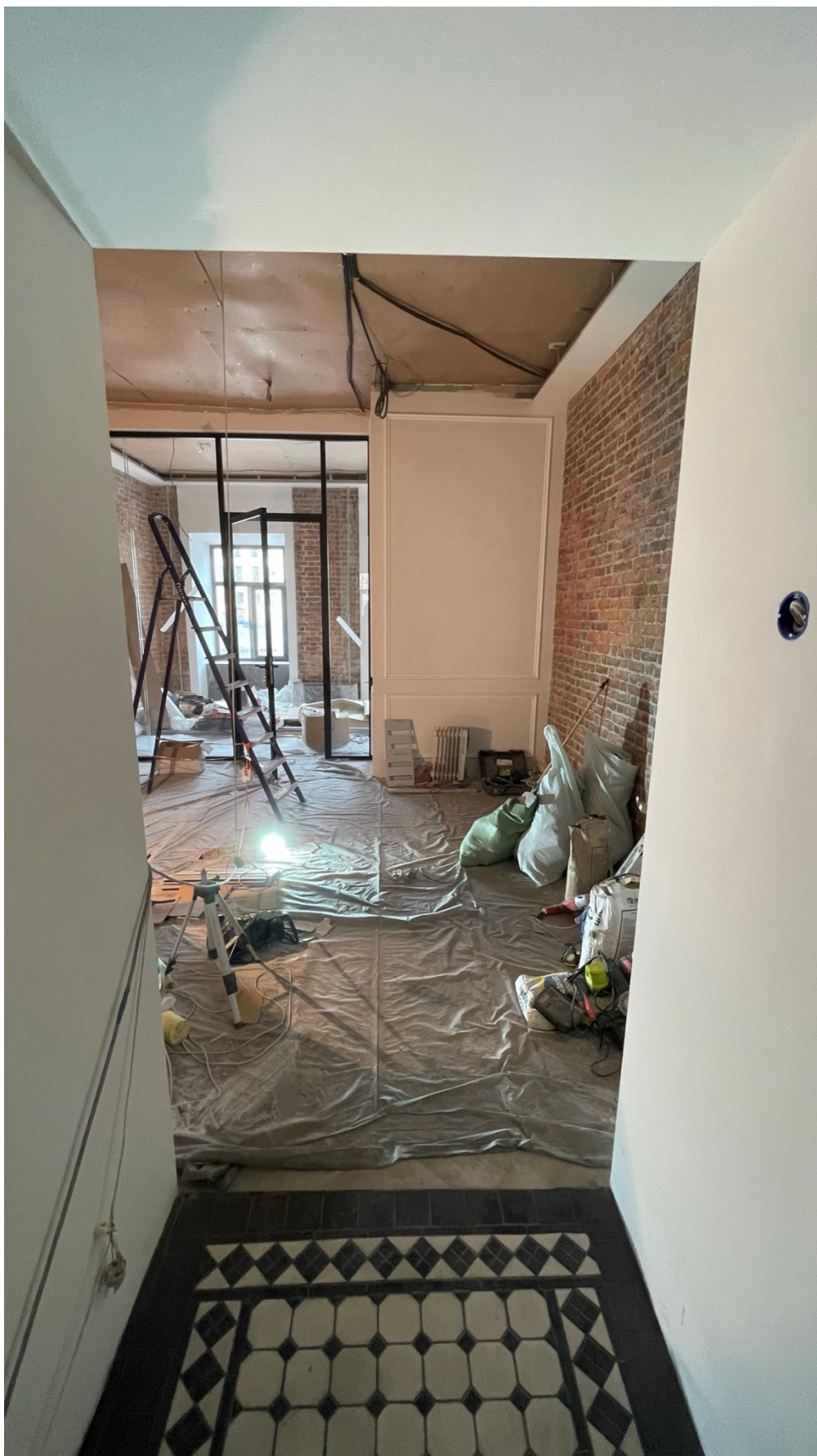
16.Фрагмент интерьера вестибюля (помещение №2);
