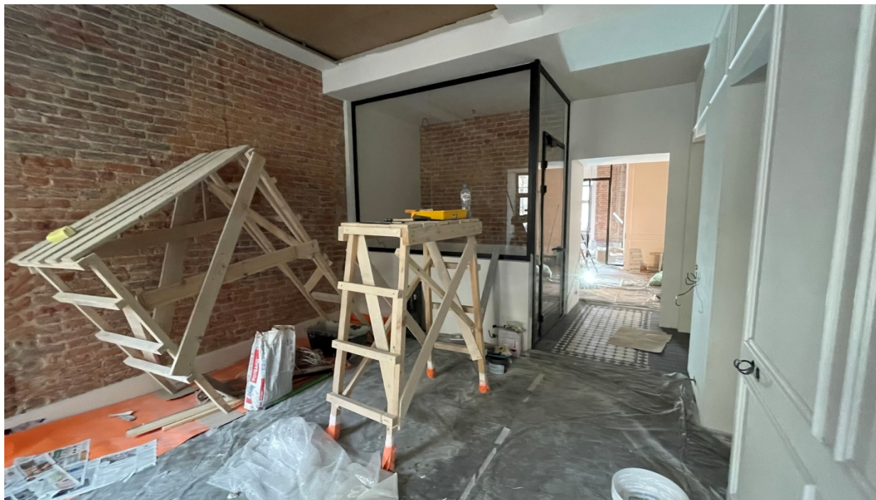
11. Фрагмент интерьера кабинета (помещение №4);
