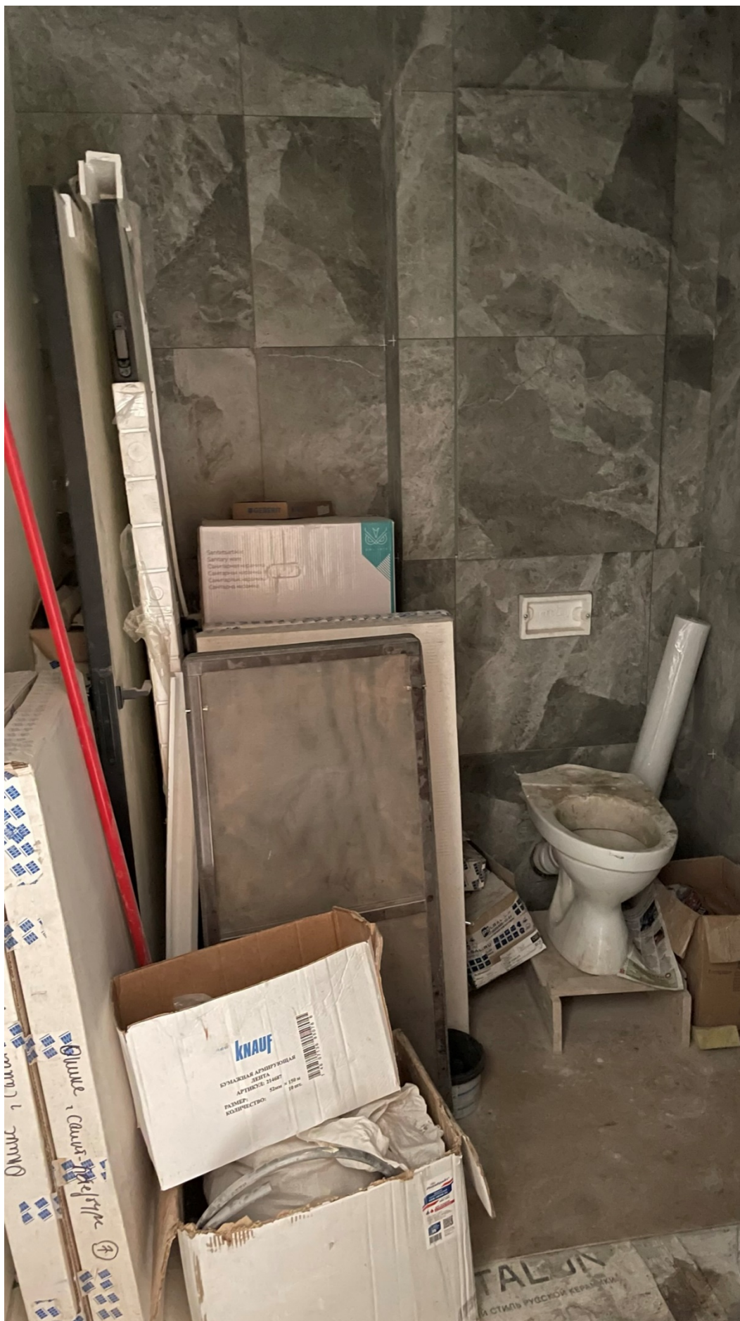
10. Фрагмент интерьера санузла (помещение №6);
