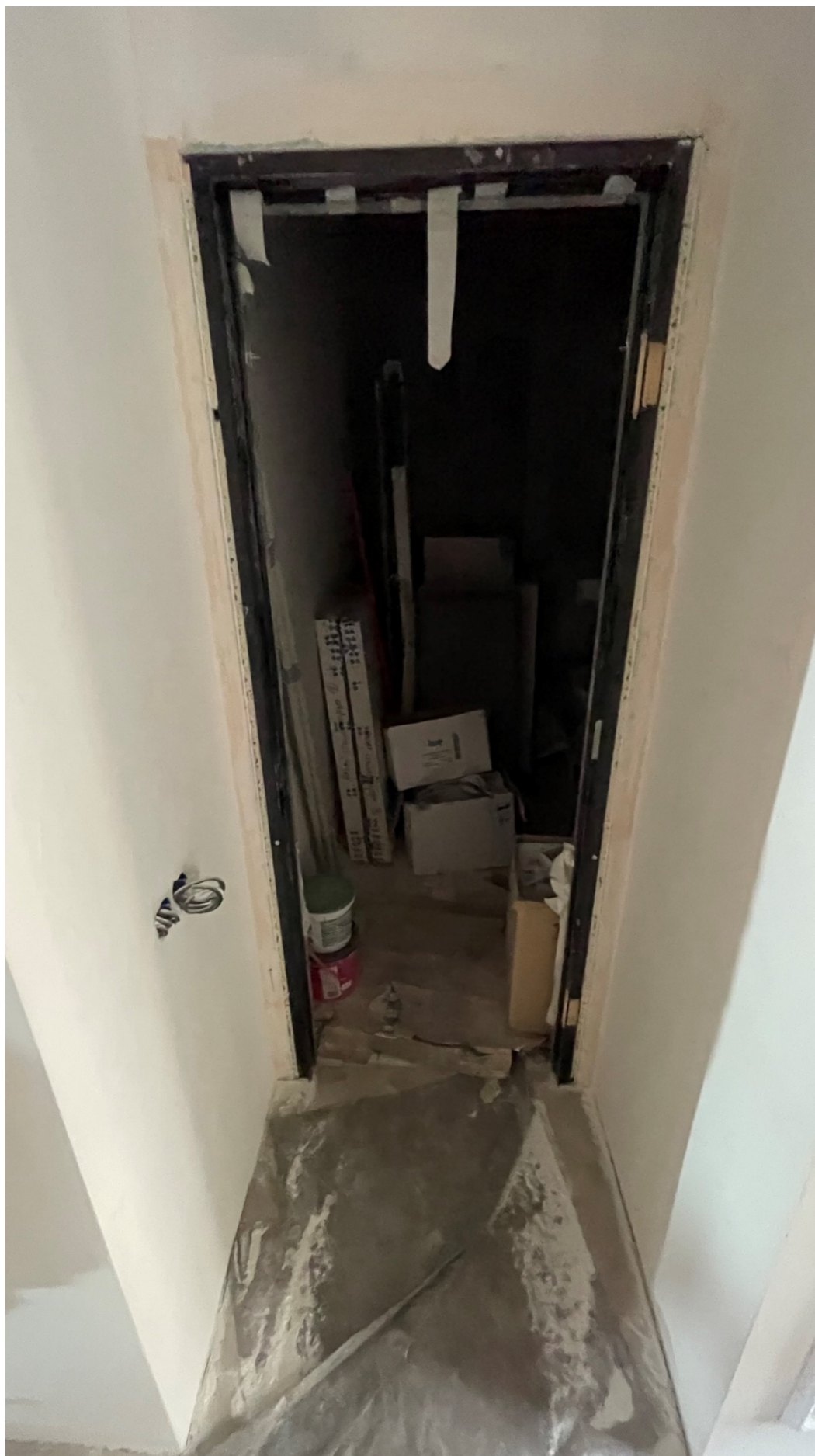
9. Вид на санузел (помещение №6);
