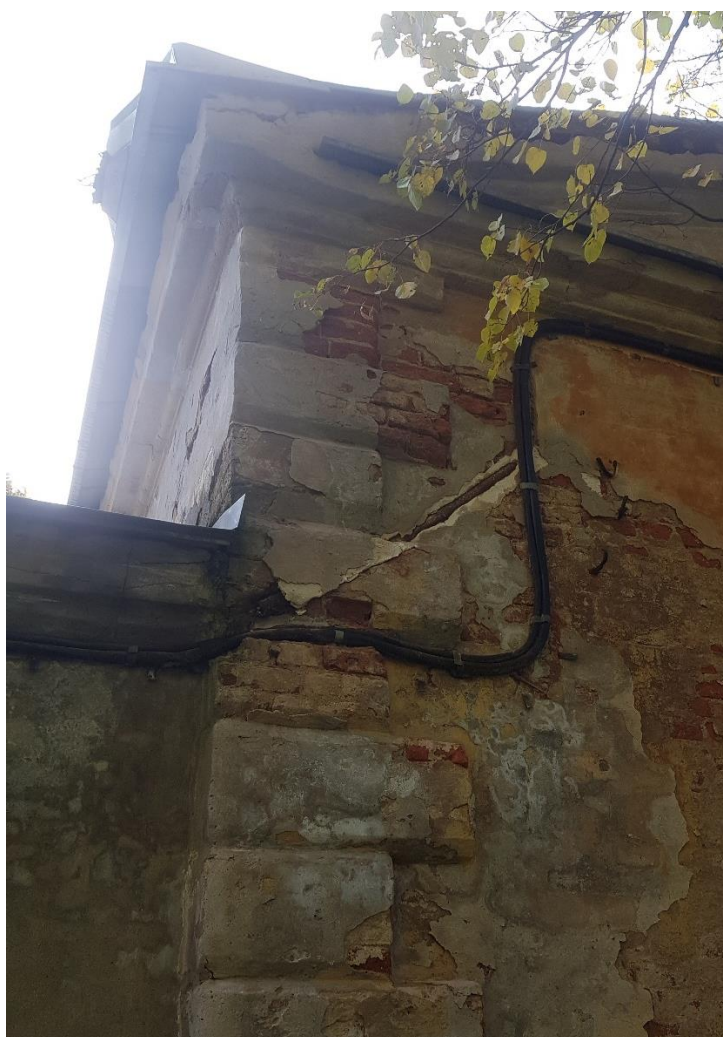
Фото 14. Руст. Фасад в осях 12-1.
