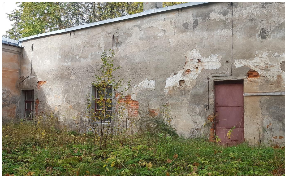
Фото 20. Фасад в осях 1-12.
