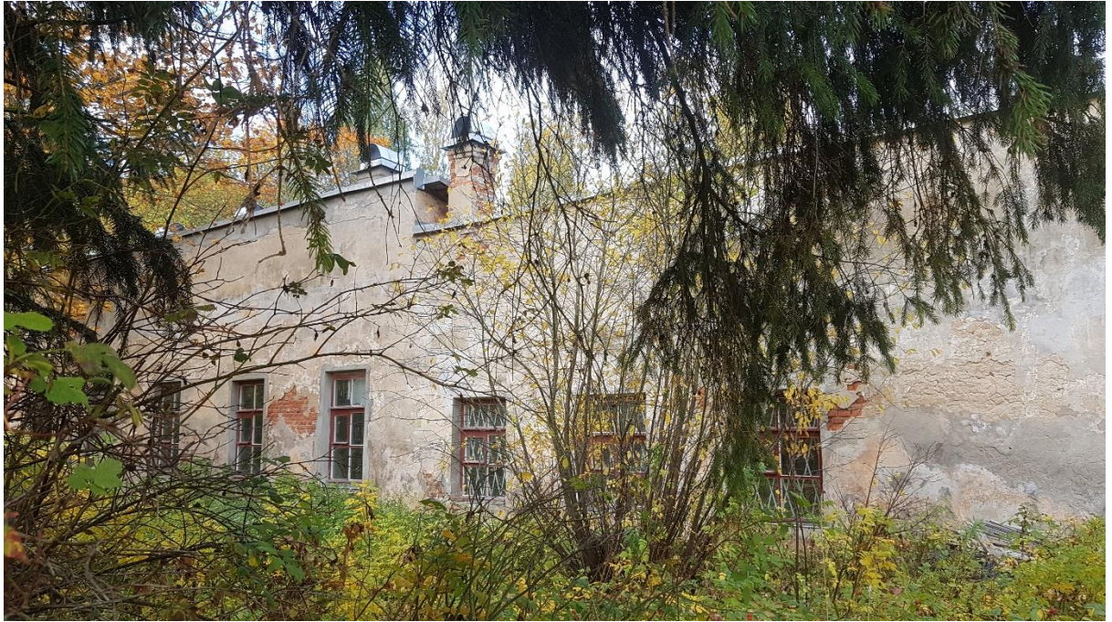
Фото 17. Фасад в осях 1-12.
