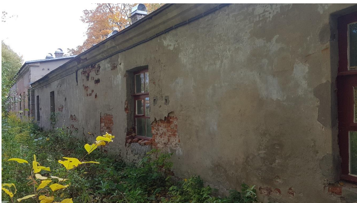
Фото 10. Фасад в осях 12-1. Правое крыло.
