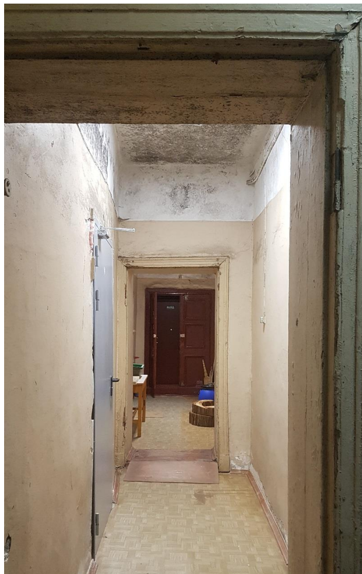
Фото 24. Коридор (пом. 24). Вид на входную дверь.
