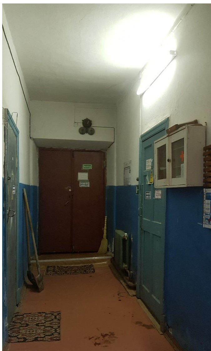
Фото 32. Коридор (пом. 1). Вид на входную дверь.
