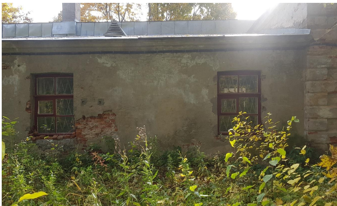
Фото 12. Фасад в осях 12-1. Правое крыло.
