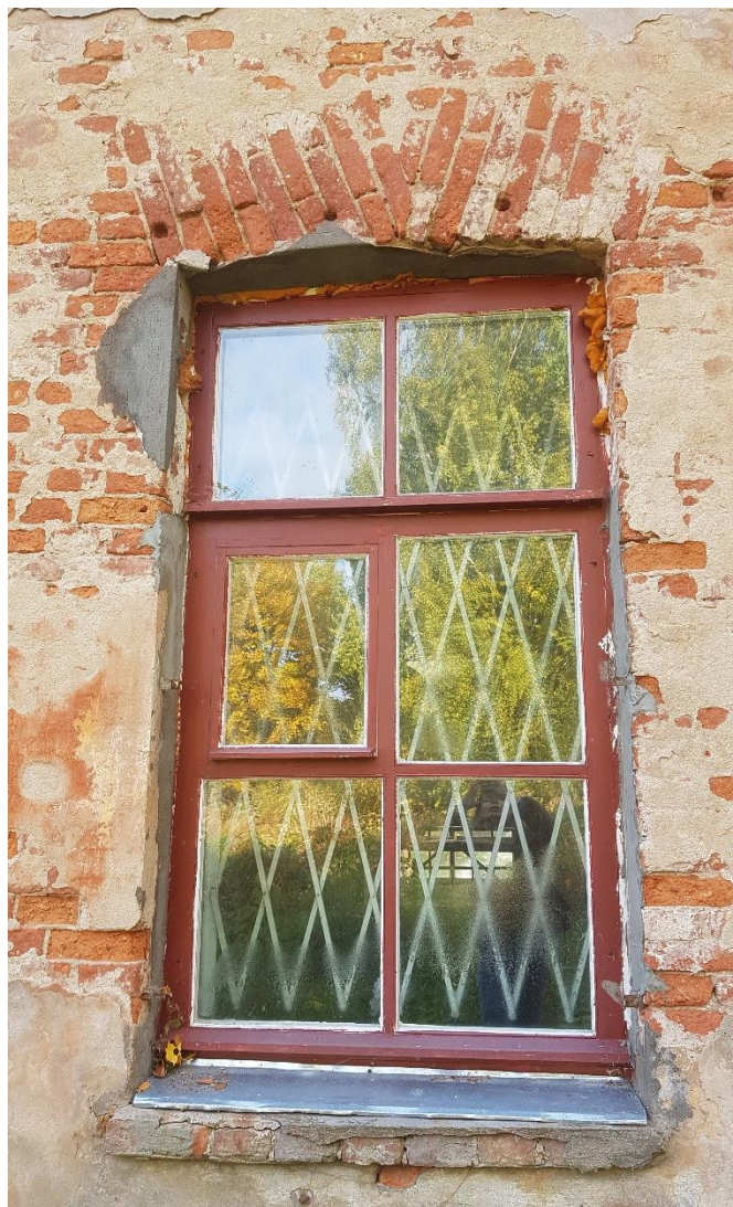
Фото 8. Оконный проем. Фасад в осях 12-1.
