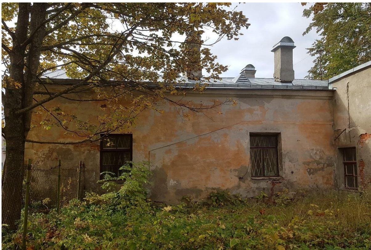
Фото 21. Фасад в осях А-Г.
