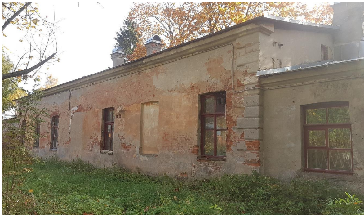
Фото 9. Фасад в осях 12-1. Центральная часть фасада.
