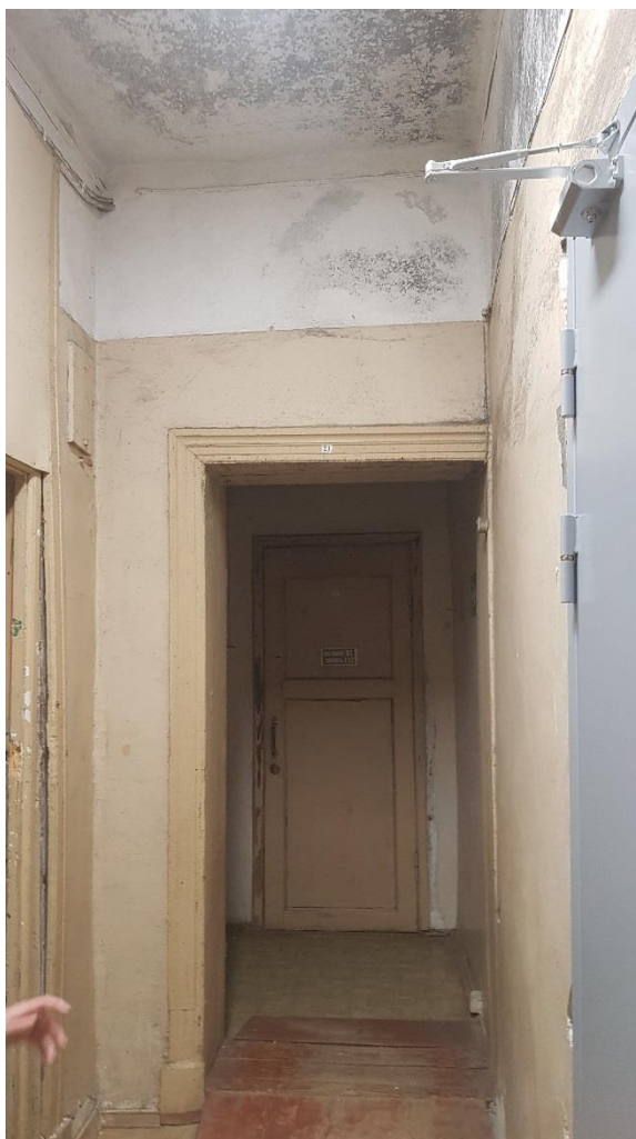
Фото 25. Коридор (пом. 24). Вид от входной двери.
