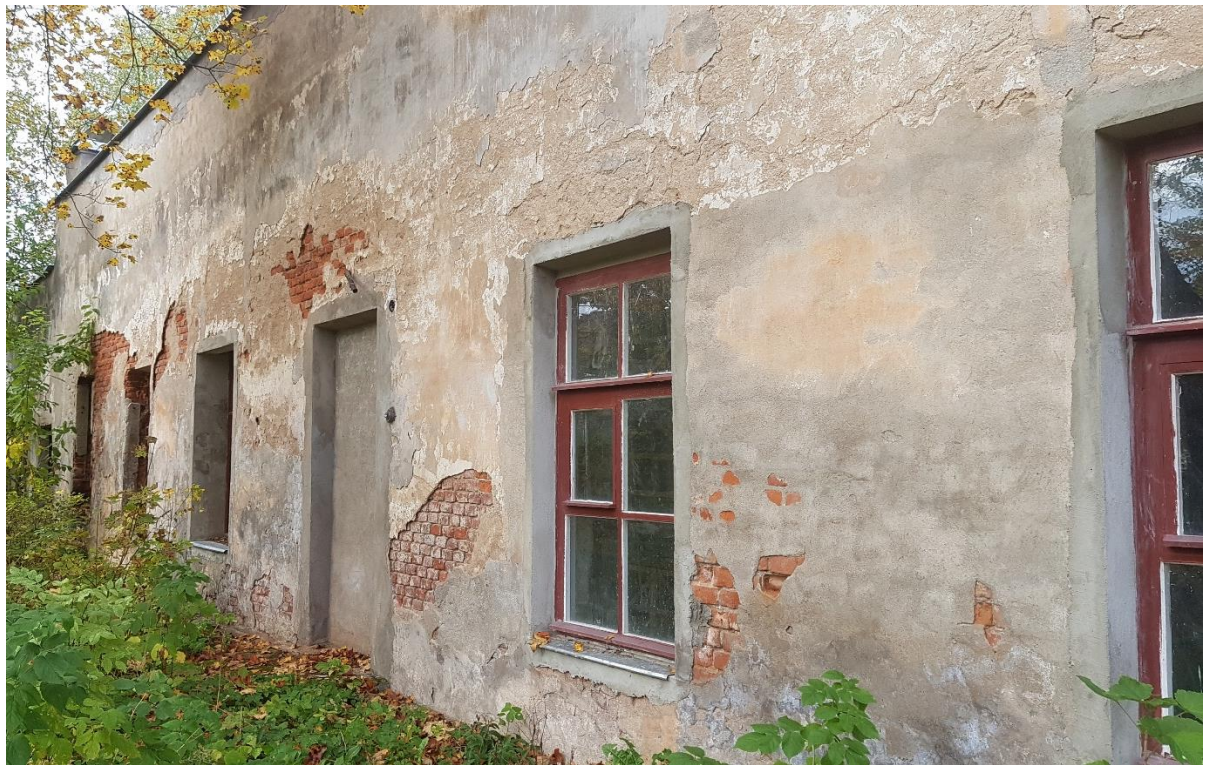
Фото 18. Фасад в осях 1-12.
