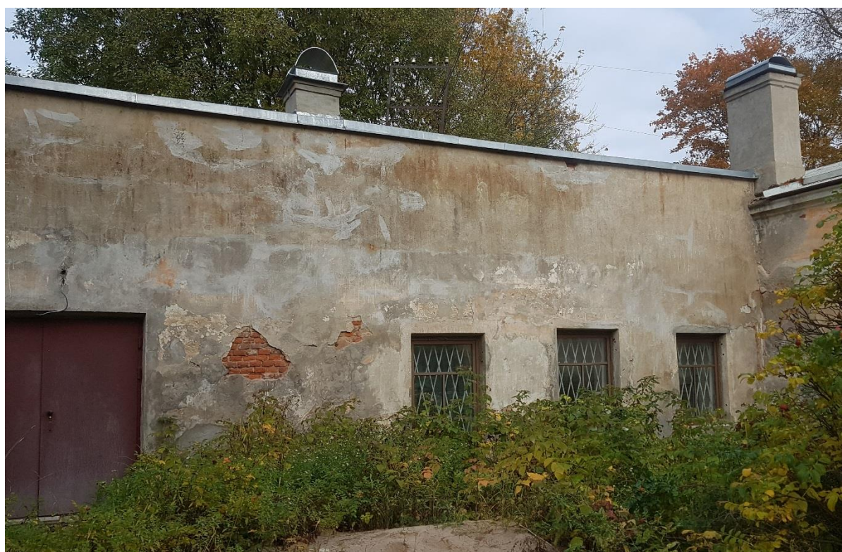
Фото 16. Фасад в осях 1-12.
