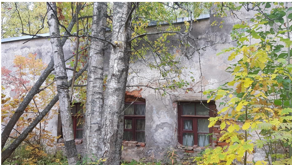
Фото 19. Фасад в осях 1-12.
