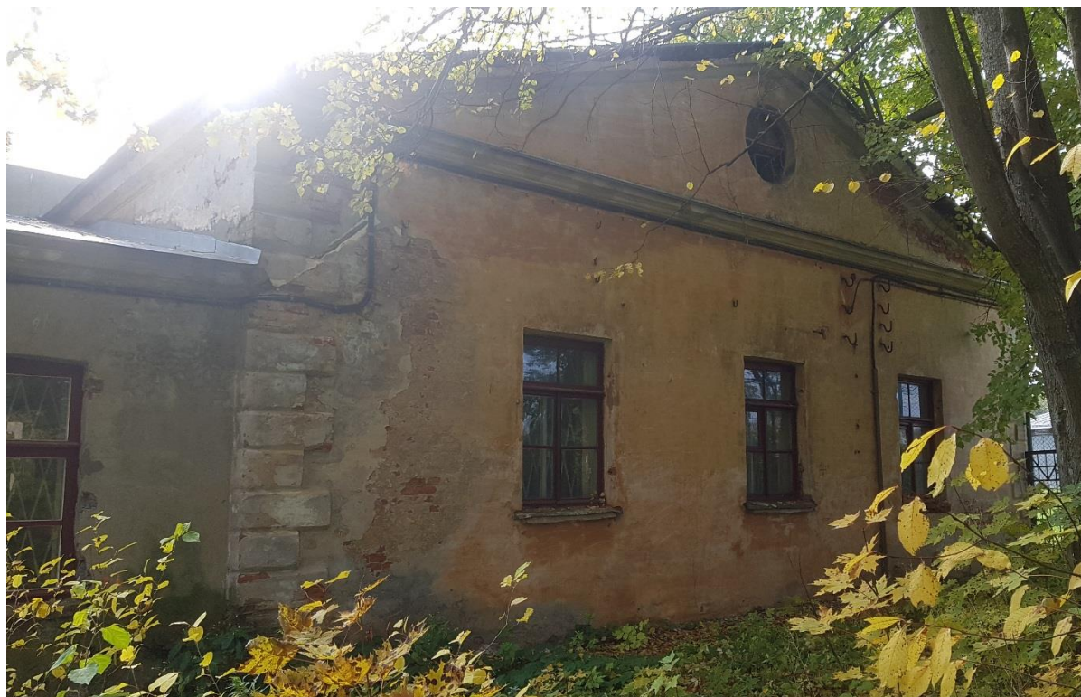
Фото 13. Фасад в осях 12-1. Правое крыло.
