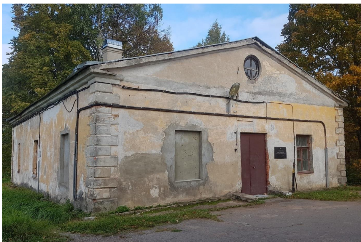
Фото 22. Фасад в осях 1-2.
