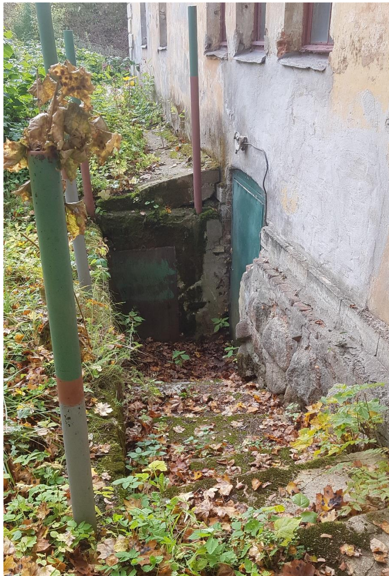
Фото 4. Прямок, вход в подвал. Фасад в осях А-Д.
