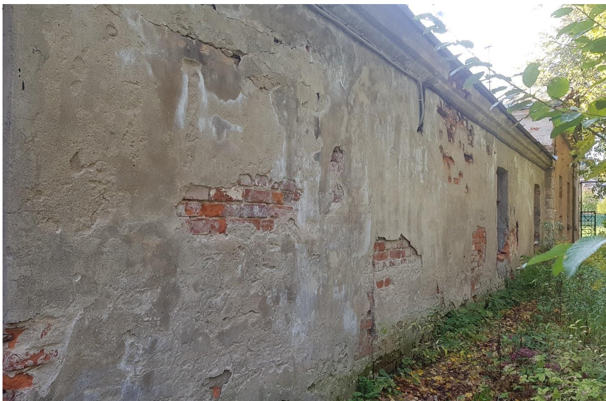
Фото 11. Фасад в осях 12-1. Правое крыло.
