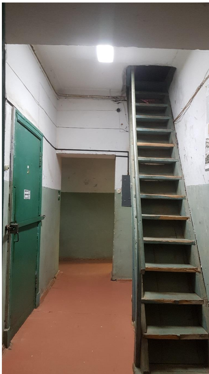
Фото 33. Коридор (пом. 1). Вид на деревянную лестницу.
