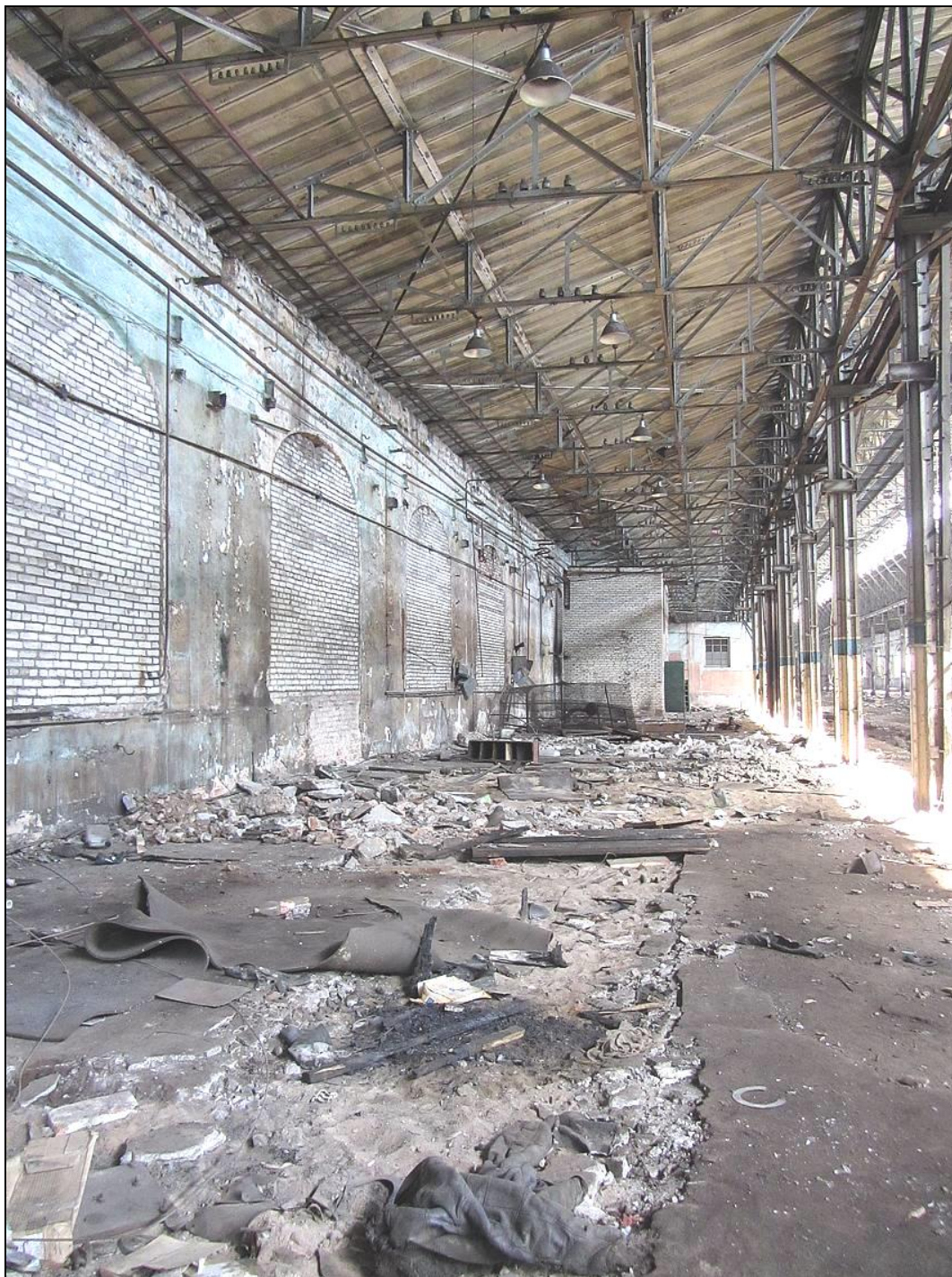
Илл. 36. Внутренне пространство здания. Вид на наружную юго-западную стену. Фотография. 2014 г.
