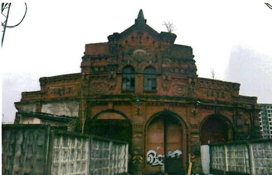
1. Юго-восточный торцевой фасад.
