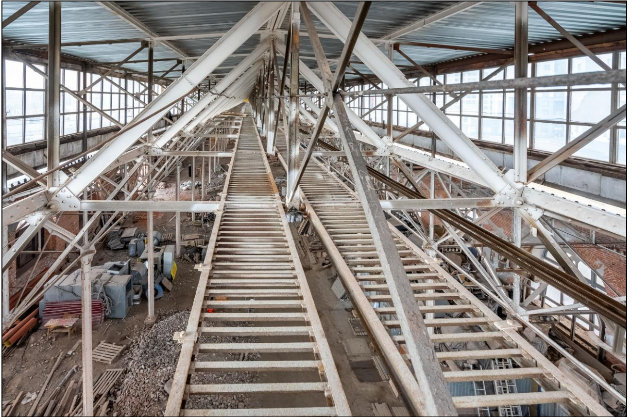
8. Объект культурного наследия регионального значения «Сарай для императорских поездов Варшавского вокзала», расположенного по адресу: г. Санкт-Петербург, участок ж/д «Варшавский вокзал – М. Митрофаньевская ул.», лит. Б. Конструкции фонаря верхнего освещения.
