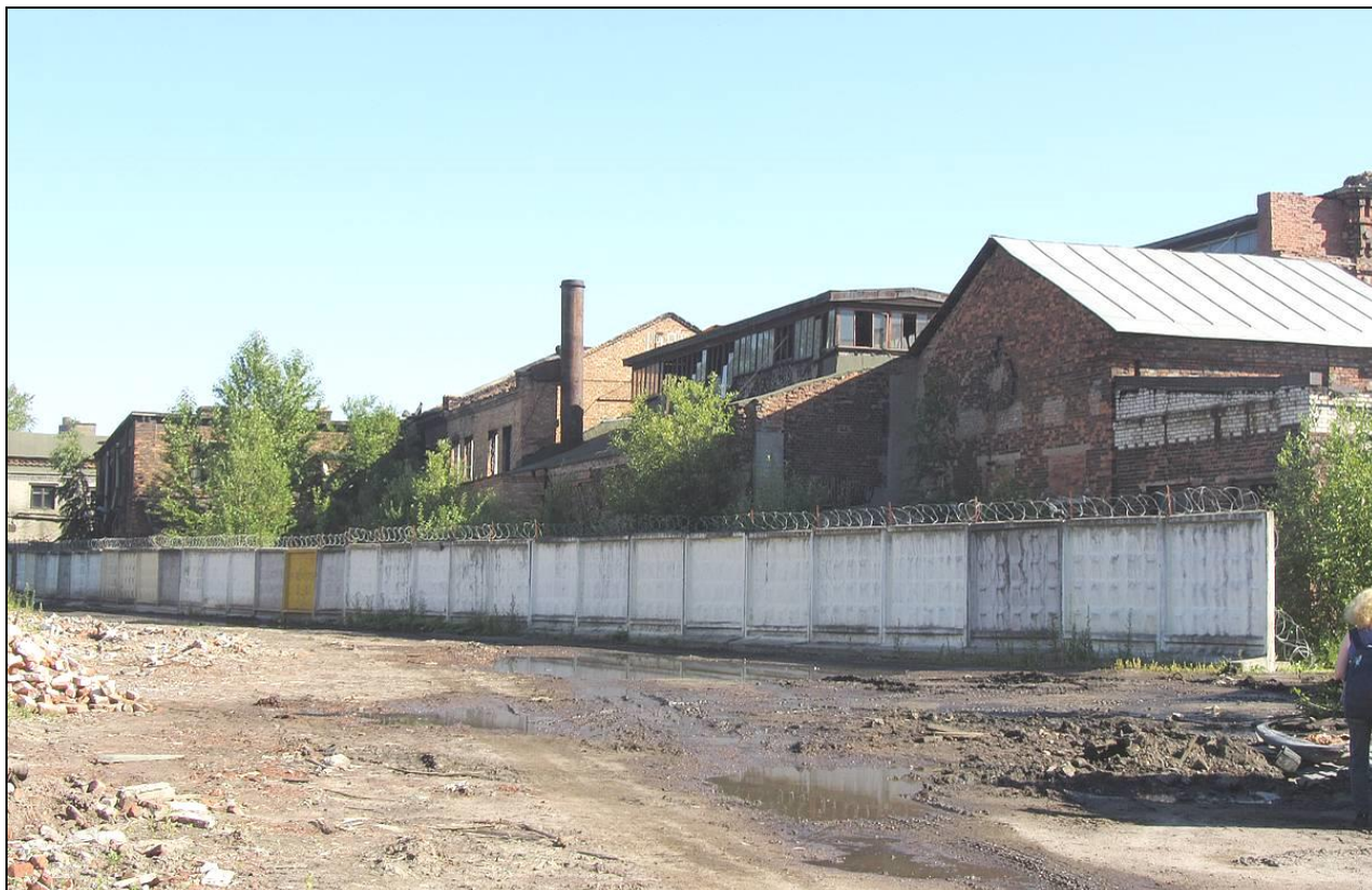
Илл. 30. Юго-западный фасад здания с перестроенными и поздними пристройками. Фотография. 2014 г.
