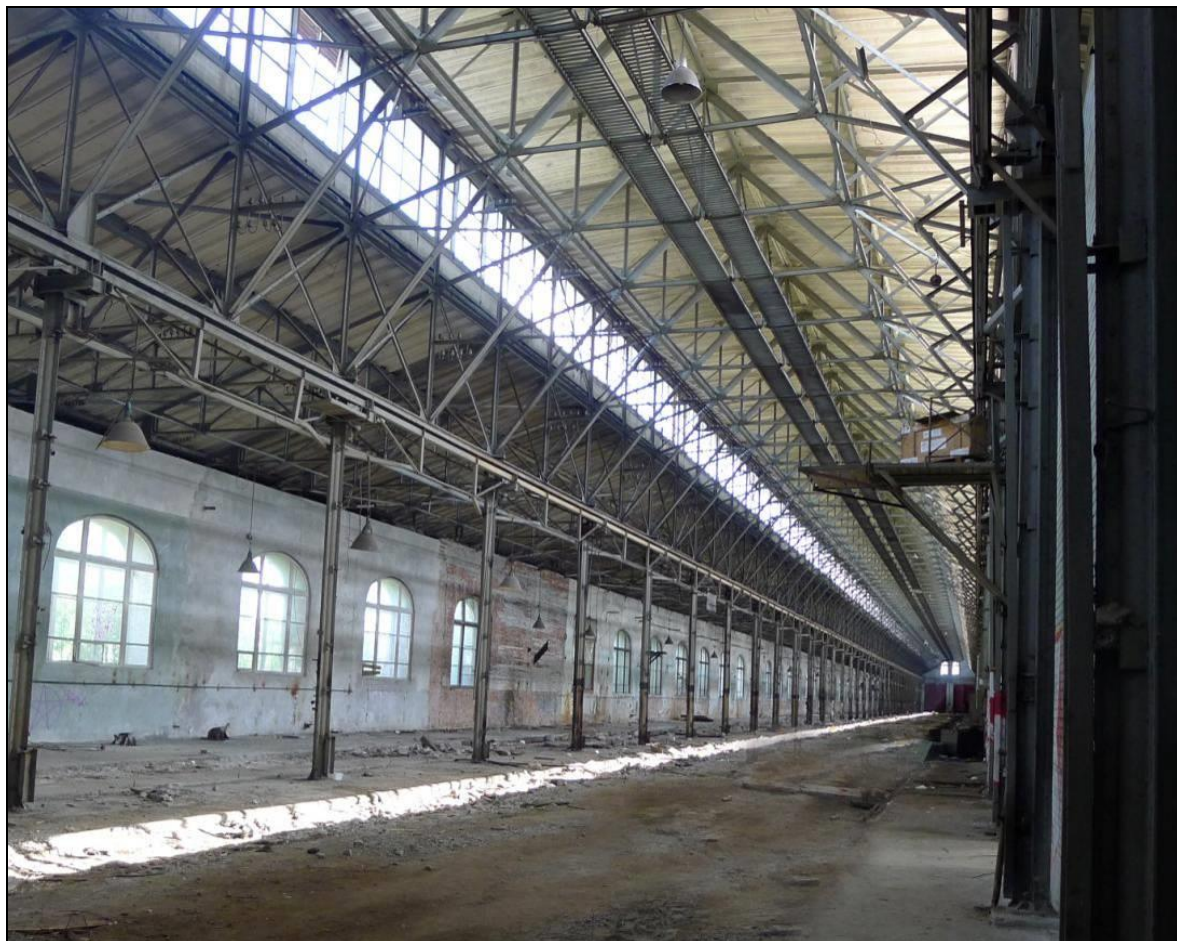
7. Объект культурного наследия регионального значения «Сарай для императорских поездов Варшавского вокзала», расположенного по адресу: г. Санкт-Петербург, участок ж/д «Варшавский вокзал – М. Митрофаньевская ул.», лит. Б. Внутренний металлический каркас здания: сборные металлические колонны с болтовым соединением и система металлических ферм перекрытия раскосного типа. Фрагмент.
