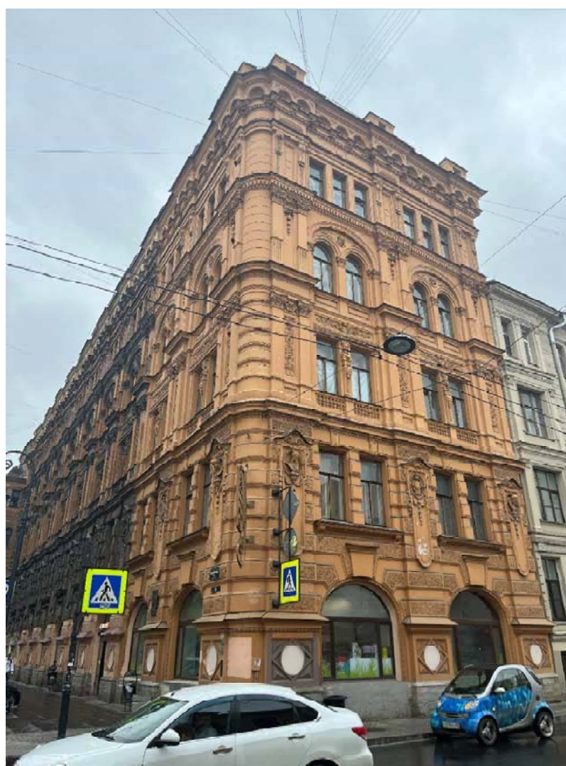
Фото №2. Западный лицевой фасад дома по улице Пушкинской.
