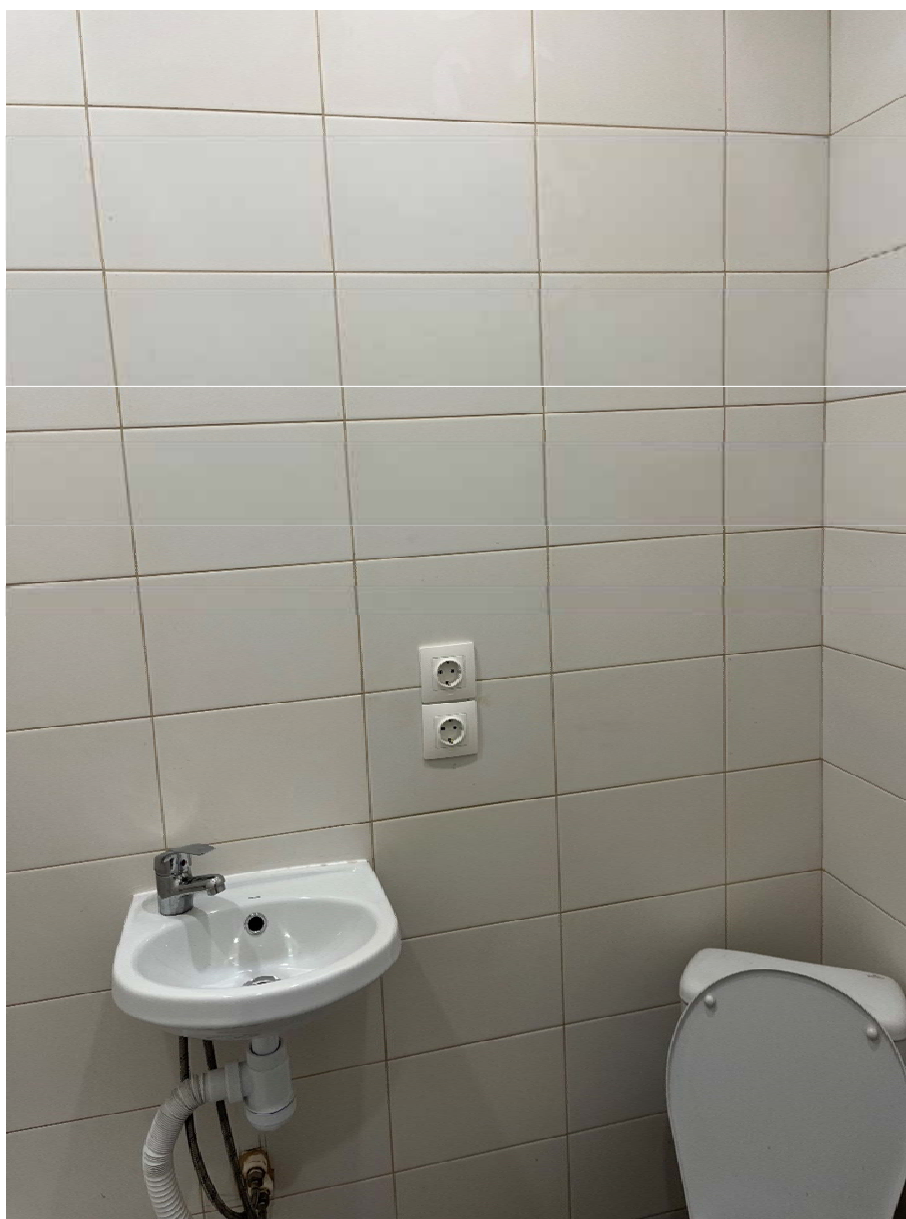
Фото №13. Квартира №9, санузел.
