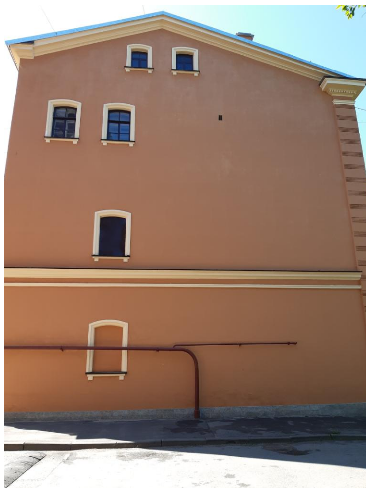
Фото 6. Фрагмент лицевого фасада выявленного объекта культурного наследия «Жилой дом» (Гражданская ул., 15)
