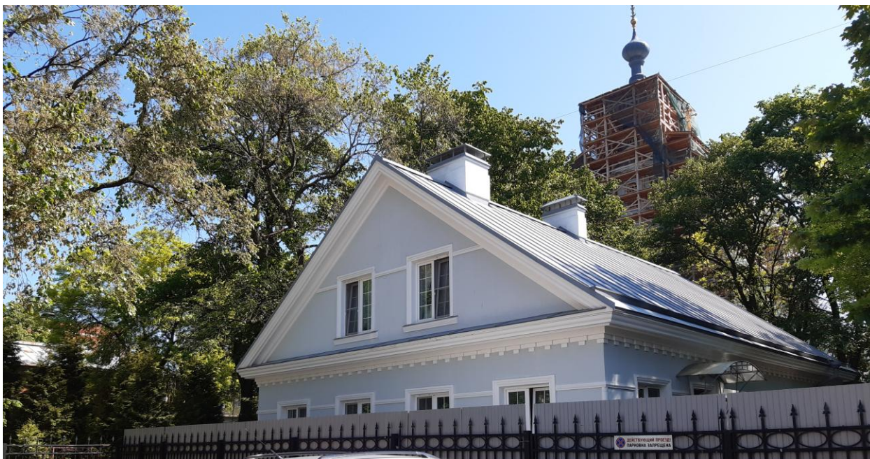
Фото 1. Фрагмент лицевого фасада объекта культурного наследия регионального значения «Служба», входящего в состав объекта культурного наследия регионального значения «Комплекс построек Владимирского собора с часовней, домом церковнослужителей, службой, садом и оградой»
