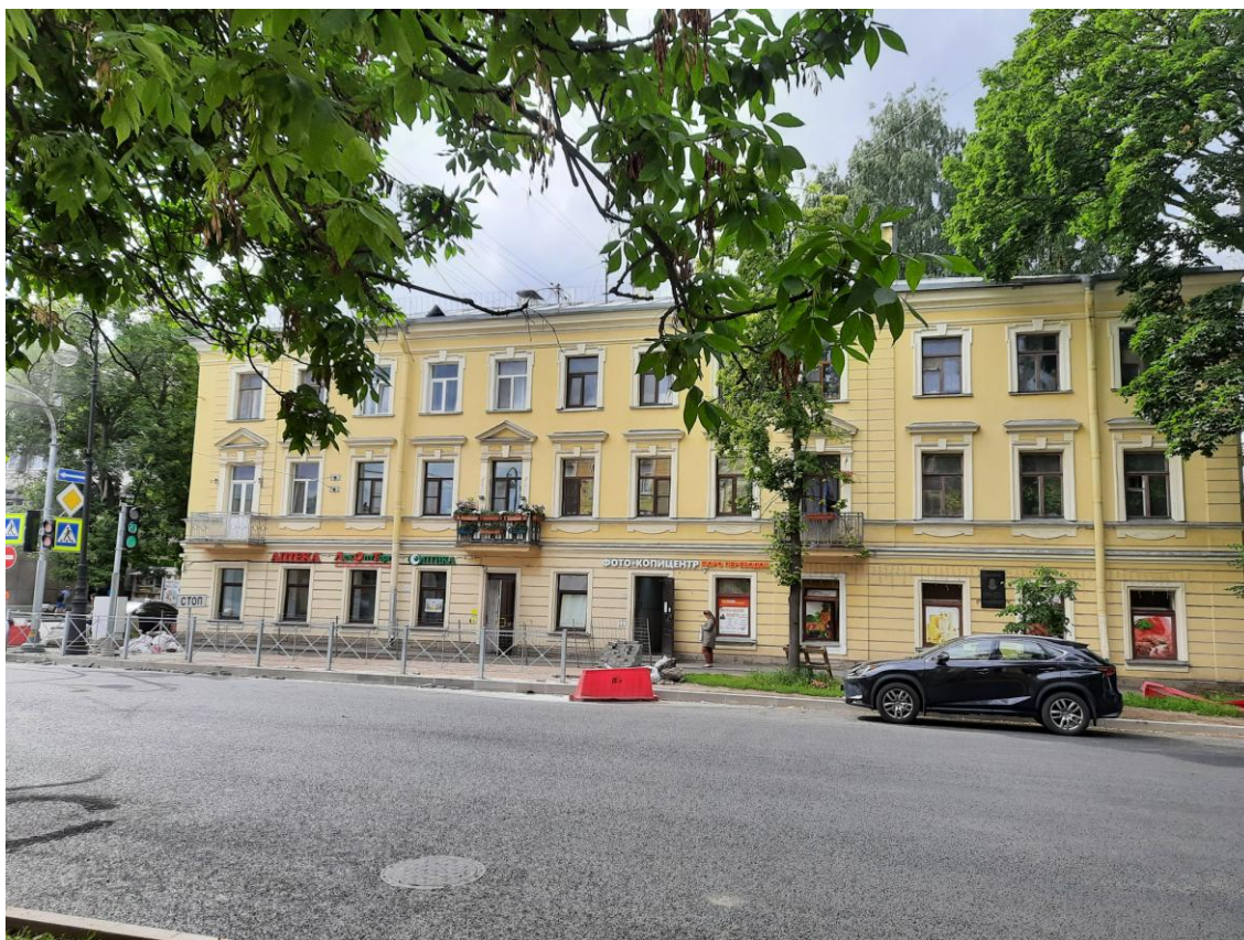
Фото 17. Фрагмент лицевого фасада объекта культурного наследия регионального значения «Жилой дом» (Гражданская ул., 7/11)
