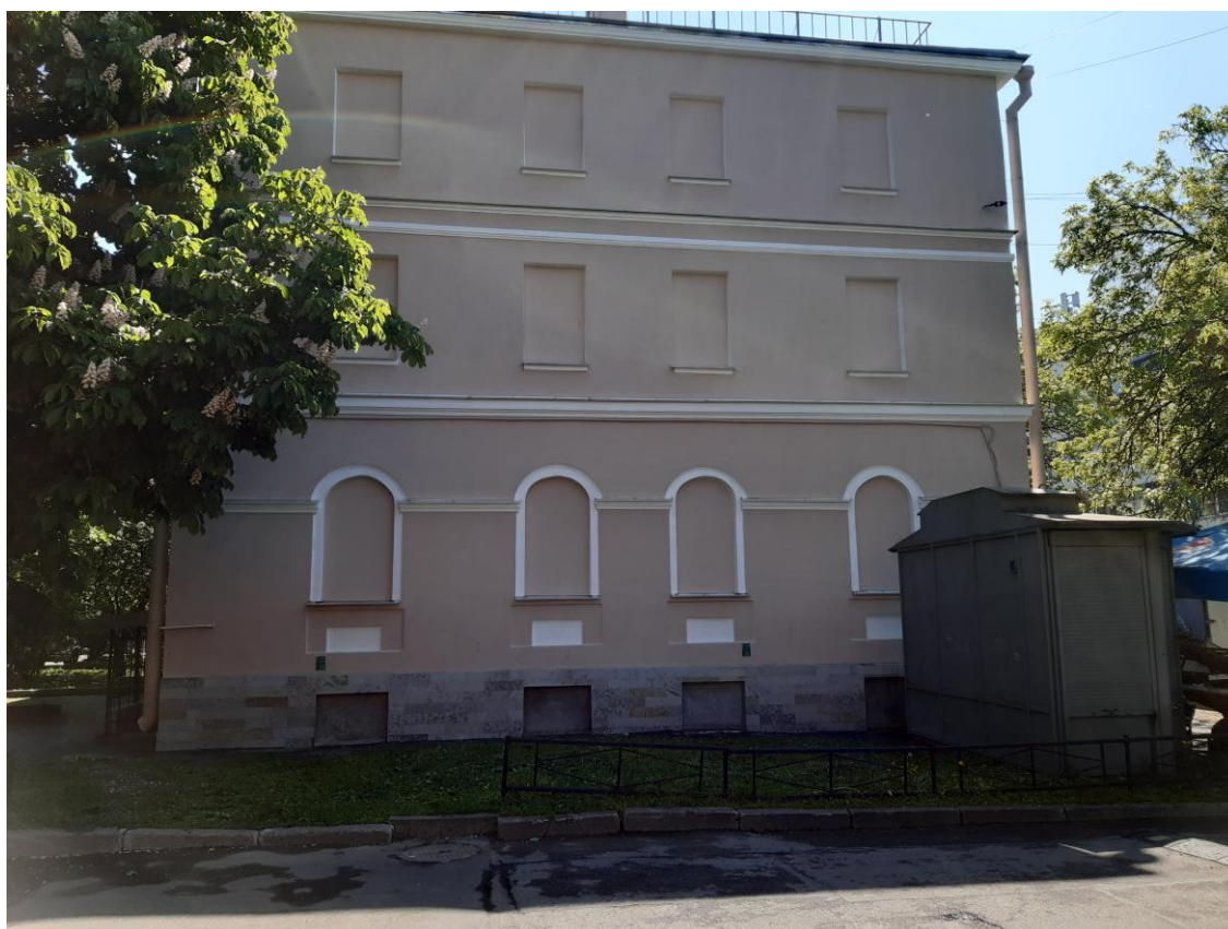
Фото 10. Фрагмент лицевого фасада выявленного объекта культурного наследия «Жилой дом» (Гражданская ул., 11)
