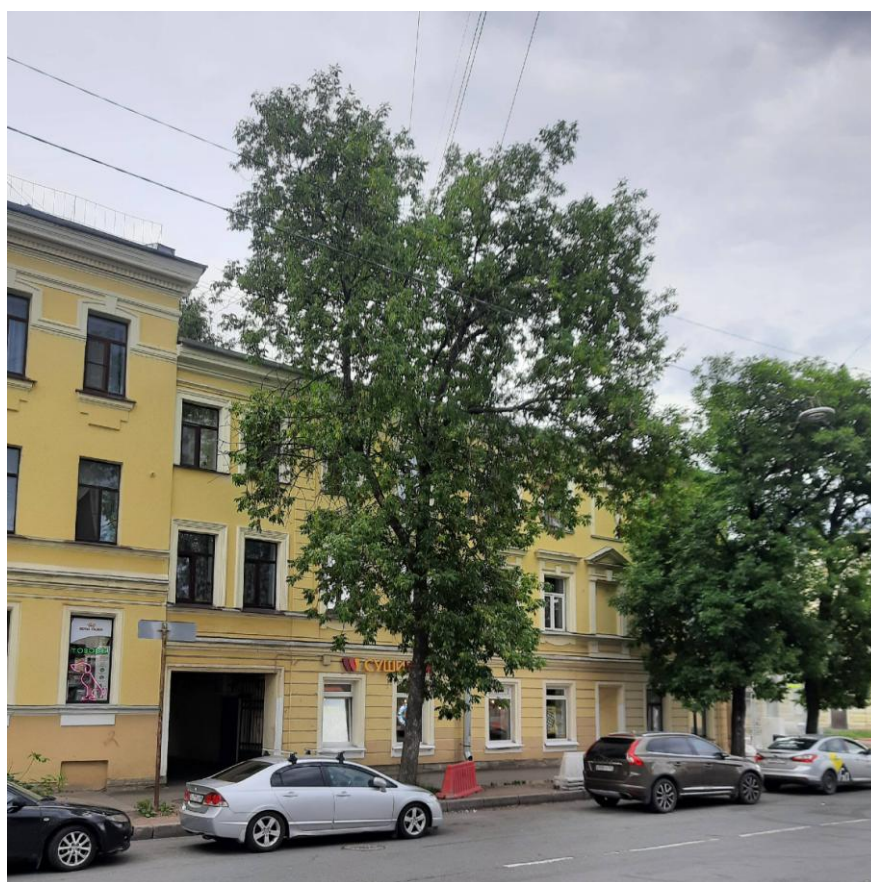
Фото 18. Фрагмент лицевого фасада объекта культурного наследия регионального значения «Жилой дом» (Гражданская ул., 7/11)
