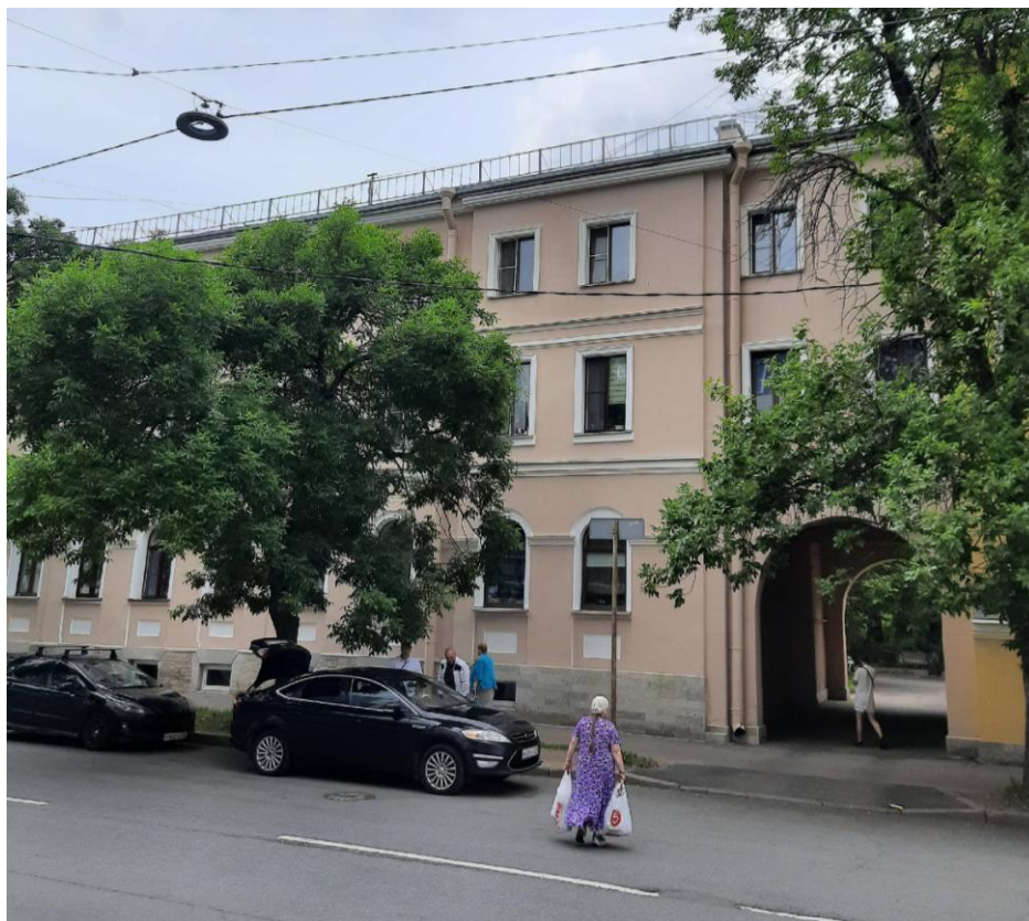
Фото 9. Фрагмент лицевого фасада выявленного объекта культурного наследия «Жилой дом» (Гражданская ул., 11)
