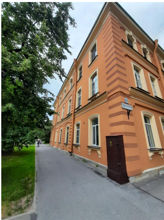
Фото 7. Фрагмент лицевого фасада выявленного объекта культурного наследия «Жилой дом» (Гражданская ул., 15)
