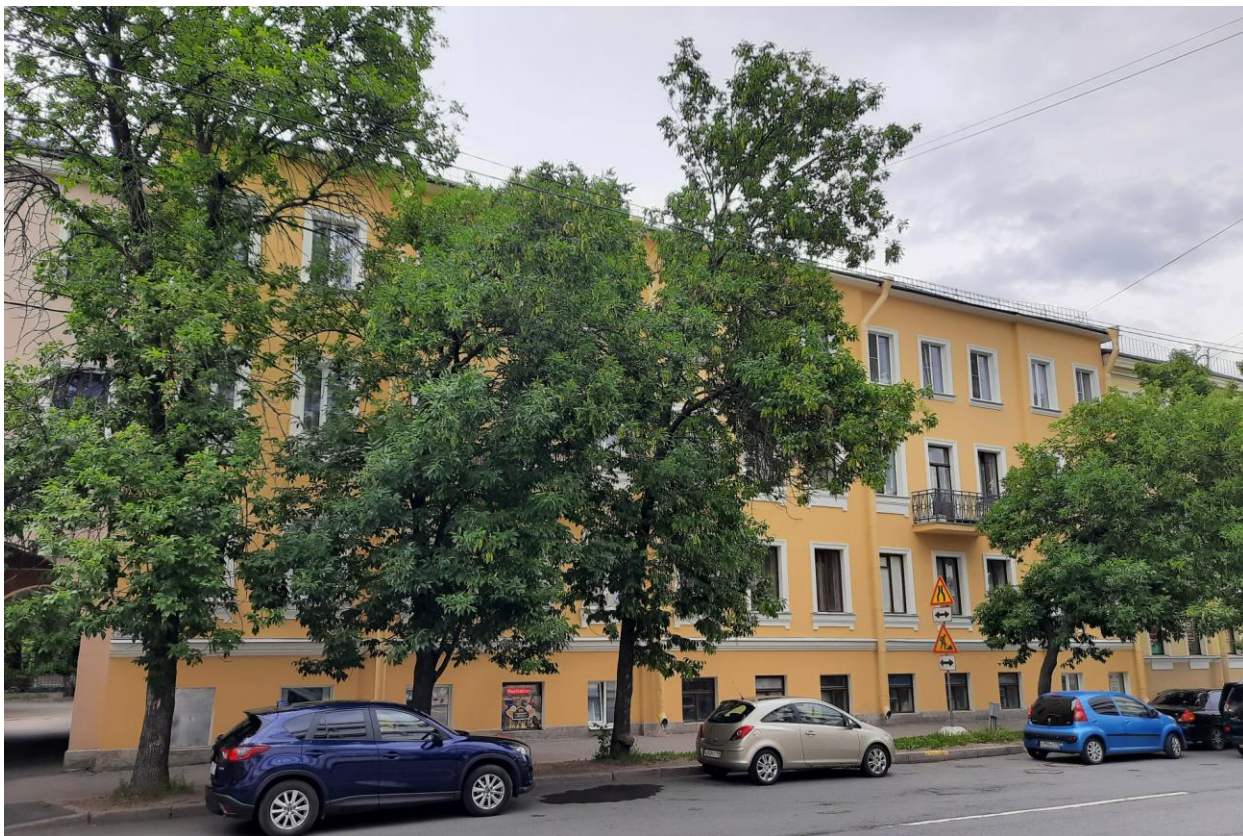
Фото 13. Фрагмент лицевого фасада выявленного объекта культурного наследия «Жилой дом» (Гражданская ул., 9)
