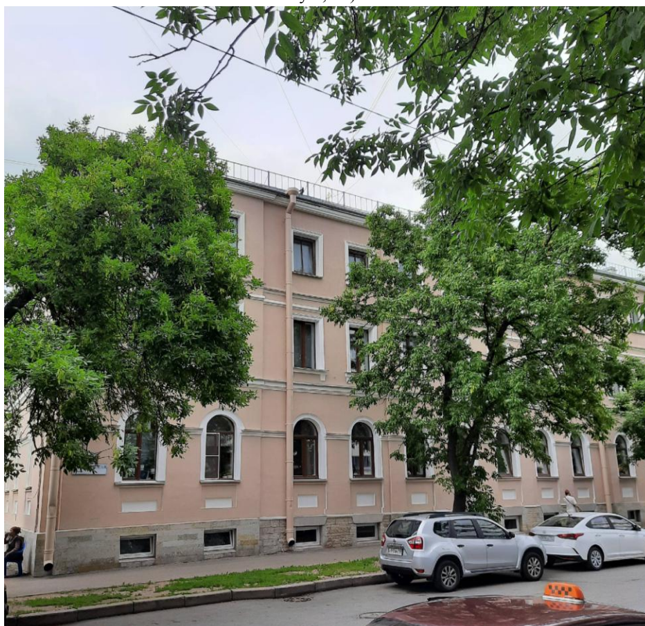
Фото 8. Фрагмент лицевого фасада выявленного объекта культурного наследия «Жилой дом» (Гражданская ул., 11)
