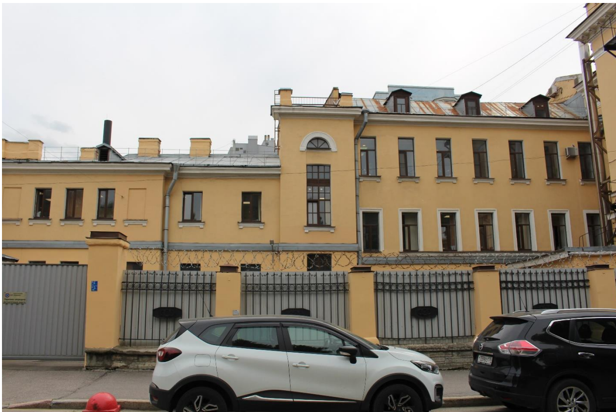
Фото 5. Вид на северный фасад дворовых корпусов.
