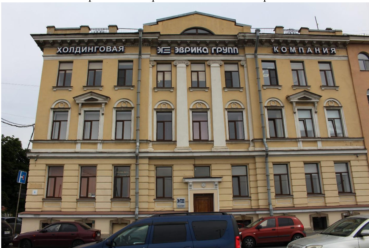
Фото 2. Вид на западный фасад лицевого корпуса.
