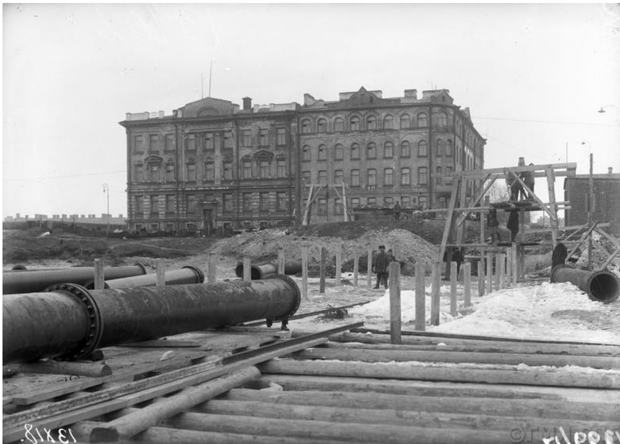
Илл. 11. Водопроводные работы. Переход через Неву. Вид на береговую часть работ. 1928 г. (источник: Государственный музей истории Санкт-Петербурга. ГМИ СПб 221781).
