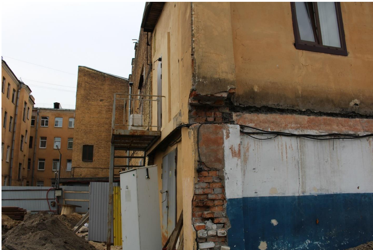
Фото 11. Вид на юго-восточный угол дворового корпуса (литера А1).
