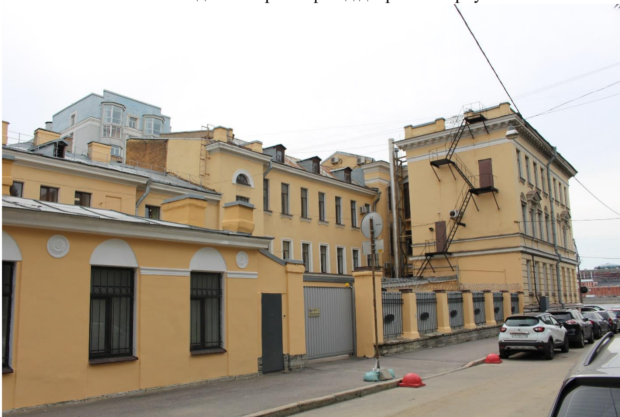
Фото 6. Вид на здание с северо-востока.
