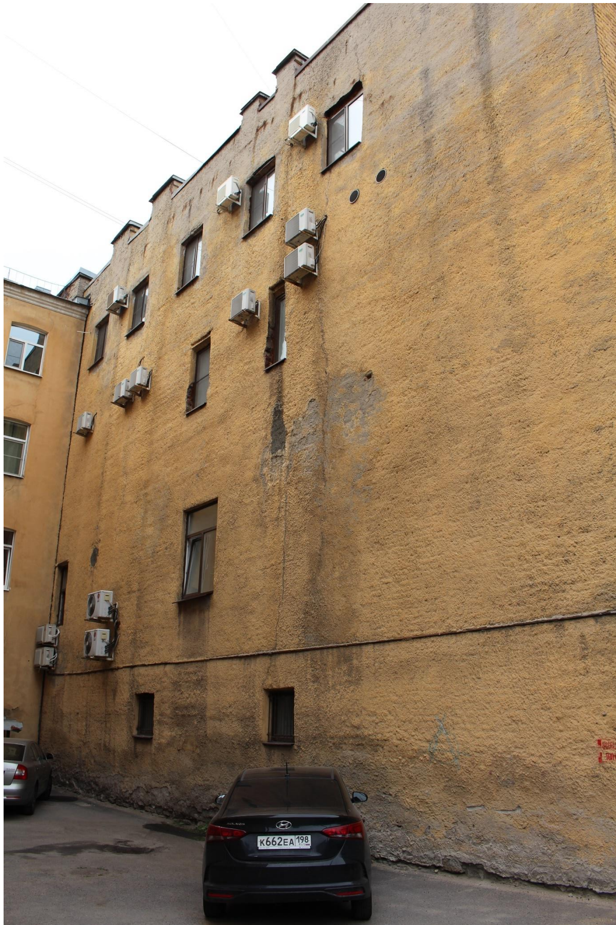
Фото 8. Вид на южную стену лицевого корпуса.
