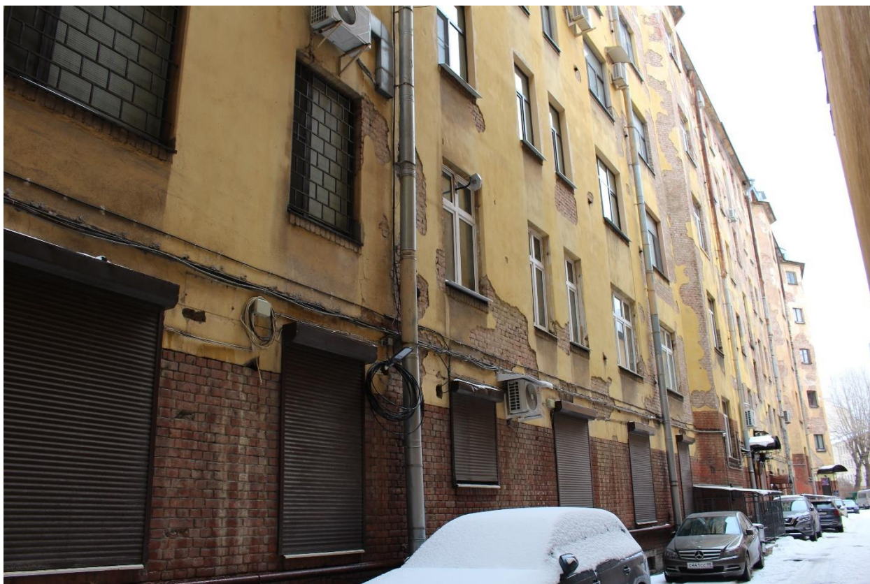
Фото 22. Вид на западную часть юго-западного дворового фасада.
