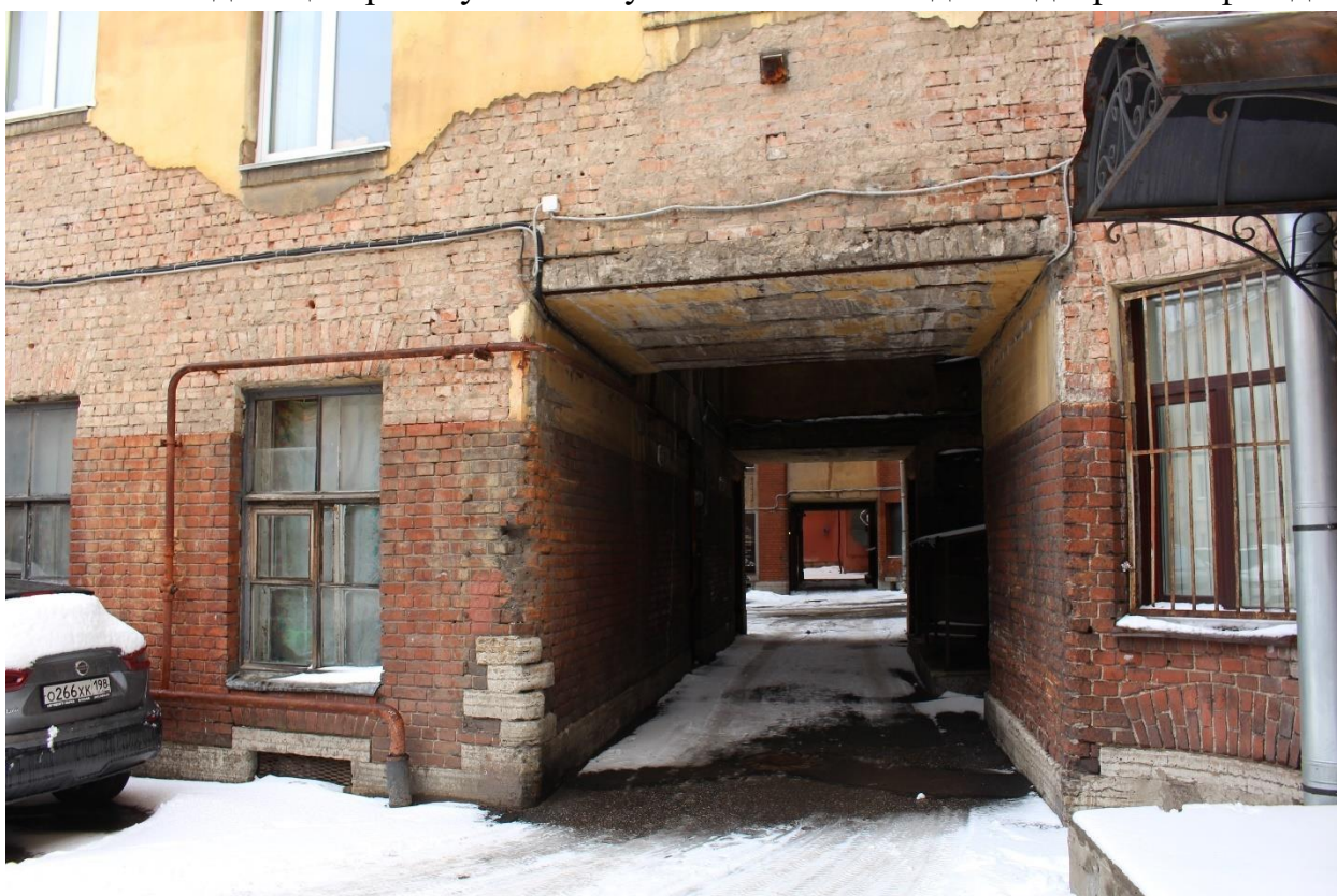
Фото 29. Арка воротного проезда в юго-восточном углу здания.
