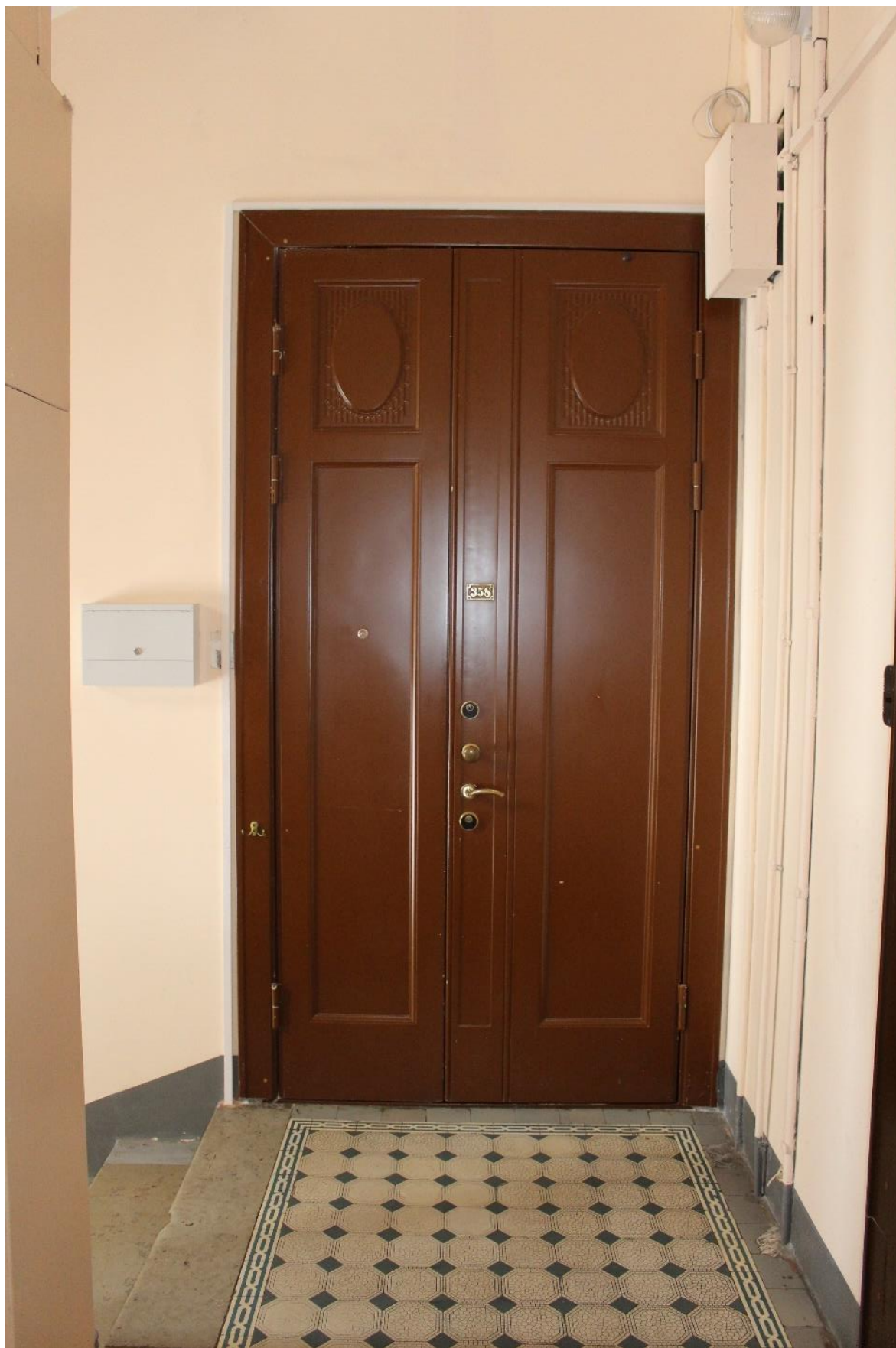
Фото 32. Вид на входные двери в квартиру № 358.
