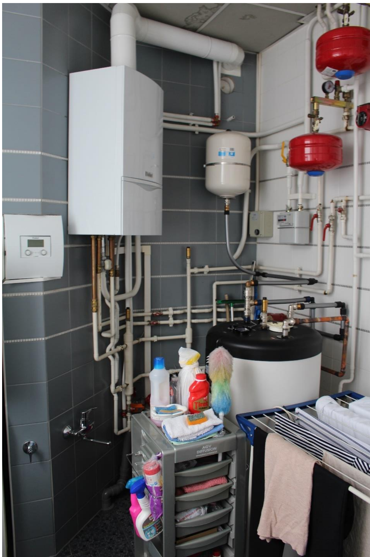
Фото 56. Вид на помещение № 10.
