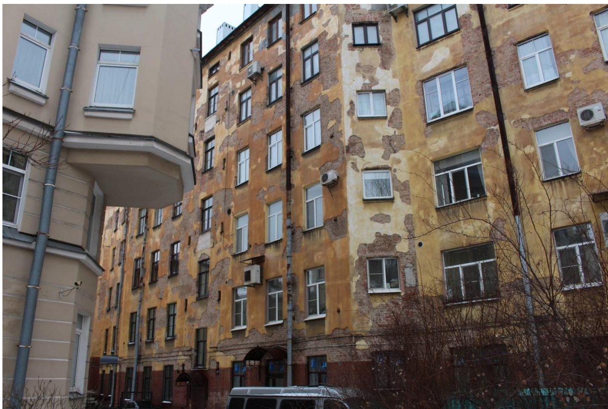
Фото 24. Вид на западную часть юго-западного дворового фасада
