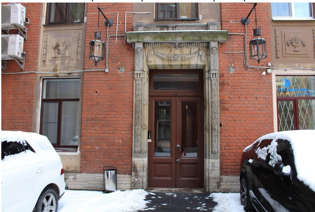
Фото 31. Вид на вход в лестничную клетку № 8.
