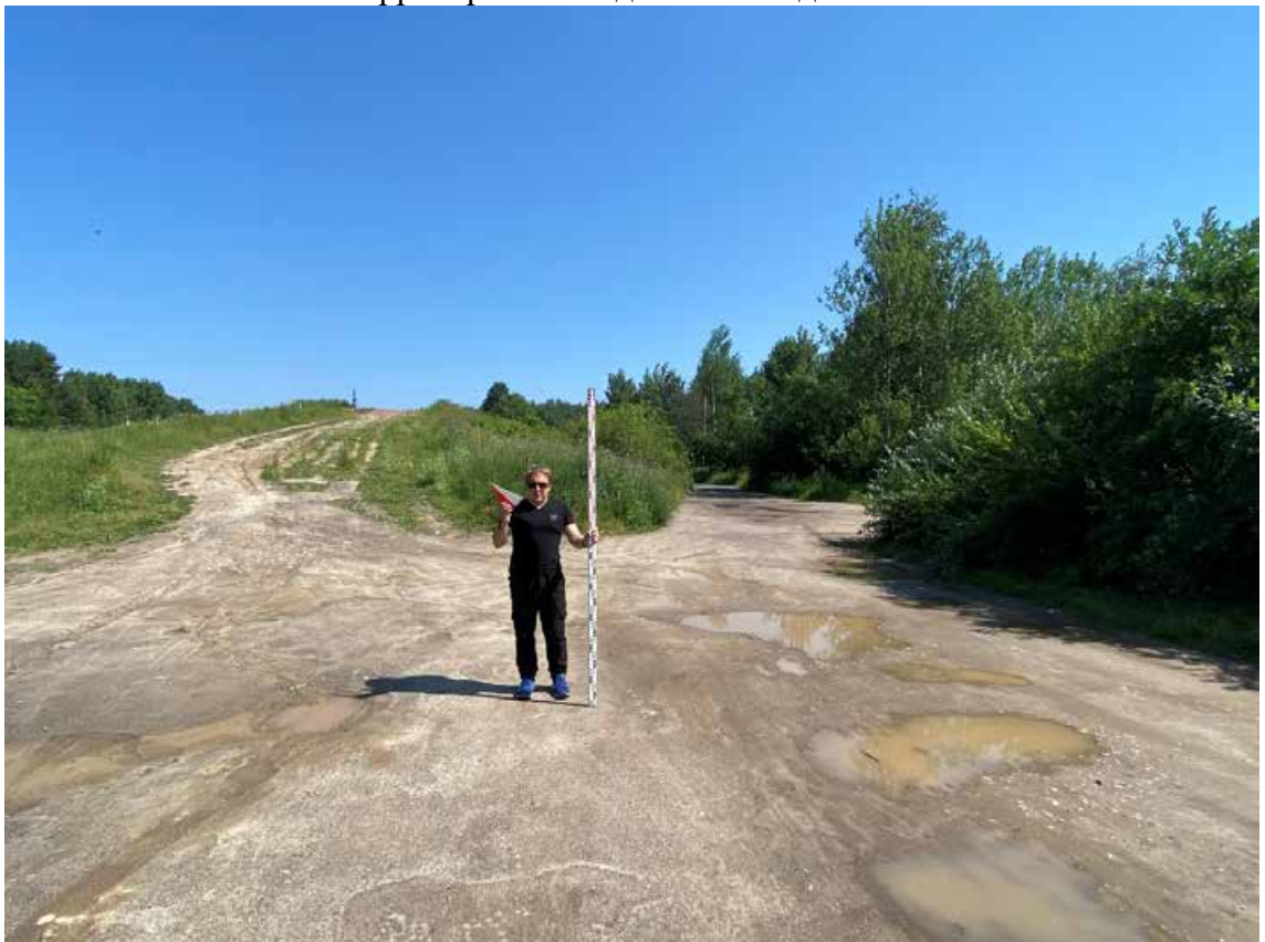
Рис. 14. СПб, Красногвардейский район, Водопроводная улица. Photo 2. Общий вид территории обследования. Вид с ЮЗ.
