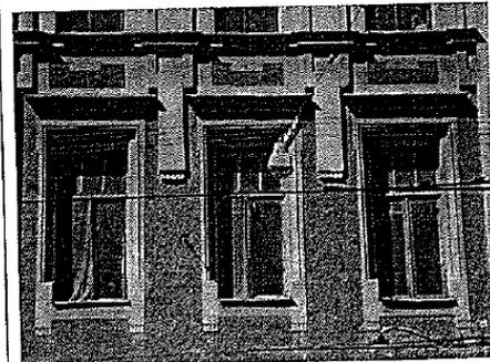
портал в центральном ризалите (7-я световая ось от угла) по Кронверкскому пр., с лепным цветочным орнаментом в характере модерна (розы), линейным профилированным сандриком с дентикулами, килевидным вимпергом над полуциркульным профилированным проемом;
