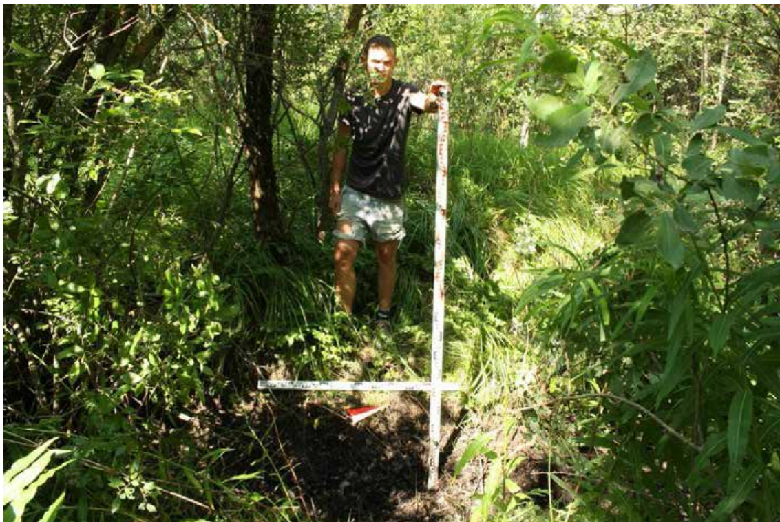
Рис. 132. Санкт-Петербург-2022. Земельный участок с кадастровым № 78:14:0772303:49. Зачистка 4. Участок северо-западной стенки канавы до начала работ. Вид с юго-востока
