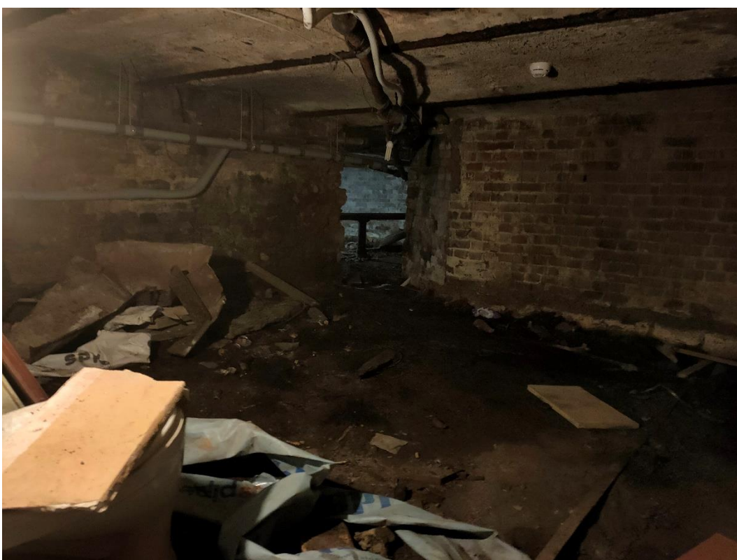
20. «Особняк Штифтер», ул. Моховая, д.15, лит. А. Подвал. Общий вид. Фото 22.07.2022г.
