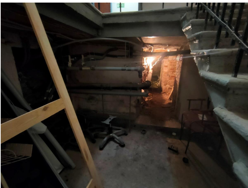
16. «Особняк Штифтер», ул. Моховая, д.15, лит. А. Подвал. Общий вид. Фото 22.07.2022г.
