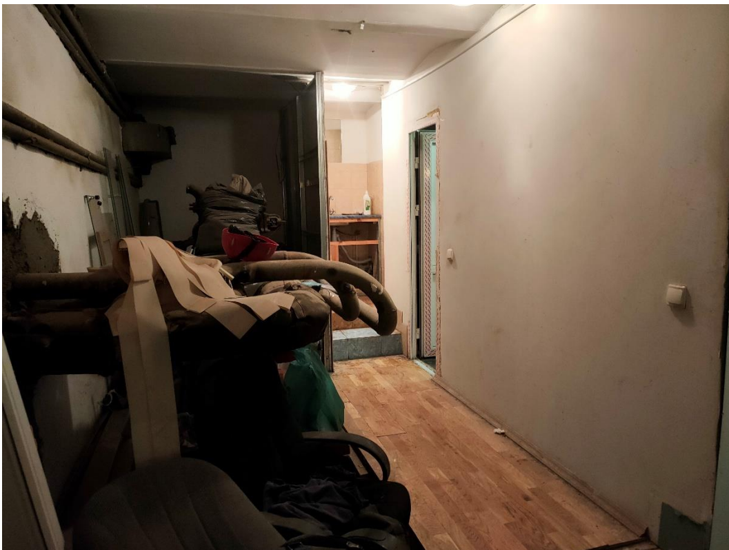
18. «Особняк Штифтер», ул. Моховая, д.15, лит. А. Подвал. Общий вид. Фото 22.07.2022г.
