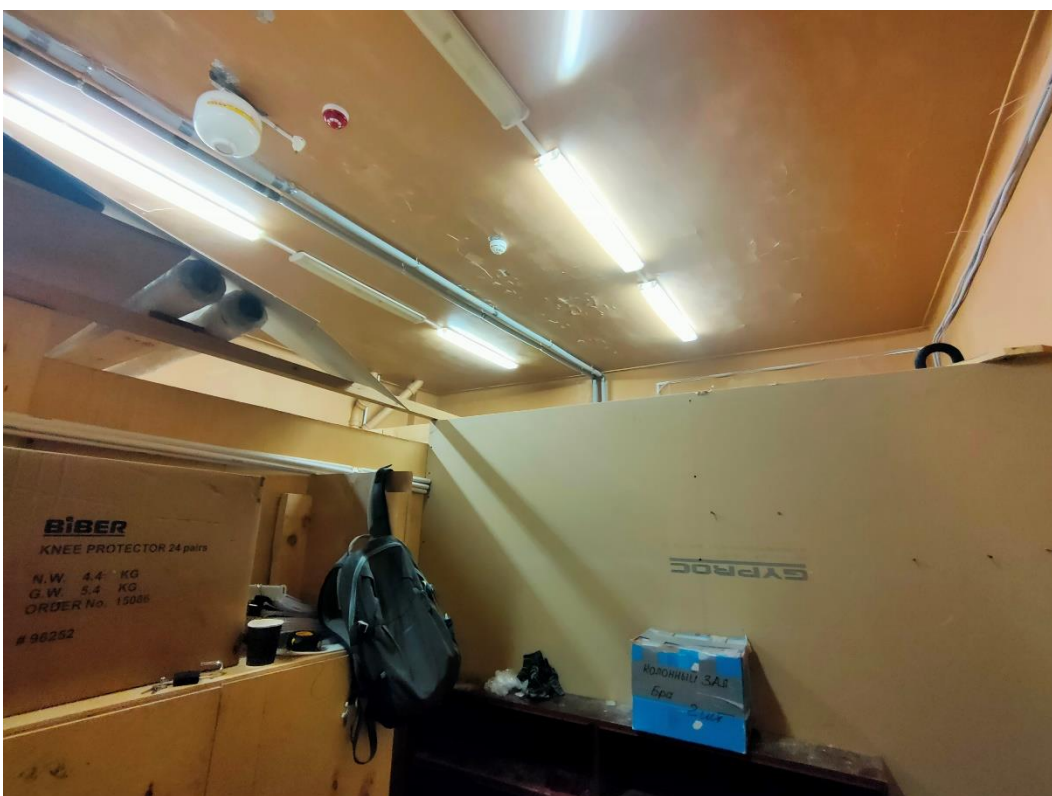
4. «Особняк Штифтер», ул. Моховая, д.15, лит. А. Первый этаж. Помещение №1. Общий вид. Фото 22.07.2022г.
