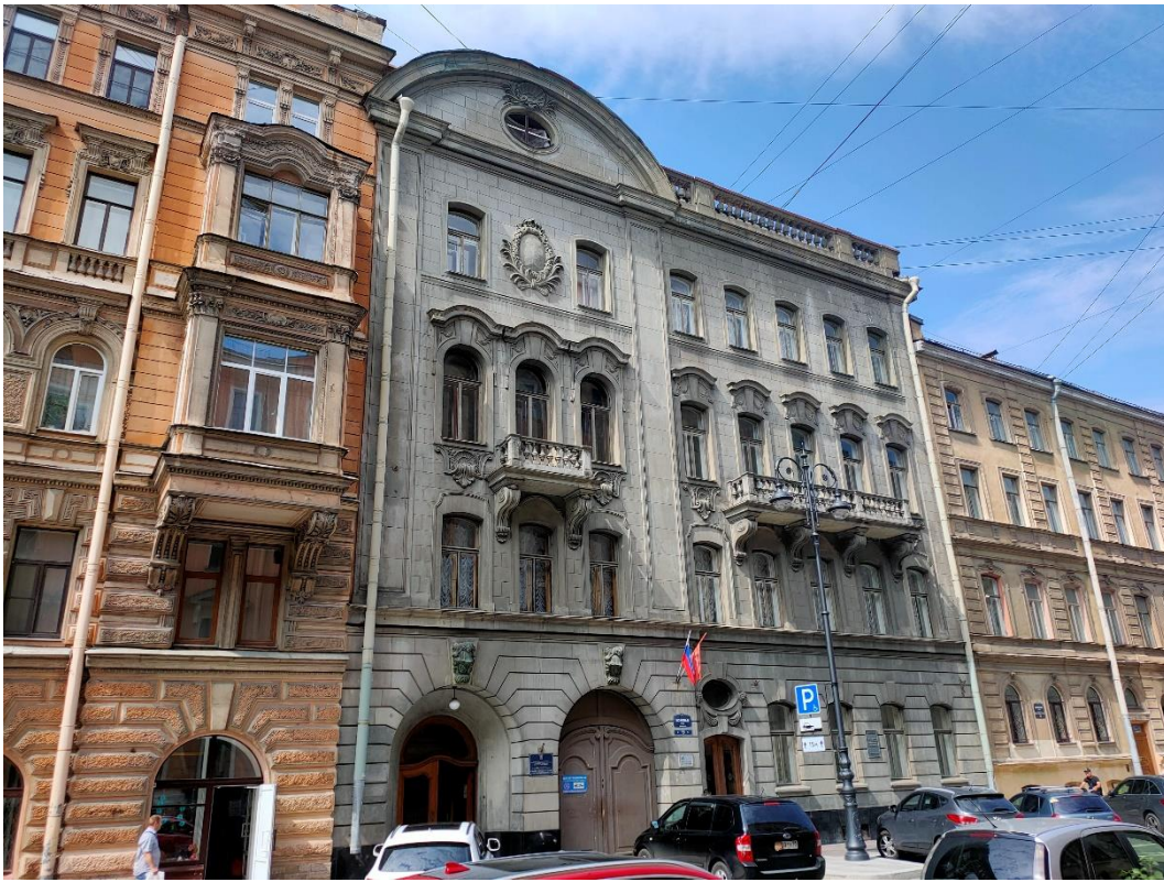
1. «Особняк Штифтер», ул. Моховая, д.15, лит. А. Восточный фасад. Общий вид. Фото 22.07.2022г.
