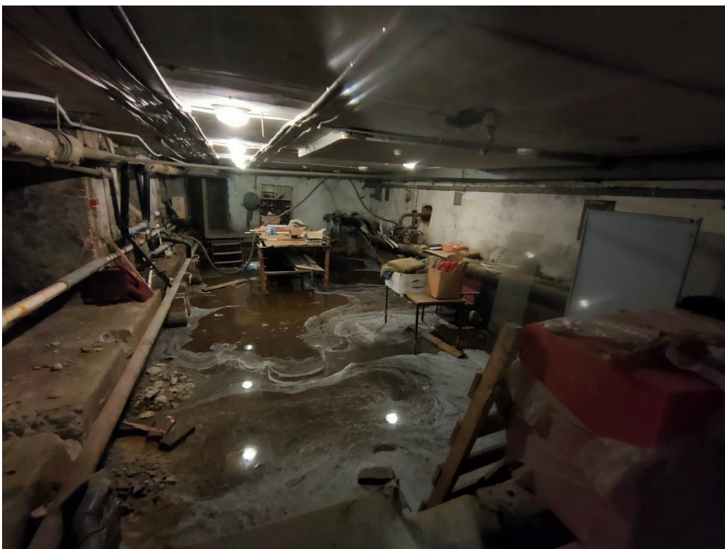
13. «Особняк Штифтер», ул. Моховая, д.15, лит. А. Подвал. Общий вид. Фото 22.07.2022г.
