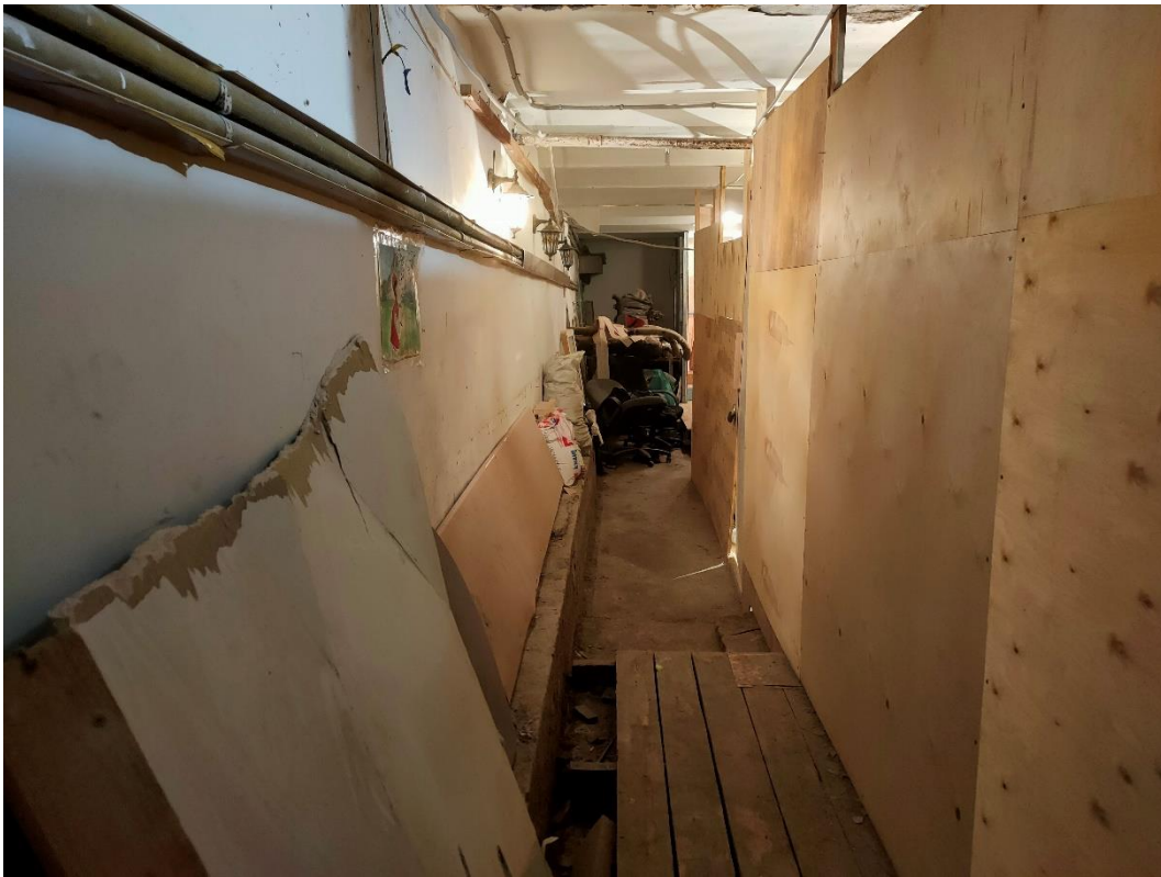
17. «Особняк Штифтер», ул. Моховая, д.15, лит. А. Подвал. Общий вид. Фото 22.07.2022г.
