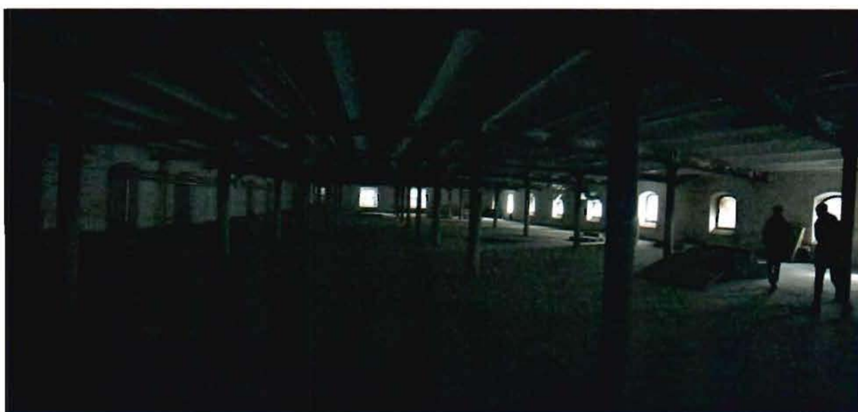
6. Помещение с колоннами.
