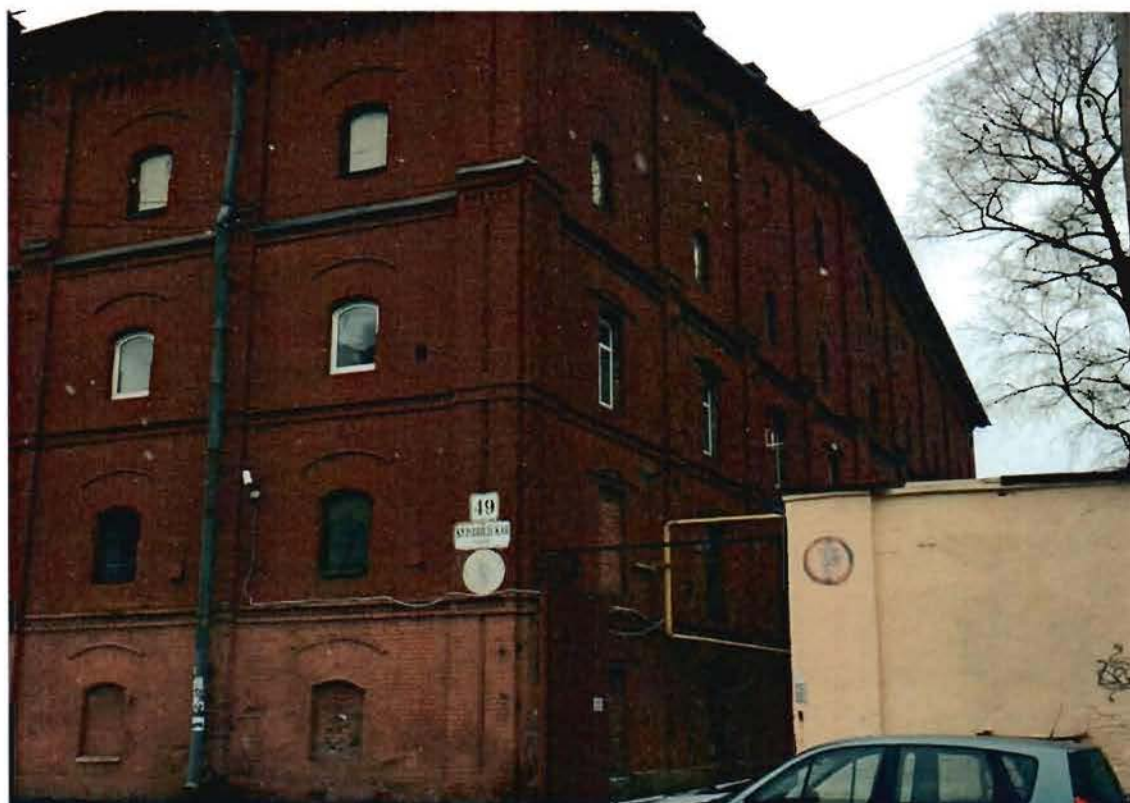
4. Восточный фасад. Общий вид.
