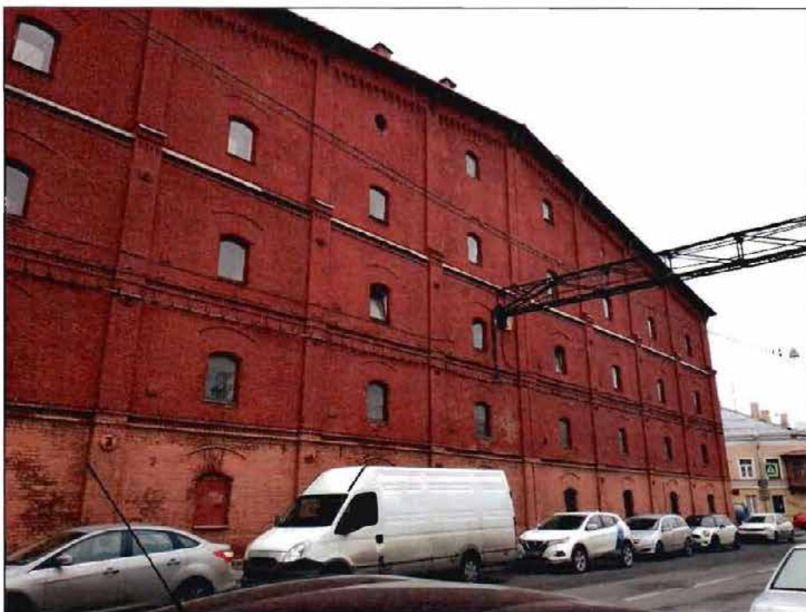
4. Вид на западный фасад.
