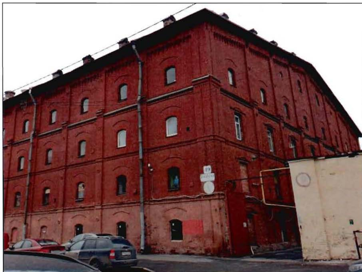
3. Вид на юго-восточный фасад.
