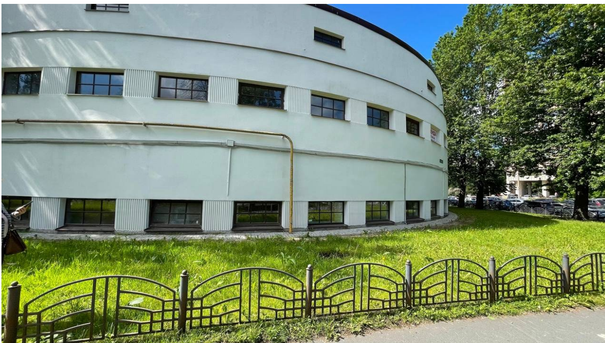
7. Вид на восточный фасад здания;
