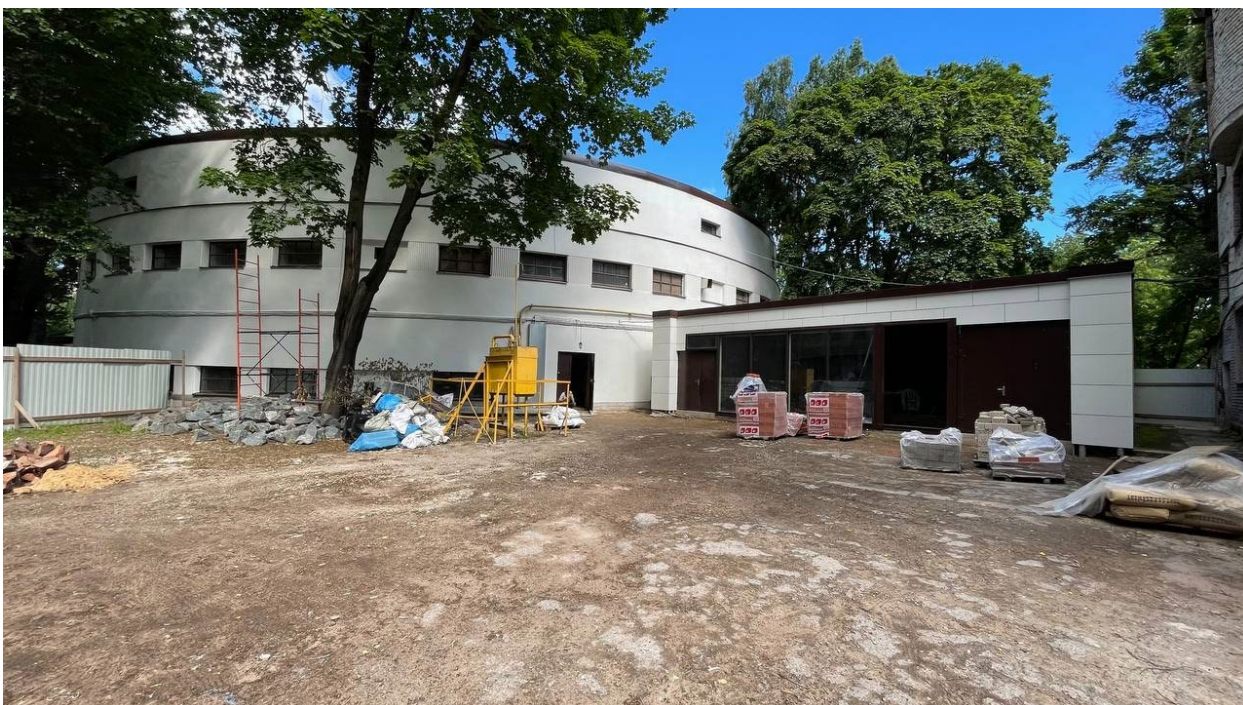
6. Вид на северо-восточный фасад здания;
