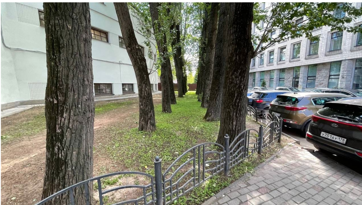
4. Общий вид на территорию и северный фасад здания;
