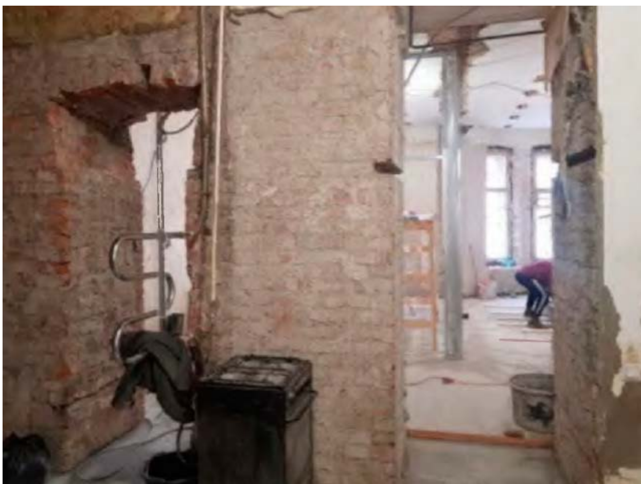
11. Помещение №4 квартиры №72 в уровне 2-го этажа объекта культурного наследия регионального значения «Дом, где в 1917 г. жил Джон Рид», расположенного по адресу: г. Санкт-Петербург, ул. Рубинштейна, д. 23, литера А. 10.09.2021.
