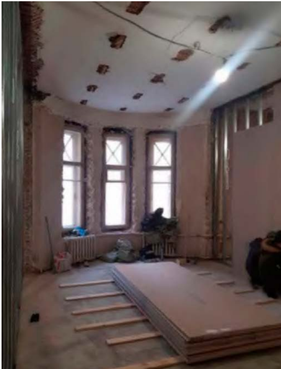
6. Помещение №6 квартиры №72 в уровне 2-го этажа объекта культурного наследия регионального значения «Дом, где в 1917 г. жил Джон Рид», расположенного по адресу: г. Санкт-Петербург, ул. Рубинштейна, д. 23, литера А. 10.09.2021.
