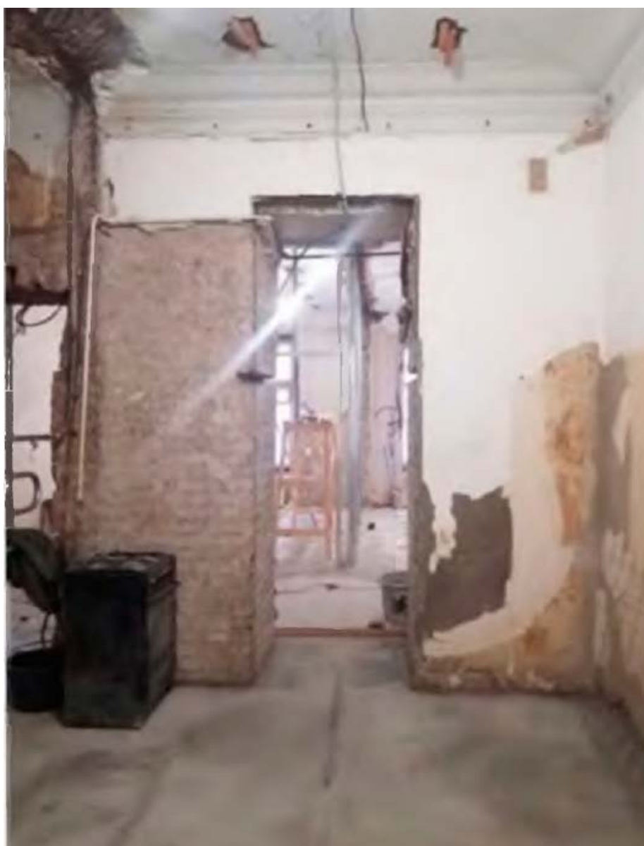
10. Помещение №4 квартиры №72 в уровне 2-го этажа объекта культурного наследия регионального значения «Дом, где в 1917 г. жил Джон Рид», расположенного по адресу: г. Санкт-Петербург, ул. Рубинштейна, д. 23, литера А. 10.09.2021.
