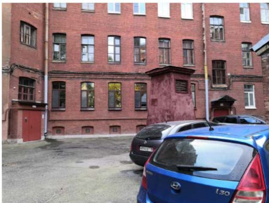
Фото 10. Вид дворового фасада Вид дворового фасада
