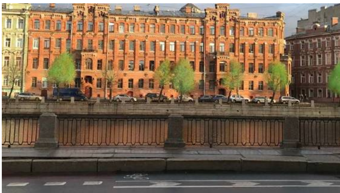
Фото 9. Вид лицевого фасада по наб. р. Фонтанки
