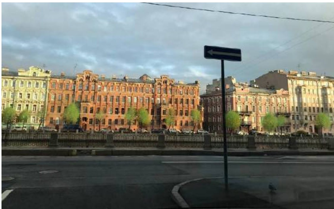
Фото 8. Вид лицевого фасада по наб. р. Фонтанки
