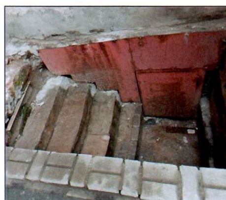
Фото 19. Вход с южного фасада через приямок.
