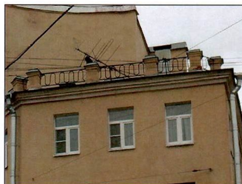
Фото 5. Фрагмент южного фасада.
