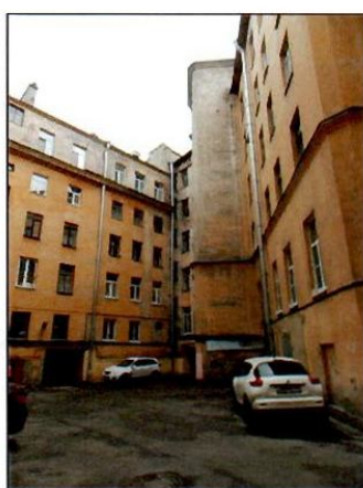
Фото 16. Западный дворовый фасад.
