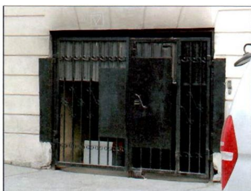
Фото 6. Воротный проезд юго-западного фасада
