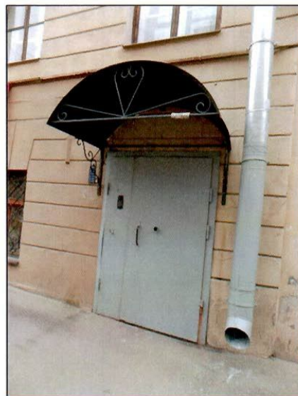
Фото 11. Вход со стороны восточного фасада (лестница).
