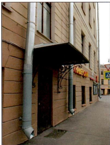
Фото 10. Вход со стороны юго-западного фасада (пом. 4-Н).
