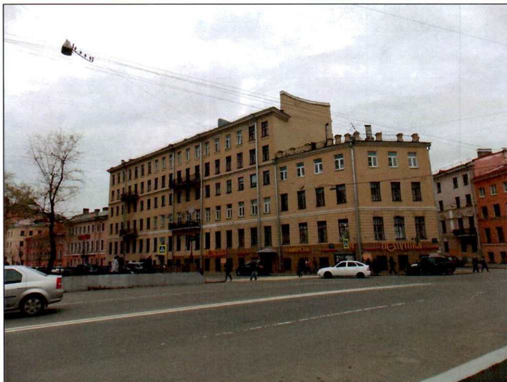
Фото 1. Юго-западный фасад со стороны канала Грибоедова.
