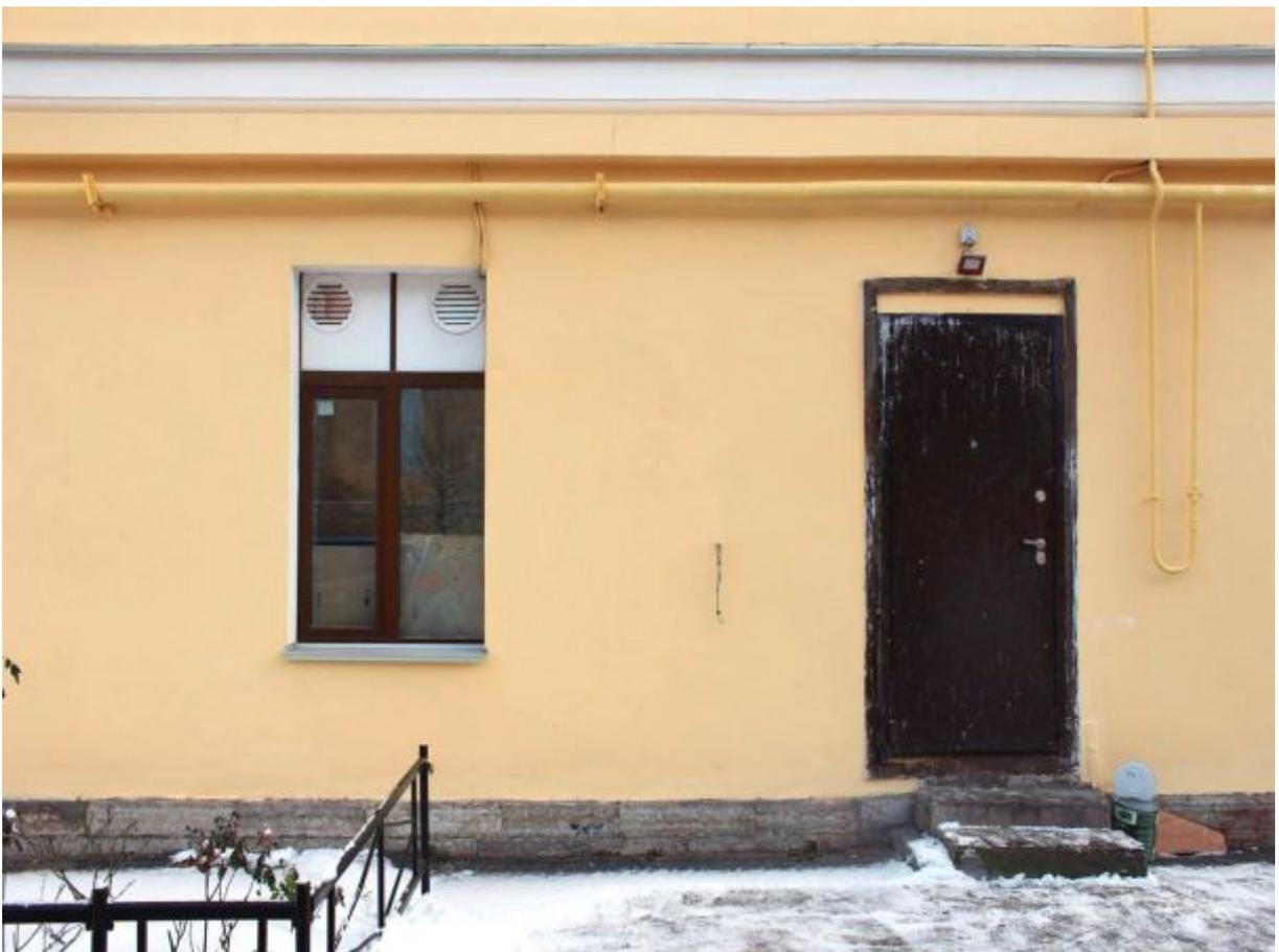
Фото.3. Кронштадт, Коммунистическая ул., д. 3 лит. А. Дворовый фасад. Фрагмент, – поздний дверной проем, устроенный вместо оконного.
