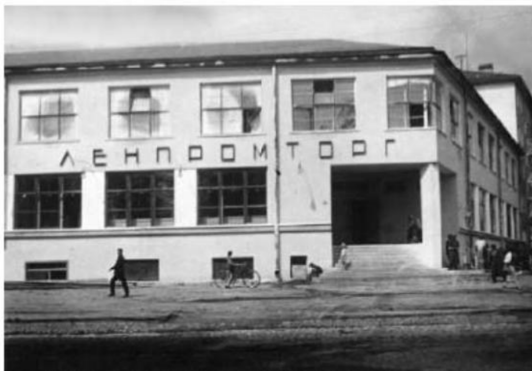
12. Кондратьевский жилмассив . Калининский универмаг (универмаг Кондратьевского жилмассива). Фрагмент фасада. 1934 г. Фотография ЦГА КФД СПб. Бр-8221.
