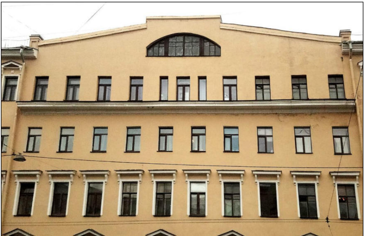
4. Лицевой фасад «Дома по проспекту». Средняя часть в уровне 3–5 этажей. Дата съемки: 15 ноября 2021 г. Фотограф: Г. В. Михайловская.
