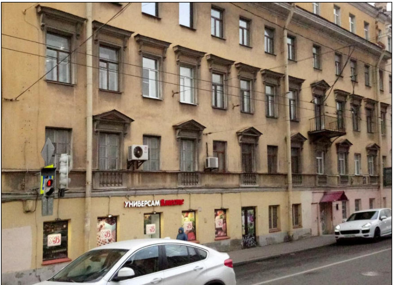
21. Лицевой фасад «Углового дома» по Малому проспекту. Современное заполнение дверных и оконных проемов первого этажа. Дата съемки: 15 ноября 2021 г. Фотограф: Г. В. Михайловская.
