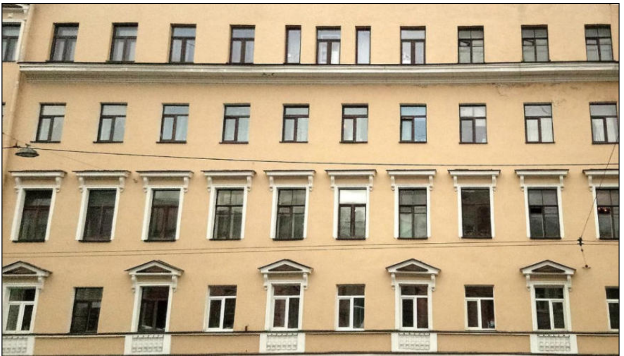
5. Лицевой фасад «Дома по проспекту». Средняя часть в уровне 2–5 этажей. Дата съемки: 15 ноября 2021 г. Фотограф: Г. В. Михайловская.
