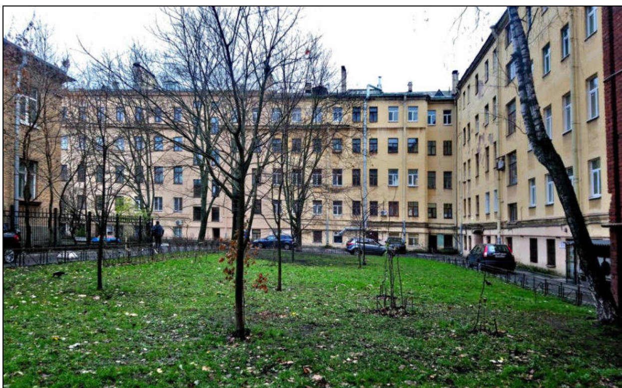
15. Выявленный объект культурного наследия «Дома В. Алексева (Л. Я. Пенчковской)», расположенный по адресу: Санкт-Петербург, Малый пр. В. О., 15 (15 а, б); 6-я линия, 53. Общий вид со стороны двора. Дата съемки: 15 ноября 2021 г. Фотограф: Г. В. Михайловская.
