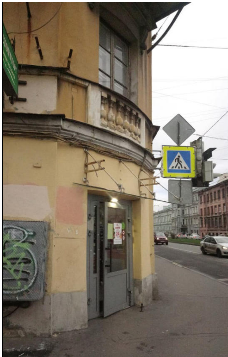
20. Фасад «Углового дома» по угловой оси. Современное заполнение дверного проема первого этажа. Дата съемки: 15 ноября 2021 г. Фотограф: Г. В. Михайловская.
