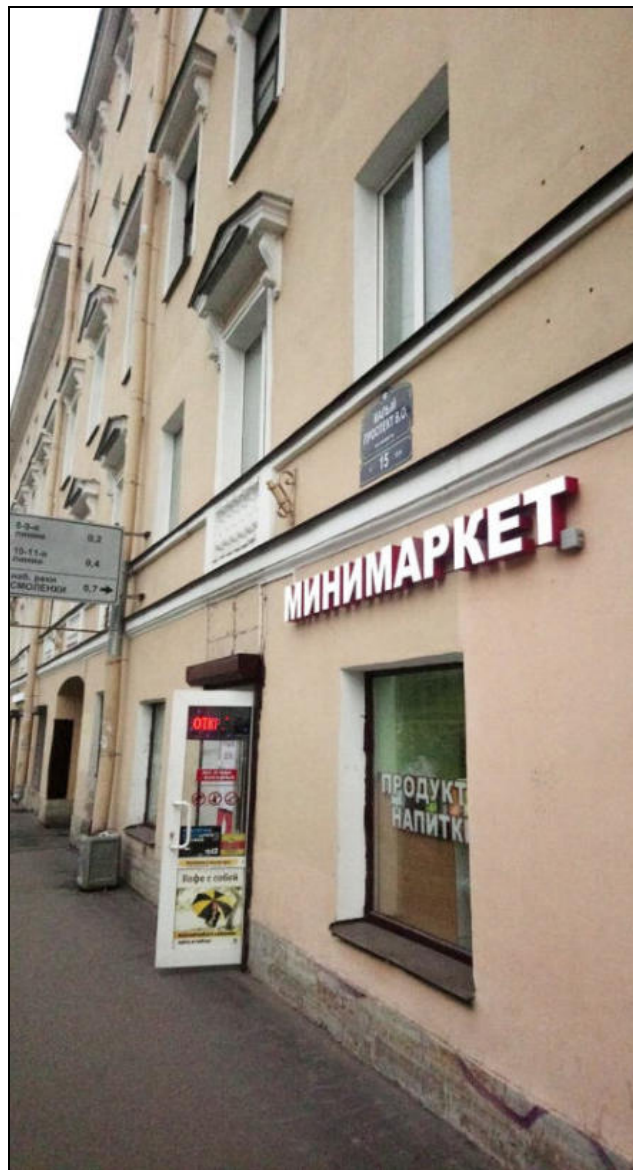
10. Лицевой фасад «Дома по проспекту». Фрагмент. Современное заполнение дверного и оконных проемов пом. 1-Н (по 20–22-й осям). Дата съемки: 15 ноября 2021 г. Фотограф: Г. В. Михайловская.
