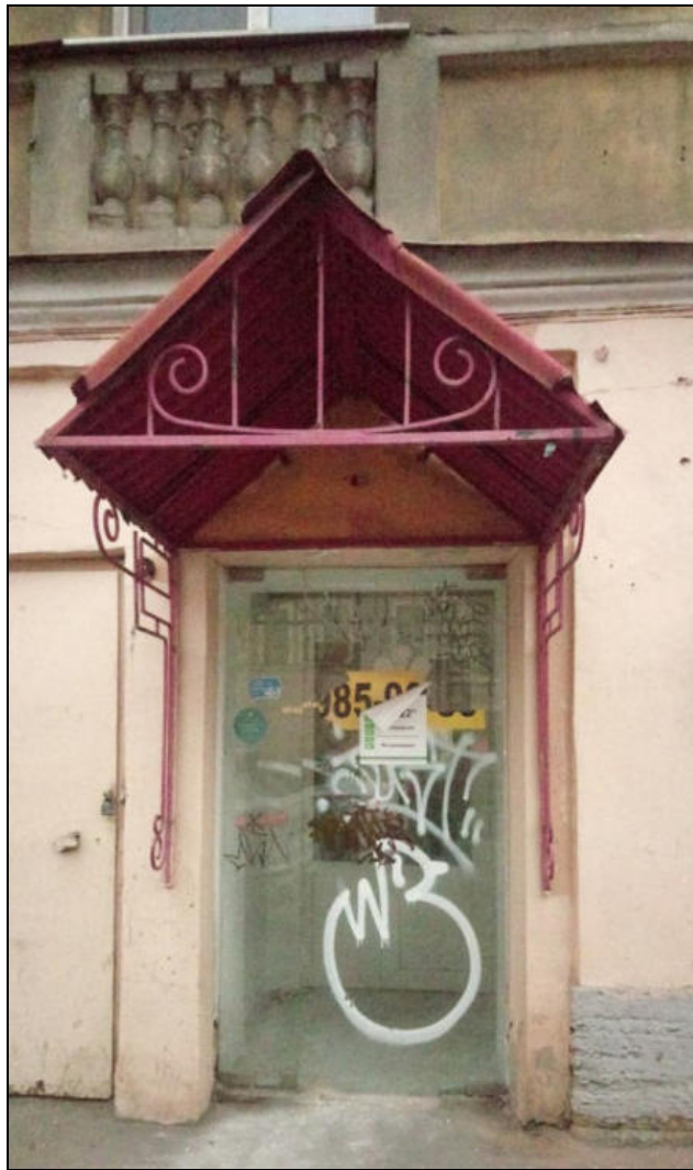
23. Лицевой фасад «Углового дома» по Малому проспекту. Современное заполнение дверного проема первого этажа по 9-й оси. Дата съемки: 15 ноября 2021 г. Фотограф: Г. В. Михайловская.
