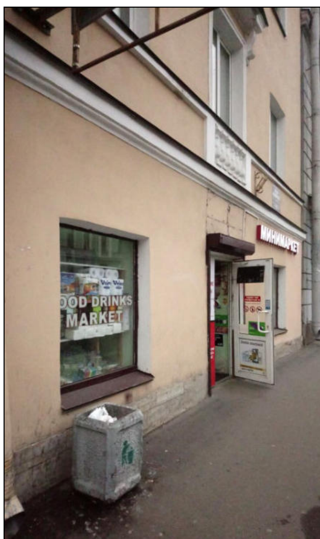
9. Лицевой фасад «Дома по проспекту». Фрагмент. Современное заполнение дверного и оконных проемов пом. 1-Н (по 20–22-й осям). Дата съемки: 15 ноября 2021 г. Фотограф: Г. В. Михайловская.
