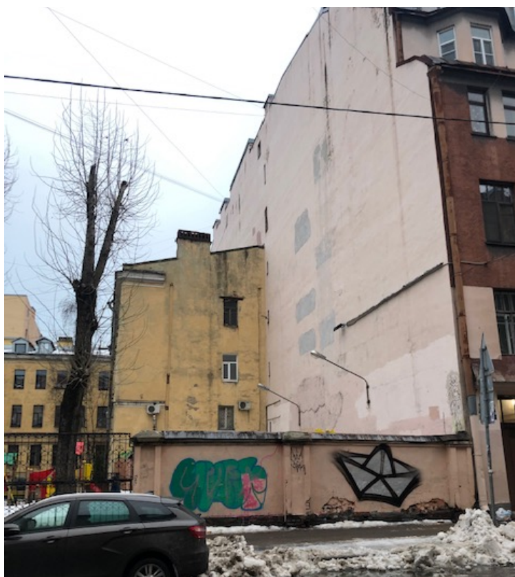
Фото 4. Участок производства работ
