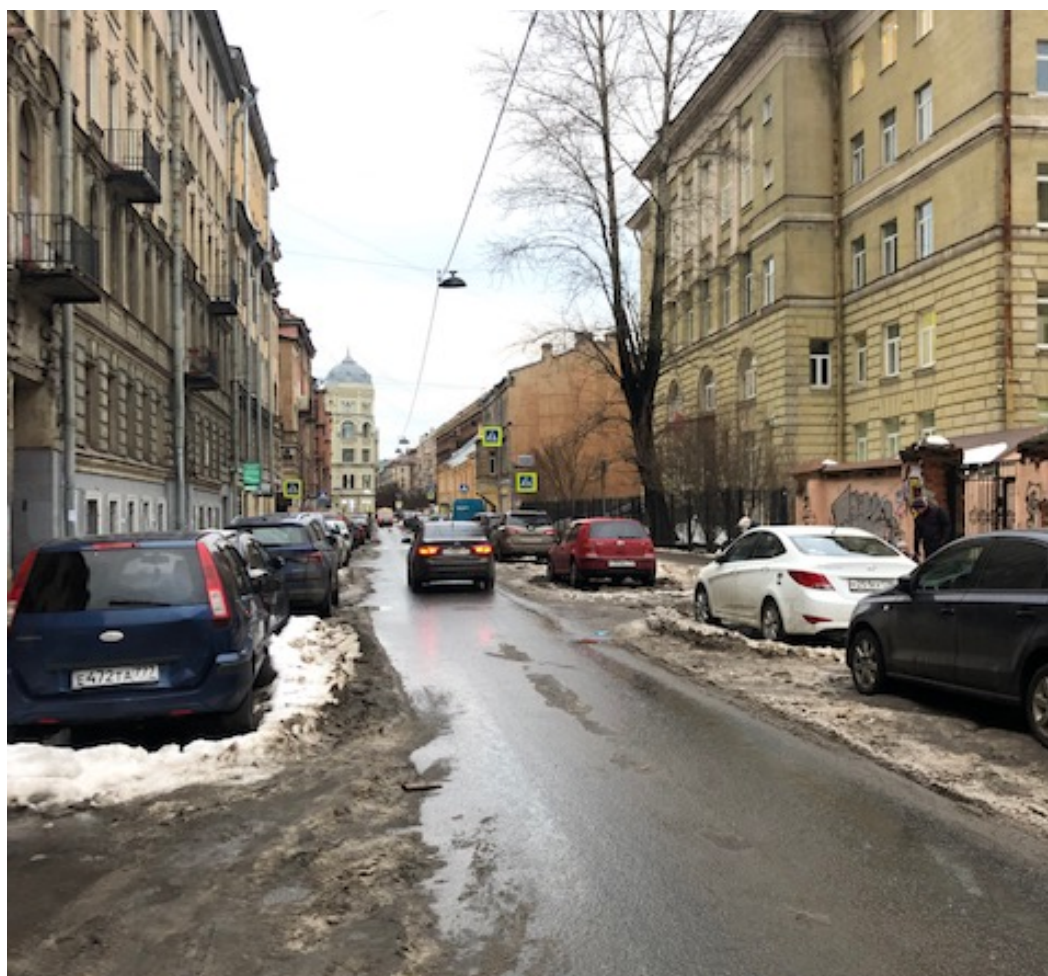
Фото 6. Участок производства работ
