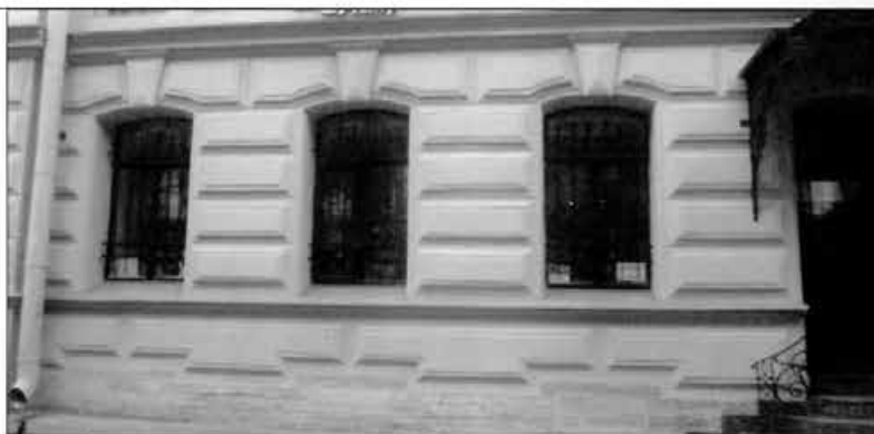
Оконные проемы помещения 17-Н (1). Съёмка 24.05.2012. Т.И. Соколова.
