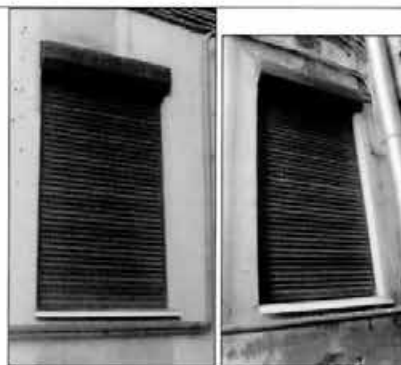
Оконные проемы помещений 17-Н (4,5). Съёмка 24.05.2012. Т.И. Соколова.
