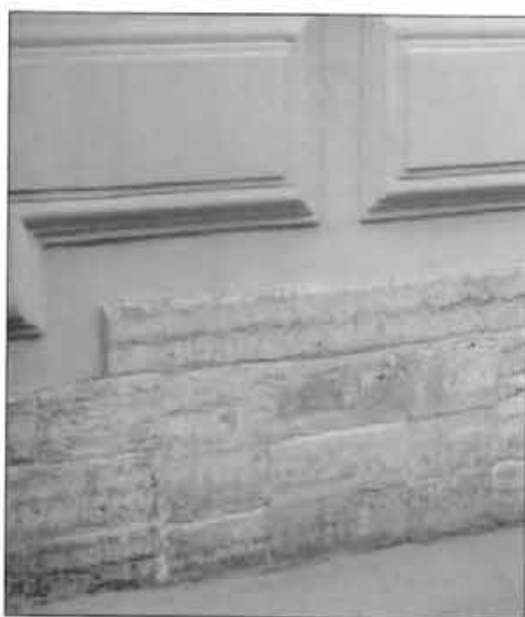
Фрагмент цоколя по Пушкинской ул. Съёмка 24.05.2012. Т.И. Соколова.
