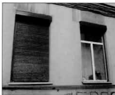
Оконные проемы помещения 17-Н (6). Съёмка 24.05.2012. Т.И. Соколова.
