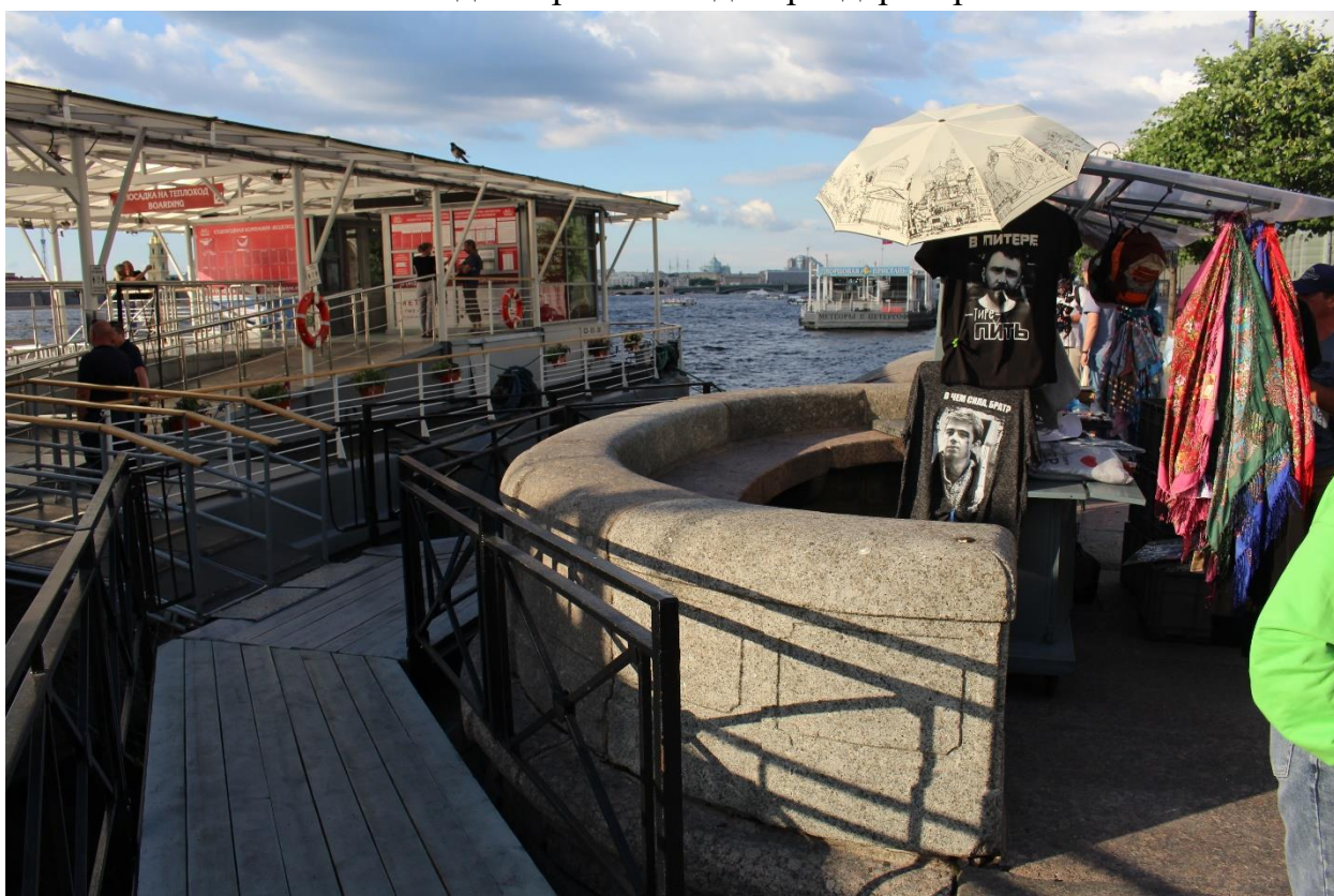
Фото 4. Вид на верхнюю площадку спуска № 9 и траповый переход.
