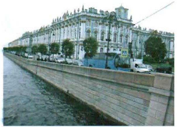
16. Вид стенки набережной с Дворцового моста
