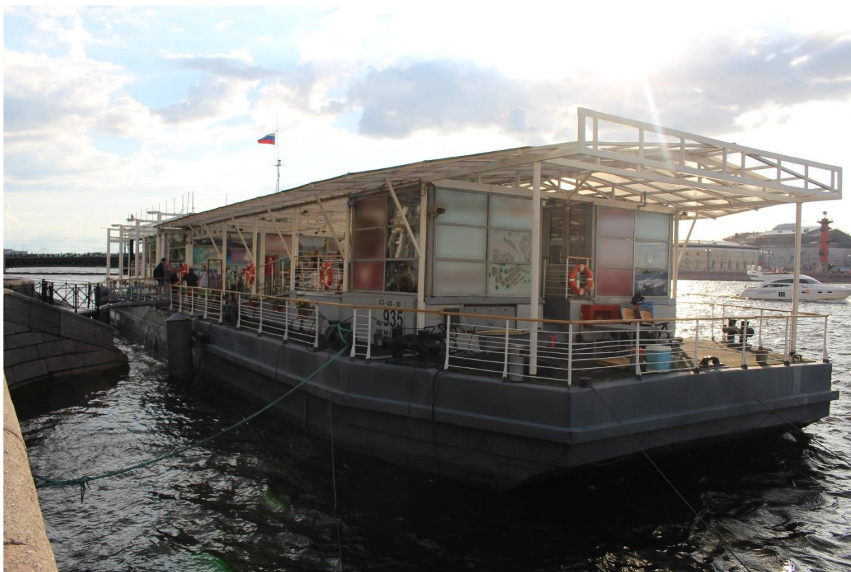
Фото 9. Вид на дебаркадер с северо-востока.
