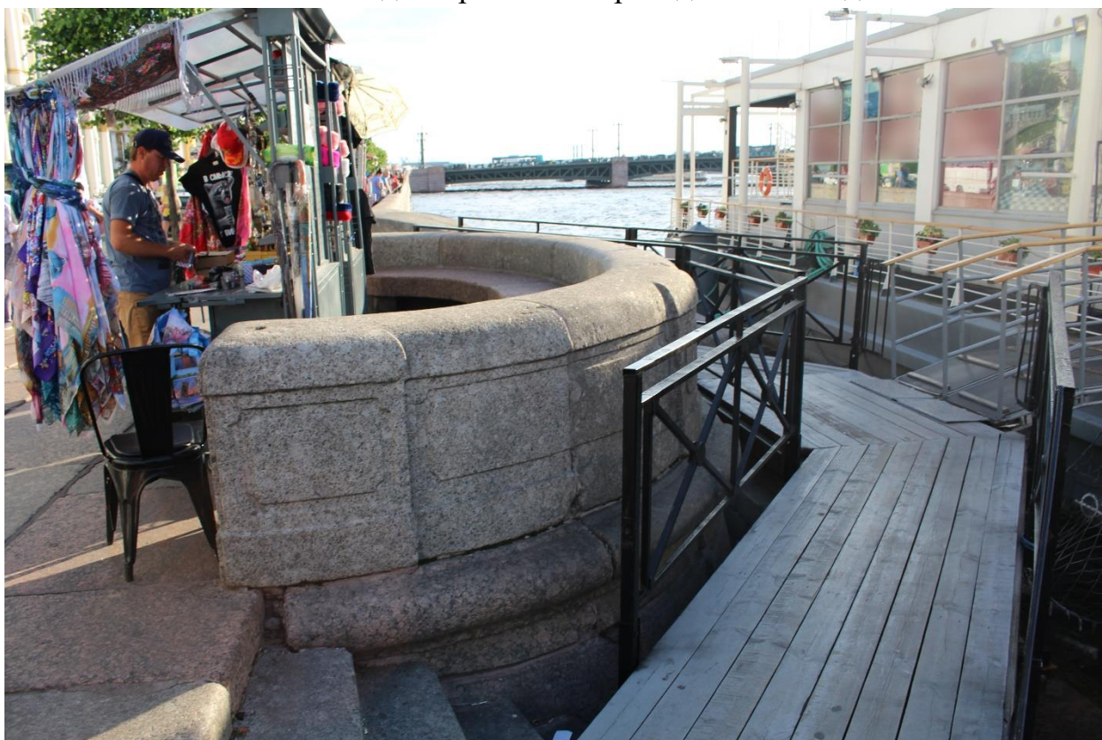
Фото 6. Вид на верхнюю площадку спуска № 9 и траповый переход с северо-востока.
