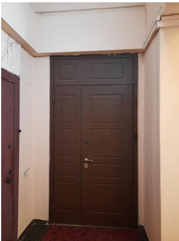
Фото 3 Интерьер объекта культурного наследия регионального значения «Дом бывшего страхового общества «Саламандра», входная дверь квартиры №15
