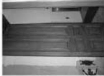
Дверь, дубовая, сдвоенная, на залив профилеобразных фиалок, стили дверного проема обрамлены дубовой фиалчатой лепниной. Наличие профилеобразных.
