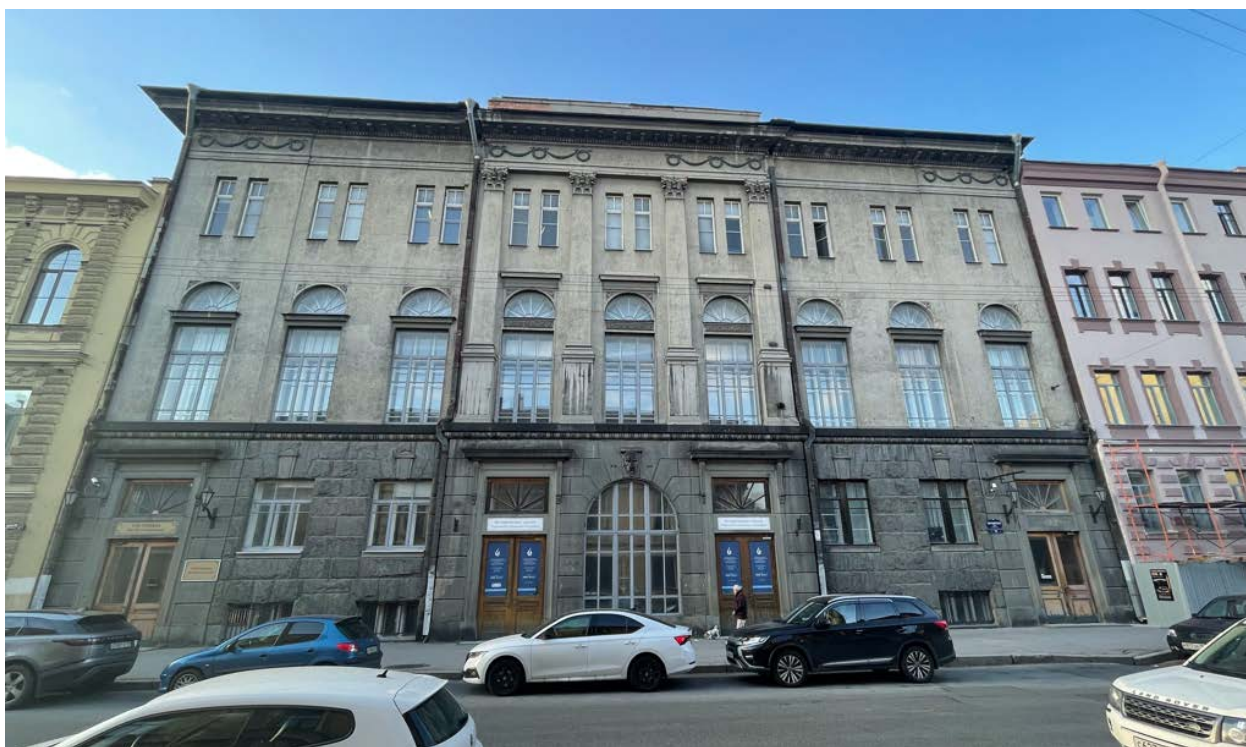
1. Юго-восточный лицевой фасад по Почтамтской улице объекта культурного наследия регионального значения «Здание Управления городского телефона и телеграфа», расположенного по адресу: г. Санкт-Петербург, Почтамтская ул., 15, литера Б. 15.08.2021.
