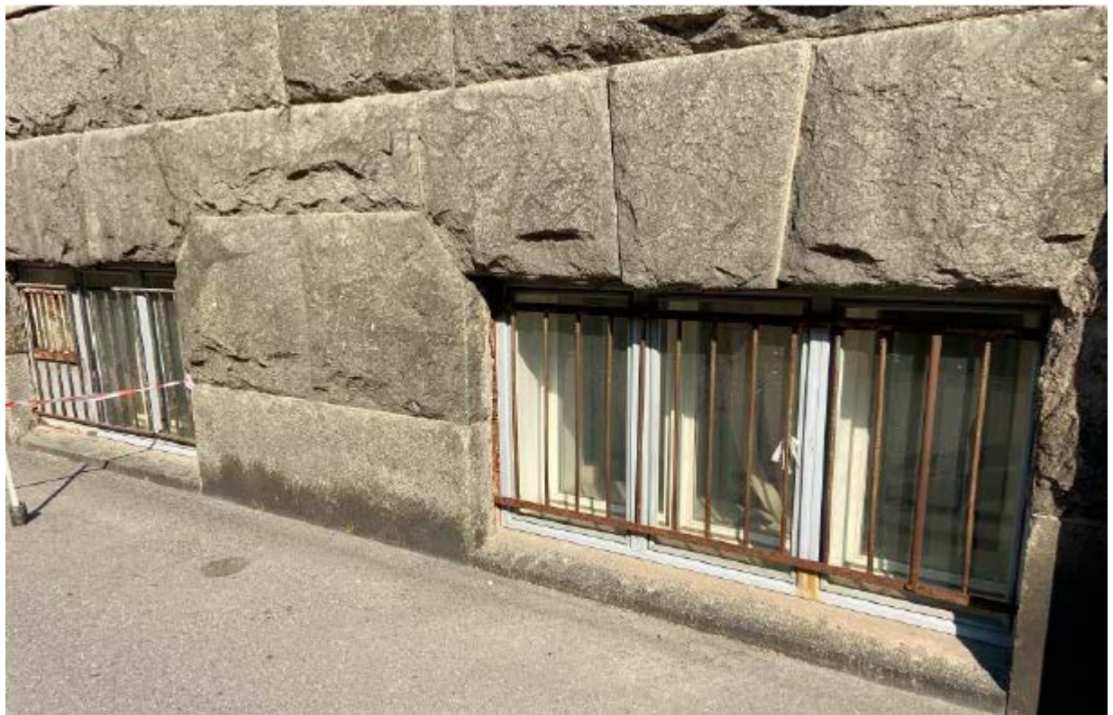
6. Цоколь юго-восточного лицевого фасада по улице Почтамтской объекта культурного наследия регионального значения «Здание Управления городского телефона и телеграфа», расположенного по адресу: г. Санкт-Петербург, Почтамтская ул., 15, литера Б. 15.08.2021.
