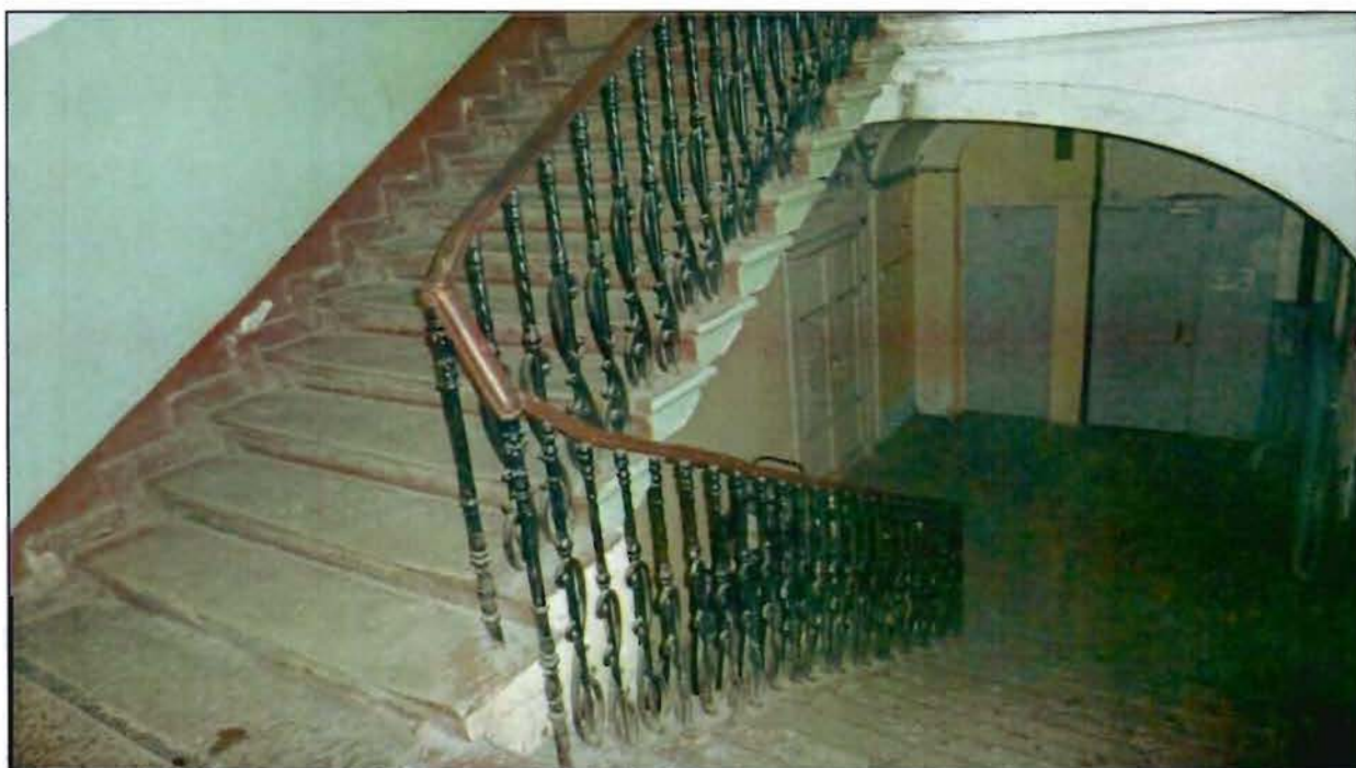
12. Лестница (5 ЛК). Корпус по ул. Якубовича.
