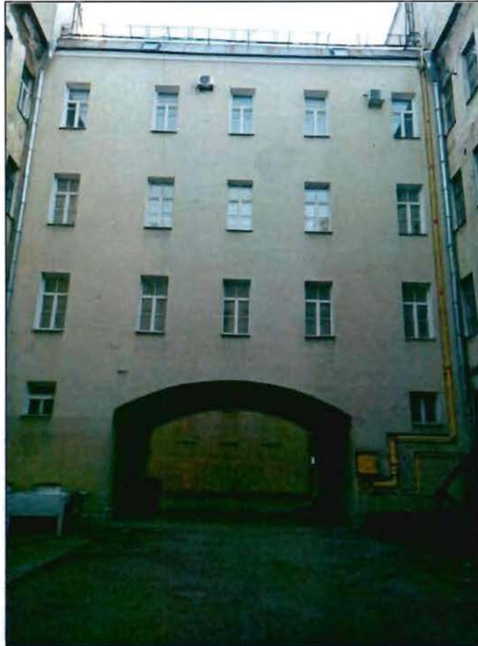
5. Поперечный дворовый корпус. Вид с северо-запада.
