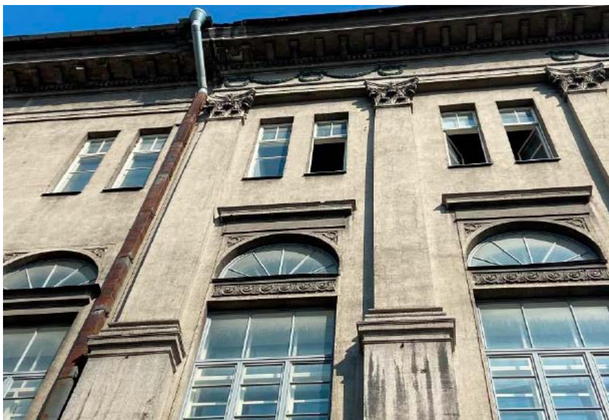
4. Юго-восточный лицевой фасад по улице Почтамтской объекта культурного наследия регионального значения «Здание Управления городского телефона и телеграфа», расположенного по адресу: г. Санкт-Петербург, Почтамтская ул., 15, литера Б. Фрагмент. 15.08.2021.
