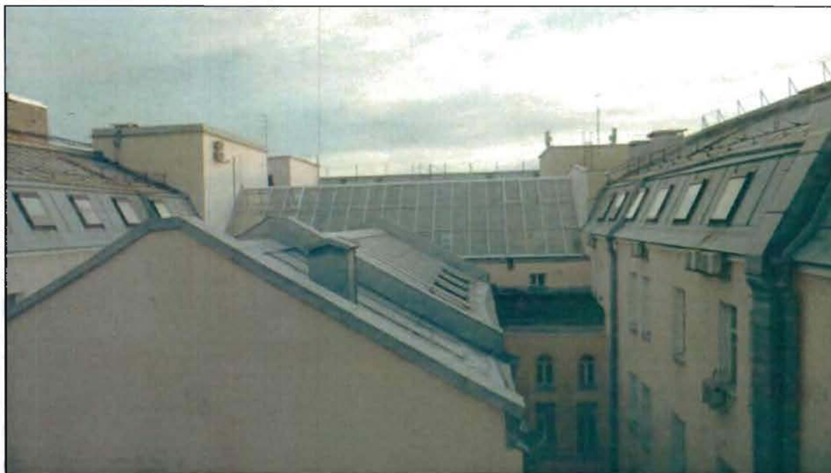
7. Кровля. Вид с северо-запада.
