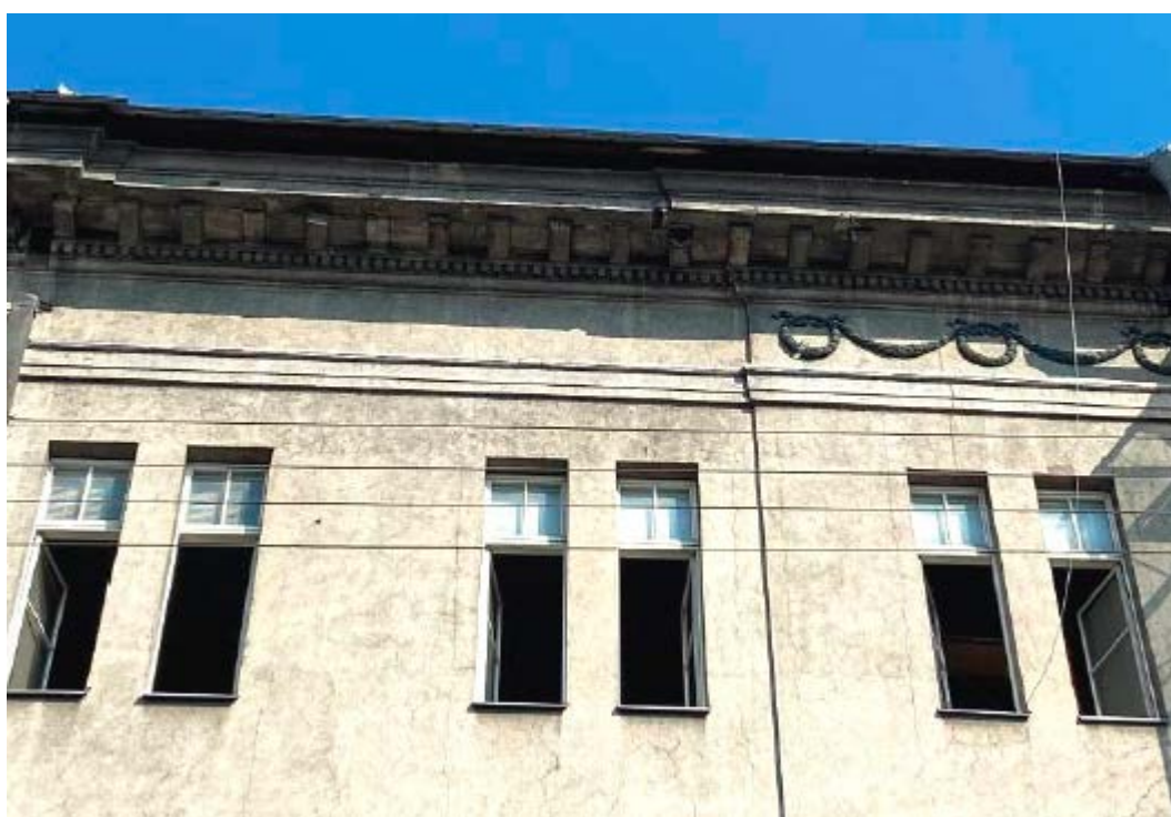
2. Юго-восточный лицевой фасад по улице Почтамтской объекта культурного наследия регионального значения «Здание Управления городского телефона и телеграфа», расположенного по адресу: г. Санкт-Петербург, Почтамтская ул., 15, литера Б. Фрагмент. 15.08.2021.
