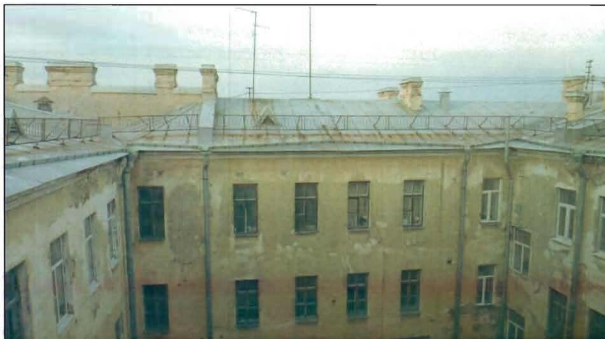
8. Кровля. Вид с юго-востока.
