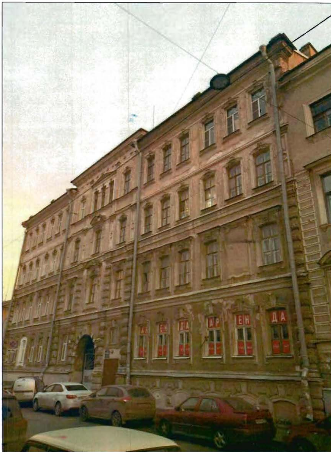
2. Общий вид с севера (лицевой фасад по ул. Якубовича).
