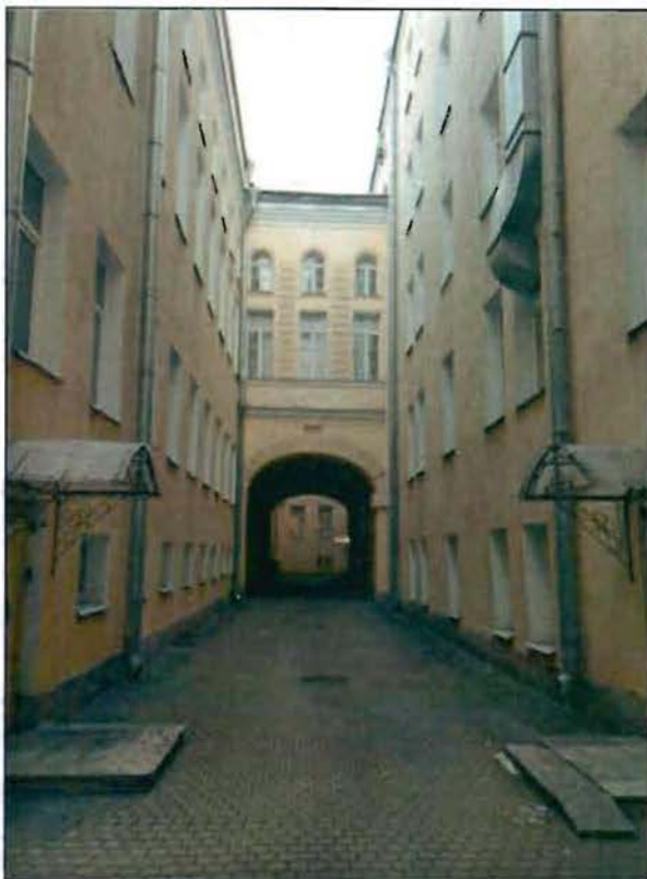
3. Дворовые фасады южного двора. Вид с северо-запада.
