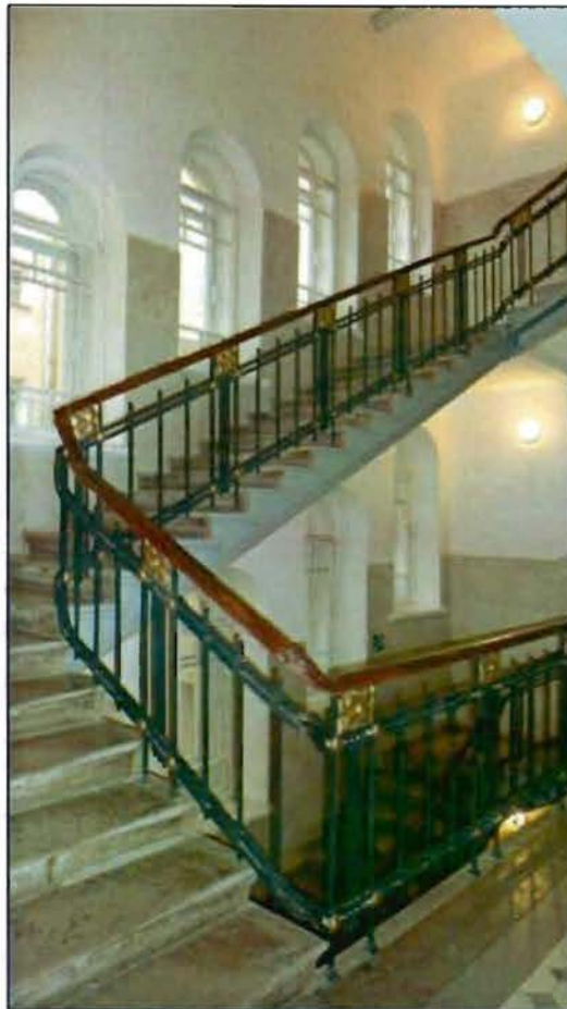
10. Лестница (2 ЛК). Корпус по ул. Почтамтской.
