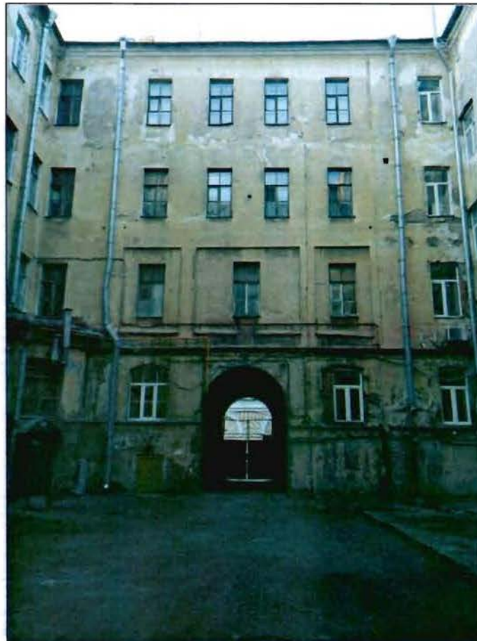
6. Северный дворовый фасад корпуса по ул. Якубовича.
