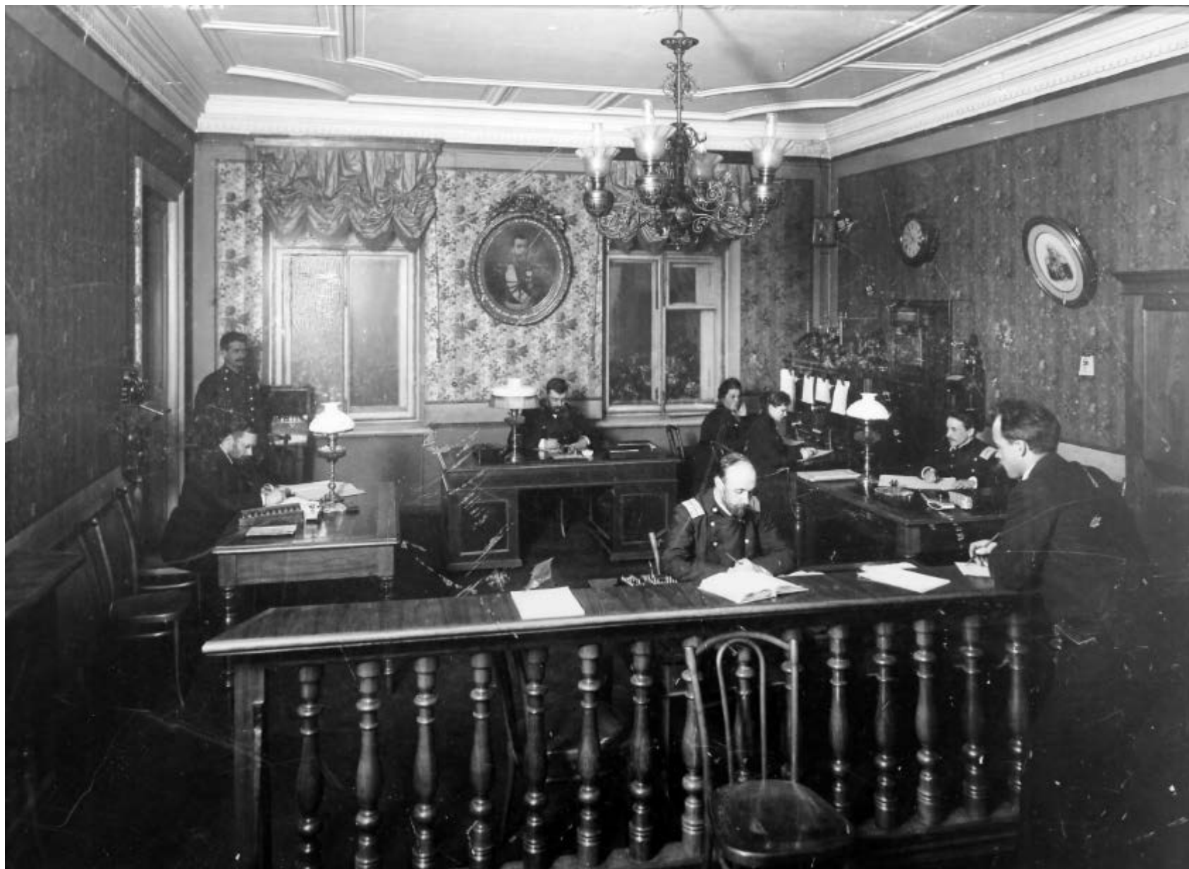
5. Помещение Международной телефонной станции. 1902 // Архив ЦМС им. Попова А.С.
