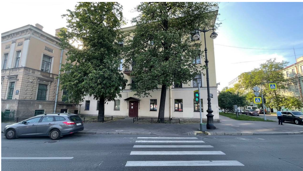
1. Вид на фасад здания с наб. Лейтенанта Шмидта;
