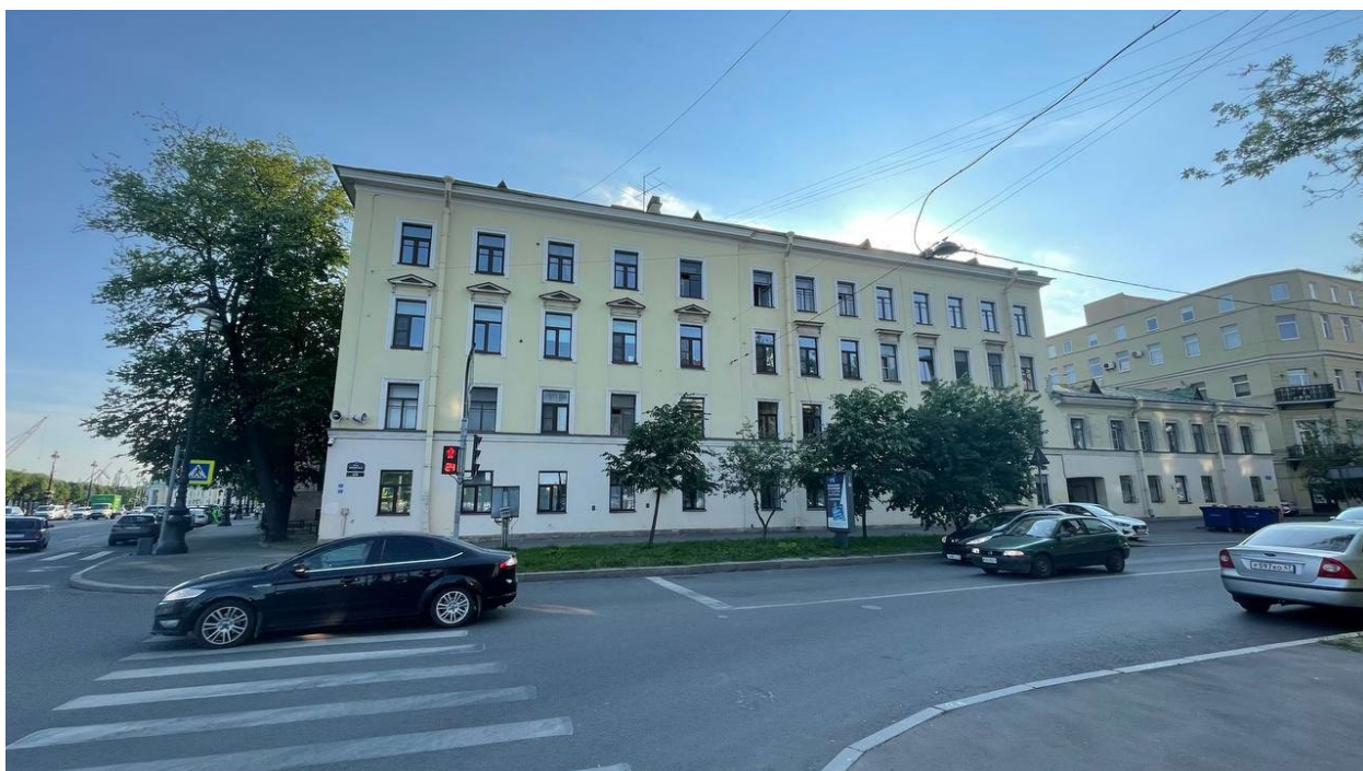
2. Вид на фасад здания с 17-ой линии В.О.;
