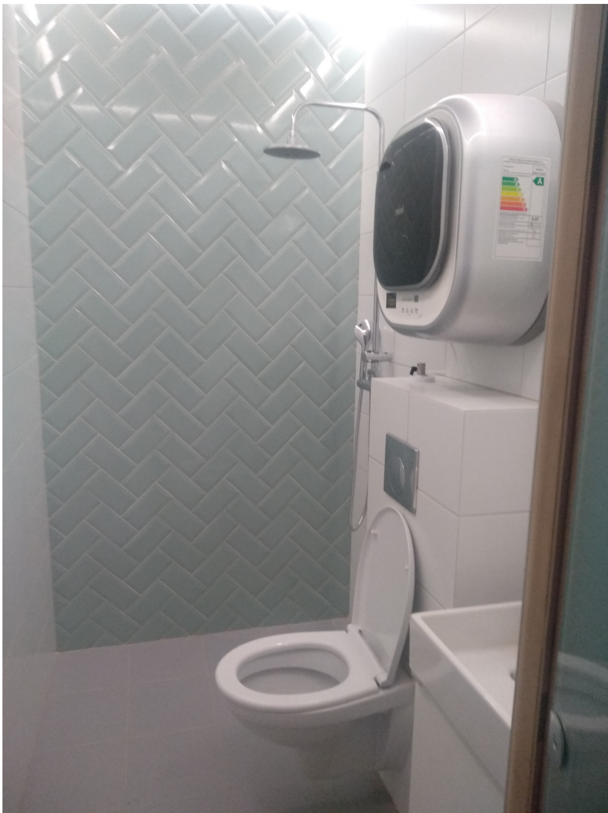
9. Фрагмент интеръера санузла (помещение №6);
