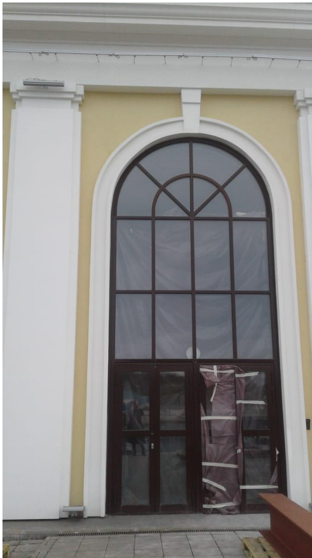
10. Объект культурного наследия регионального значения «Ресторан Кюба» по адресу: г. Санкт-Петербург, набережная реки Большой Невки, дом 24, литера А (наб. р. Большой Невки, 24). Северный фасад. Фрагмент. Заполнение проема.
