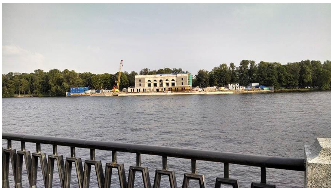
16. Объект культурного наследия регионального значения «Ресторан «Кюба» на Каменном острове (Санкт-Петербург, набережная реки Большой Невки, дом 24, литера А (наб. р. Большой Невки, 24). Работы по реконструкции 2015 г. Вид с Большой Невки. Фотография. https://www.citywalls.ru/
