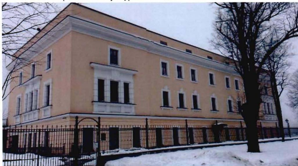
1. Вид на южный фасад объекта культурного наследия.
