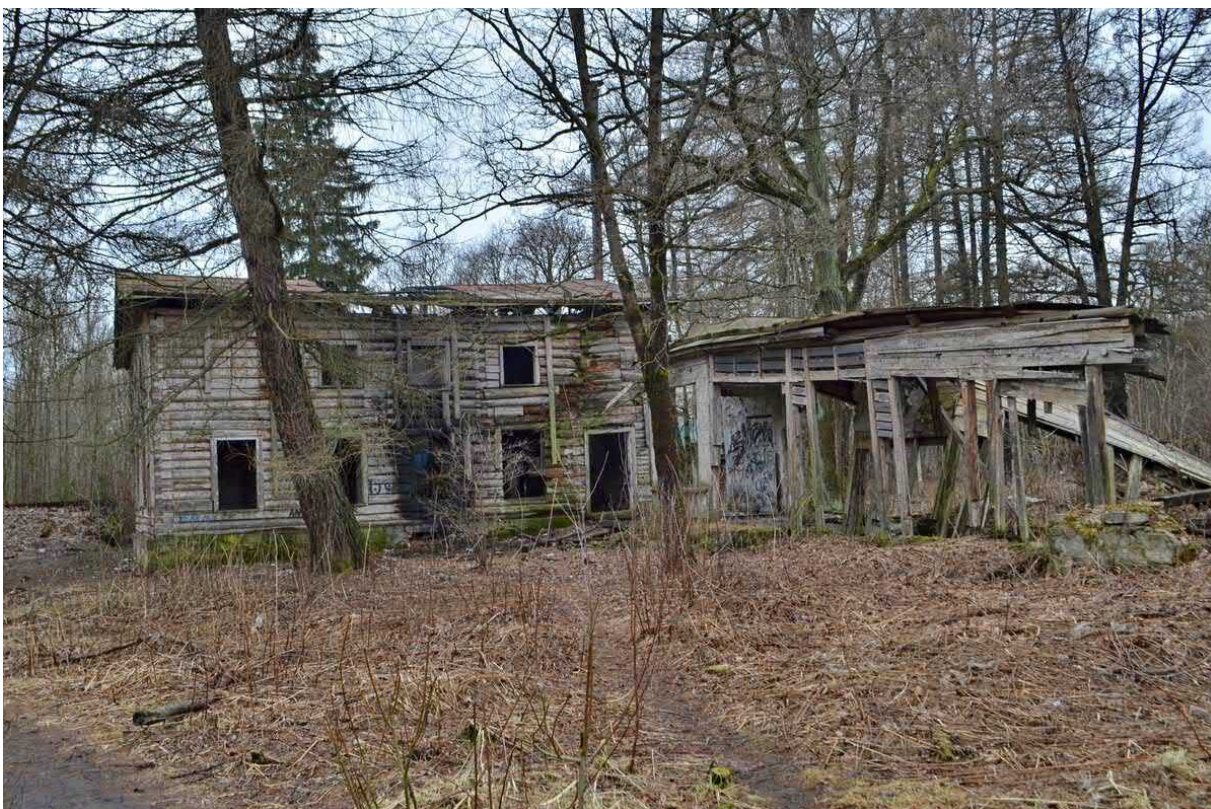
22. Современное состояние Усадьбы Вяземских (после пожара)
