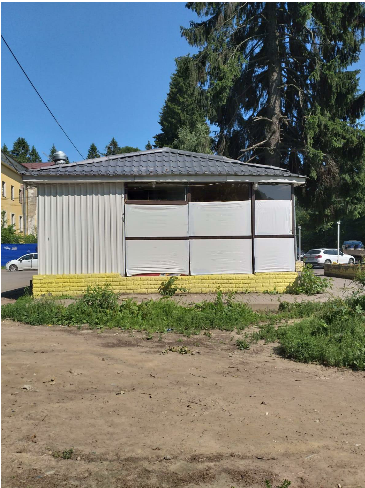
Фото 6. СПб, Осиновая Роща, Приозерское шоссе, дом 15, корп. 6. Боковой фасад со стороны Приозерского шоссе
