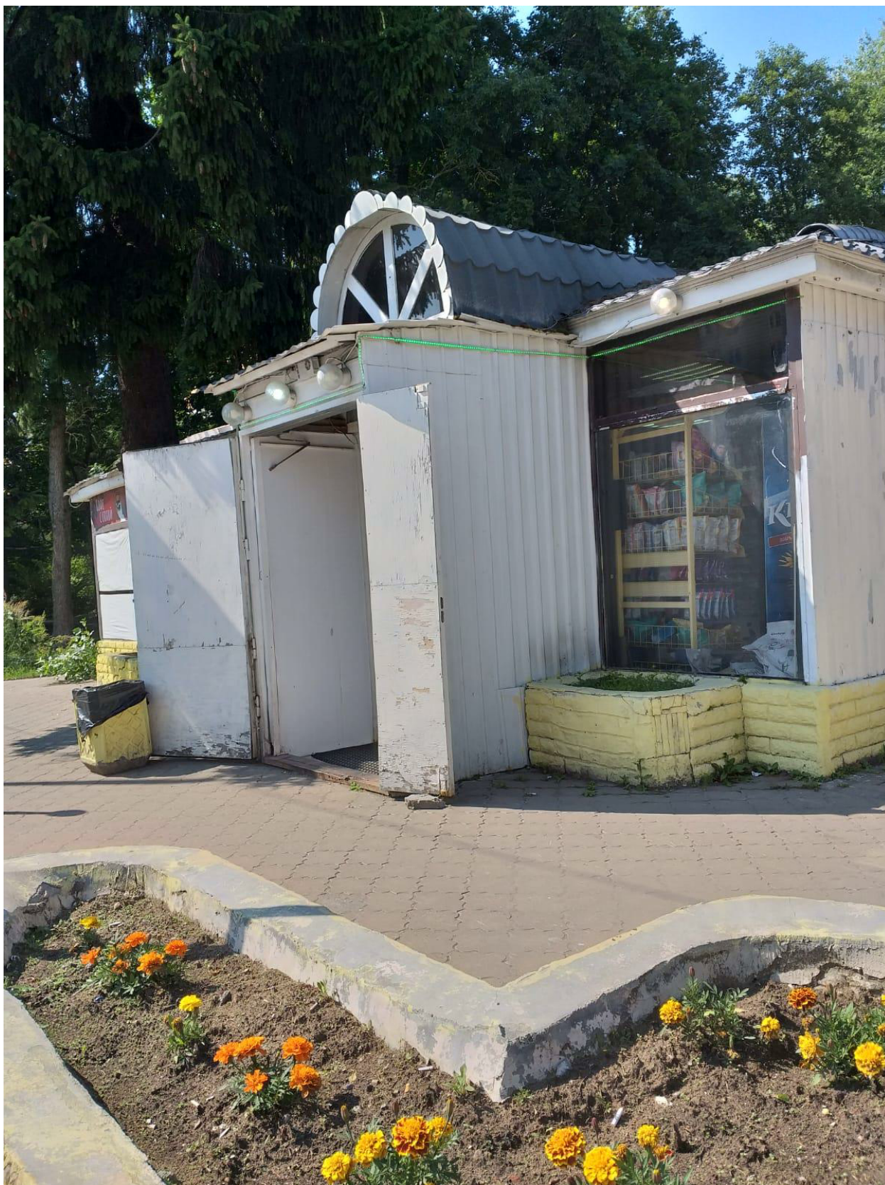
Фото 3. СПб, Осиновая Роща, Приозерское шоссе, дом 15, корп. 6. Фрагмент лицевого фасада. Вход
