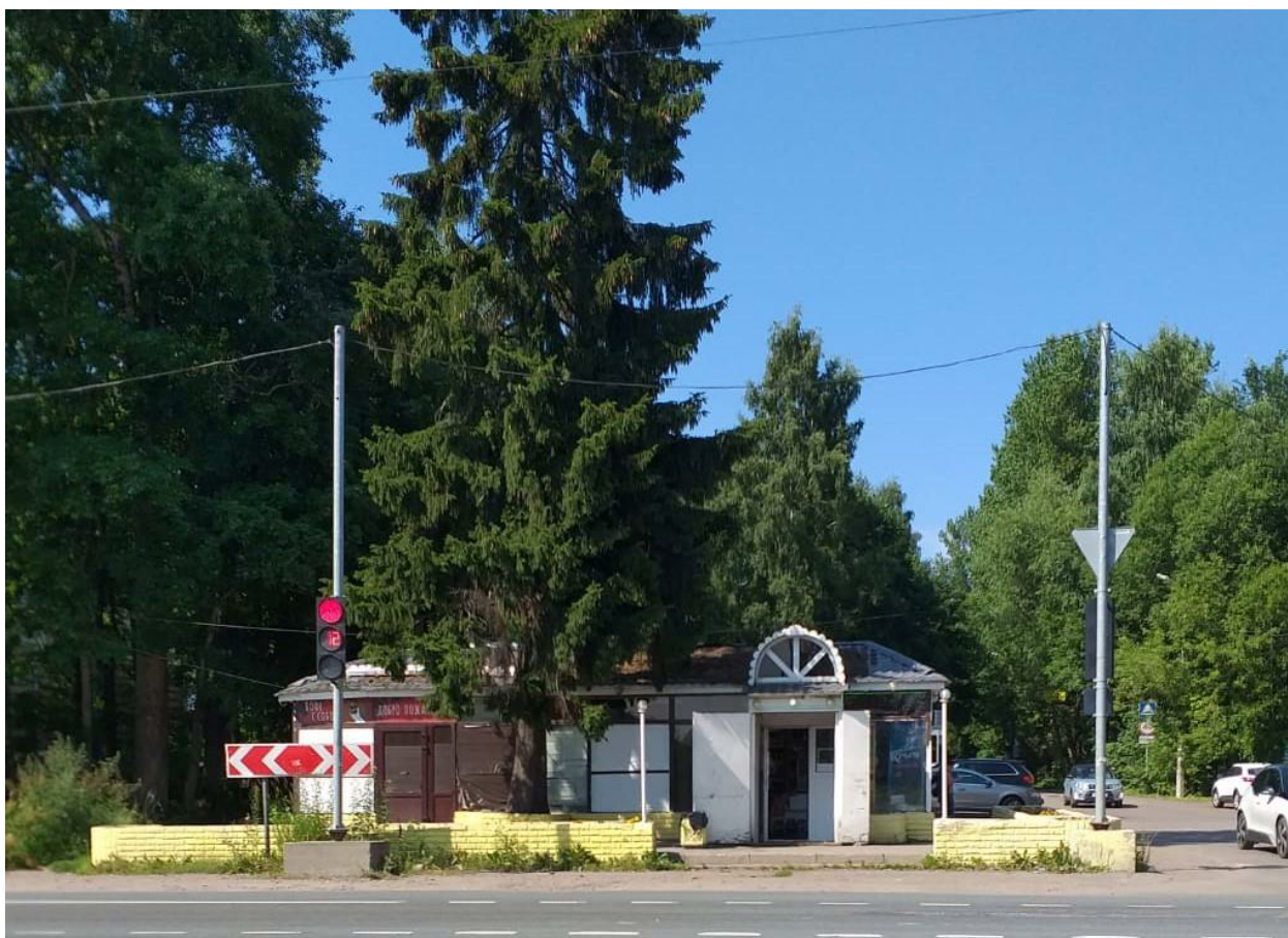
Фото 1. СПб, Осиновая Роща, Приозерское шоссе, дом 15, корп. 6. Лицевой фасад по Приозерскому шоссе.
