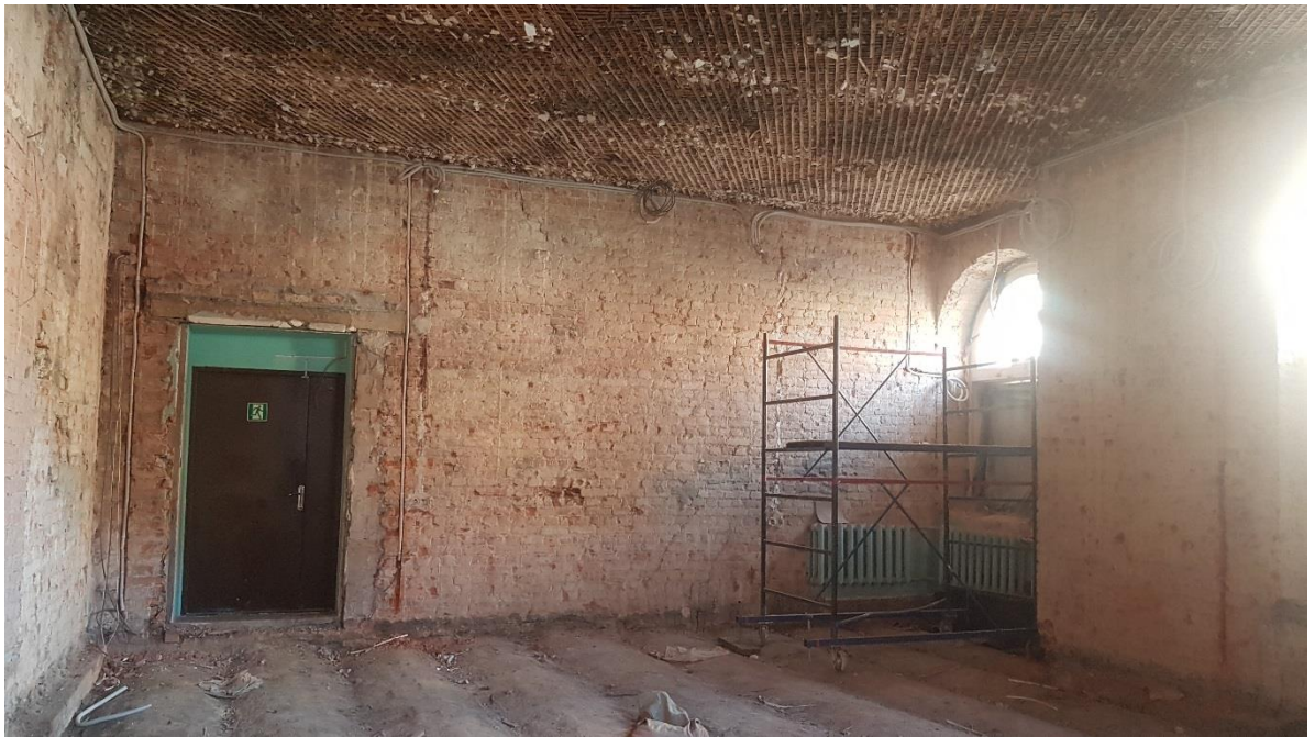
Фото 1. Помещение № 3. Вид в сторону входной двери.
