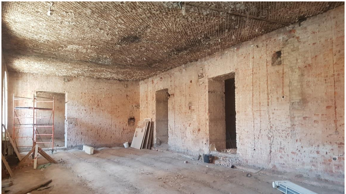
Фото 10. Помещение № 6. Вид на дверные проемы.
