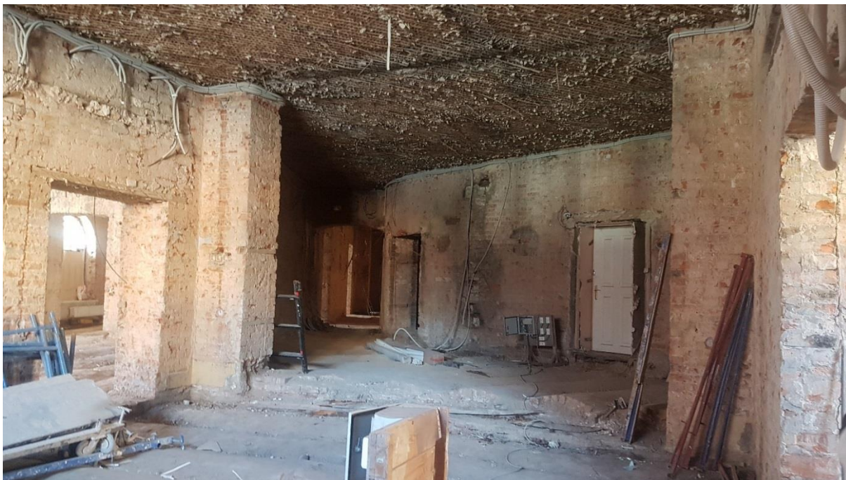
Фото 3. Помещение № 4. Вид в сторону пом. № 2.
