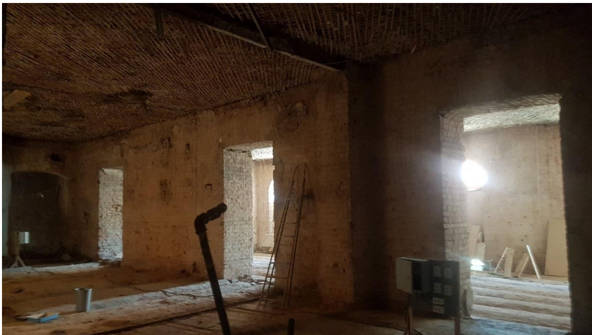
Фото 21. Помещение № 14. Вид на дверные проемы.
