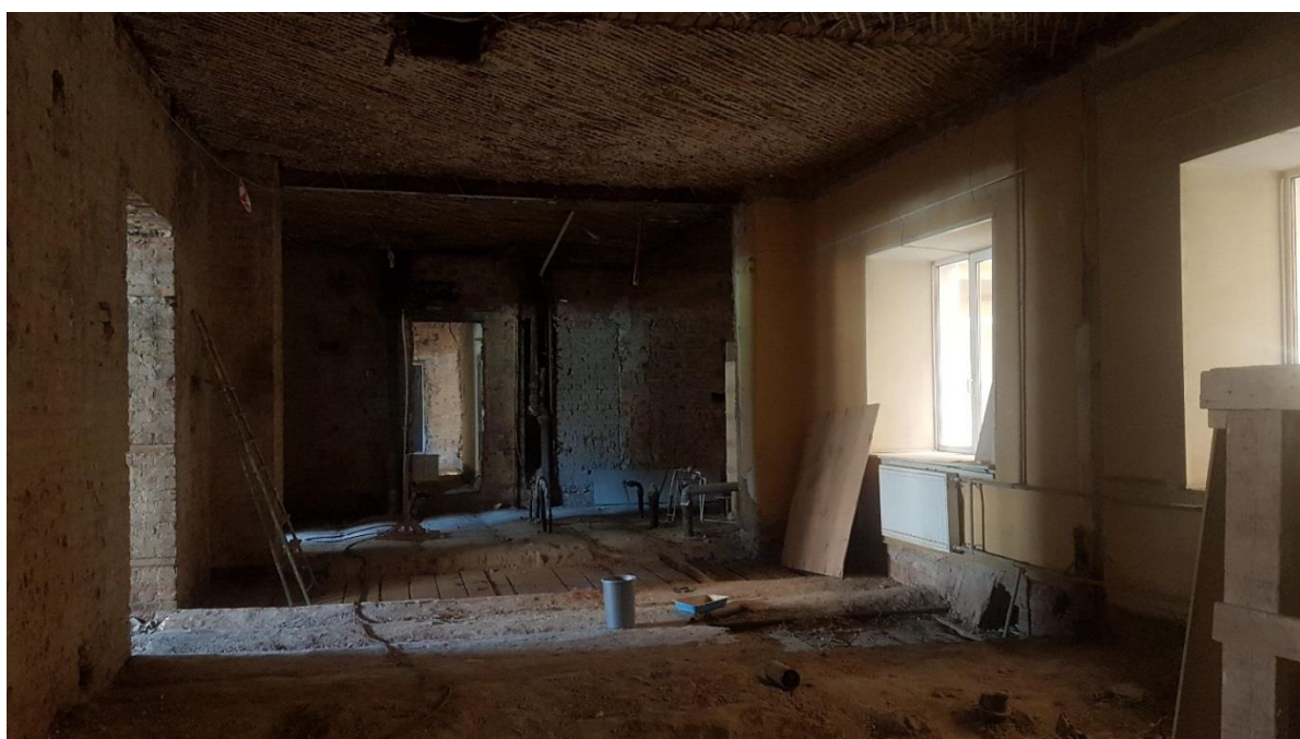
Фото 24. Помещение № 17. Вид на дверной проем в пом. № 10.
