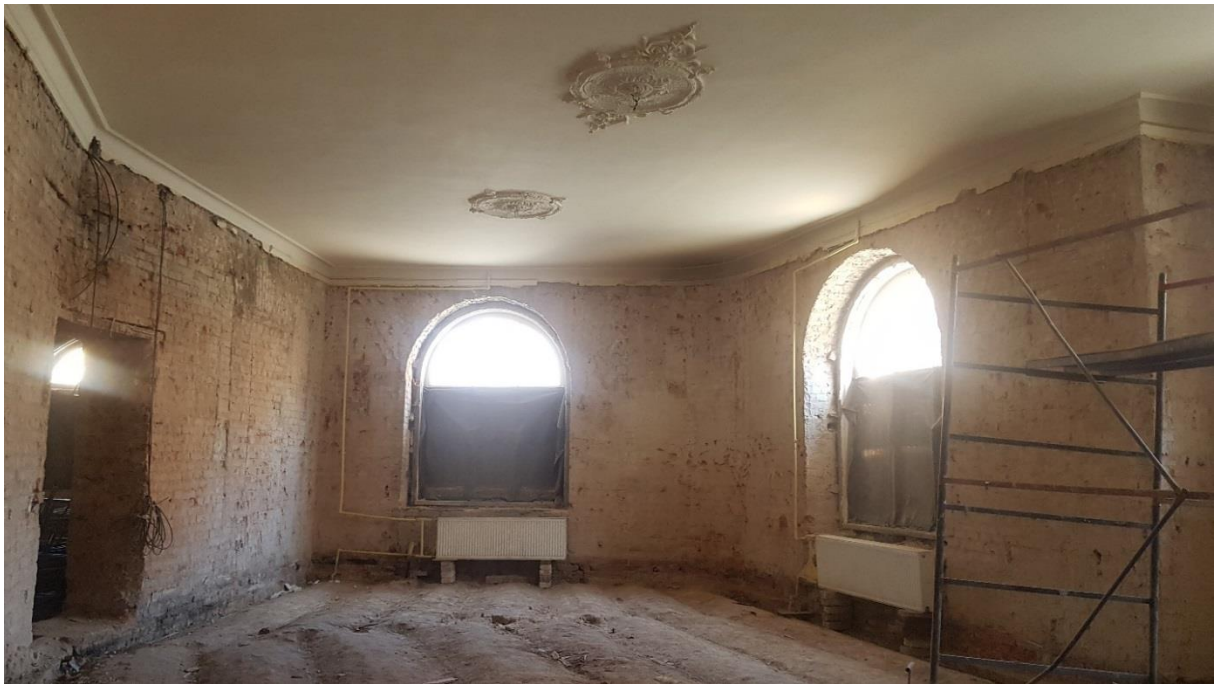
Фото 9. Помещение № 5. Вид на оконные проемы.
