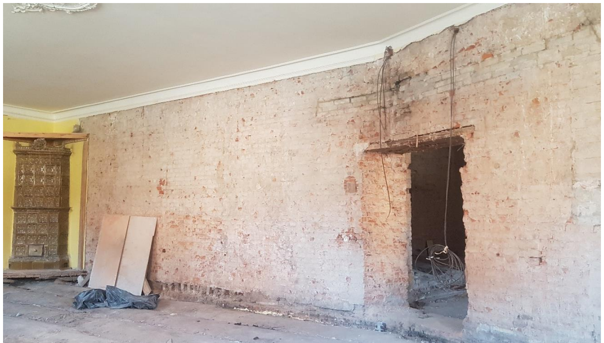
Фото 8. Помещение № 5. Вид на дверной проем в пом. № 4.
