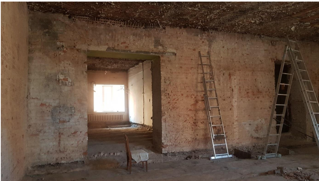
Фото 17. Помещение № 7. Вид на дверной проем в пом. № 10.
