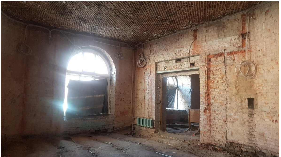
Фото 2. Помещение № 3. Вид в сторону пом. № 4.
