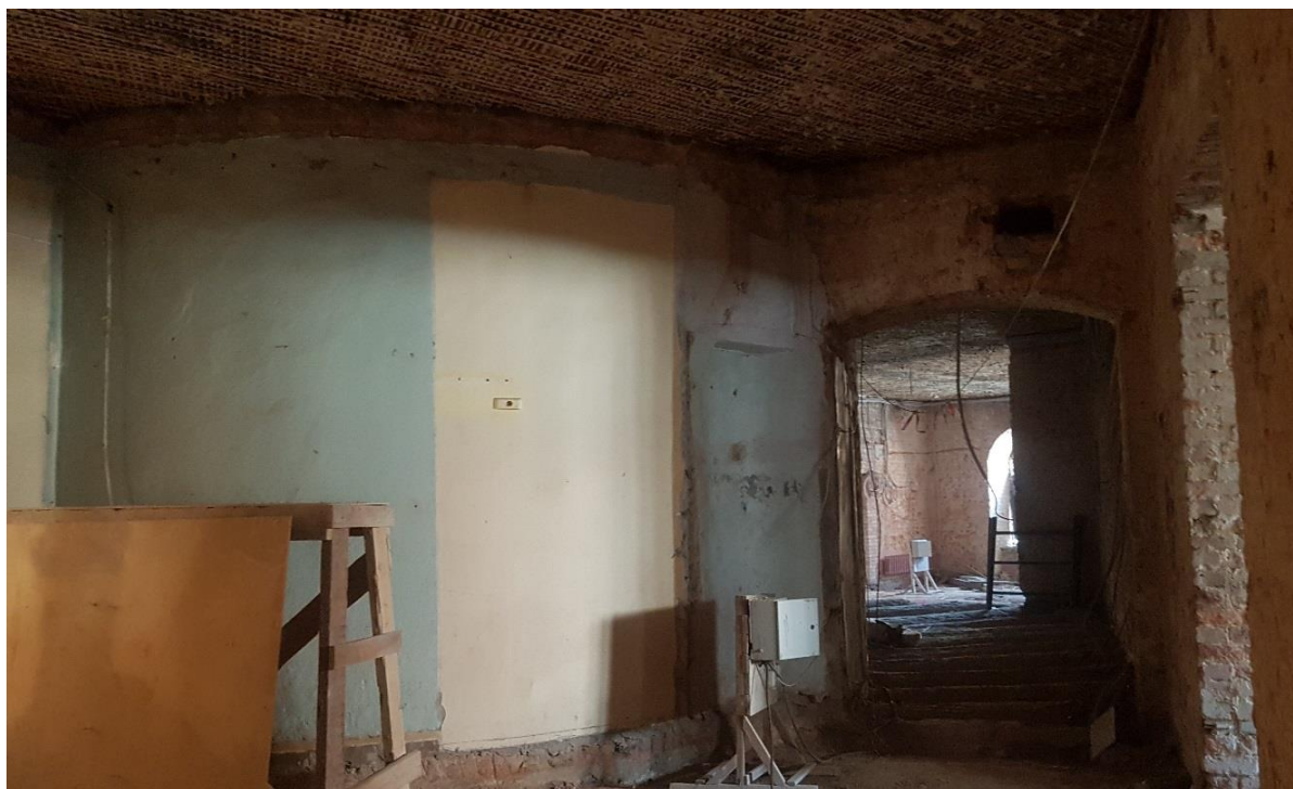
Фото 22. Помещение № 17. Вид на дверной проем в пом. № 2.
