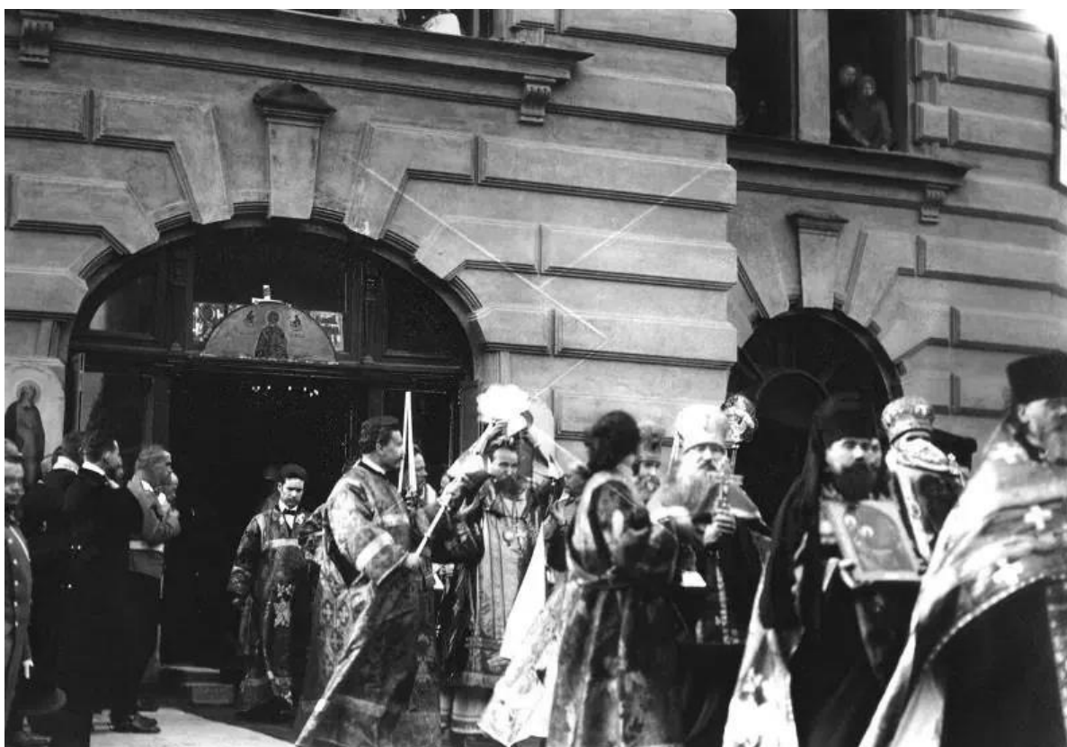
16. Закладка Николо-Александровского («Барградского») храма. 1913.
