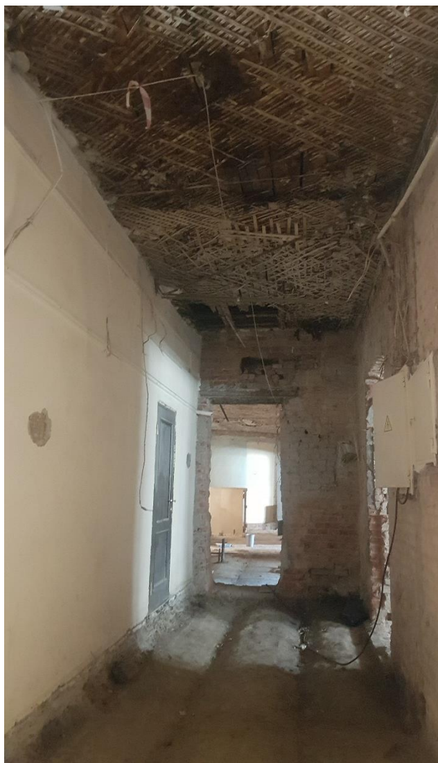
Фото 19. Помещение № 10. Вид на дверной проем в пом. № 14.
