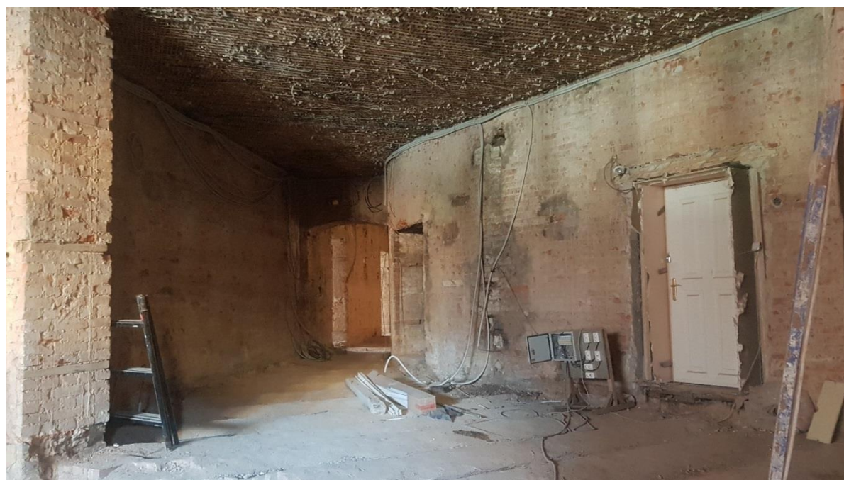
Фото 26. Помещение № 2. Вид на дверной проем в пом. № 17.
