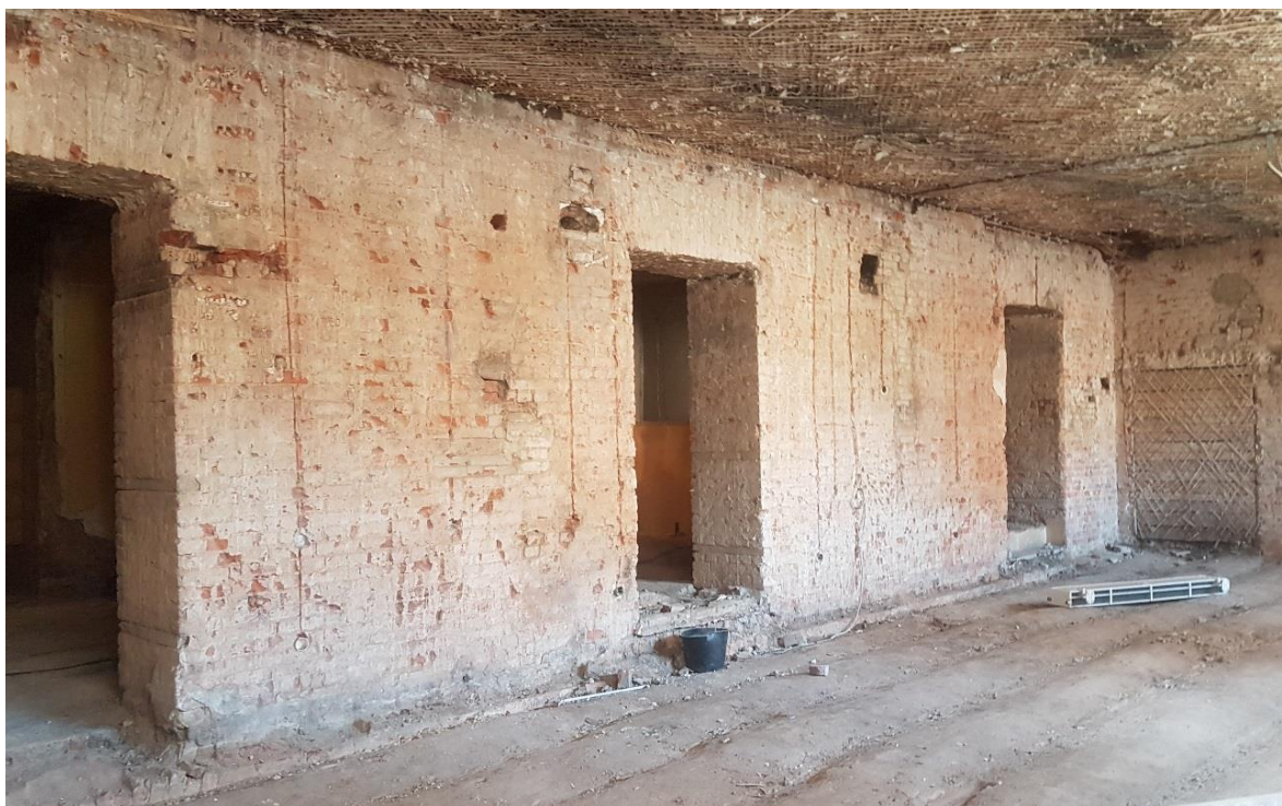
Фото 13. Помещение № 6. Вид на дверные проемы.
