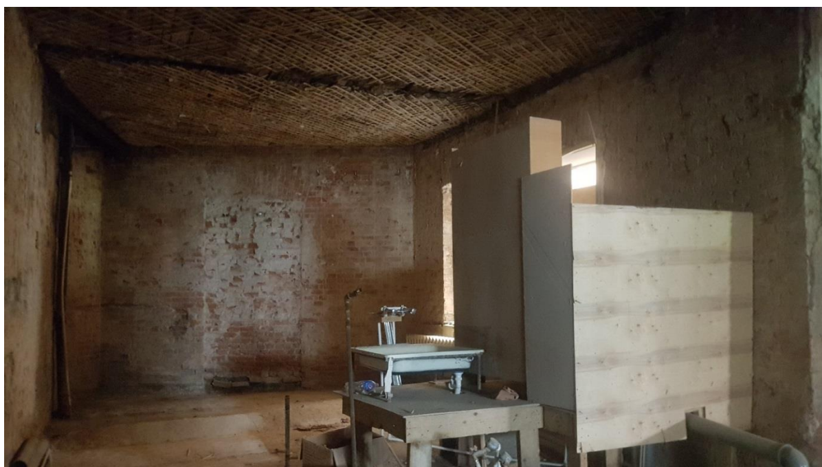
Фото 20. Помещение № 14. Вид на оконные проемы.
