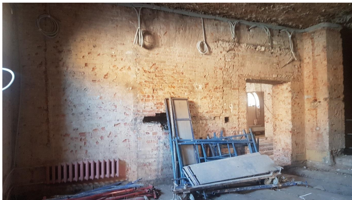
Фото 4. Помещение № 4. Вид на дверной проем в пом. № 5.
