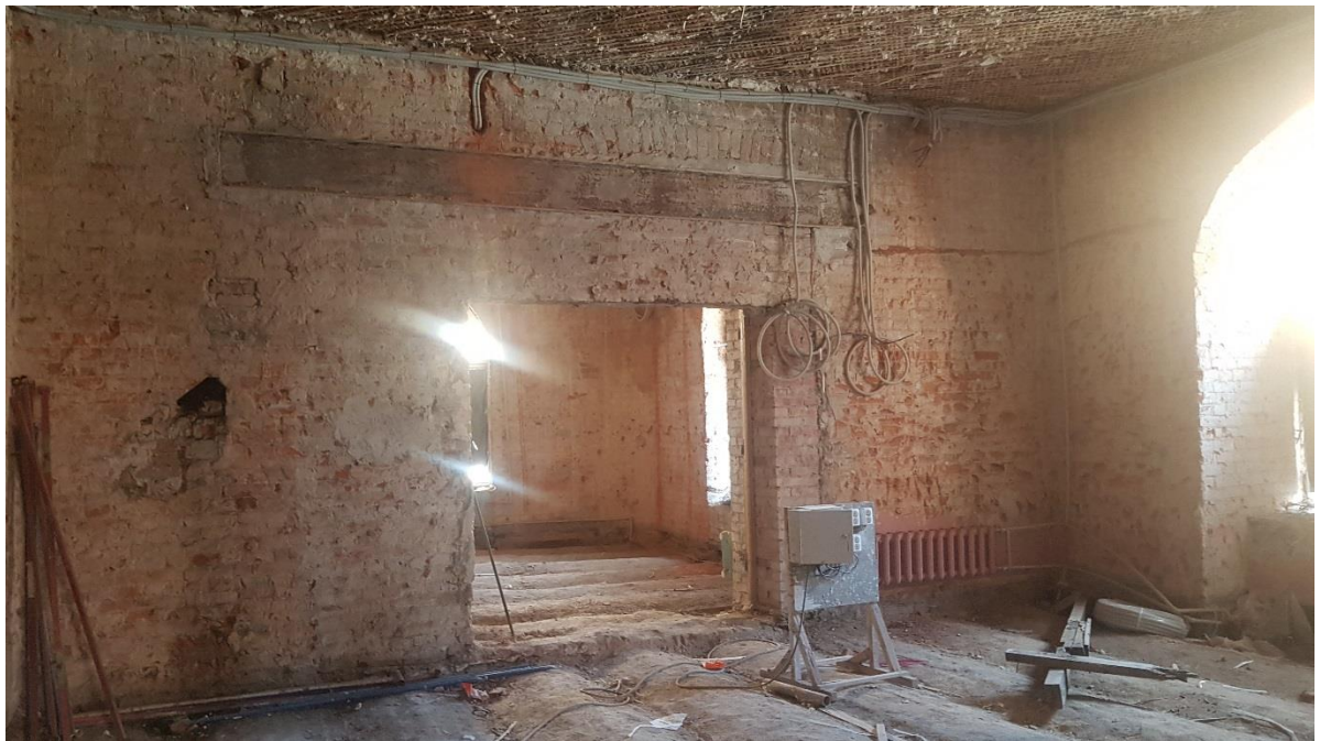
Фото 6. Помещение № 4. Вид на дверной проем в пом. № 3.
