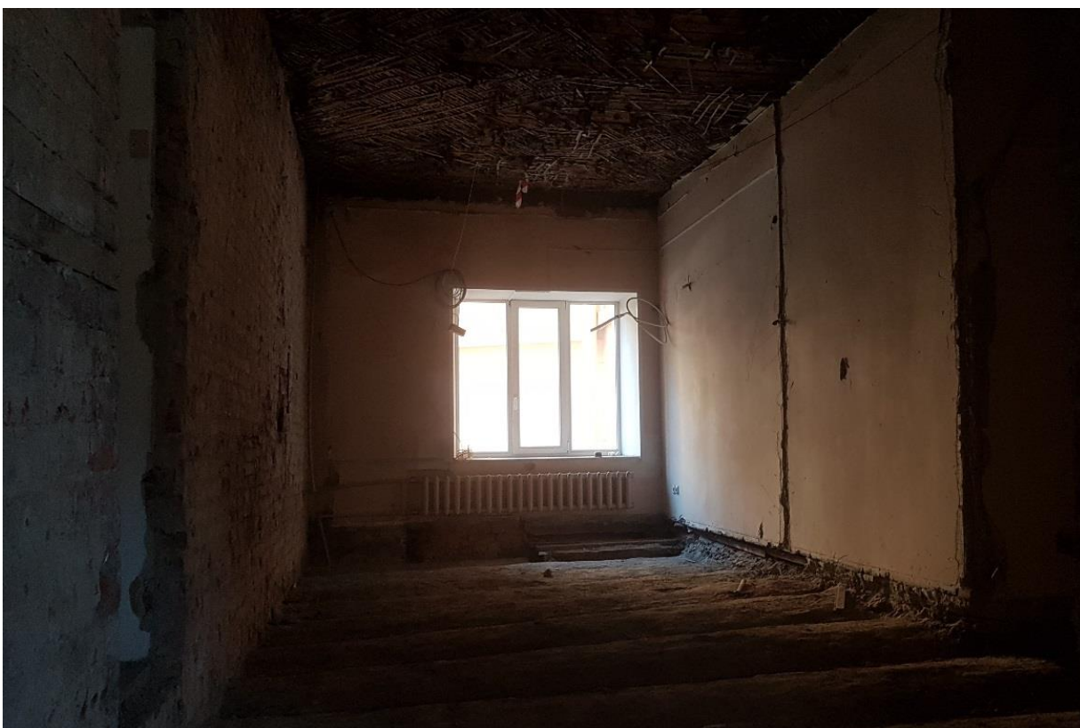
Фото 18. Помещение № 10. Вид на оконный проем пом. № 9.
