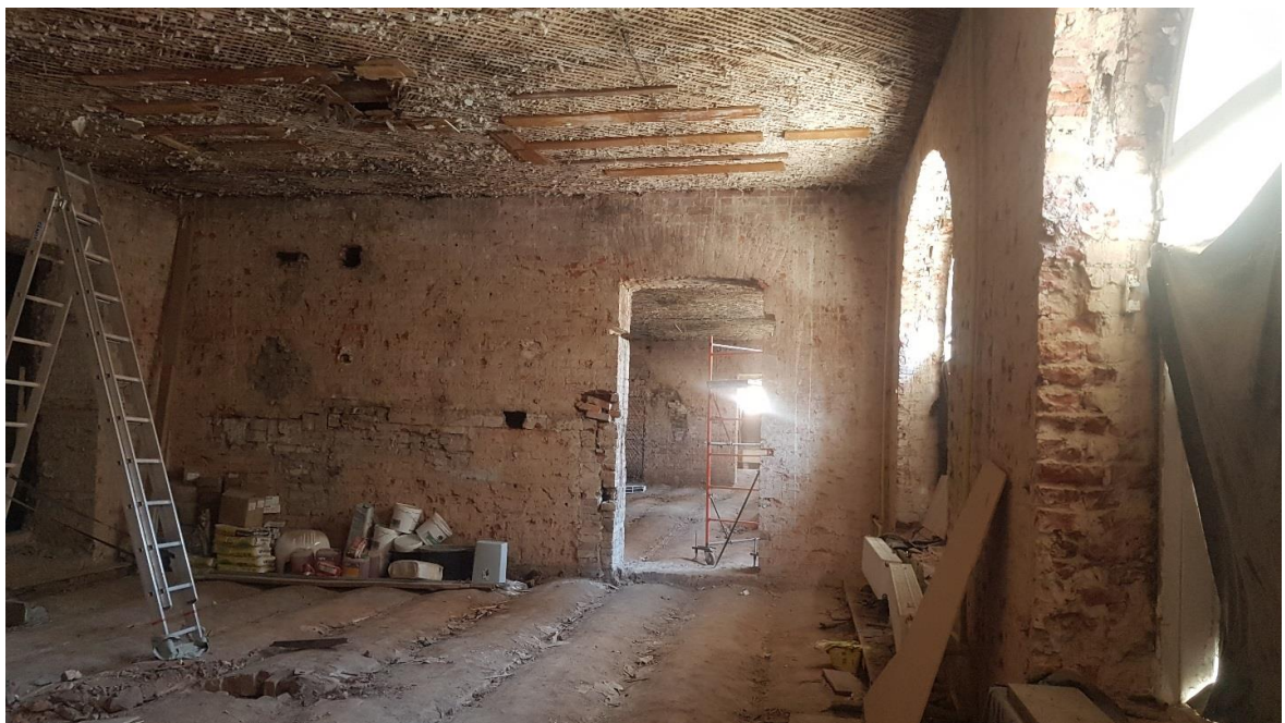
Фото 16. Помещение № 7. Вид на дверной проем в пом. № 6.
