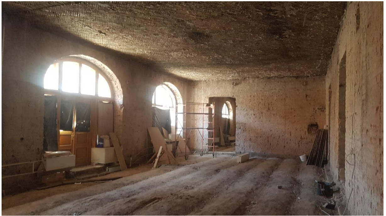
Фото 11. Помещение № 6. Вид на оконные проемы.
