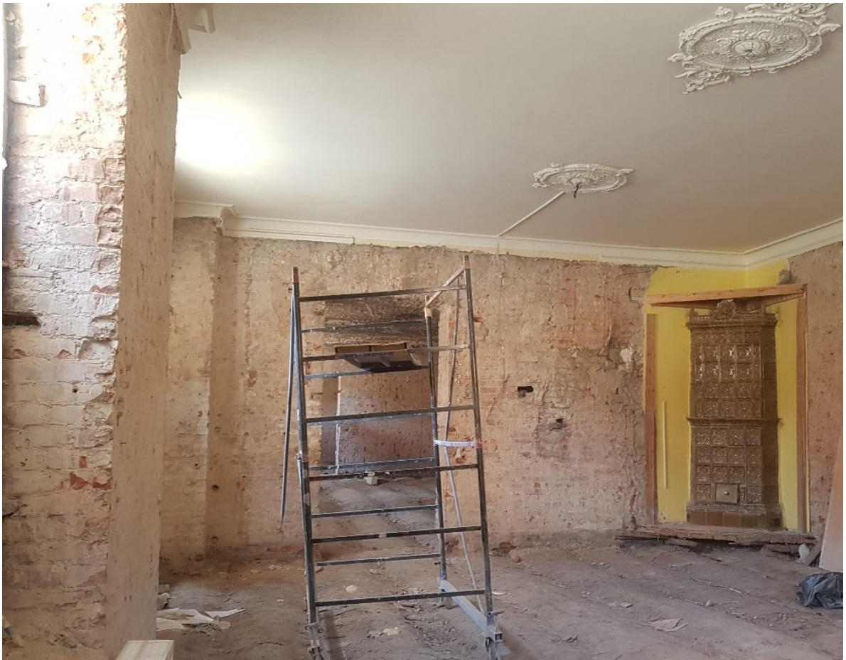
Фото 7. Помещение № 5. Вид на дверной проем в пом. № 6.
