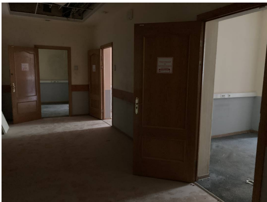
Фото 50. Интерьер объекта культурного наследия федерального значения «Казармы(Трехэскадронный корпус)», пом. 129-Н
