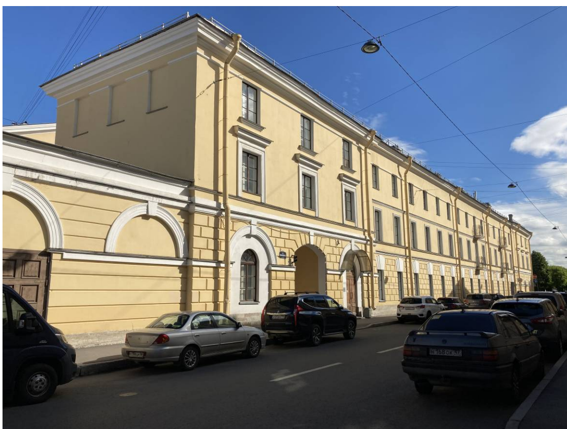
Фото 8. Лицевой фасад объекта культурного наследия федерального значения «Казармы(Трехэскадронный корпус)».
