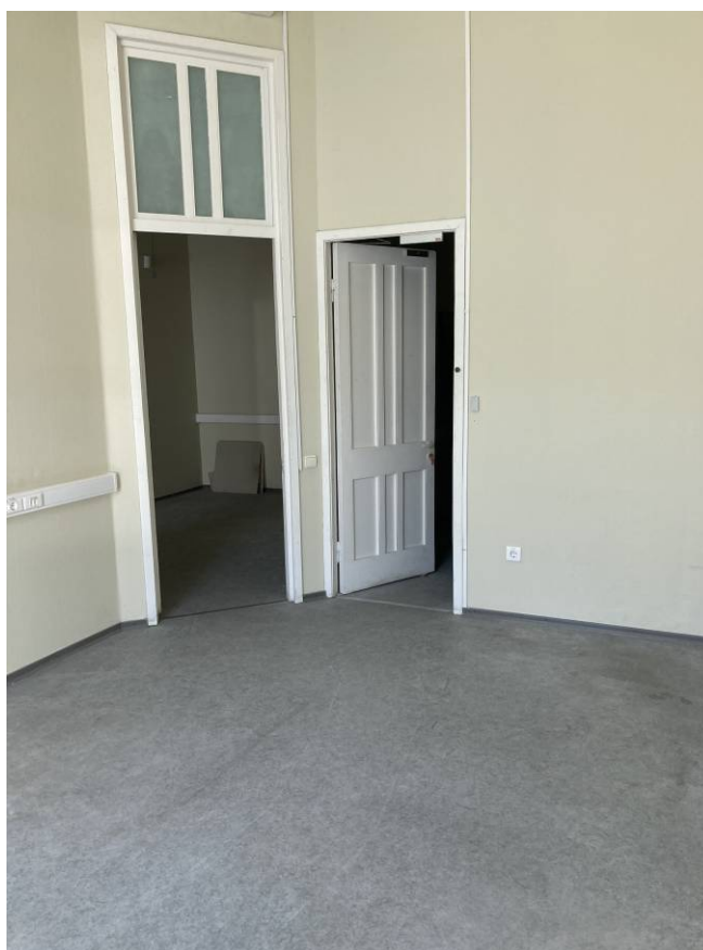
Фото 40. Интерьер объекта культурного наследия федерального значения «Казармы(Трехэскадронный корпус)», пом. 53-Н
