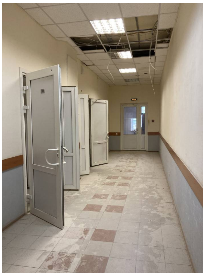
Фото 44. Интерьер объекта культурного наследия федерального значения «Казармы(Трехэскадронный корпус)», пом. 129-Н
