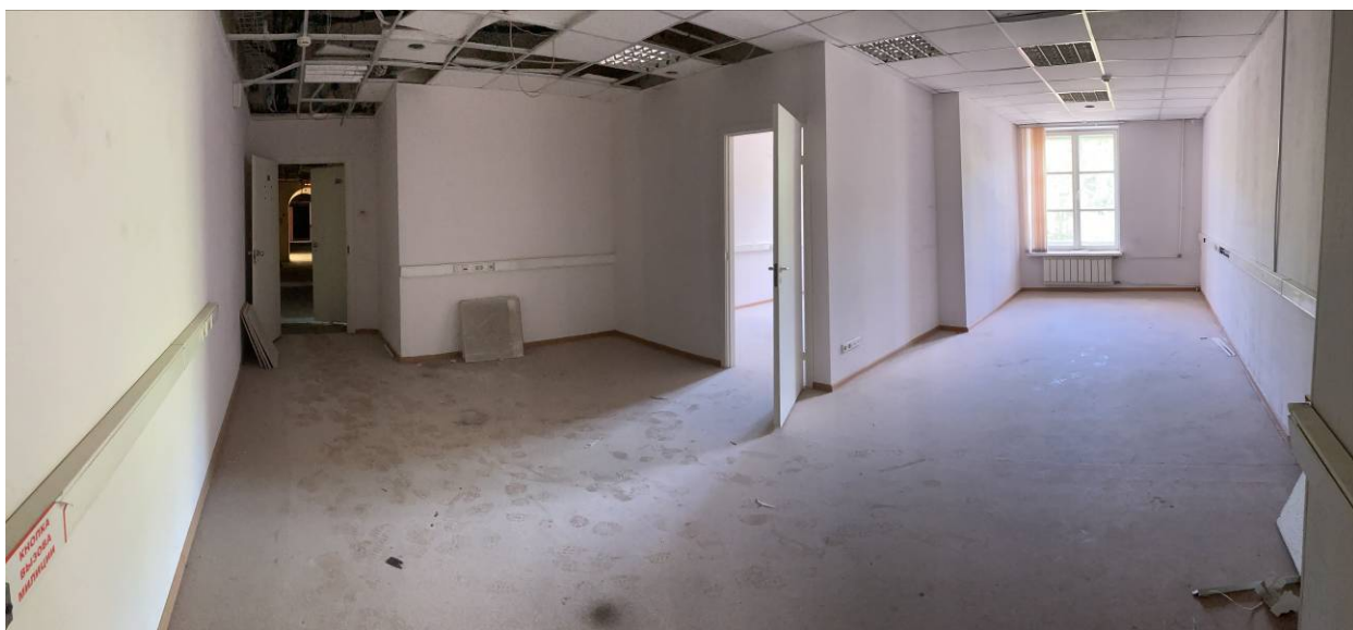
Фото 68. Интерьер объекта культурного наследия федерального значения «Казармы(Трехэскадронный корпус)», пом. 130-Н
