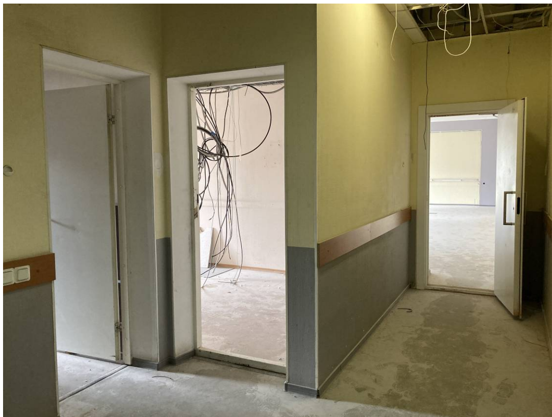
Фото 45. Интерьер объекта культурного наследия федерального значения «Казармы(Трехэскадронный корпус)», пом. 129-Н
