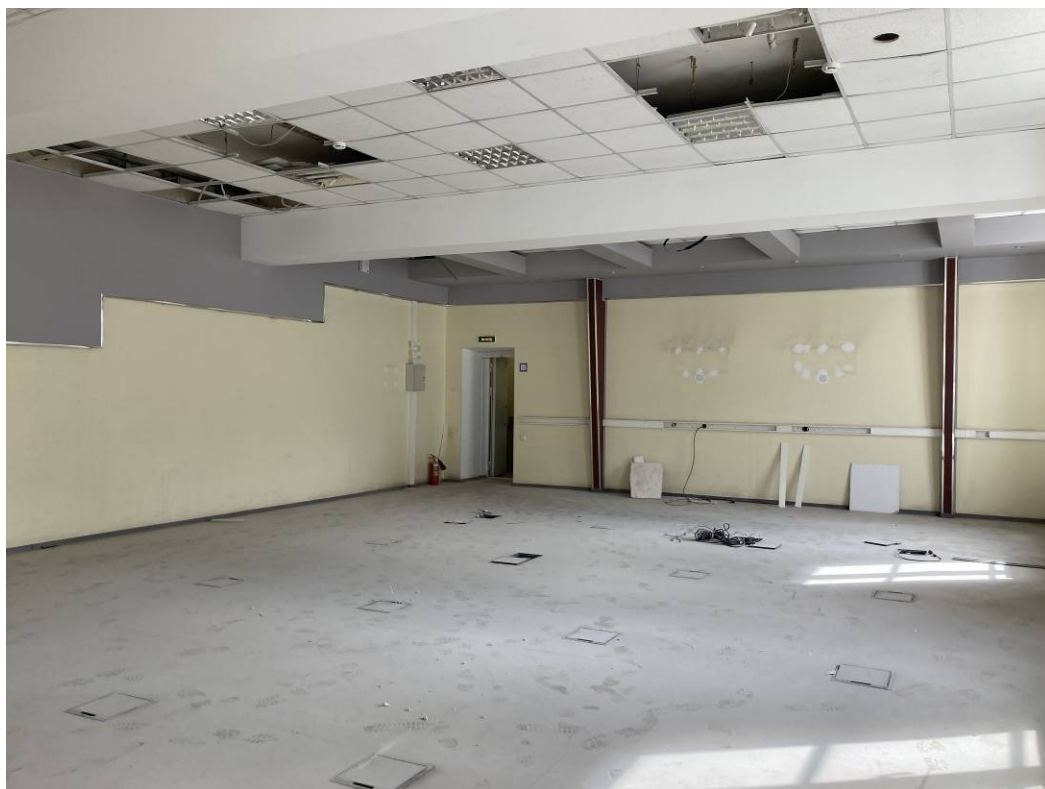
Фото 47. Интерьер объекта культурного наследия федерального значения «Казармы(Трехэскадронный корпус)», пом. 129-Н
