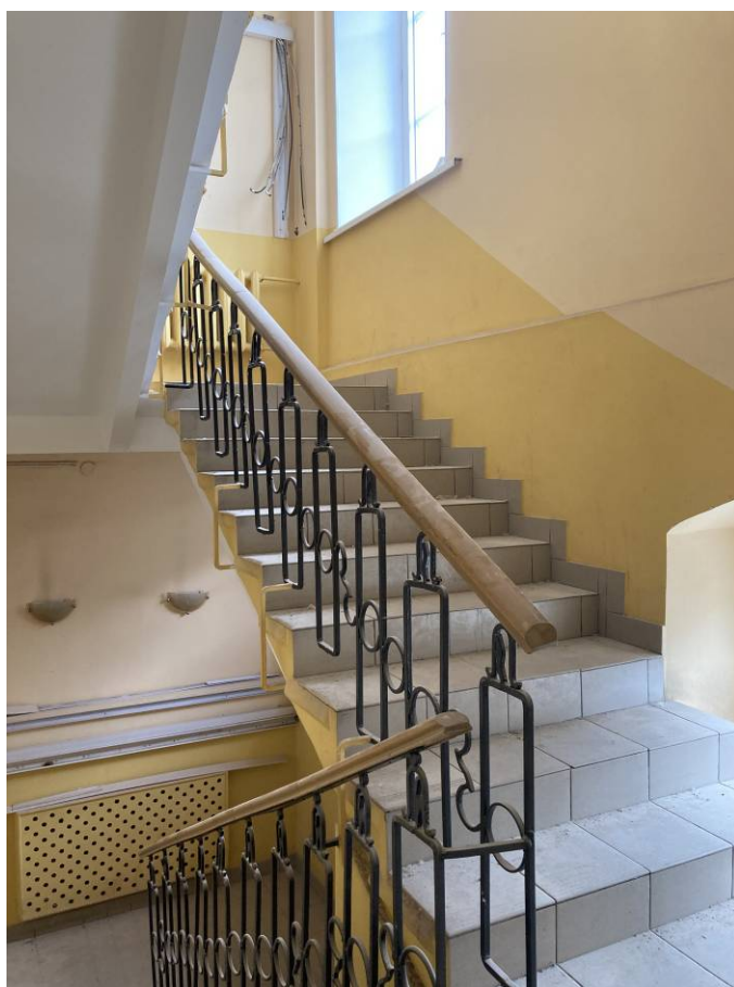
Фото 42. Интерьер объекта культурного наследия федерального значения «Казармы(Трехэскадронный корпус)», пом. 129-Н
