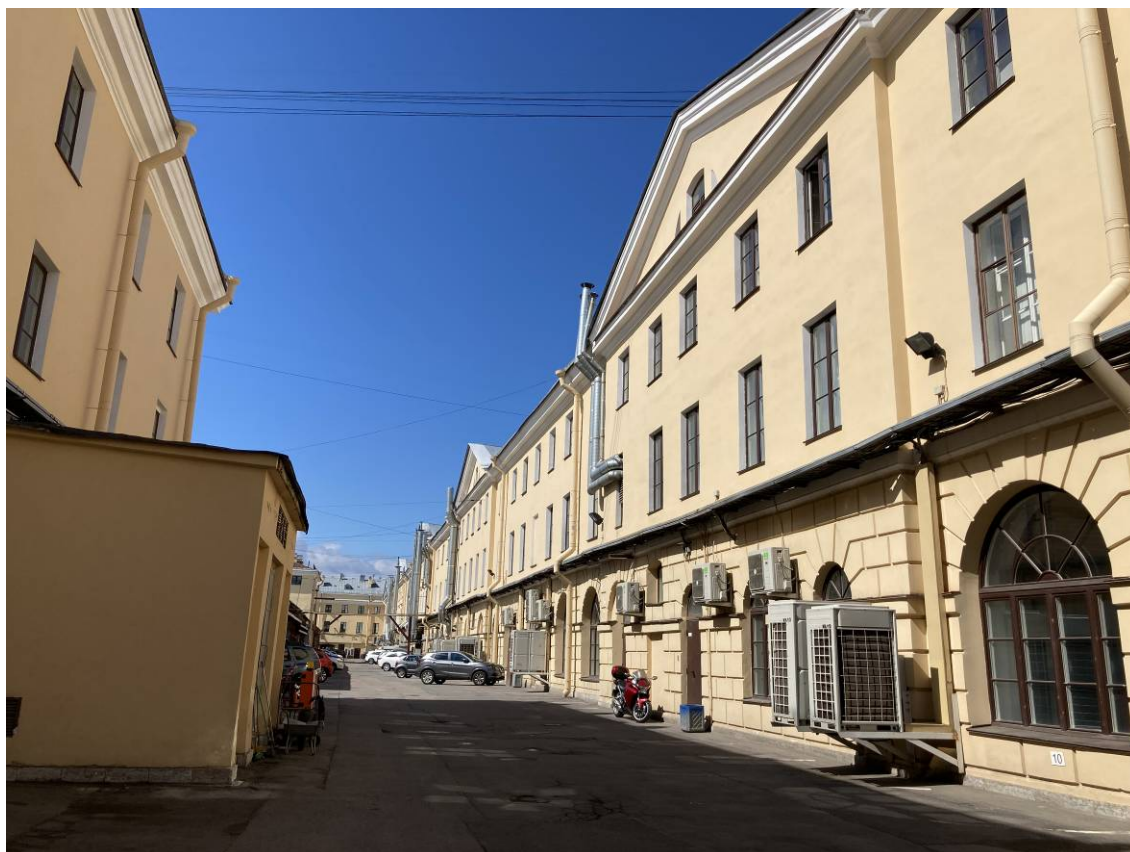
Фото 23. Фрагмент дворового фасада объекта культурного наследия федерального значения «Казармы(Трехэскадронный корпус)»
