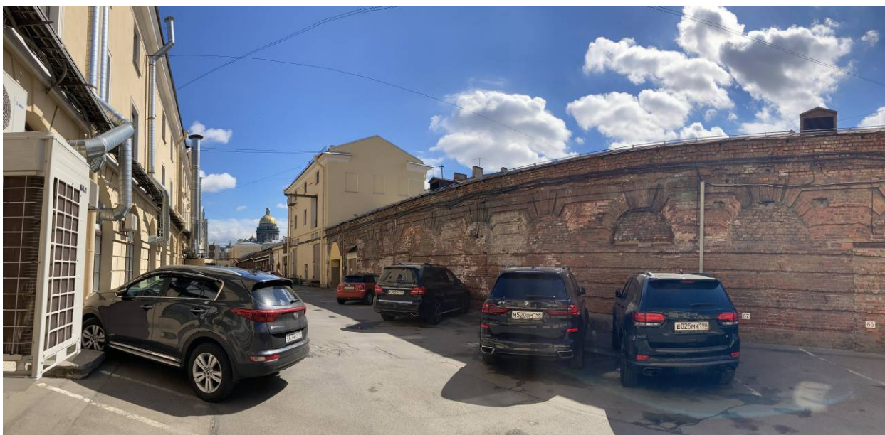
Фото 17. Фрагмент дворового фасада объекта культурного наследия федерального значения «Казармы(Трехэскадронный корпус)»
