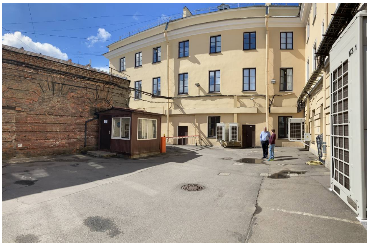
Фото 16. Фрагмент дворового фасада объекта культурного наследия федерального значения «Казармы(Трехэскадронный корпус)»
