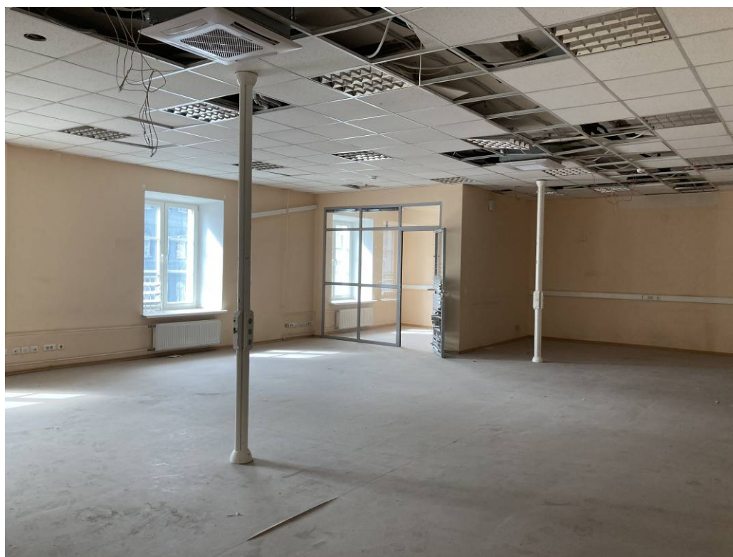
Фото 72. Интерьер объекта культурного наследия федерального значения «Казармы(Трехэскадронный корпус)», пом. 130-Н
