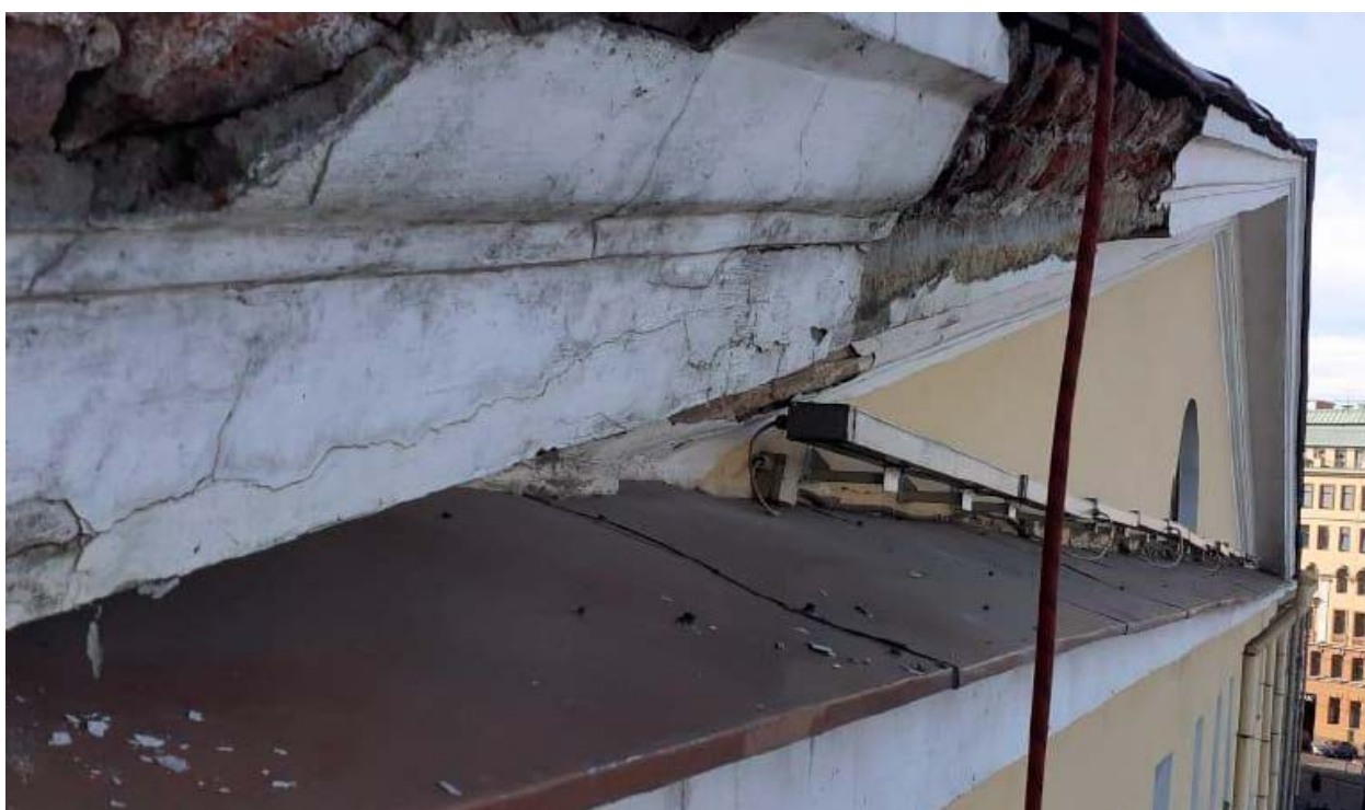
3. Фрагмент венчающего карниза северо-восточного лицевого фасада объекта культурного наследия регионального значения «Дом Балашова А.Д. (Стенбок-Фермора)», расположенного по адресу: г. Санкт-Петербург, Макарова наб., д. 26, литера А. 17.06.2022.
