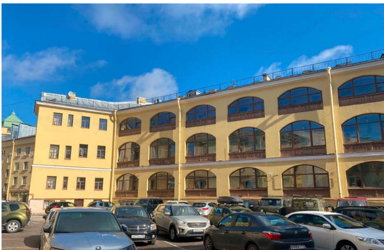
б. Фрагмент дворового юго-западного фасада объекта культурного наследия регионального значения «Дом Балашова А.Д. (Стенбок-Фермора)», расположенного по адресу: г. Санкт-Петербург, Макарова наб., д. 26, литера А. 17.06.2022.
