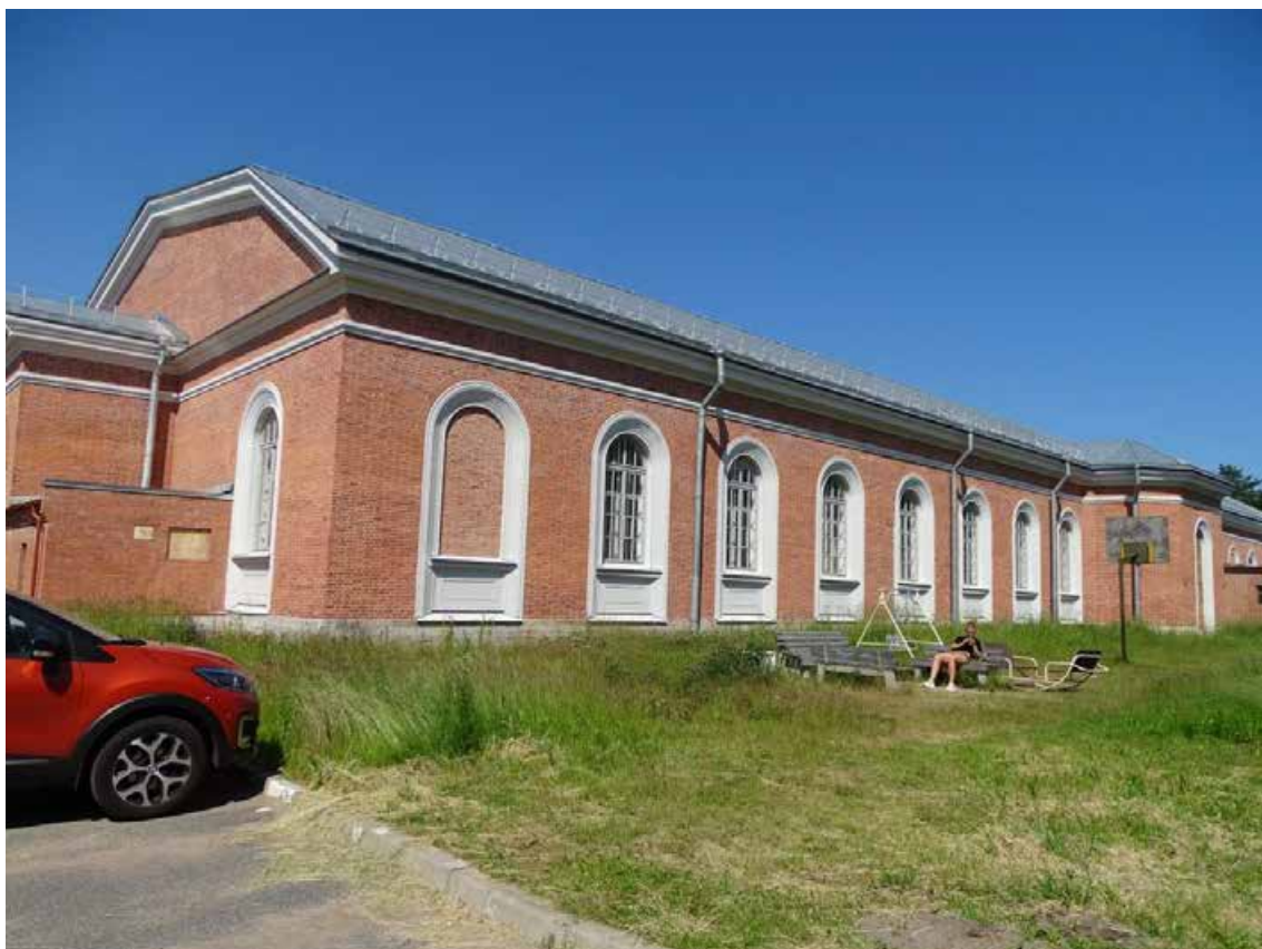
Фото 20. Объект культурного наследия регионального значения «Манеж Уланского полка». Южный и Восточный фасады. Съемка 20.06.2022 г. Трушковский В. Э.
