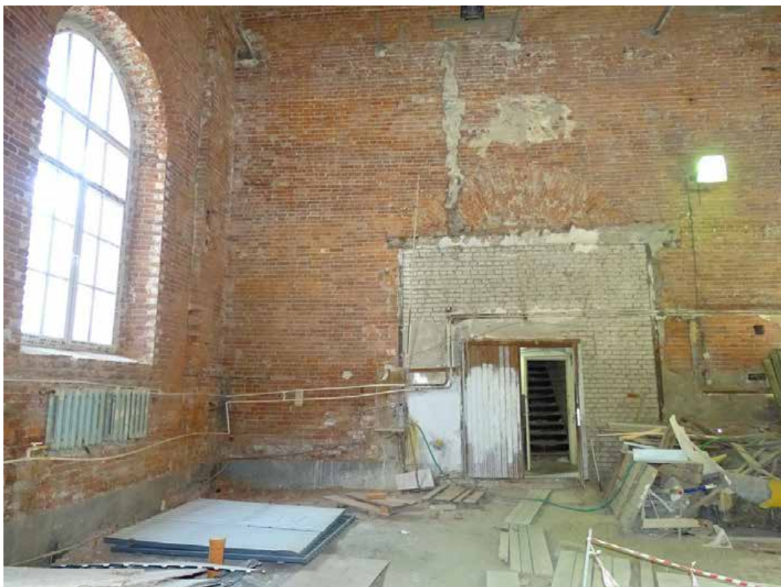
Фото 14. 1-й этаж. Помещение 33/5,9; 34/65,5; 35/2,4; 36/2,5; 37/65,0; 38/2417,8.
