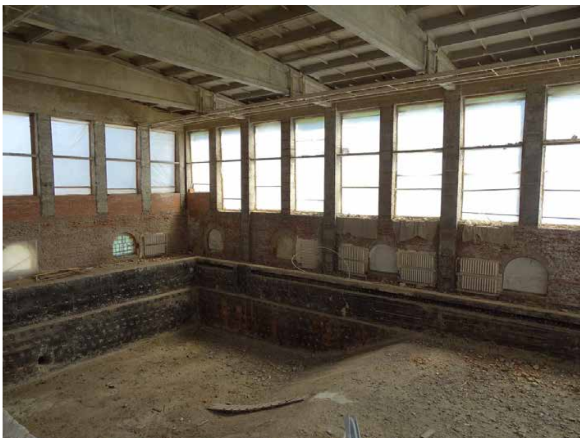
Фото 02. 3-й этаж. Помещение 85/83,9. Вид на Бассейн 2-го этажа.
