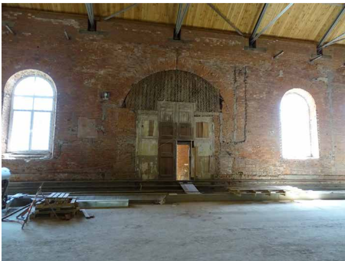
Фото 04. 1-й этаж. Помещение 33/5,9; 34/65,5; 35/2,4; 36/2,5; 37/65,0; 38/2417,8.
