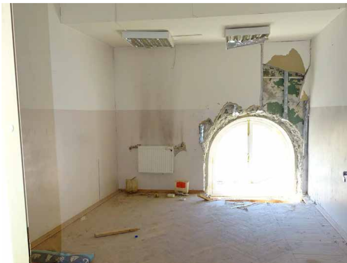
Фото 05. 2-й этаж. Помещение 65/15,9.
