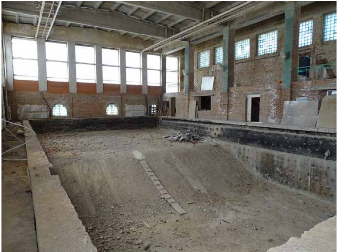
Фото 17. 2-й этаж. Помещение 53/508,4.
