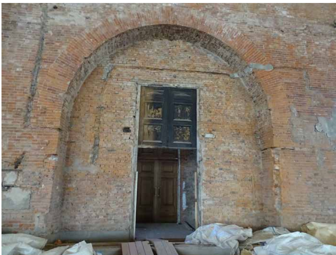
Фото 07. 1-й этаж. Помещение 33/5,9; 34/65,5; 35/2,4; 36/2,5; 37/65,0; 38/2417,8.
