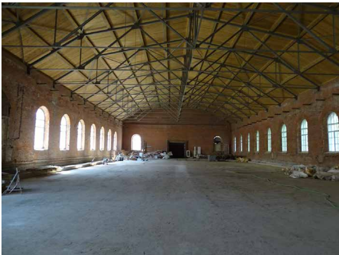
Фото 01. 1-й этаж. Помещение 33/5,9; 34/65,5; 35/2,4; 36/2,5; 37/65,0; 38/2417,8.
