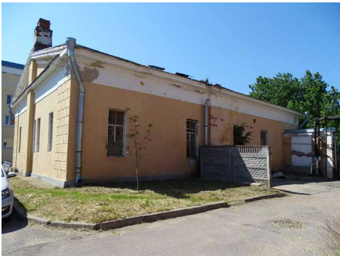
Фото 36. Объект культурного наследия федерального значения: «Главное здание»; «Ограда». Северный и восточный фасады. Съемка 20.06.2022 г. Трушковский В. Э.
