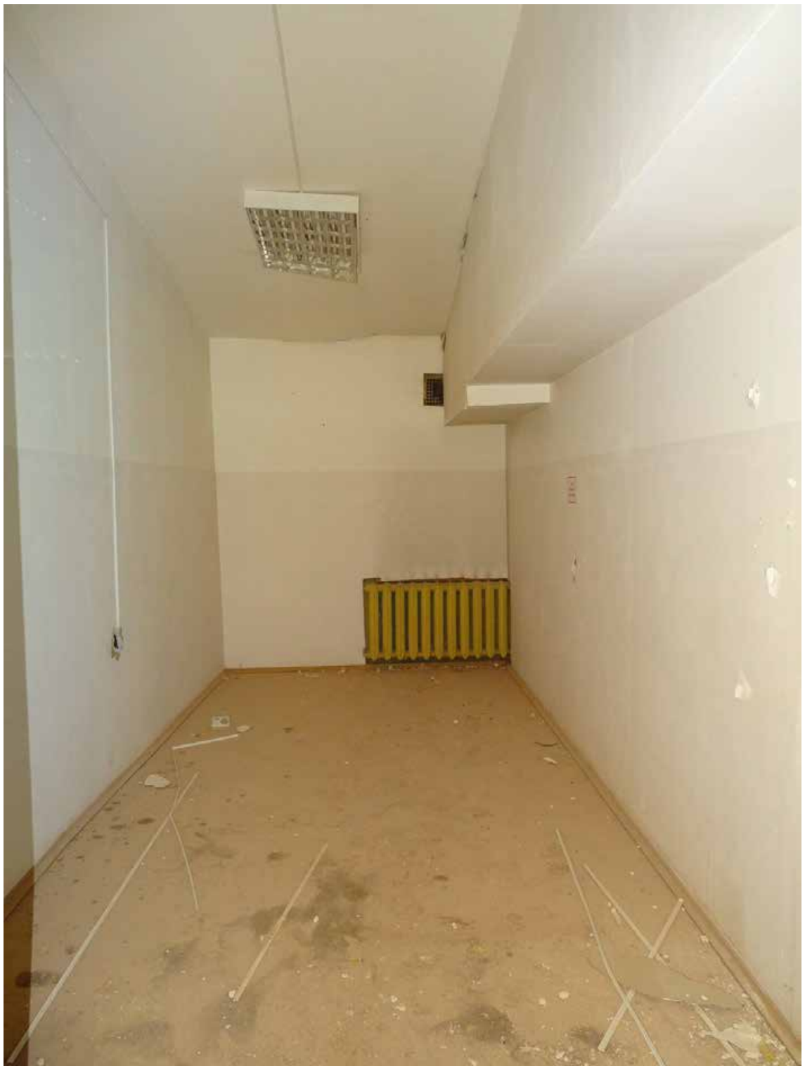
Фото 03. 2-й этаж. Помещение 69/7,8.
