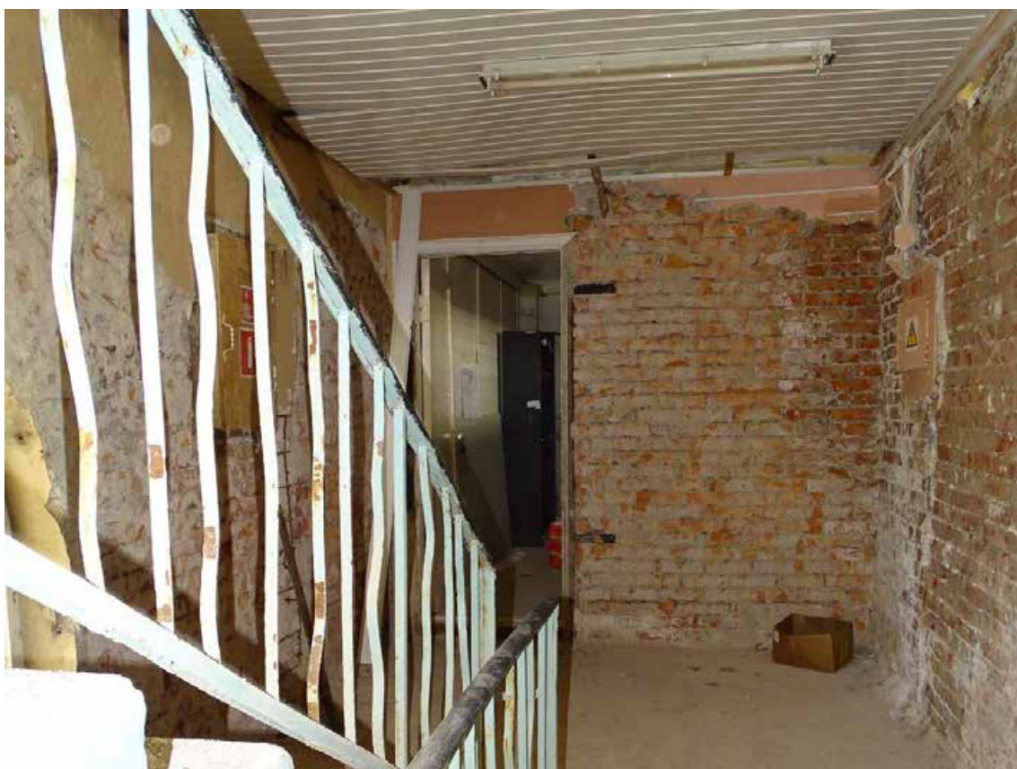
Фото 20. 2-й этаж. Помещение 55/29,7.
