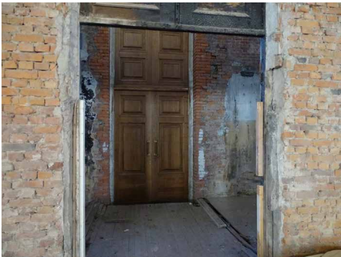
Фото 08. 1-й этаж. Помещение 33/5,9; 34/65,5; 35/2,4; 36/2,5; 37/65,0; 38/2417,8.
