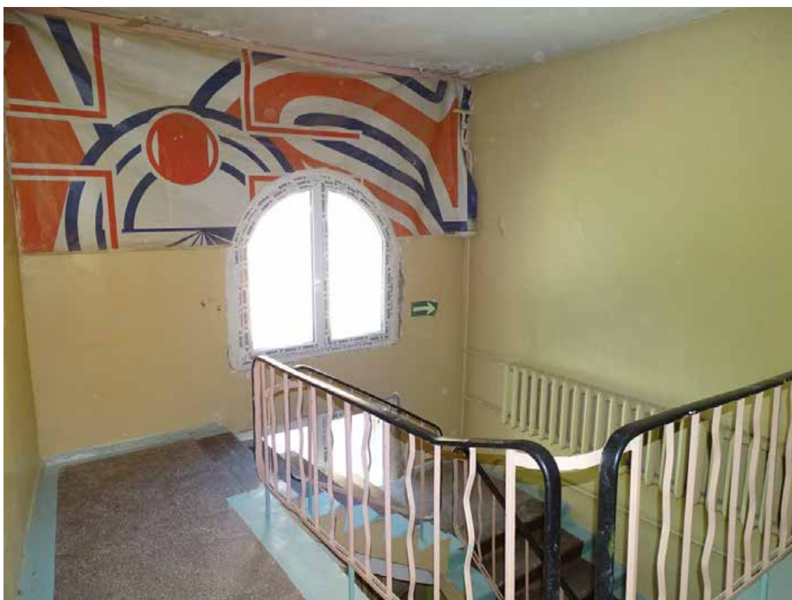
Фото 09. Лестничная площадка между 1-м и 2-м этажом.
