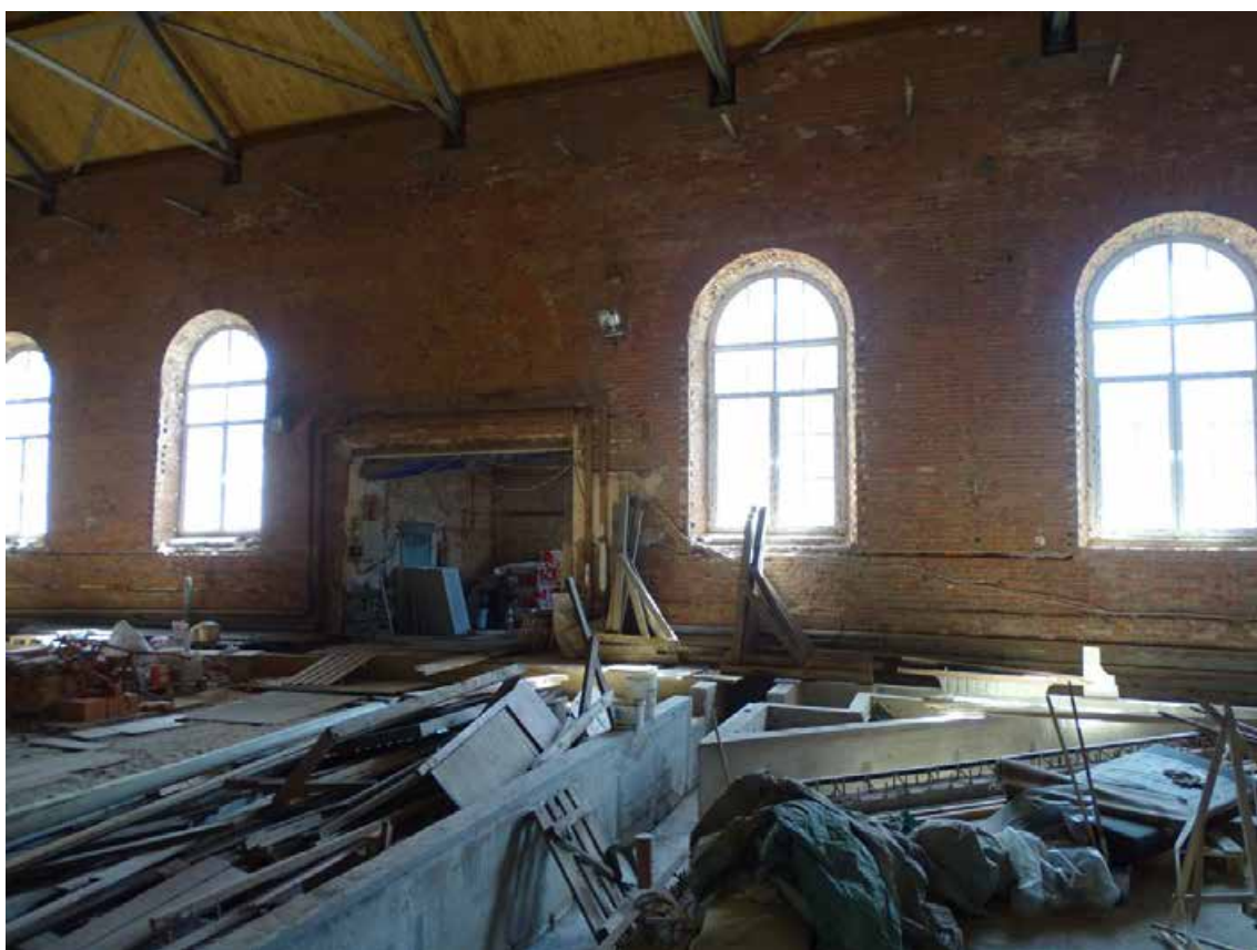
Фото 11. 1-й этаж. Помещение 33/5,9; 34/65,5; 35/2,4; 36/2,5; 37/65,0; 38/2417,8.
