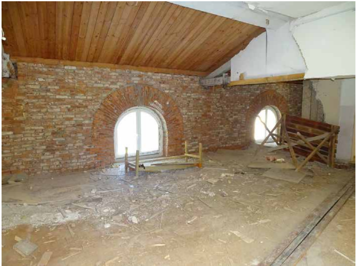
Фото 01. 2-й этаж. Помещение 68/31,0; 73/1,5; 74/21,0; 75/4,6.
