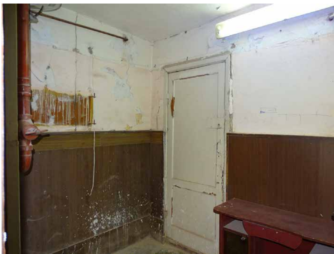
Фото 15. 1-й этаж. Помещение 13/6,2.
