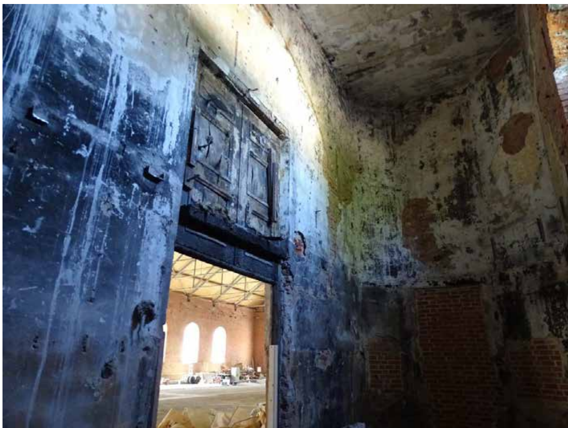
Фото 09. 1-й этаж. Помещение 47/26,3.
