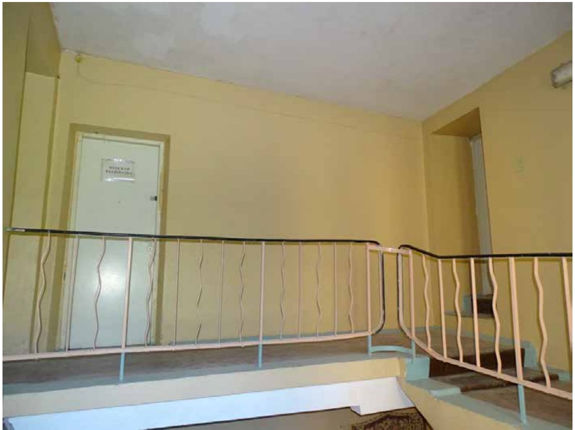
Фото 11. Площадка 2-го этажа.
