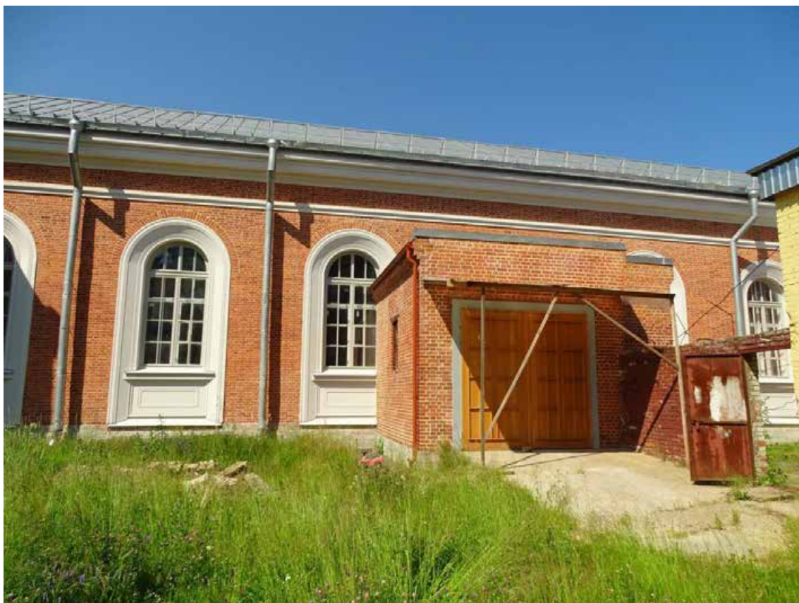
Фото 16. Объект культурного наследия регионального значения «Манеж Уланского полка». Восточный фасад. Фрагмент. Съемка 20.06.2022 г. Трушковский В. Э.
