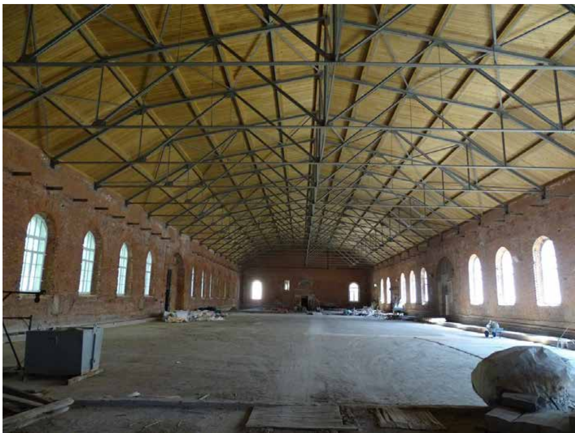
Фото 03. 1-й этаж. Помещение 33/5,9; 34/65,5; 35/2,4; 36/2,5; 37/65,0; 38/2417,8.
