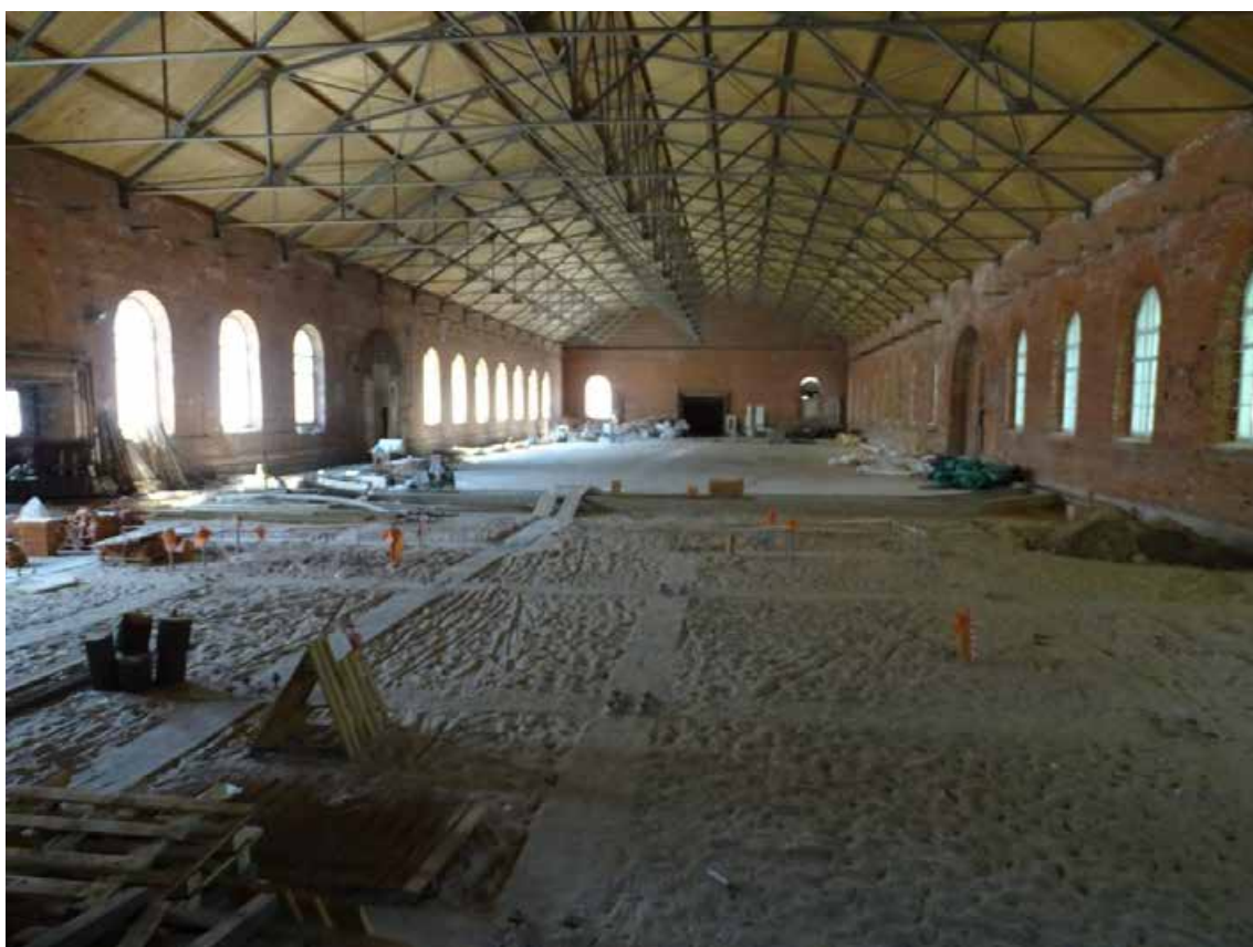
Фото 13. 1-й этаж. Помещение 33/5,9; 34/65,5; 35/2,4; 36/2,5; 37/65,0; 38/2417,8.
