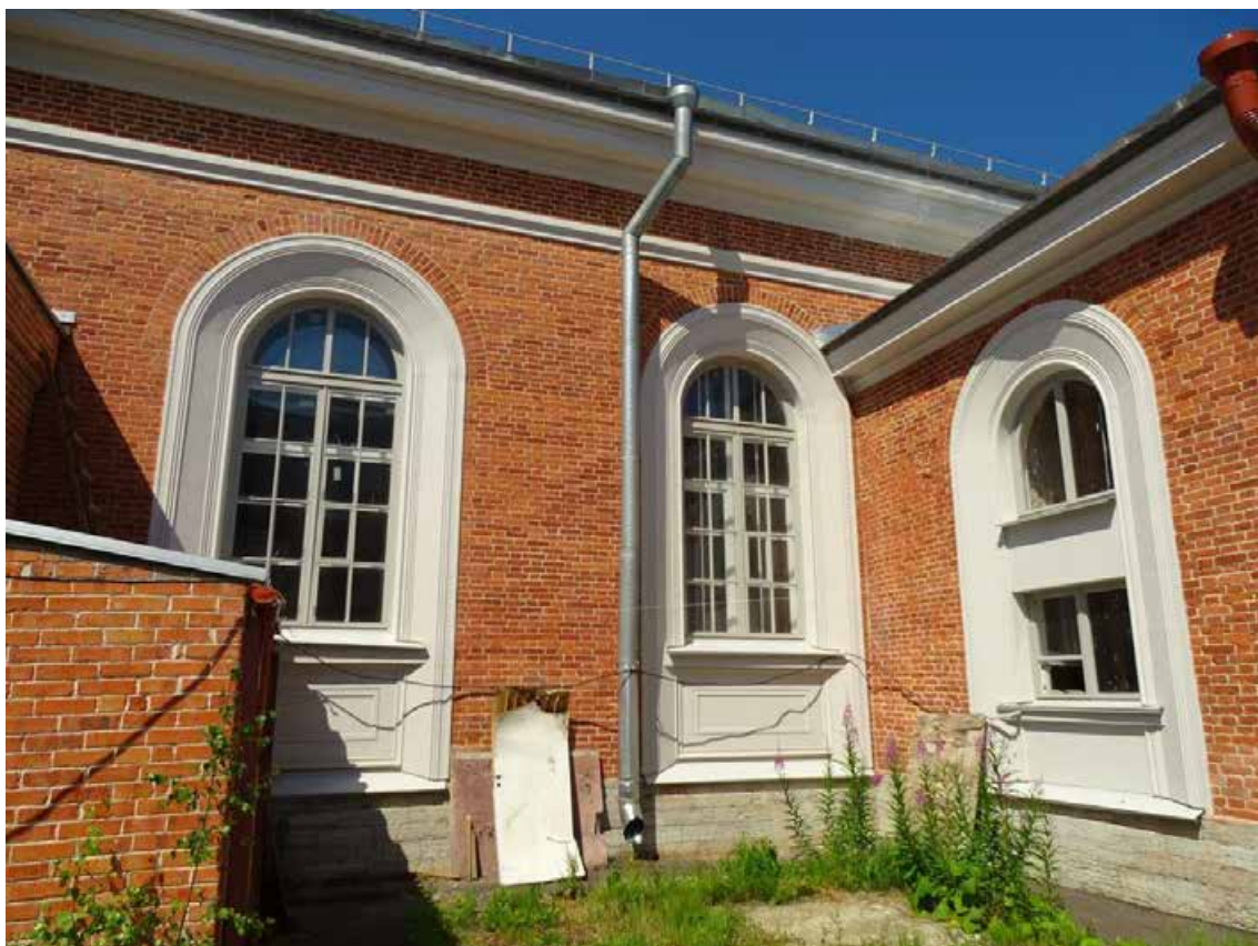
Фото 15. Объект культурного наследия регионального значения «Манеж Уланского полка». Восточный и южный фасады. Фрагмент. Съемка 20.06.2022 г. Трушковский В. Э.
