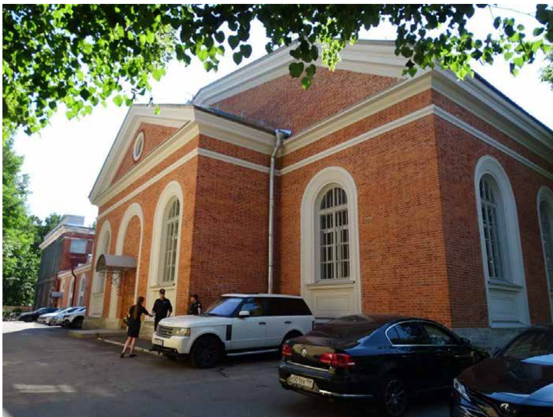
Фото 3. Объект культурного наследия регионального значения «Манеж Уланского полка». Западный и северный фасады. Съемка 20.06.2022 г. Трушковский В. Э.
