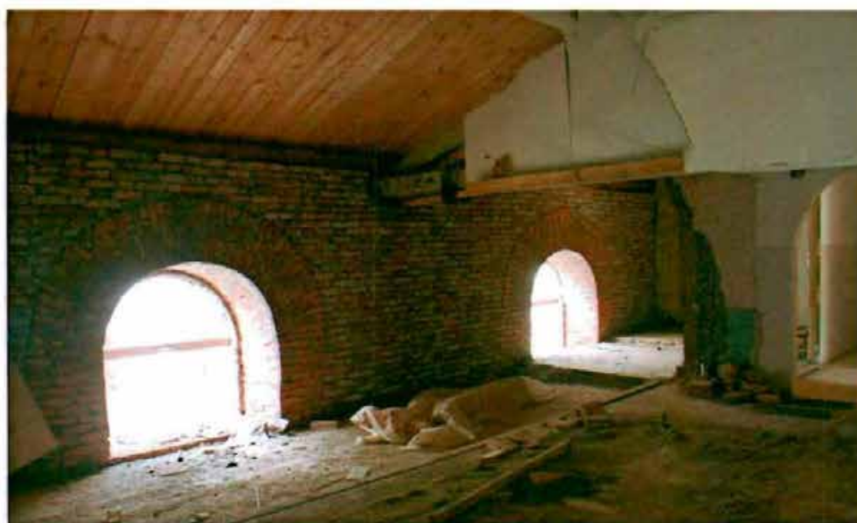
Фото №4. Помещение 2-го этажа.
