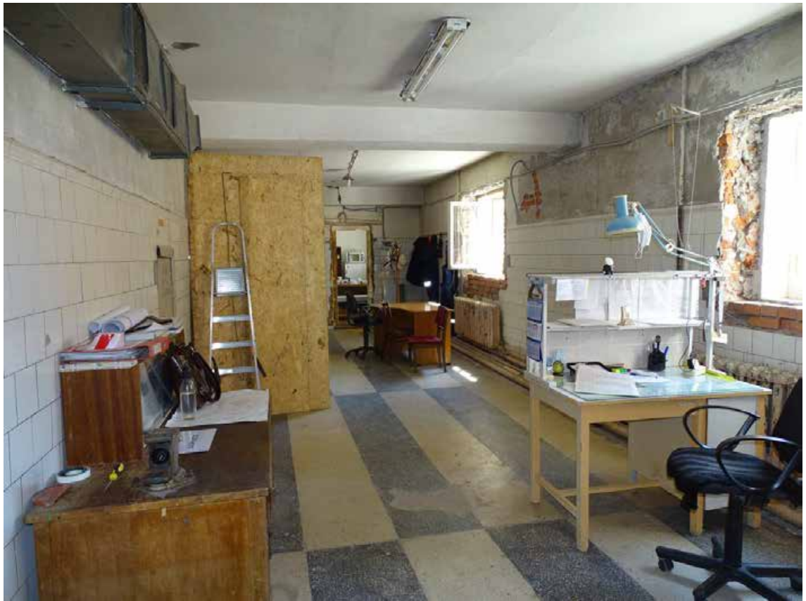
Фото 16. 1-й этаж. Помещение 12/49,7.
