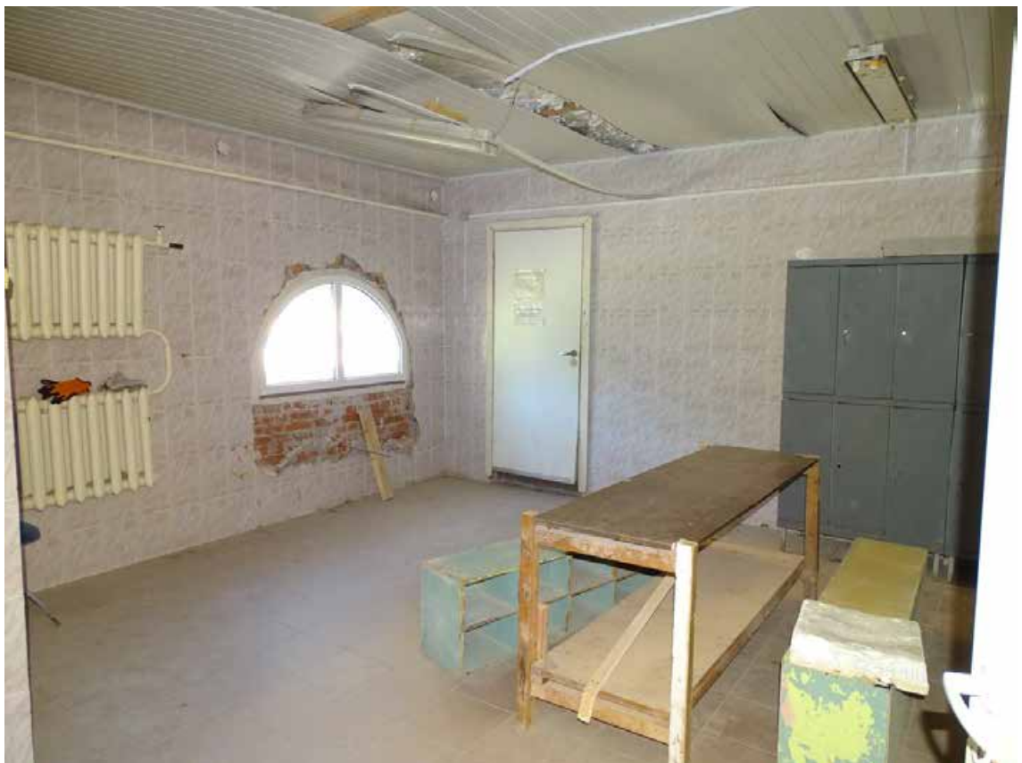
Фото 14. 2-й этаж. Помещение 49/23,2.
