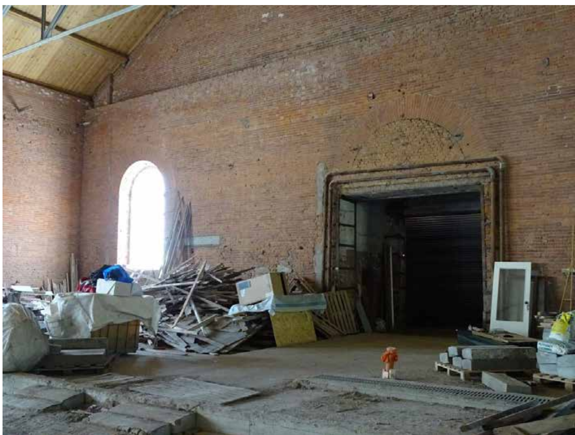
Фото 02. 1-й этаж. Помещение 33/5,9; 34/65,5; 35/2,4; 36/2,5; 37/65,0; 38/2417,8.
