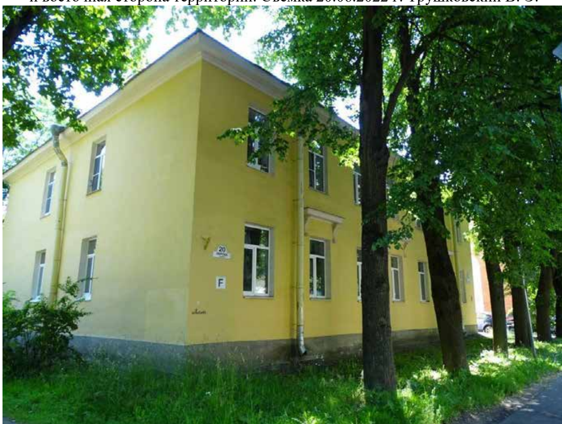
Фото 31. Объект культурного наследия регионального значения «Казарма трубачей» входящий в объект культурного наследия регионального значения «Казармы лейб-гвардии Уланского полка (с воротами, каменной оградой и территорией)». Южный и западный фасады. Съемка 20.06.2022 г. Трушковский В. Э.
