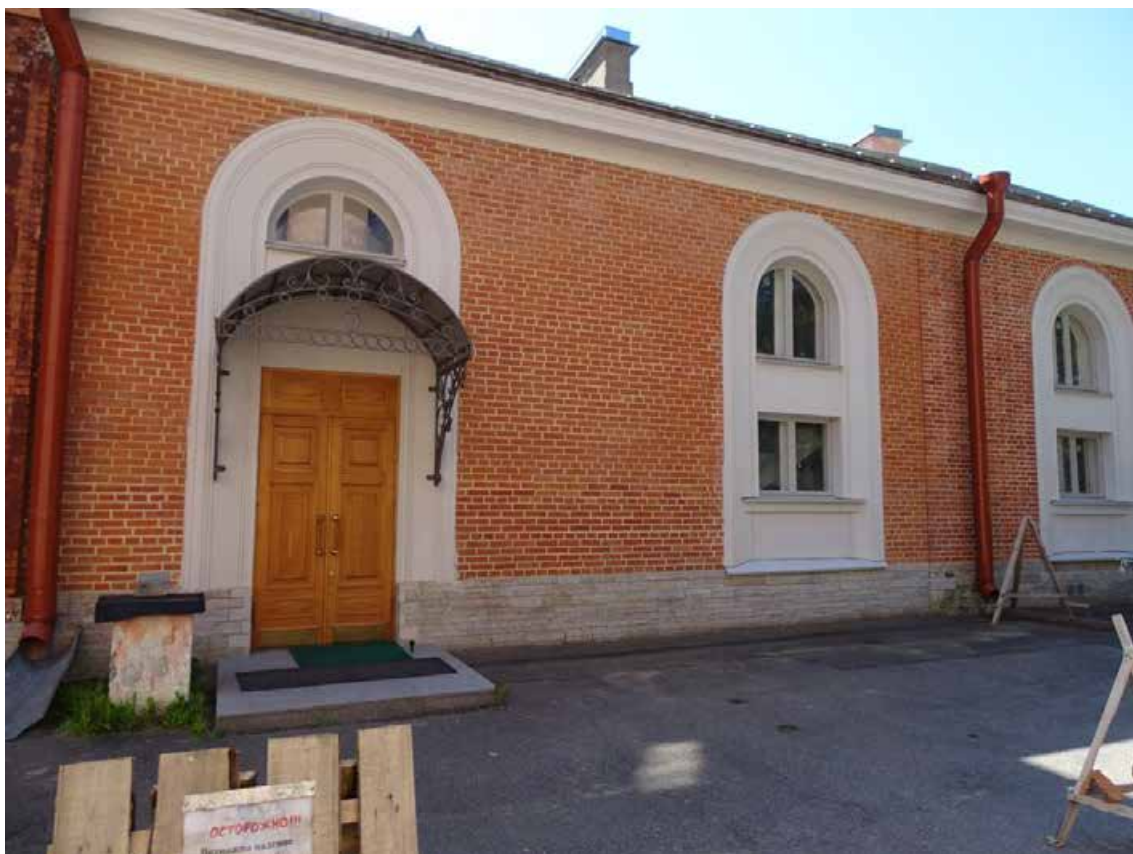
Фото 7. Здание по адресу: СПб, г. Петергоф, ул., Аврова, дом 22, литера А; Объект культурного наследия регионального значения «Манеж Уланского полка» Северный фасад. Фрагмент. Съемка 20.06.2022 г. Трушковский В. Э.
