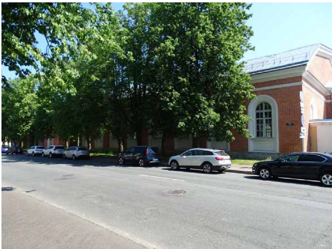
Фото 24. Объект культурного наследия регионального значения «Манеж Уланского полка». Южный и западный фасады. Съемка 20.06.2022 г. Трушковский В. Э.
