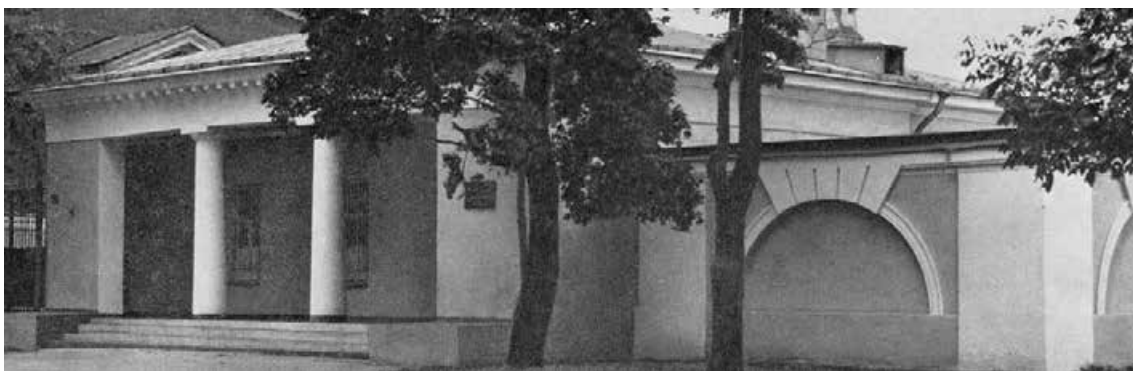
Илл. 30. Гауптвахта Уланского полка на улице Аврова, 22. 1983 - 1984 гг. Памятники архитектуры пригородов Ленинграда. Л., Стройиздат, ЛО, 1985 г.
