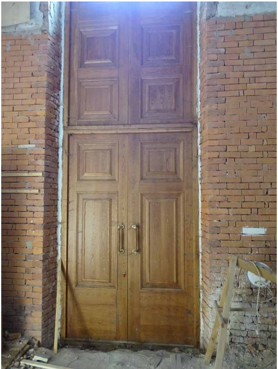
Фото 05. 1-й этаж. Помещение 41/15,3; 42/6,4; 43/6,4.
