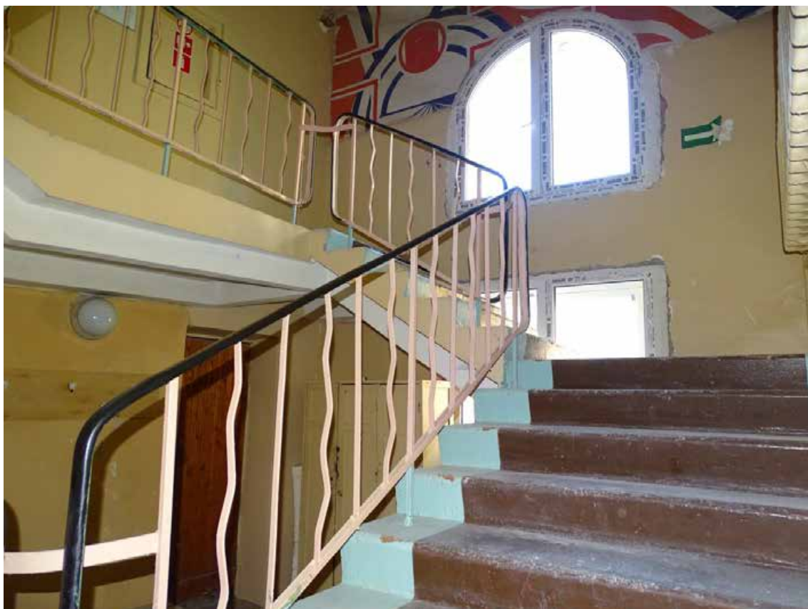
Фото 08. Лестничная площадка между 1-м и 2-м этажом.
