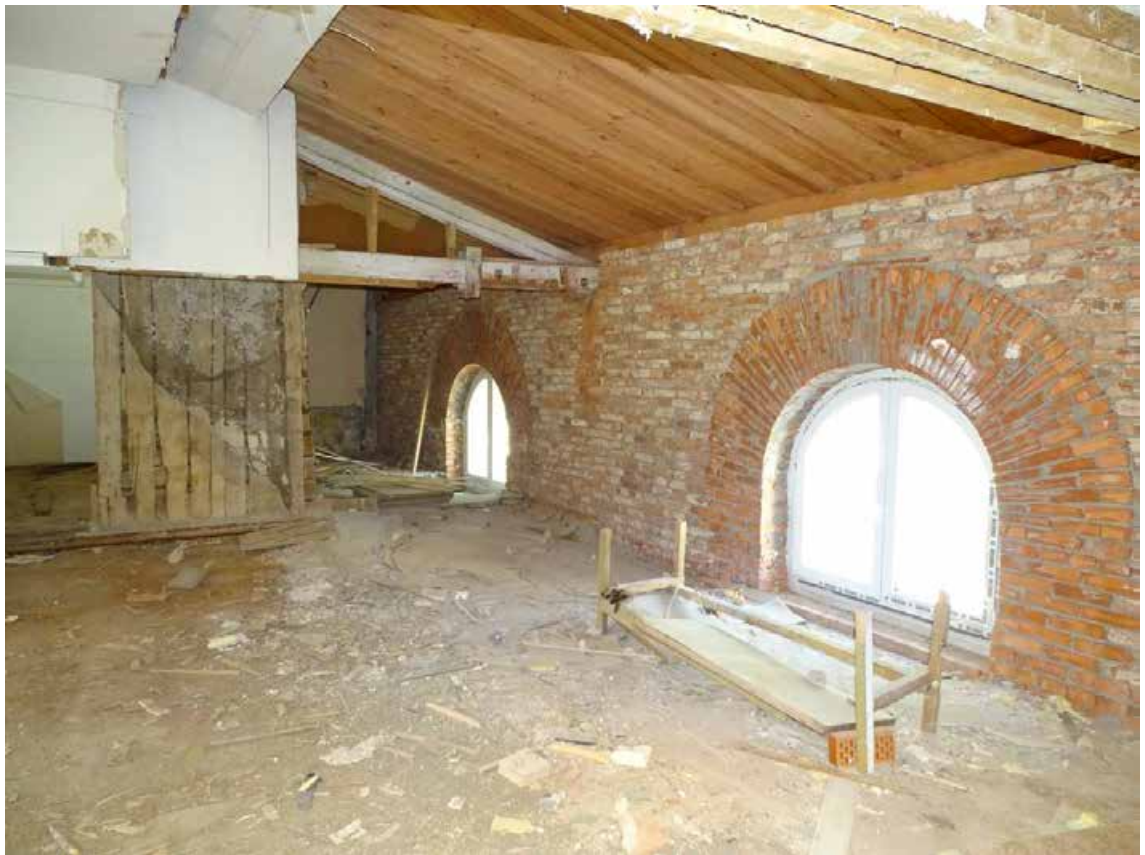
Фото 02. 2-й этаж. Помещение 68/31,0; 73/1,5; 74/21,0; 75/4,6.
