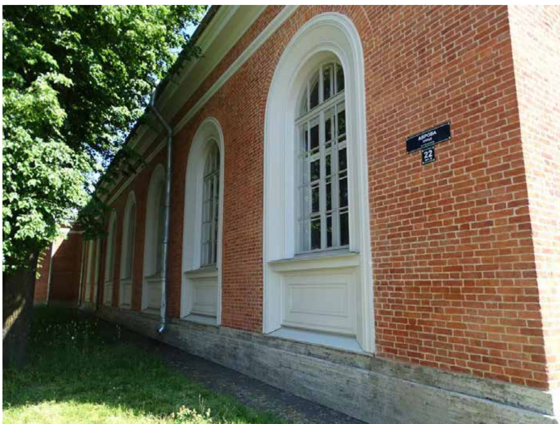
Фото 25. Объект культурного наследия регионального значения «Манеж Уланского полка». Западный фасад. Съемка 20.06.2022 г. Трушковский В. Э.
