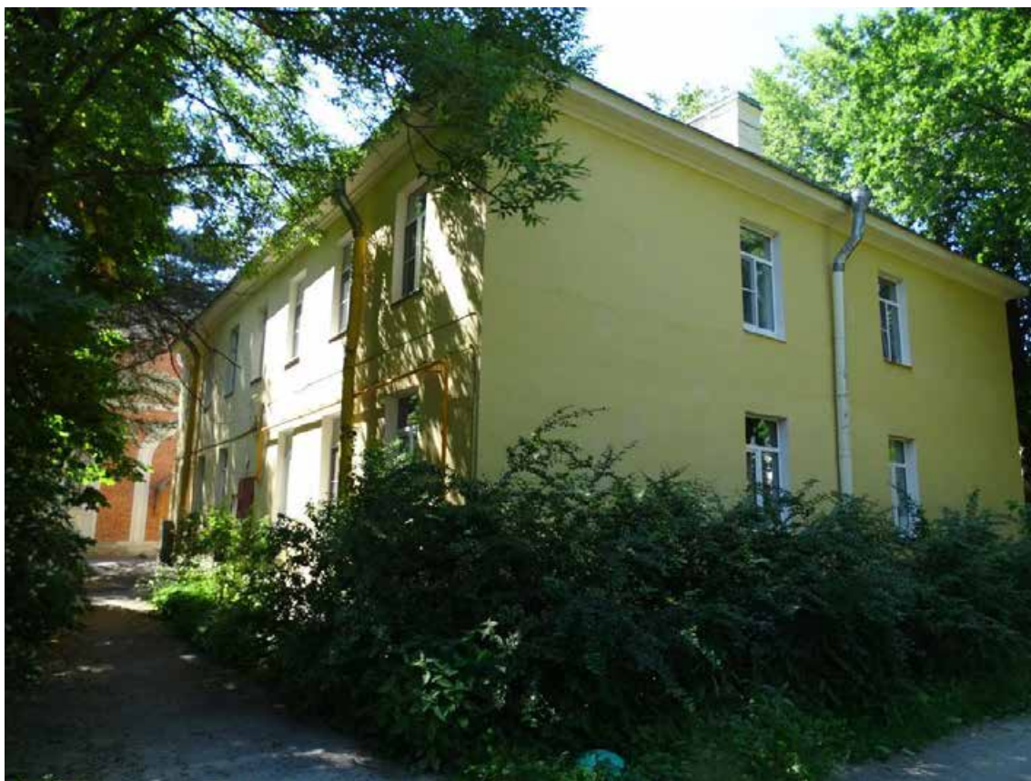
Фото 32. Объект культурного наследия регионального значения «Казарма трубачей». Северный и восточный фасады. Съемка 20.06.2022 г. Трушковский В. Э.
