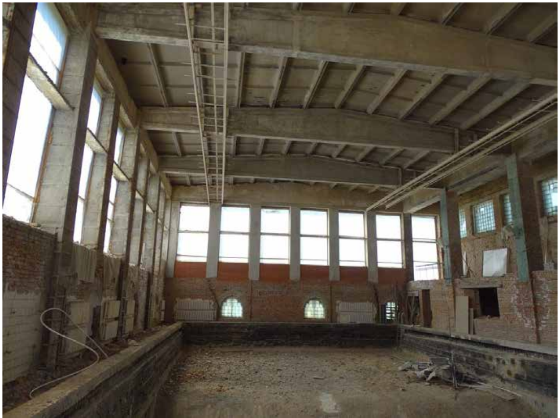
Фото 18. 2-й этаж. Помещение 53/508,4.
