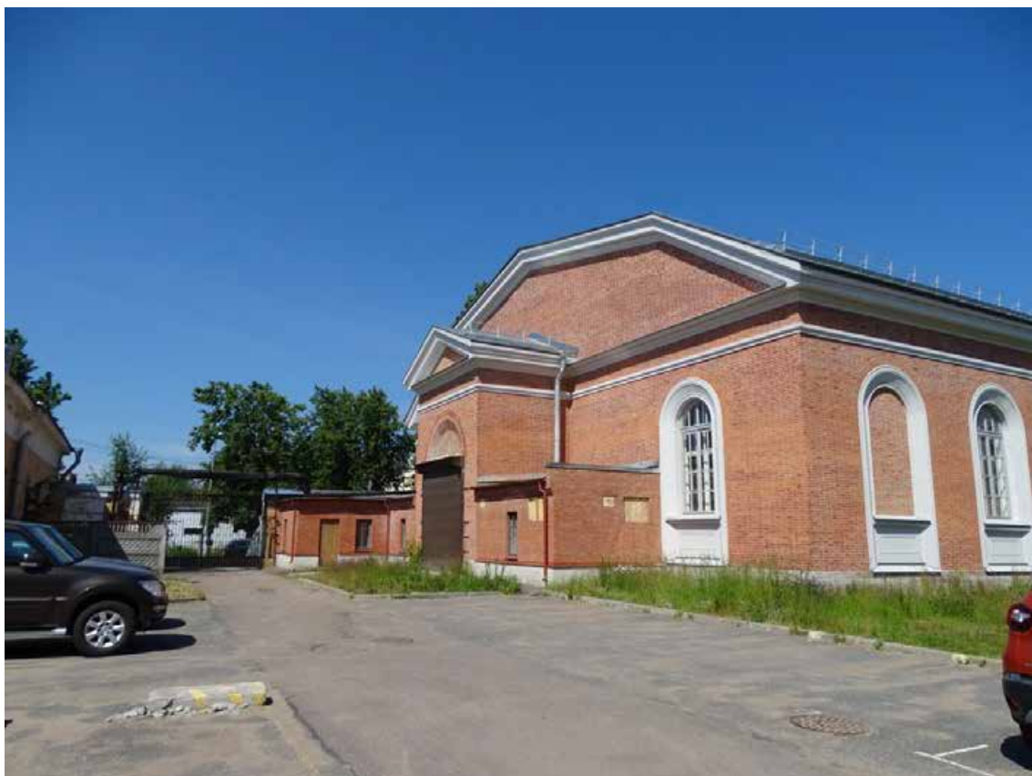
Фото 21. Объект культурного наследия регионального значения «Манеж Уланского полка». Южный и Восточный фасады. Съемка 20.06.2022 г. Трушковский В. Э.
