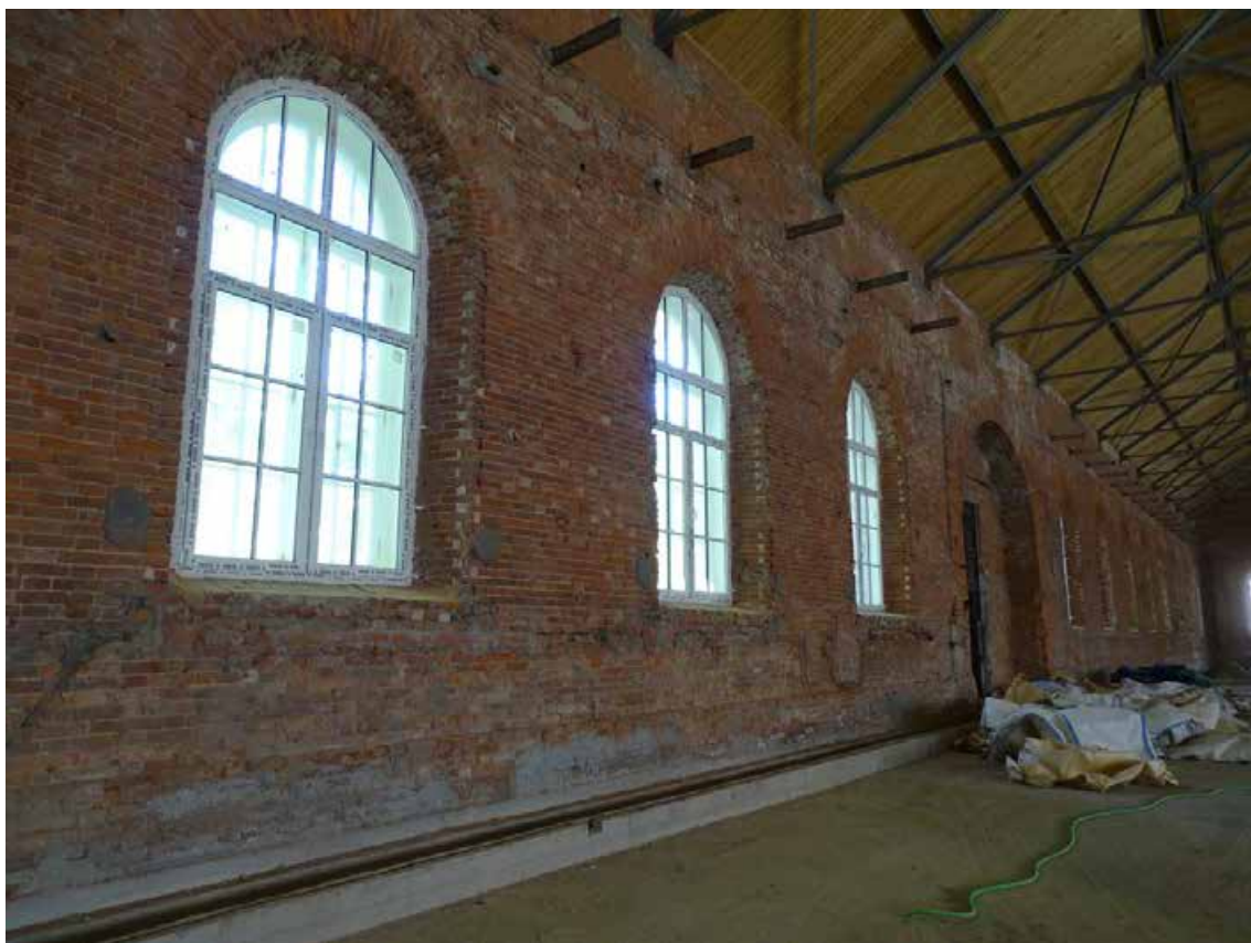
Фото 10. 1-й этаж. Помещение 33/5,9; 34/65,5; 35/2,4; 36/2,5; 37/65,0; 38/2417,8.
