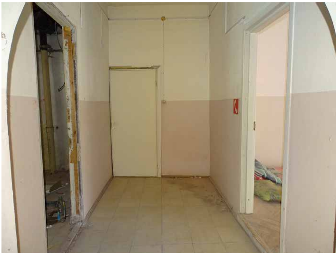
Фото 04. 2-й этаж. Помещение 64/6,6; 66/3,0.
