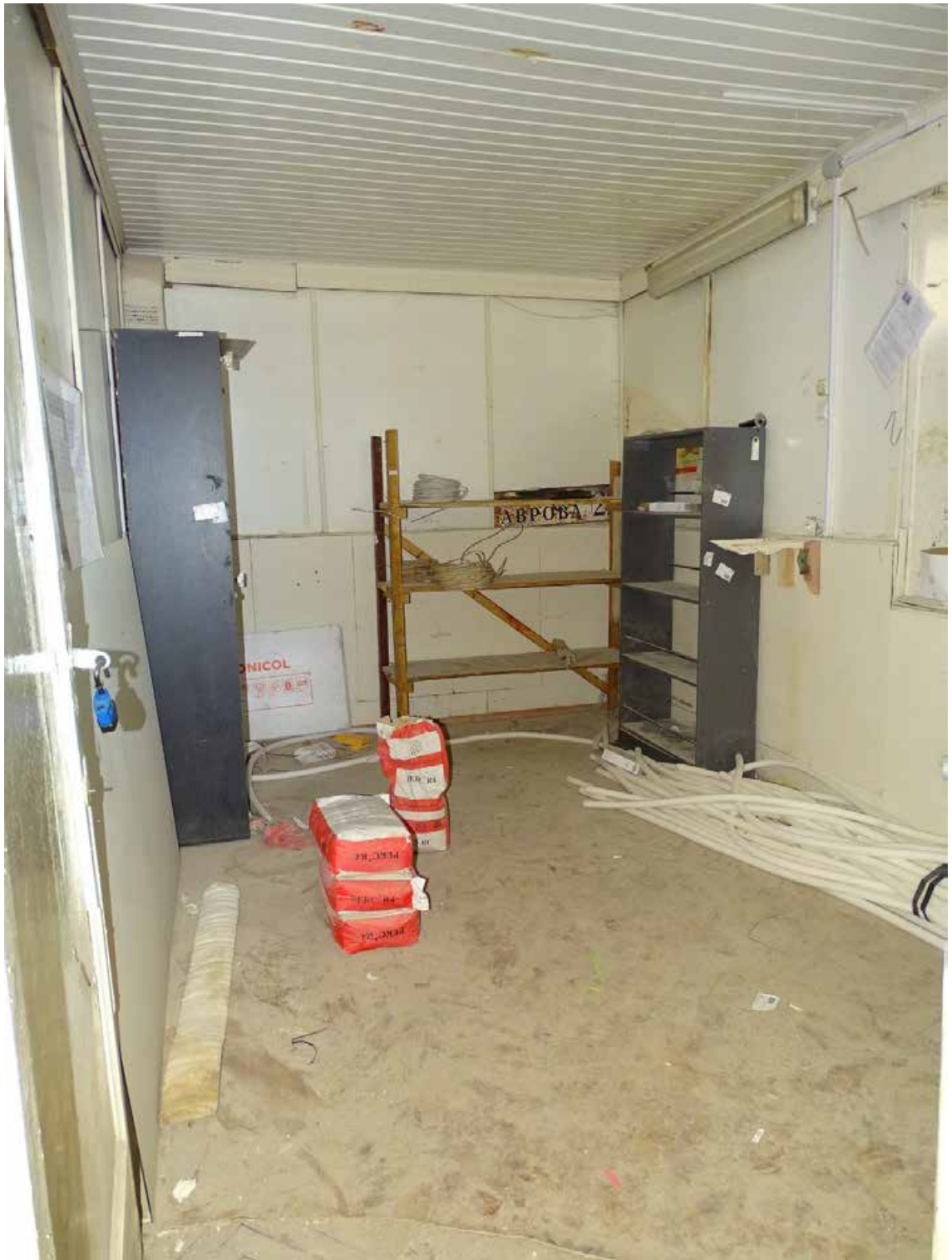
Фото 21. 2-й этаж. Помещение 54/12,2.
