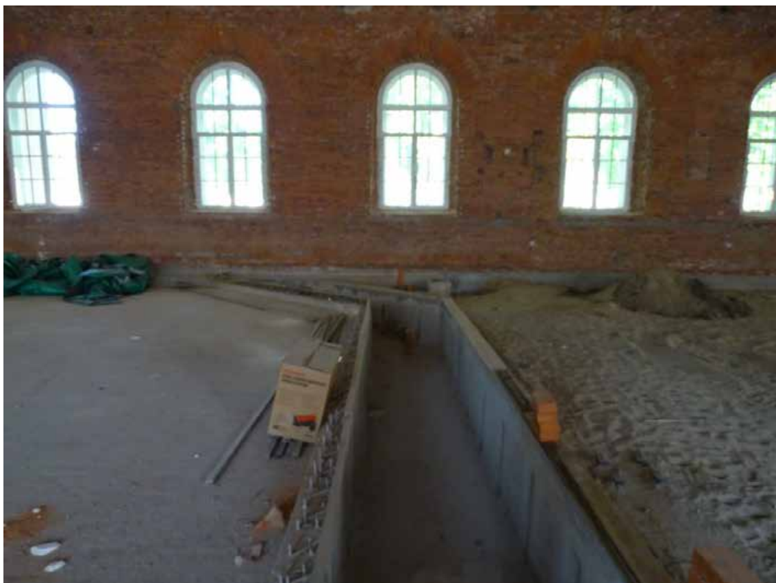
Фото 12. 1-й этаж. Помещение 33/5,9; 34/65,5; 35/2,4; 36/2,5; 37/65,0; 38/2417,8.
