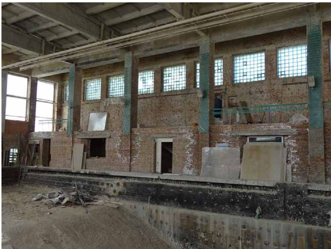
Фото 19. 2-й этаж. Помещение 53/508,4.
