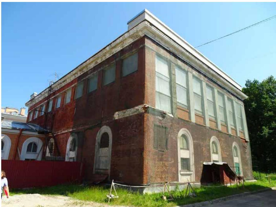
Фото 11. Здание по адресу: СПб, г. Петергоф, ул., Аврова, дом 22, литера А. Южный и западный фасады. Съемка 20.06.2022 г. Трушковский В. Э.
