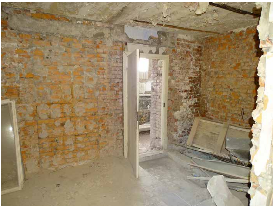
Фото 15. 2-й этаж. Помещение 51/10,7;52/9,7.
