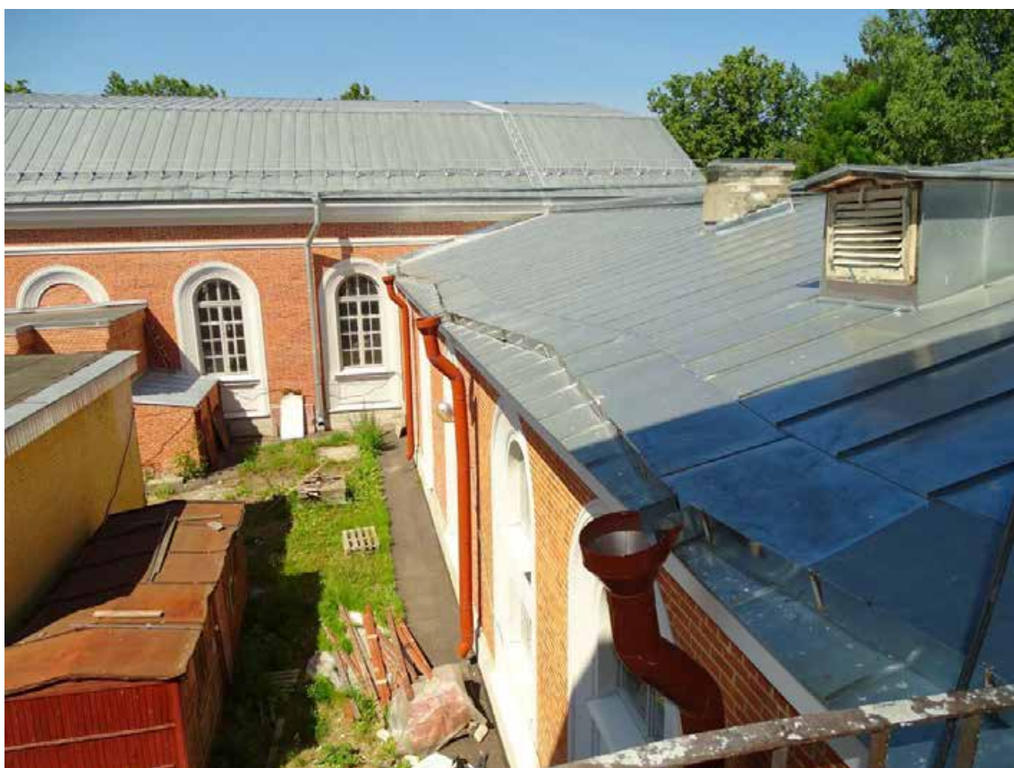
Фото 12. Здание по адресу: СПб, г. Петергоф, ул., Аврова, дом 22, литера А; Объект культурного наследия регионального значения «Манеж Уланского полка». Дворовые фасады. Фрагмент кровли. Съемка 20.06.2022 г. Трушковский В. Э.
