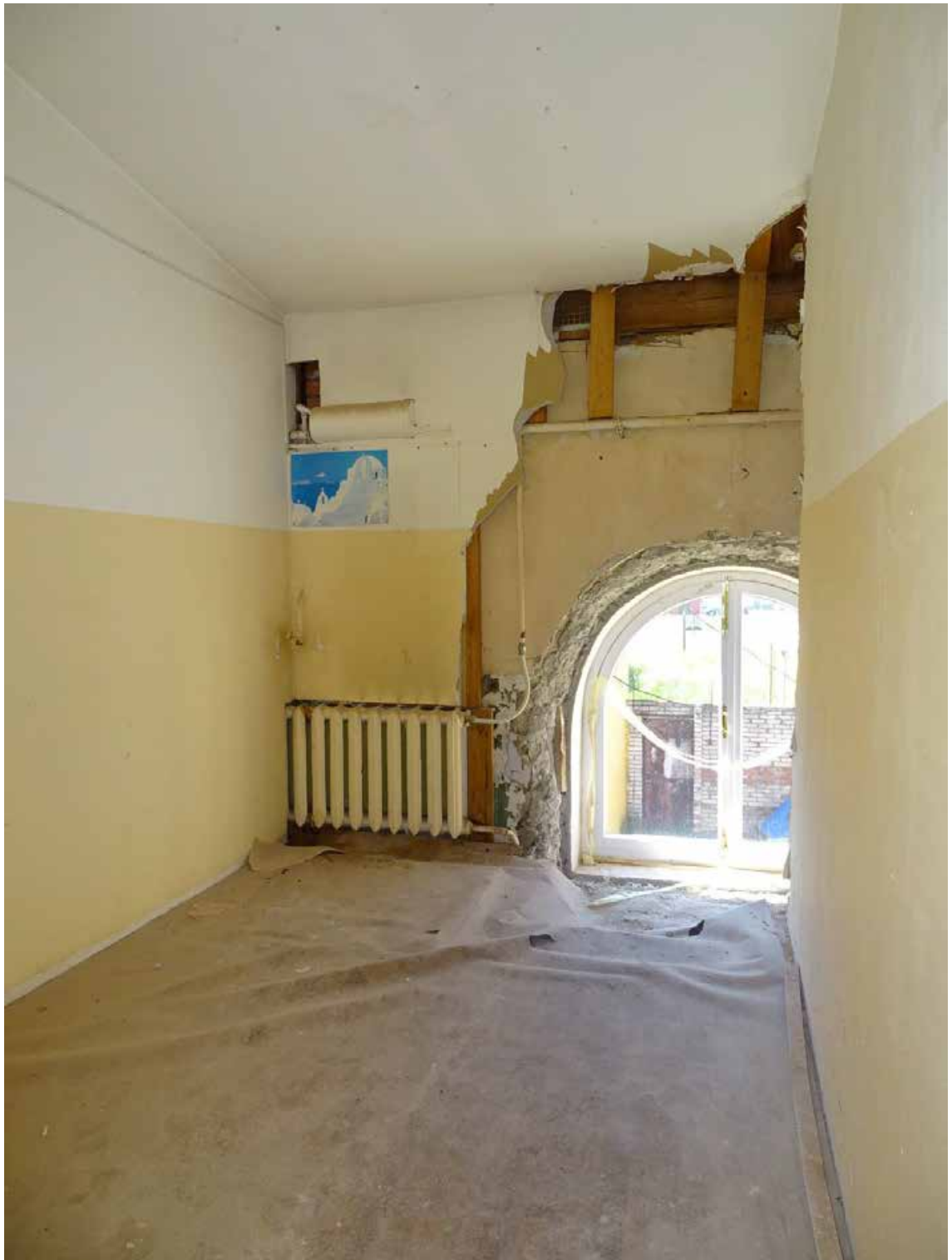
Фото 06. 2-й этаж. Помещение 67/10,8.
