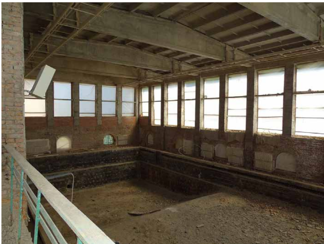
Фото 01. 3-й этаж. Помещение 85/83,9. Вид на Бассейн 2-го этажа.
