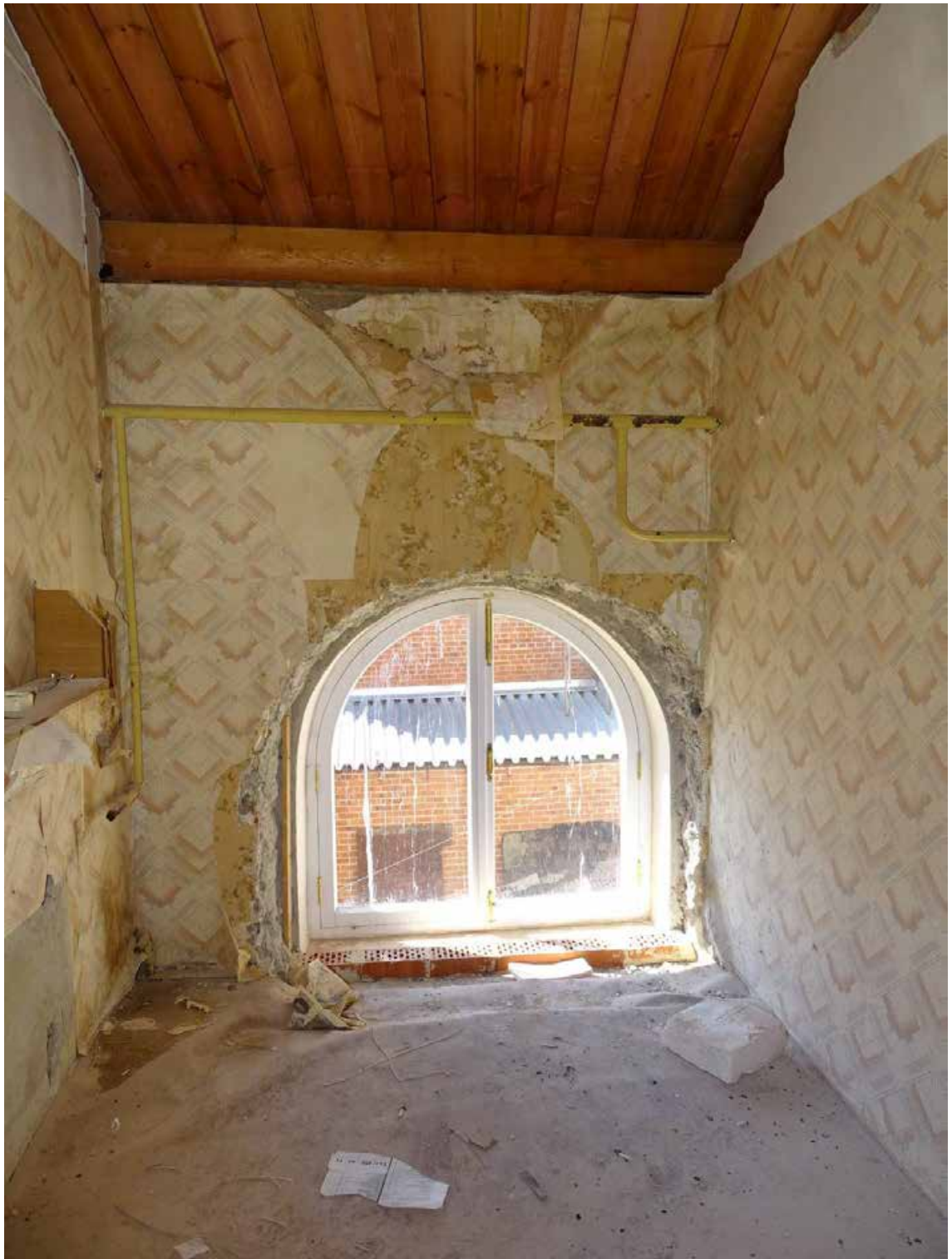
Фото 07. 2-й этаж. Помещение 72/7,7.
