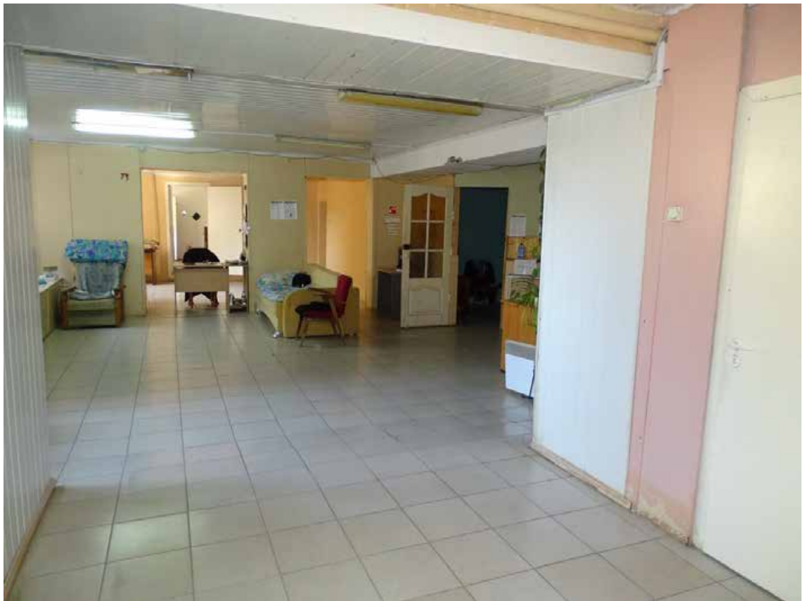
Фото 21. 1-й этаж. Помещение 1/67,6.
