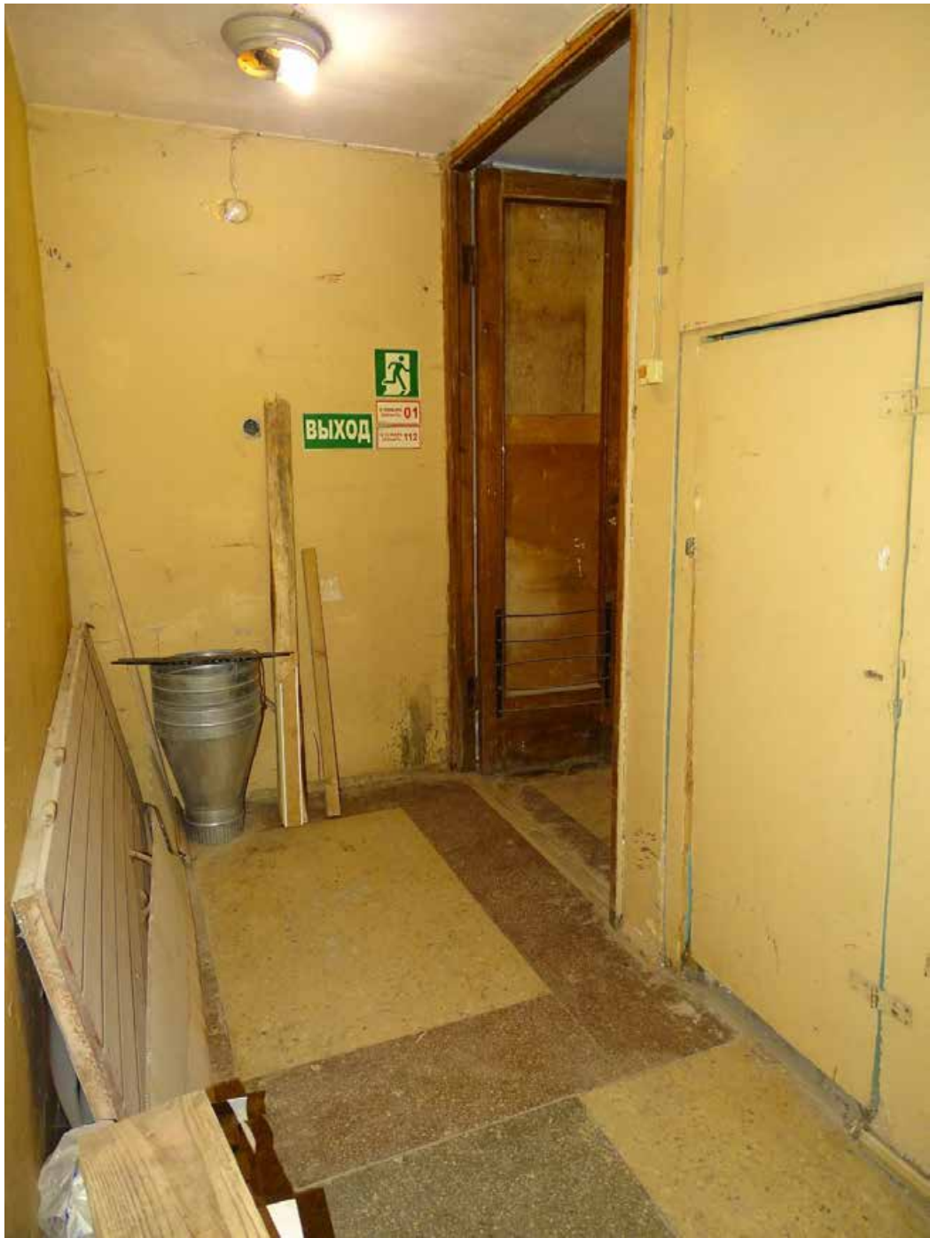
Фото 24. 1-й этаж. Помещение 7/40,2.
