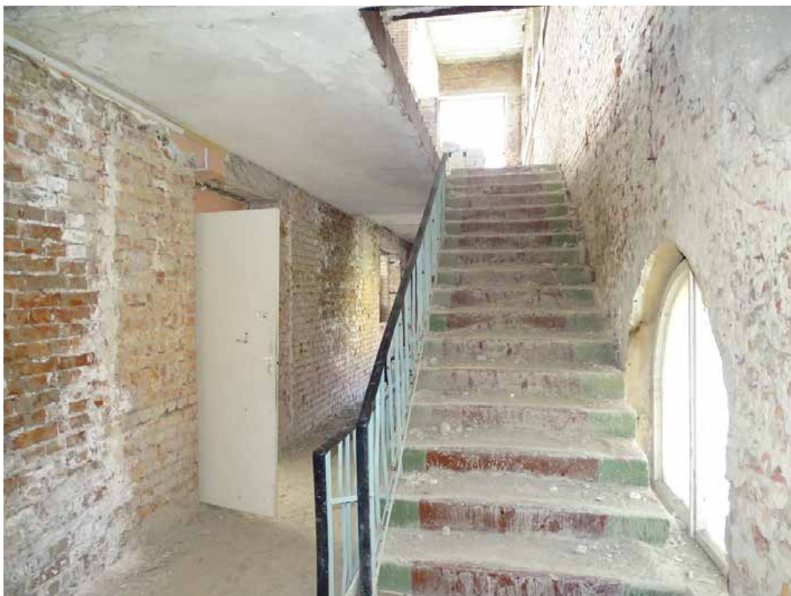
Фото 23. 2-й этаж. Помещение 55/29,7.
