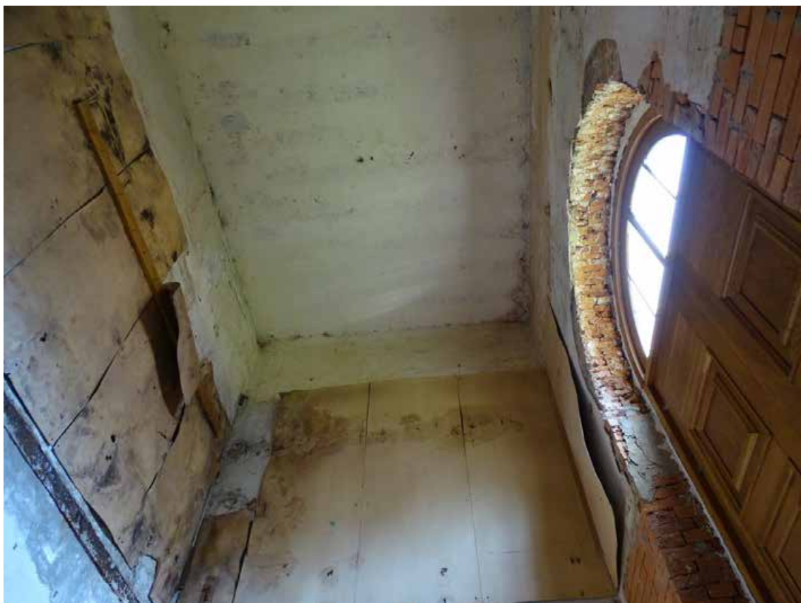
Фото 06. 1-й этаж. Помещение 41/15,3; 42/6,4; 43/6,4.
