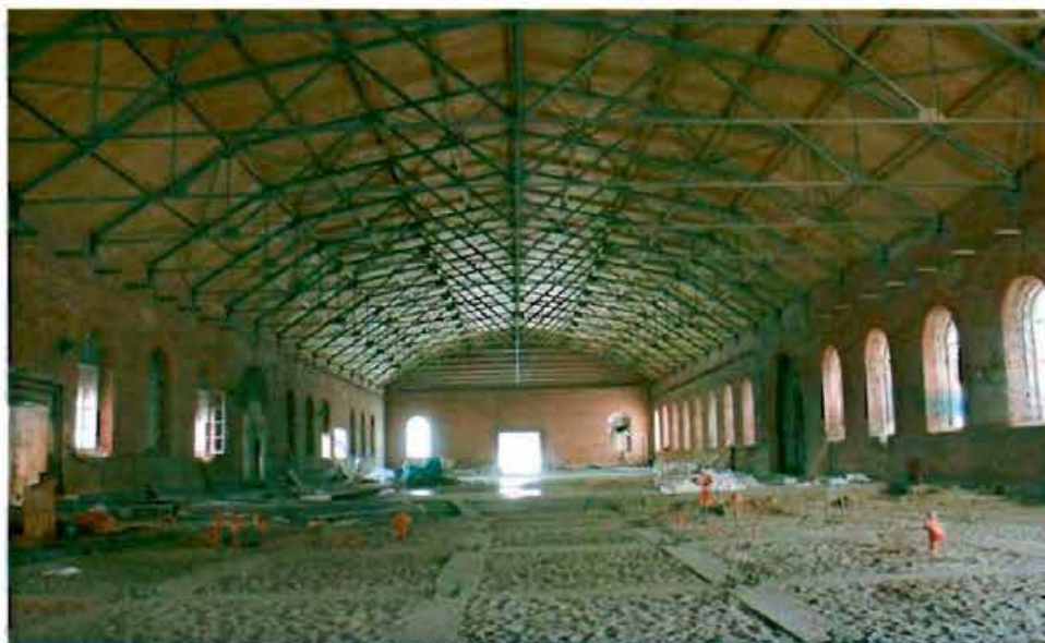
Фото №3. Помещение 1-го этажа.
