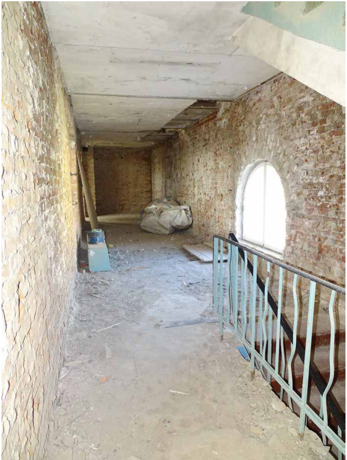
Фото 22. 2-й этаж. Помещение 55/29,7.
