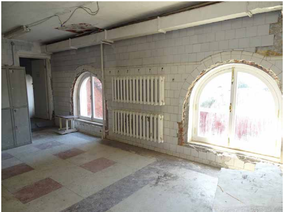
Фото 12. 2-й этаж. Помещение 61/39,1.
