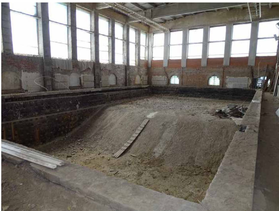
Фото 16. 2-й этаж. Помещение 53/508,4.
