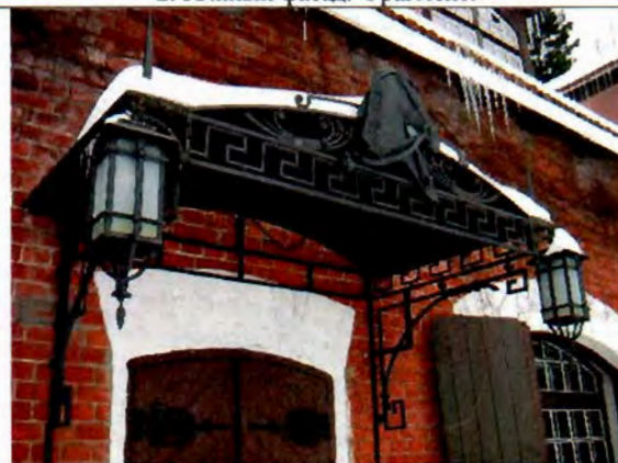
4. Козырек дверного проема южного фасада. Общий вид.
