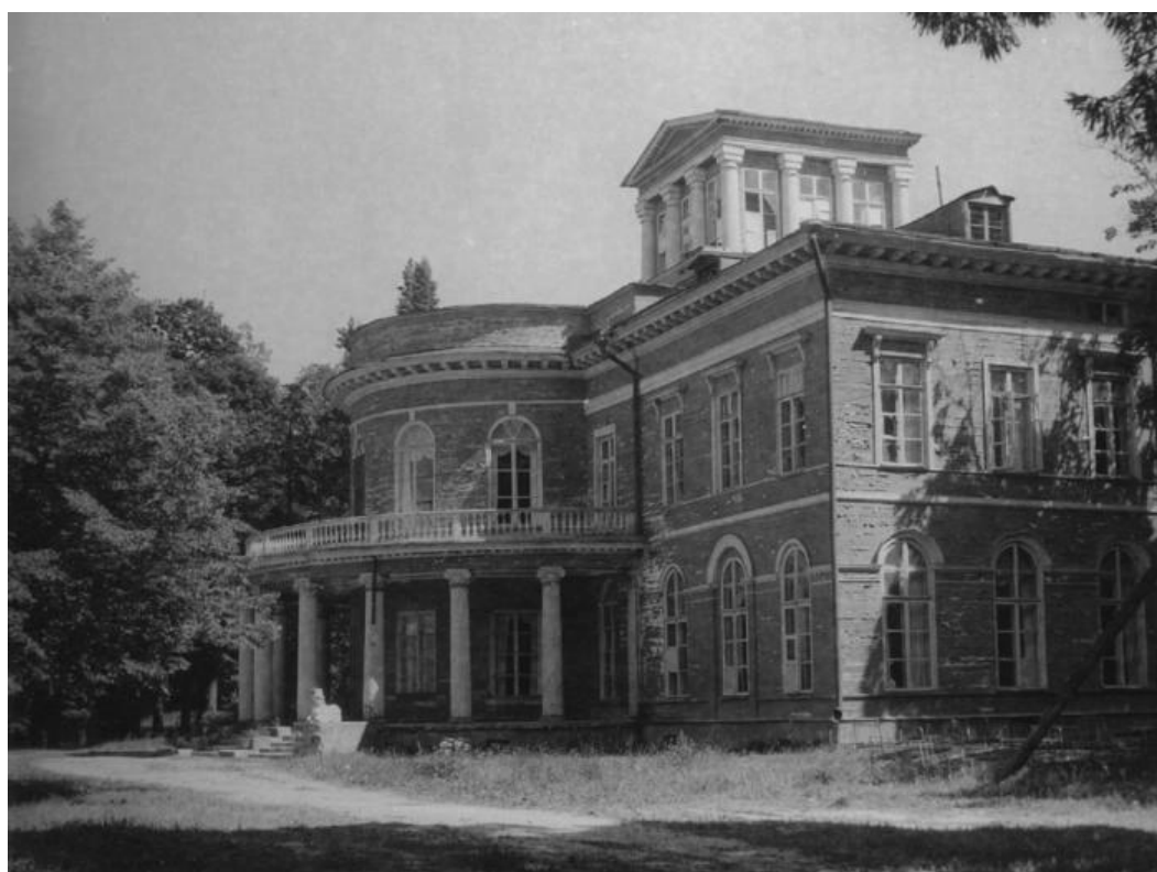
33. Осиновая роща. Северный садовый фасад. Фото 1946 г. (Мурашова Н.В. Осиновая роща. Дача Вяземских. Историческая справка. НИИ «Спецпроектреставрация», 1978 г.)
