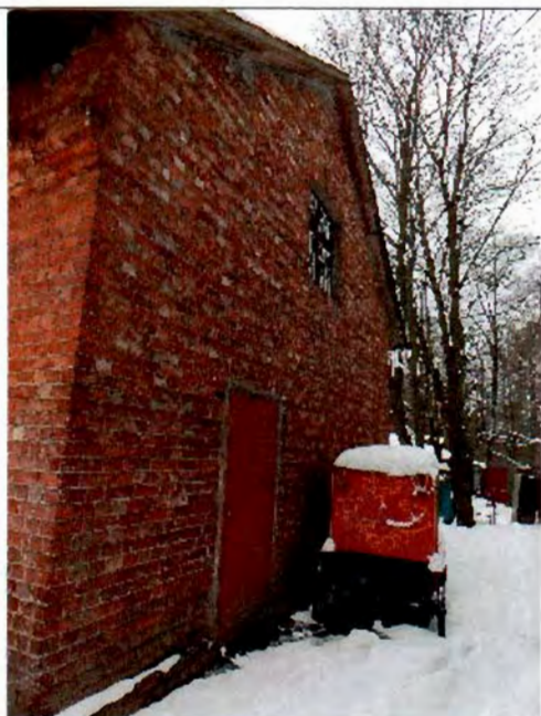
7. Восточный фасад. Общий вид.
