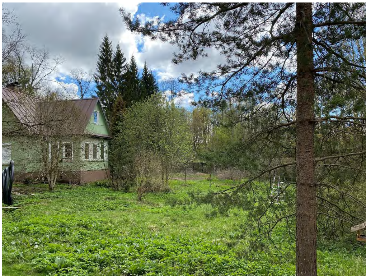
13. Санкт-Петербург, поселок Парголово, Осиновая Роща, Лесной переулок, дом 2, литера А. Дата фотофиксации: 15.04.2020 г.
