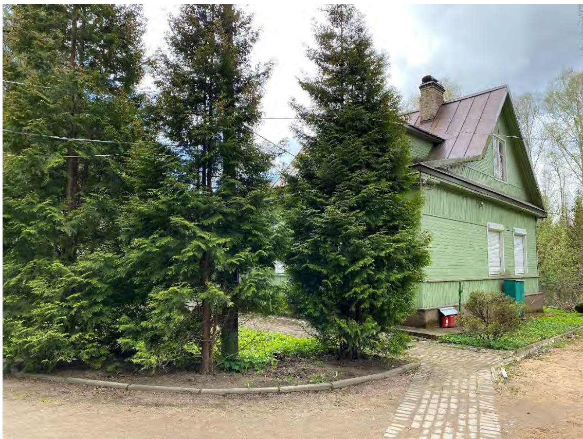
21. Санкт-Петербург, поселок Парголово, Осиновая Роща, Лесной переулок, дом 2, литера А. Дата фотофиксации: 15.04.2020 г.
