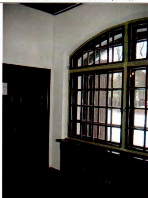
10. Помещение 1-го этажа.
