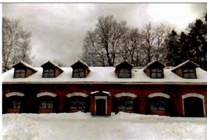
1. Южный фасад. Общий вид.
