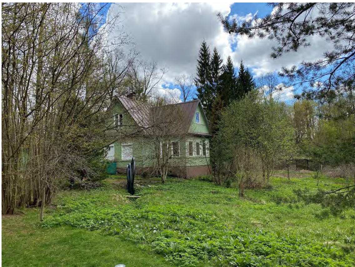
17. Санкт-Петербург, поселок Парголово, Осиновая Роща, Лесной переулок, дом 2, литера А. Дата фотофиксации: 15.04.2020 г.
