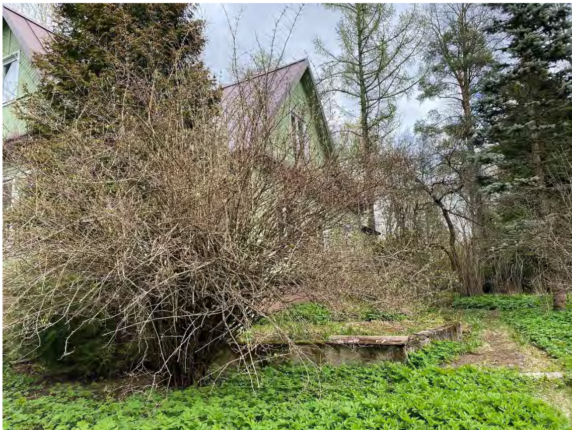
29. Санкт-Петербург, поселок Парголово, Осиновая Роща, Лесной переулок, дом 2, литера А. Дата фотофиксации: 15.04.2020 г.
