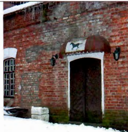
6. Дверное заполнение северного фасада. Общий вид.
