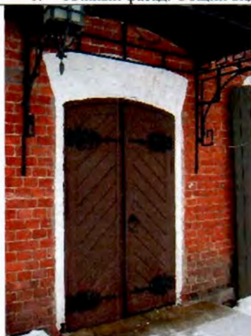
3. Дверной проем южного фасада. Общий вид.
