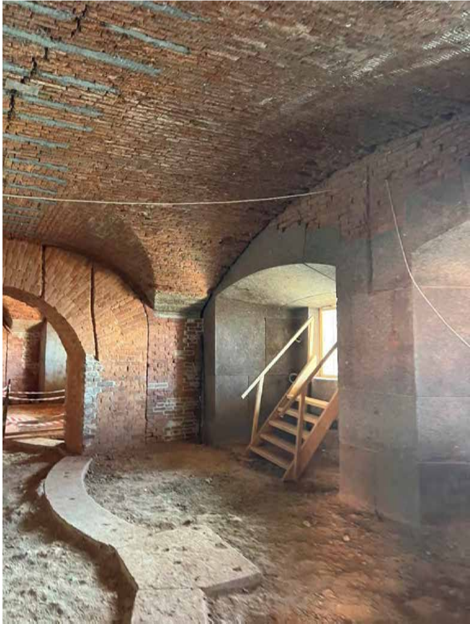
Фото 17. Первый этаж. Помещения казематов.
