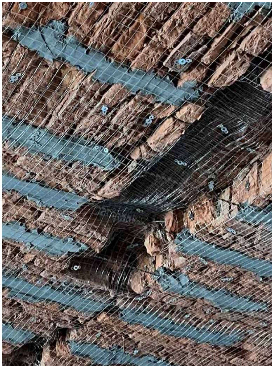
Фото 15. Первый этаж. Помещения казематов. Работы по усилению конструкций, находящихся в неудовлетворительном состоянии.
