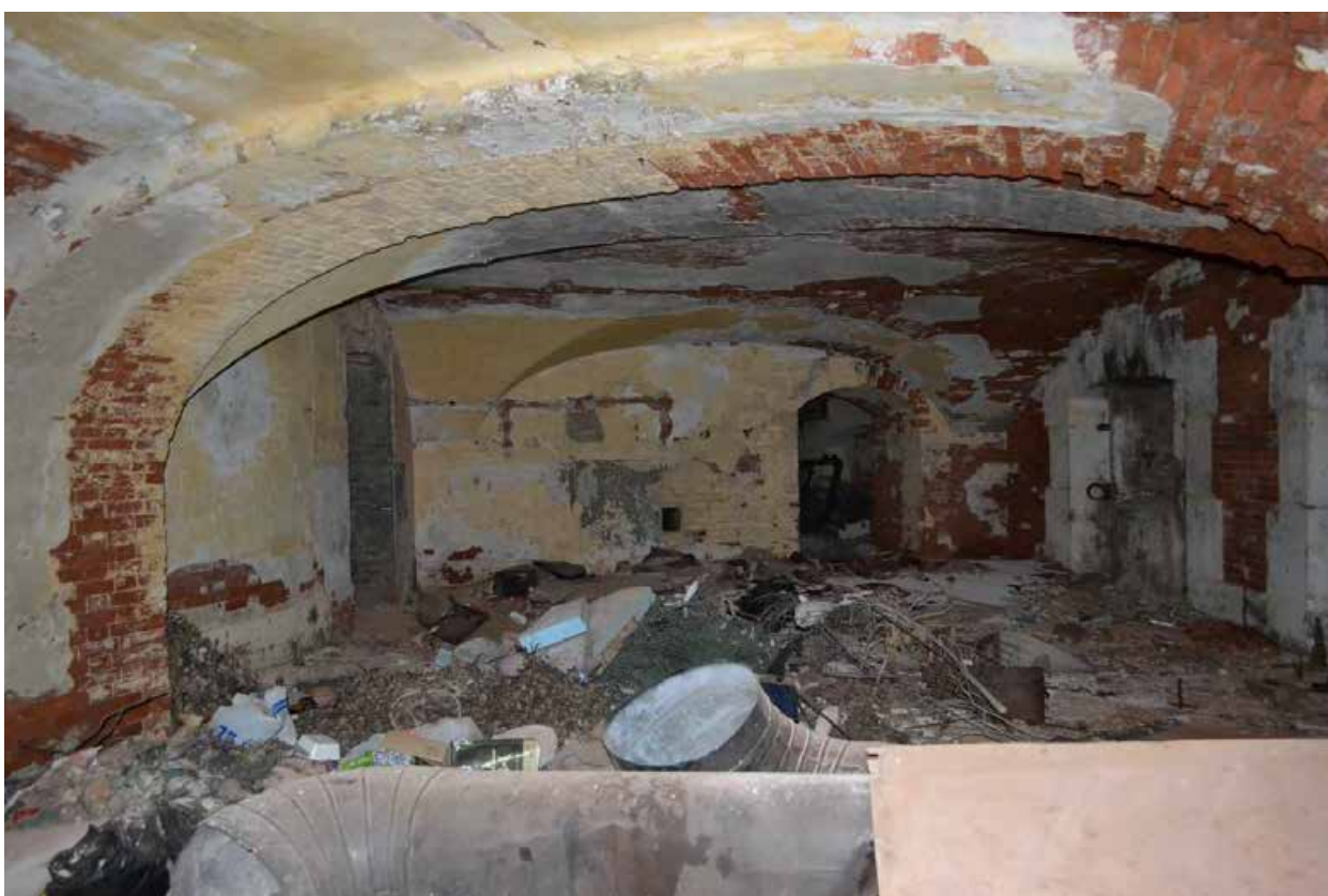
Фото 10. Первый этаж. Помещение казематов.
