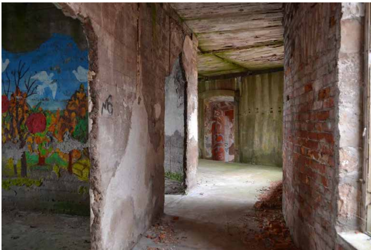
Фото 4. Казематы. Помещения третьего этажа.
