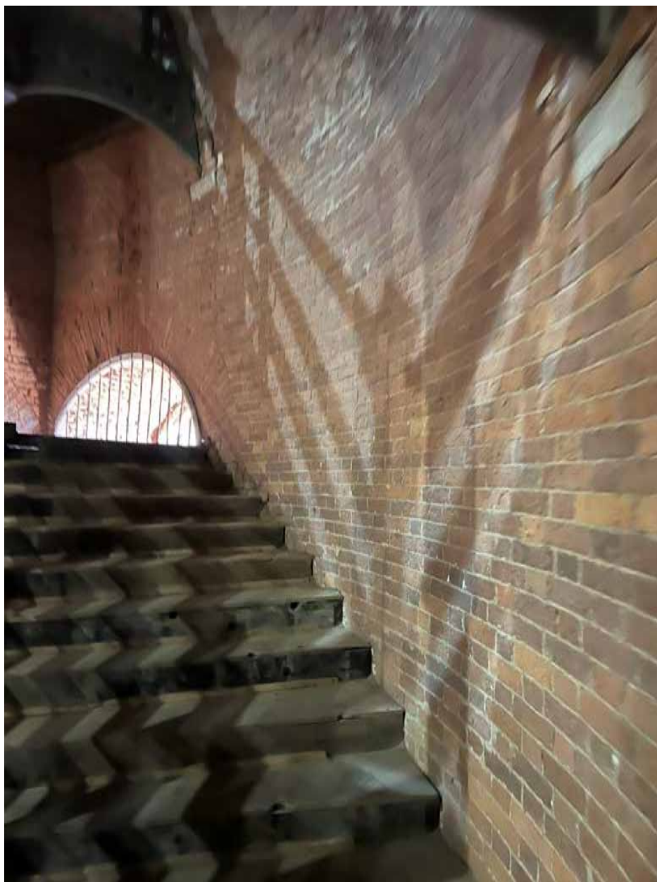
Фото 31. Третий этаж. Лестница западной полубашни.
