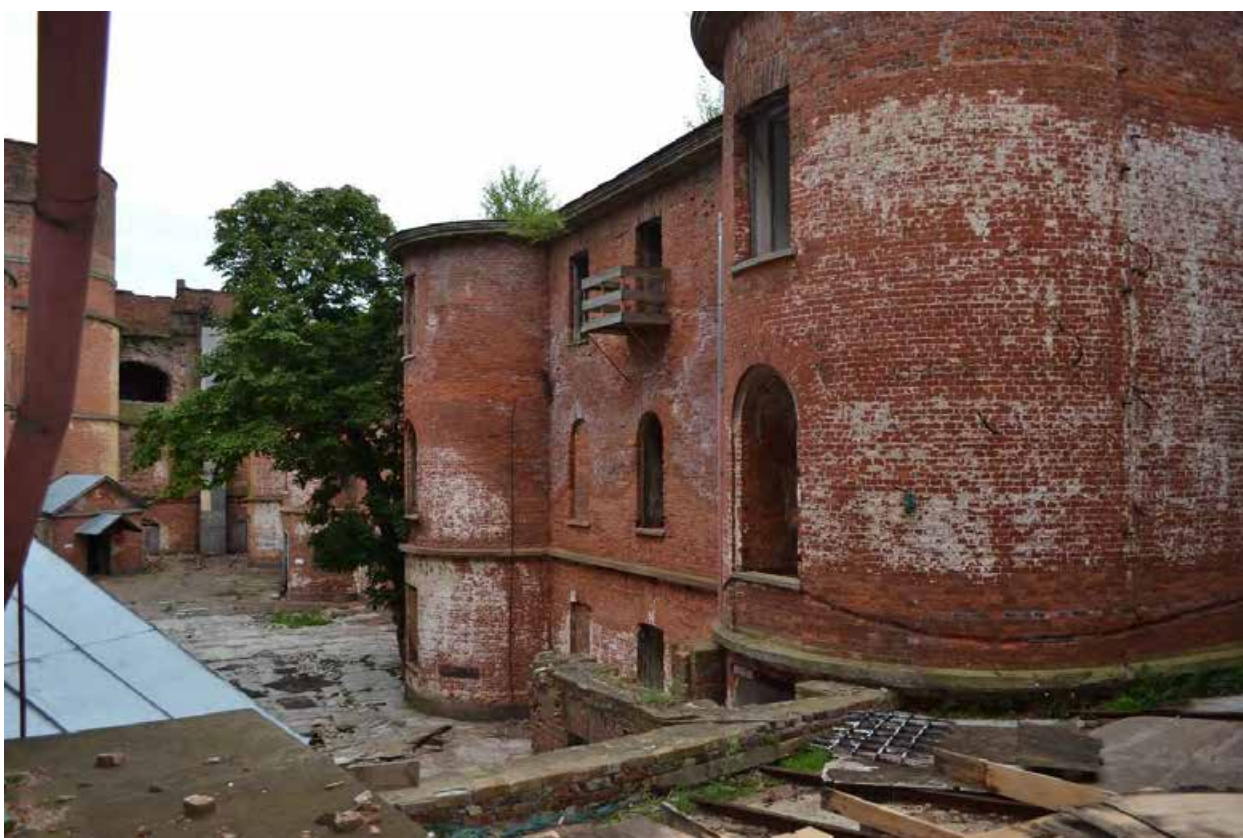
Фото 11. Форт Александр I. Пространство внутреннего двора. Вид со второго этажа, с запада.
