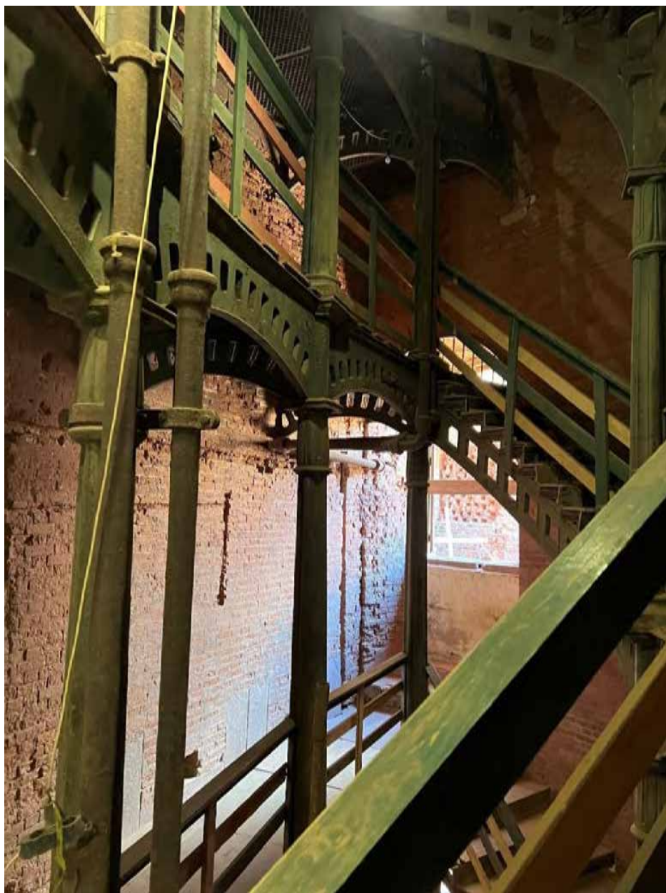
Фото 30. Третий этаж. Лестница западной полубашни.
