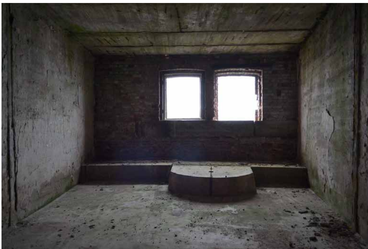
Фото 5. Казематы. Помещения третьего этажа.
