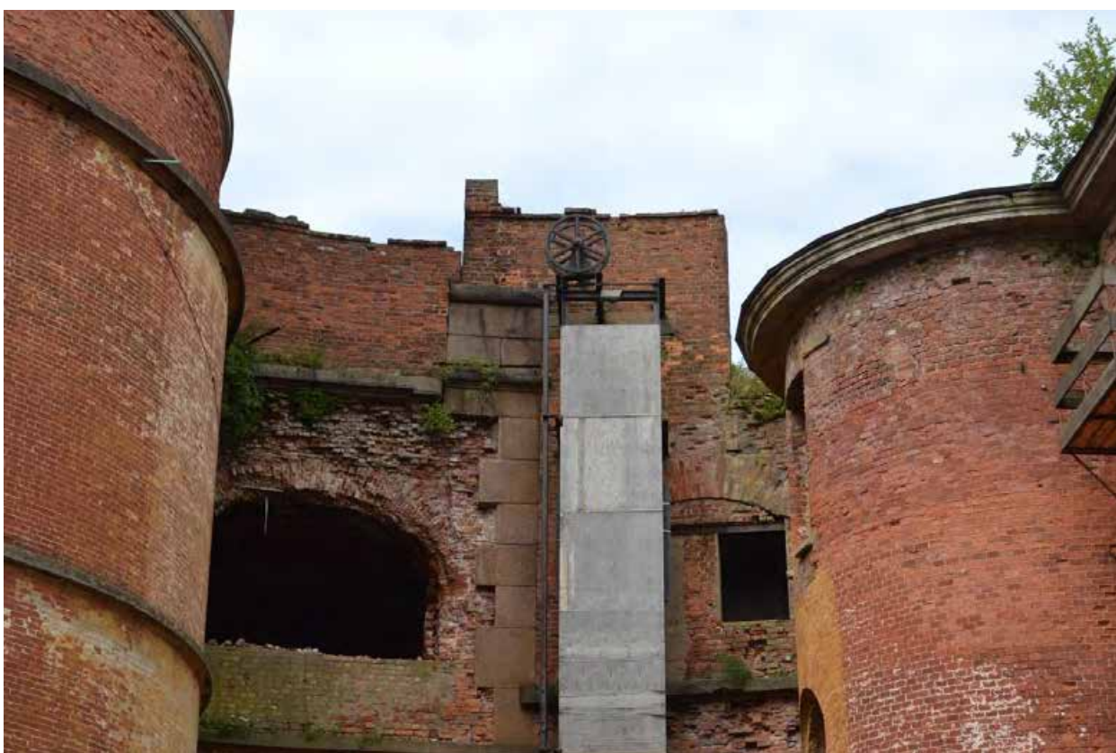
Фото 13. Форт Александр I. Сохранившиеся металлические конструкции исторического лифта. Вид с запада.
