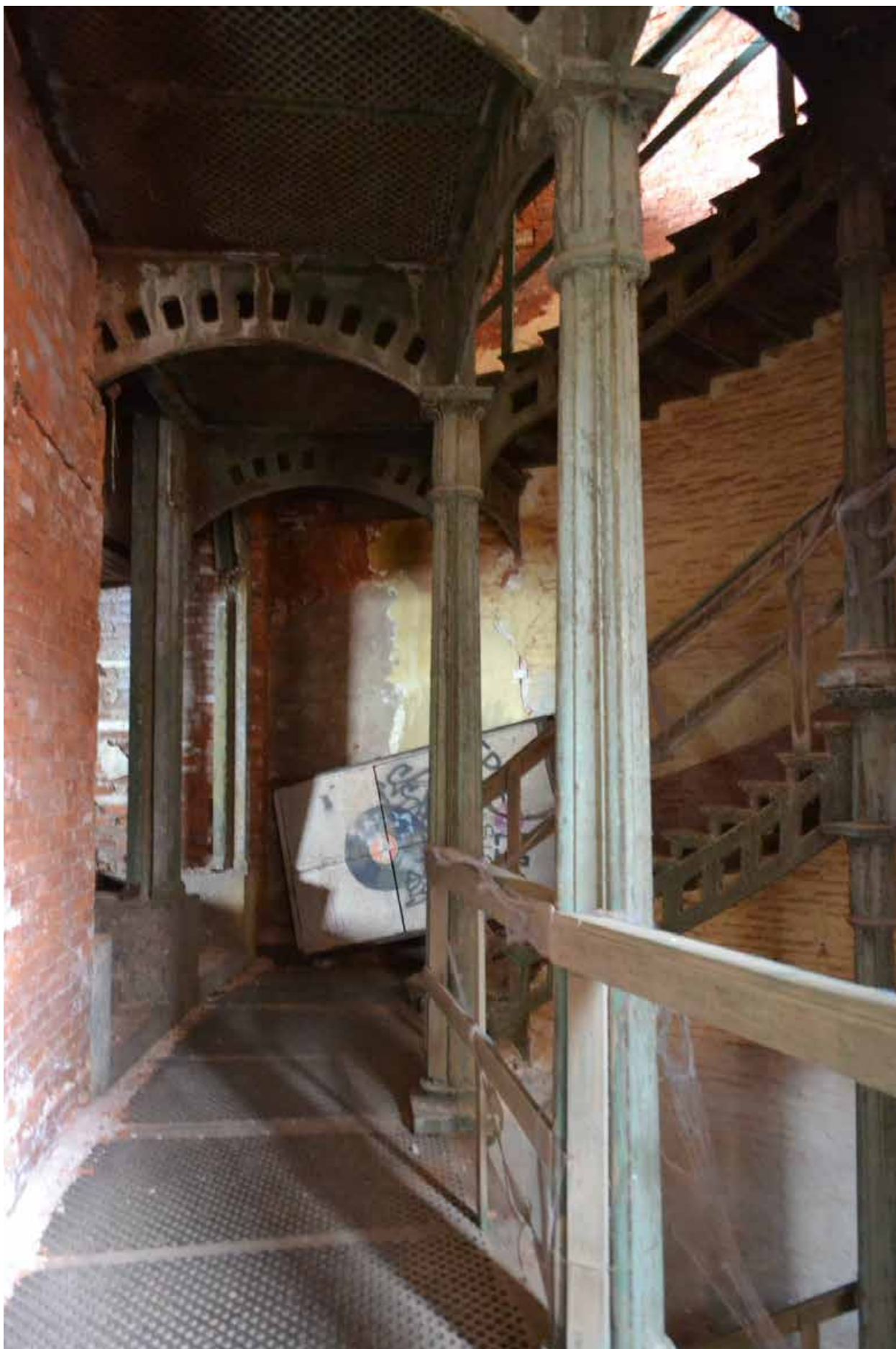
Фото 5. Лестничная площадка в уровне третьего этажа. Общий вид.
