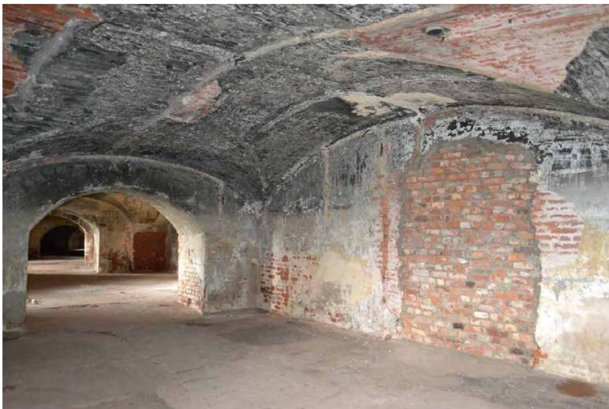
Фото 3. Первый этаж. Помещение казематов. Заложенный проем.
