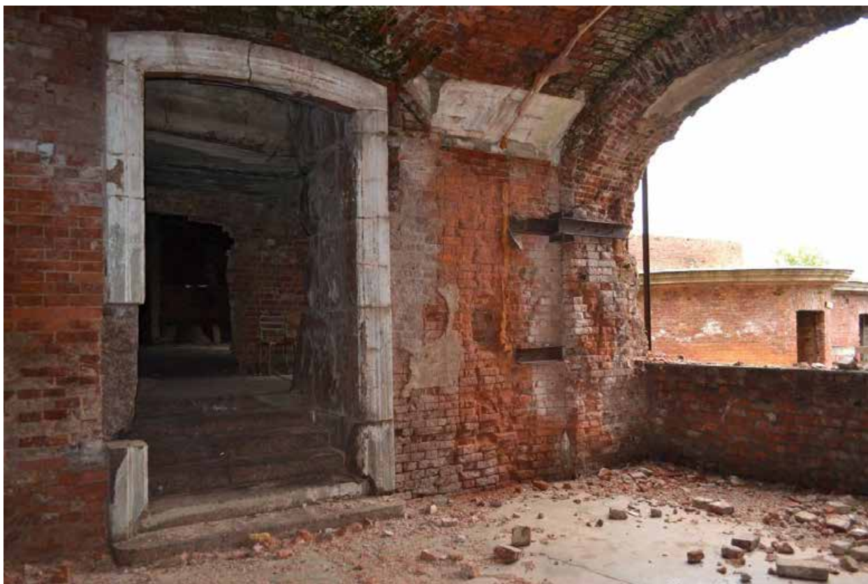
Фото 9. Казематы. Помещения третьего этажа.
