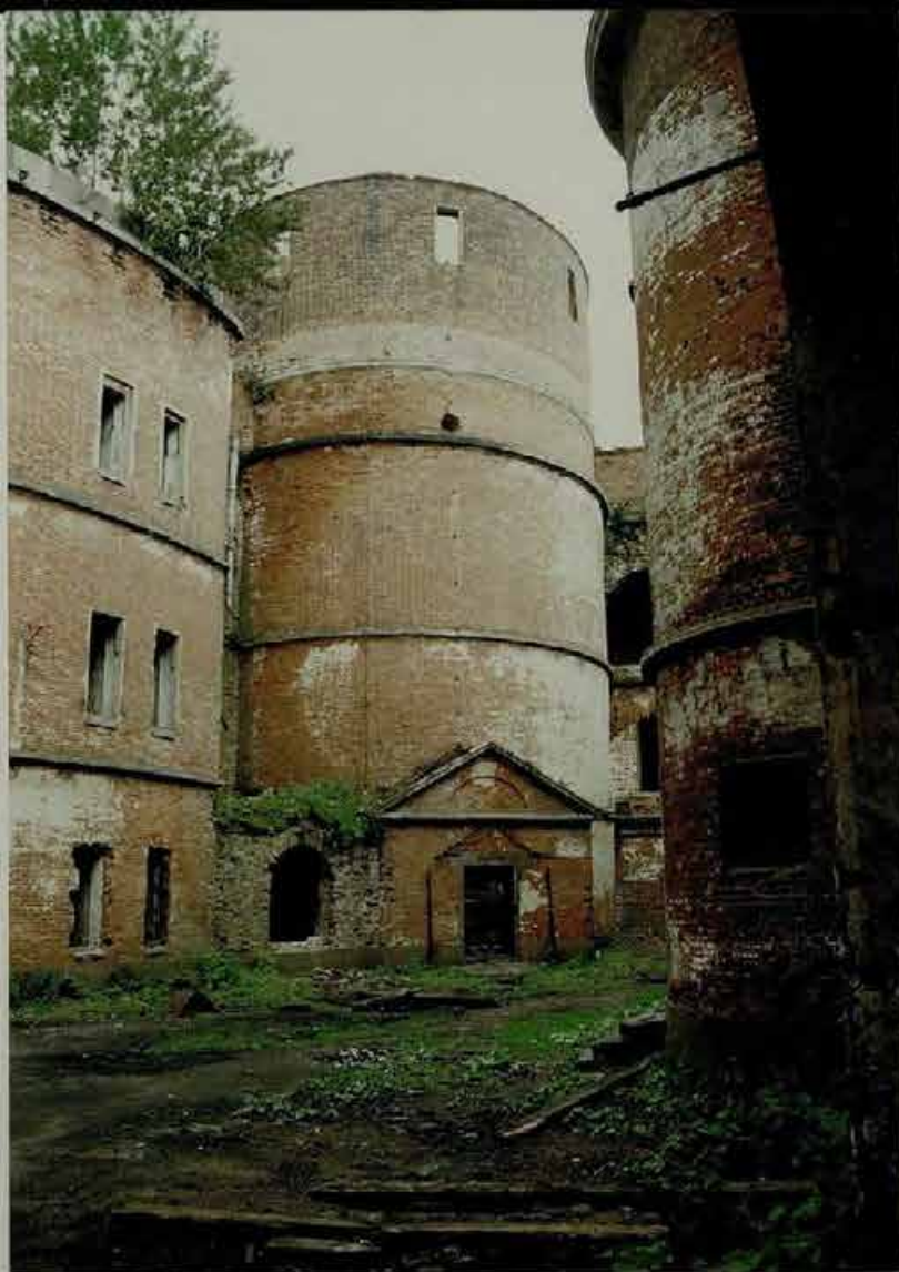
Российская Федерация Санкт-Петербург Крошгальский район Финский залив, Южный фарватер. Форт «Александр II» 1836 - 1845 гг. Внутренний двор. Западная лестница. Вид с востока. Натурная съемка: июль 2000 г. Фото В. П. Орлова. Фото № 14.
