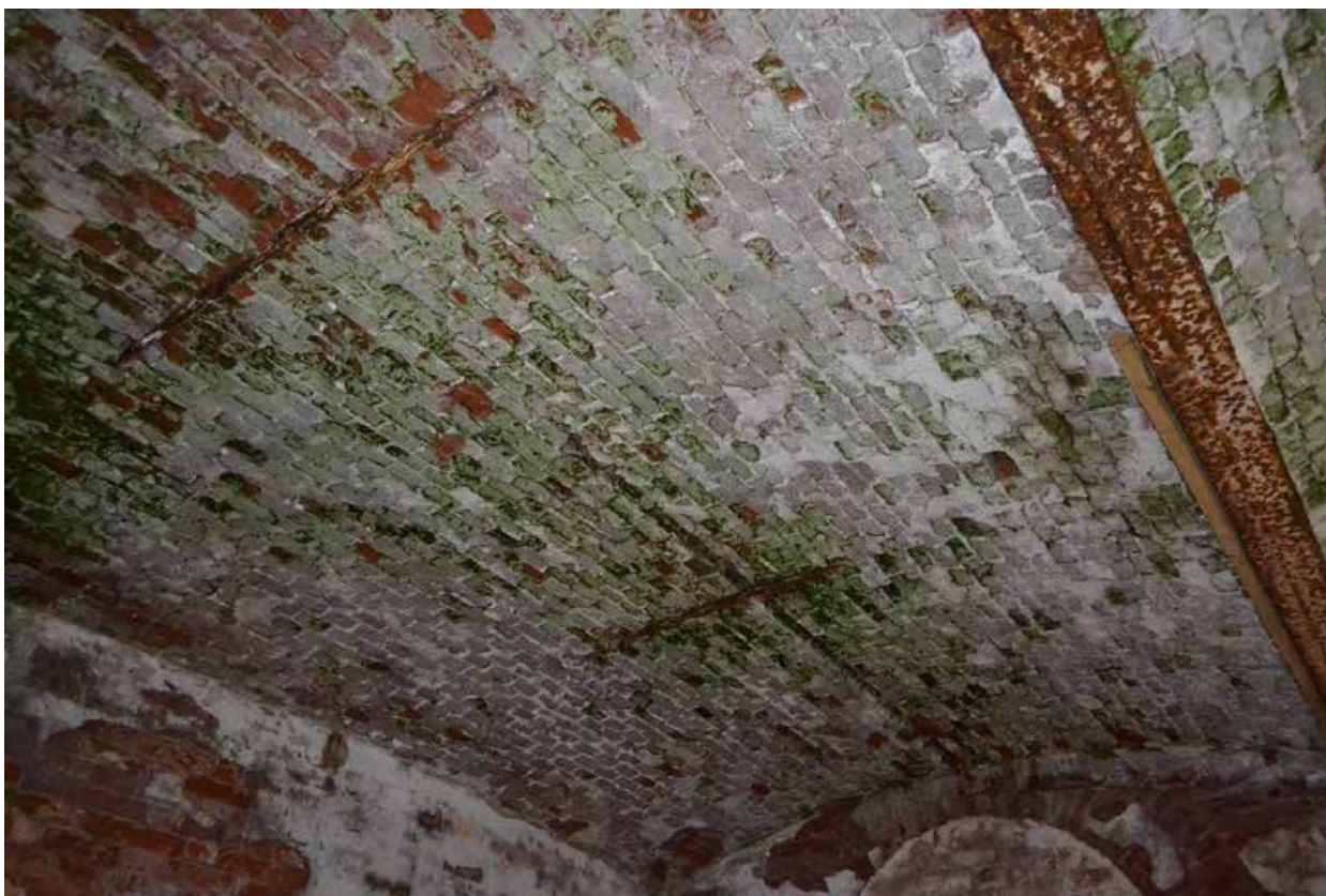
Фото 4. Второй этаж. Помещение горжевой части. Вид на своды «Монье».
