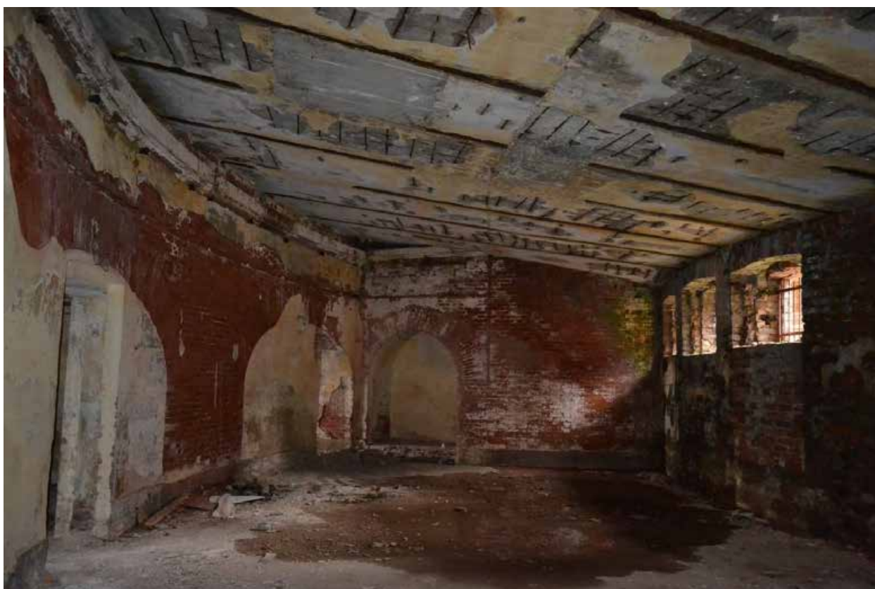
Фото 8. Первый этаж. Бывшая часть внутреннего двора.
