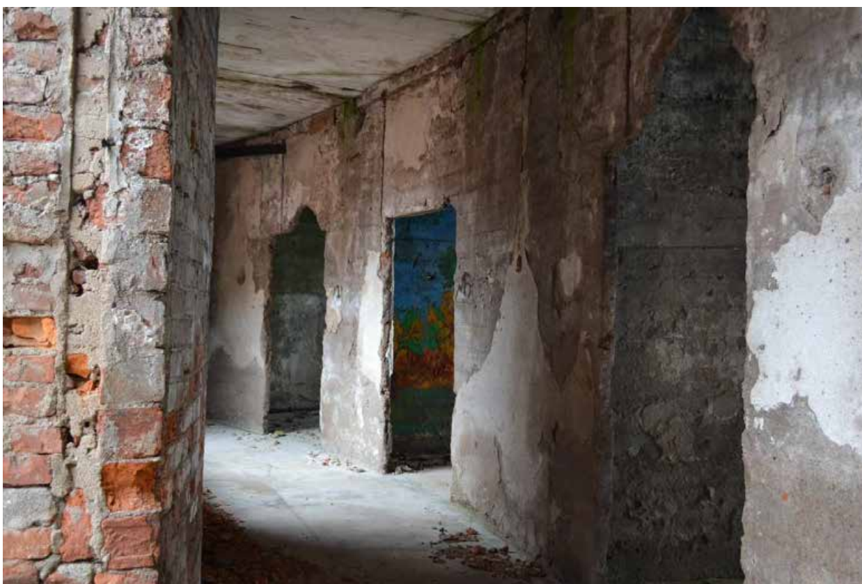
Фото 3. Казематы. Помещения третьего этажа.
