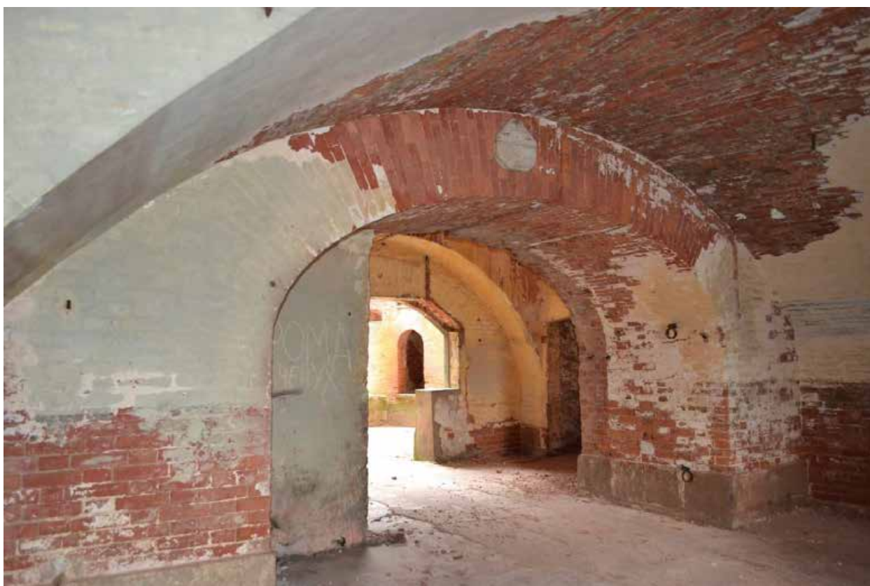
Фото 4. Первый этаж. Помещение казематов. Выход во внутренний двор из казематов.
