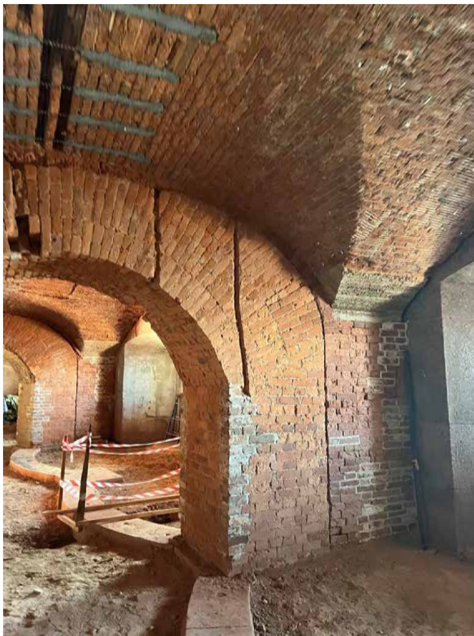
Фото 18. Первый этаж. Помещения казематов.
