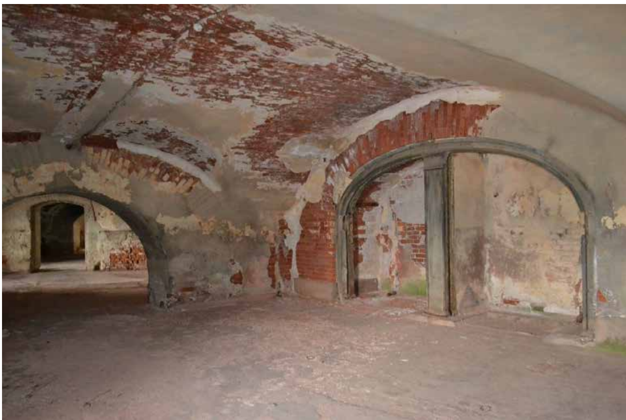
Фото 6. Первый этаж. Помещение казематов. Ниши с чугунным оформлением.
