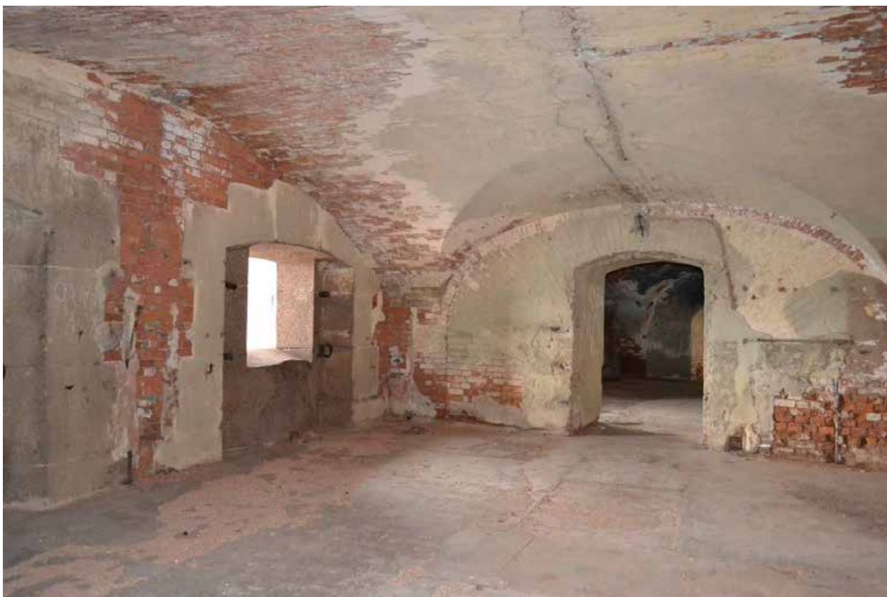
Фото 5. Первый этаж. Помещение казематов.
