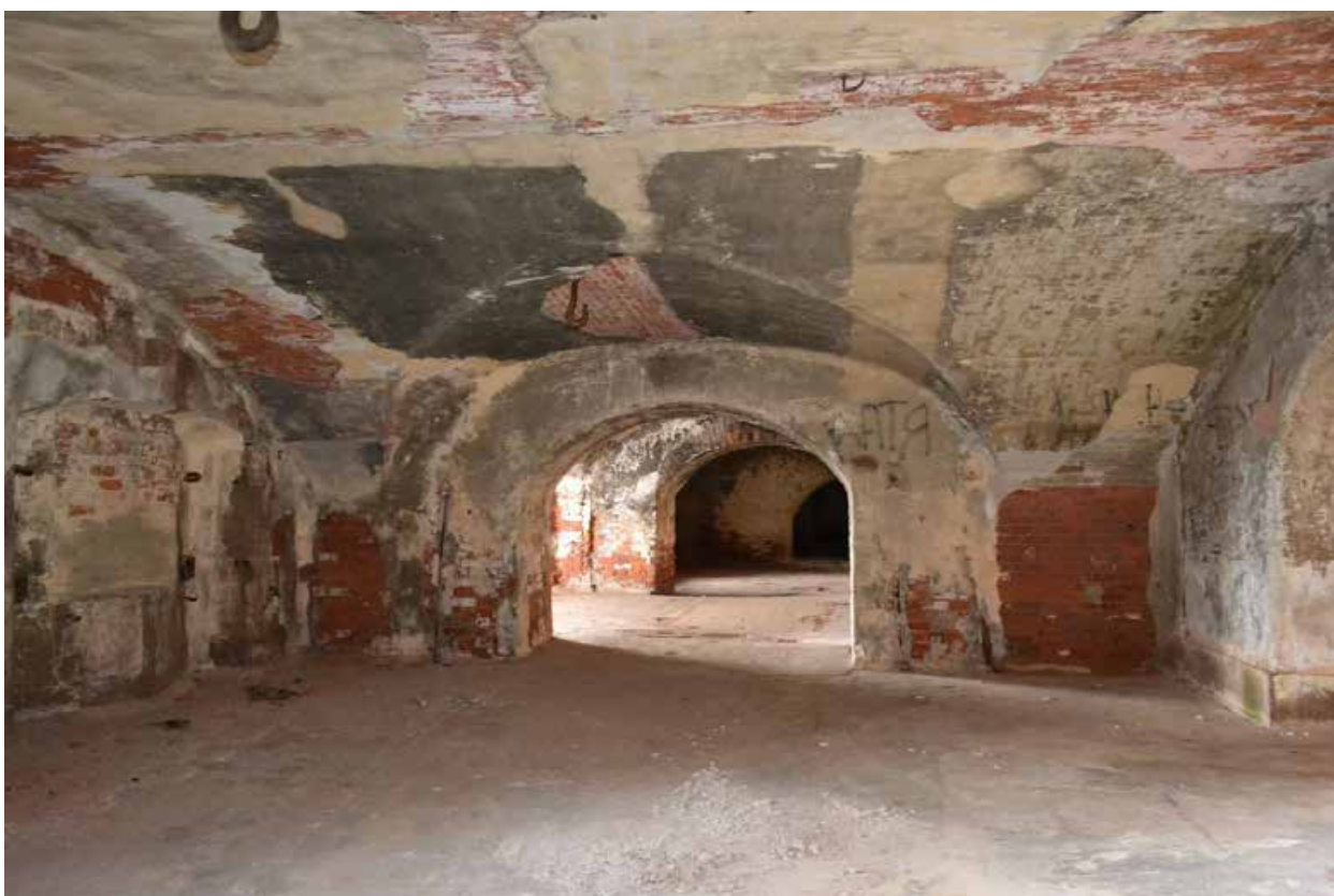
Фото 2. Первый этаж. Помещение казематов.
