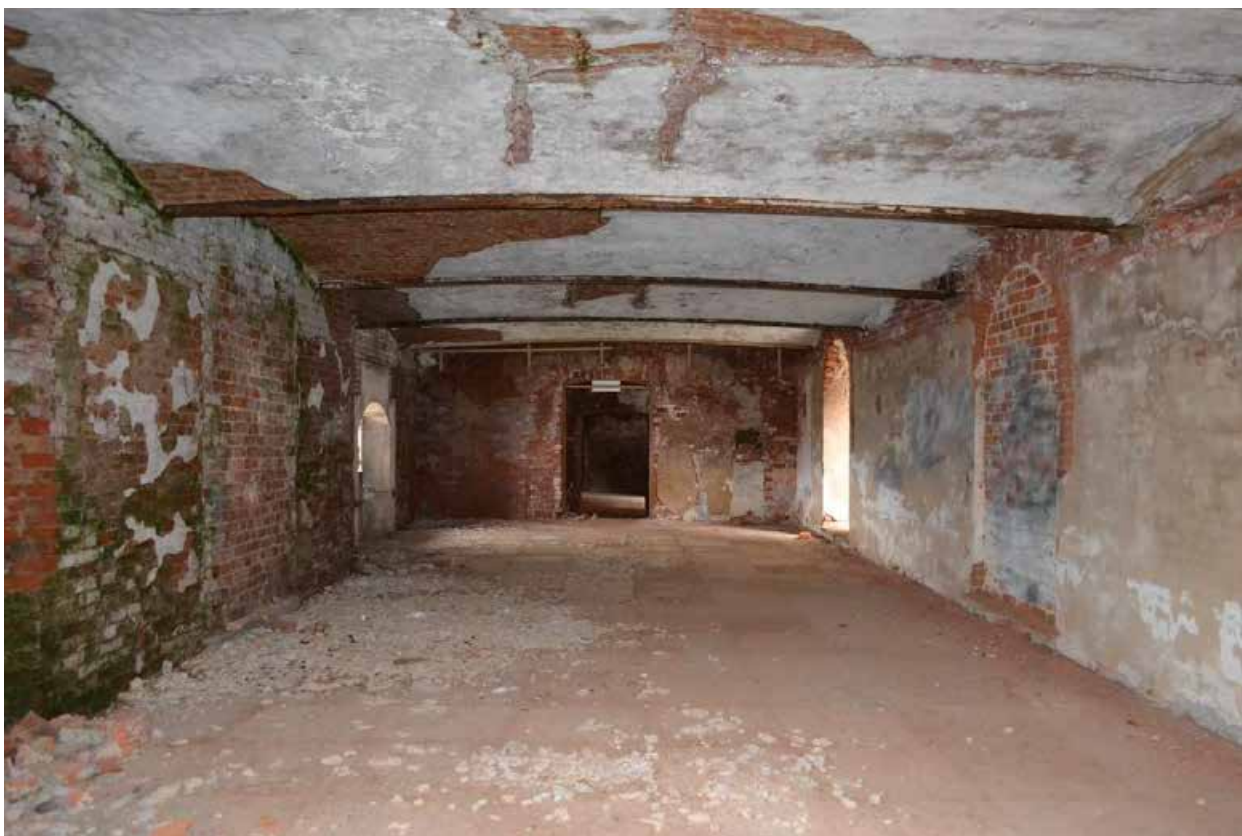
Фото 5. Второй этаж. Помещение горжевой части.
