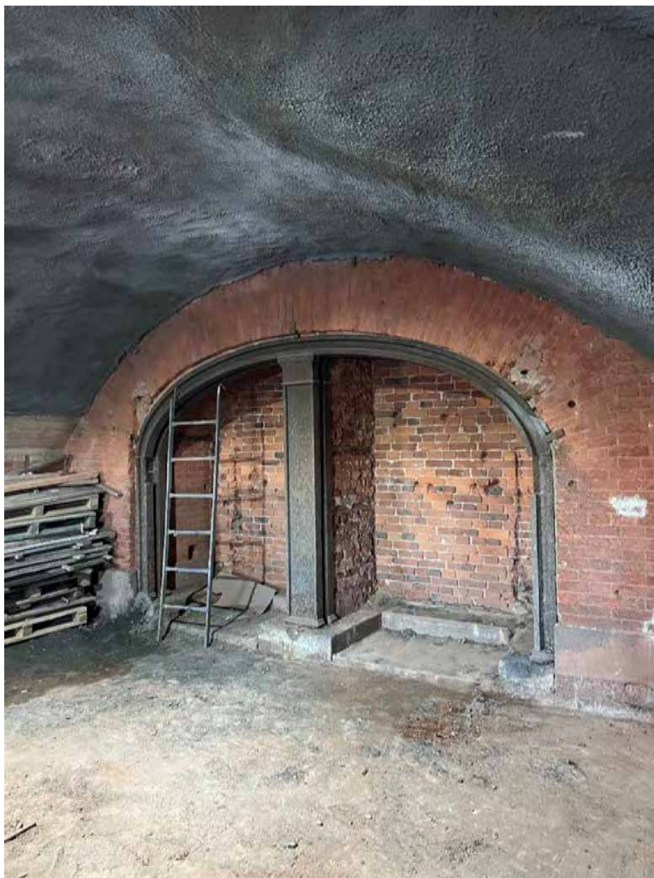
Фото 12. Первый этаж. Помещения казематов. Ниши с чугунным оформлением.
