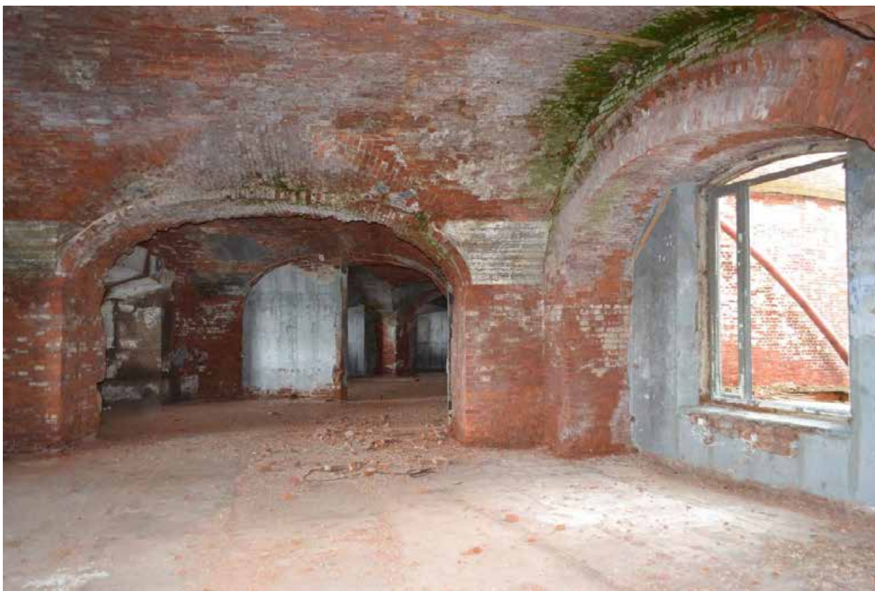
Фото 3. Второй этаж. Казематы. Вид на частично заложённый проем.
