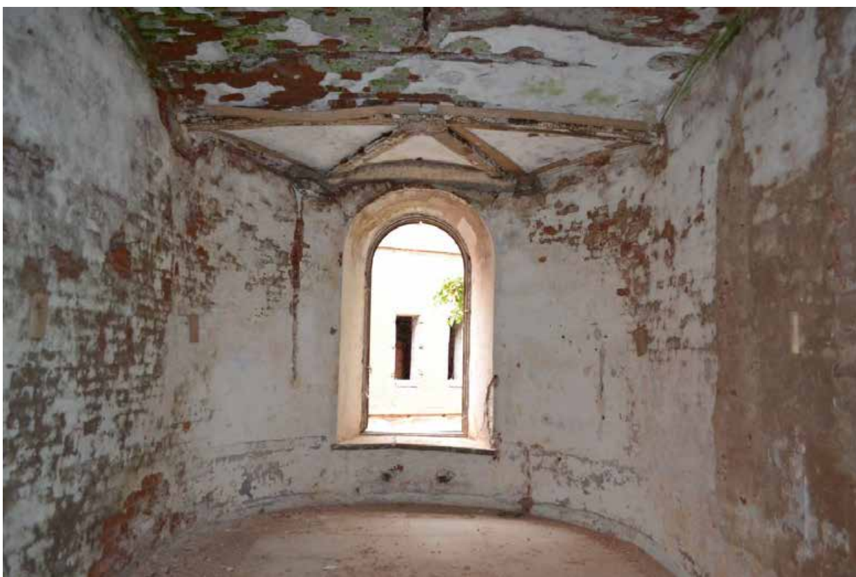
Фото 6. Второй этаж. Помещение горжевой части.
