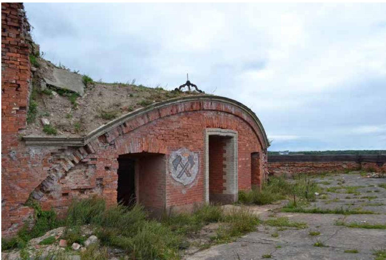
Фото 1. Вид на объем восточной лестничной клетки с валагнга.
