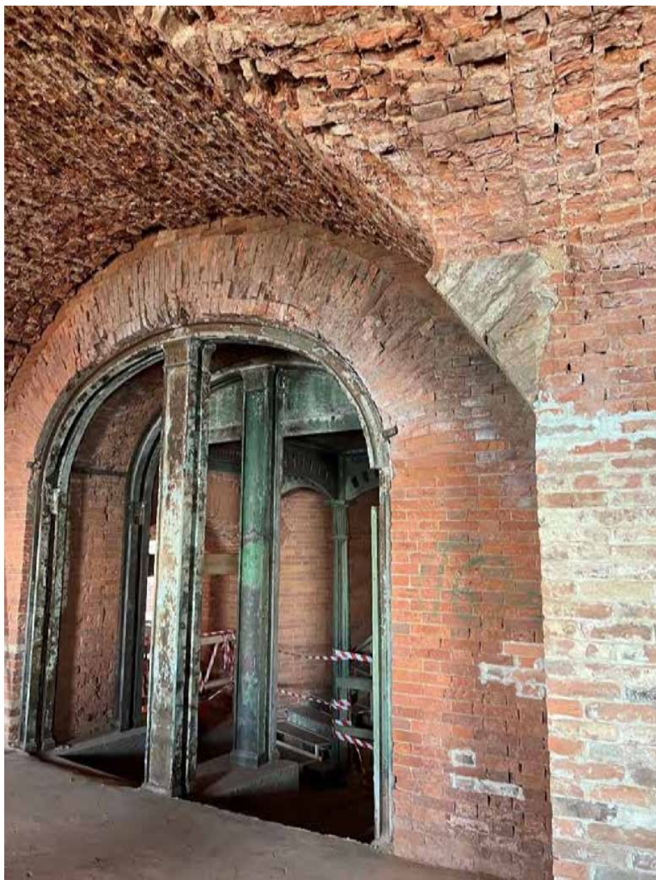
Фото 22. Третий этаж. Помещения казематов. Вид на проем, ведущий на лестницу.
