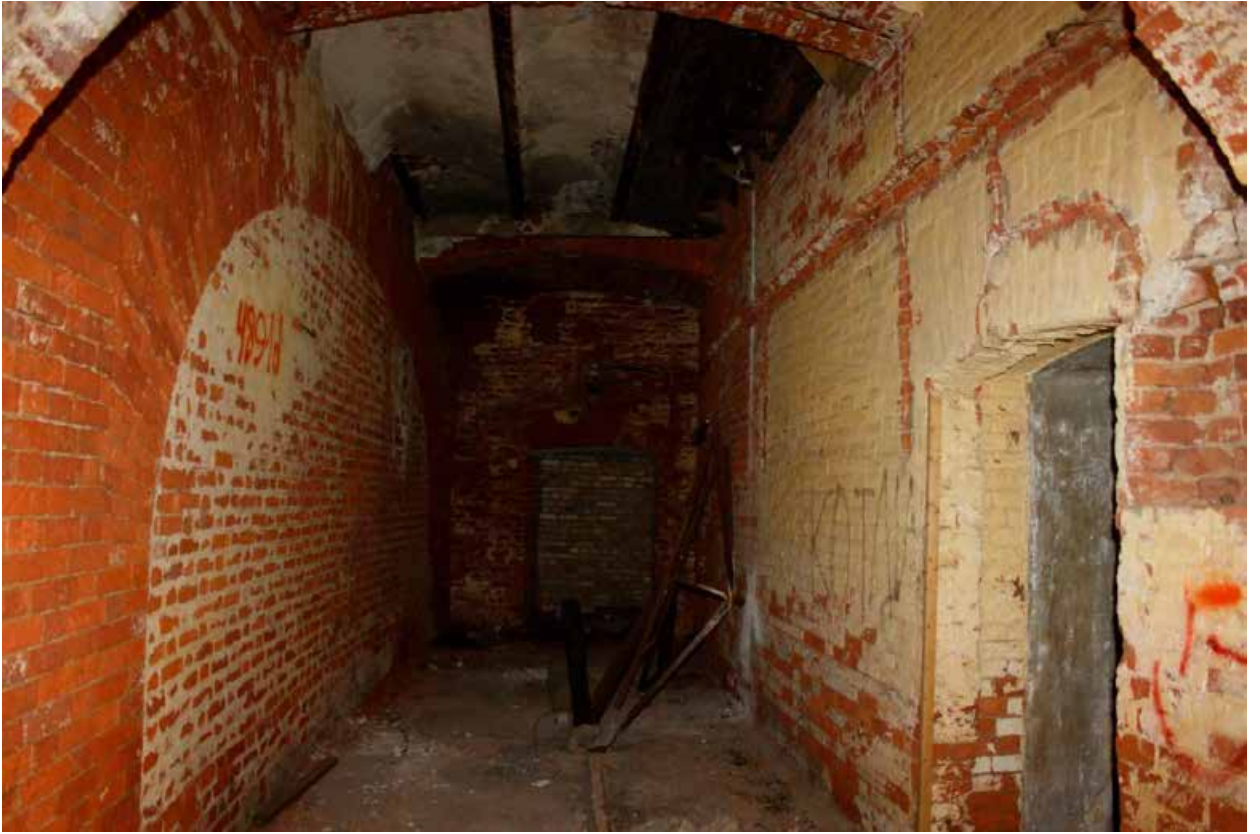
Фото 15. Первый этаж. Помещения порохохранилища.
