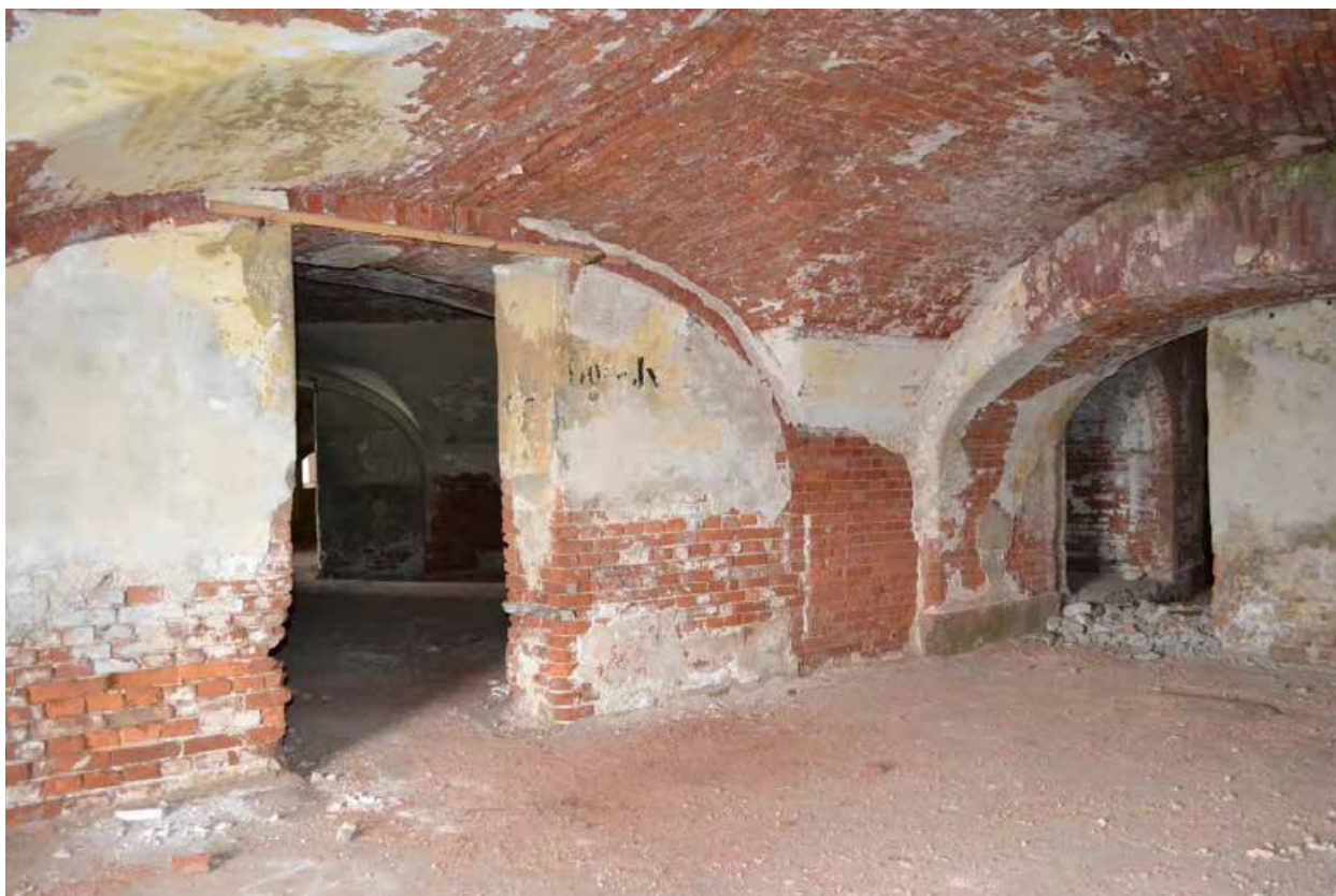
Фото 7. Первый этаж. Помещение казематов.
