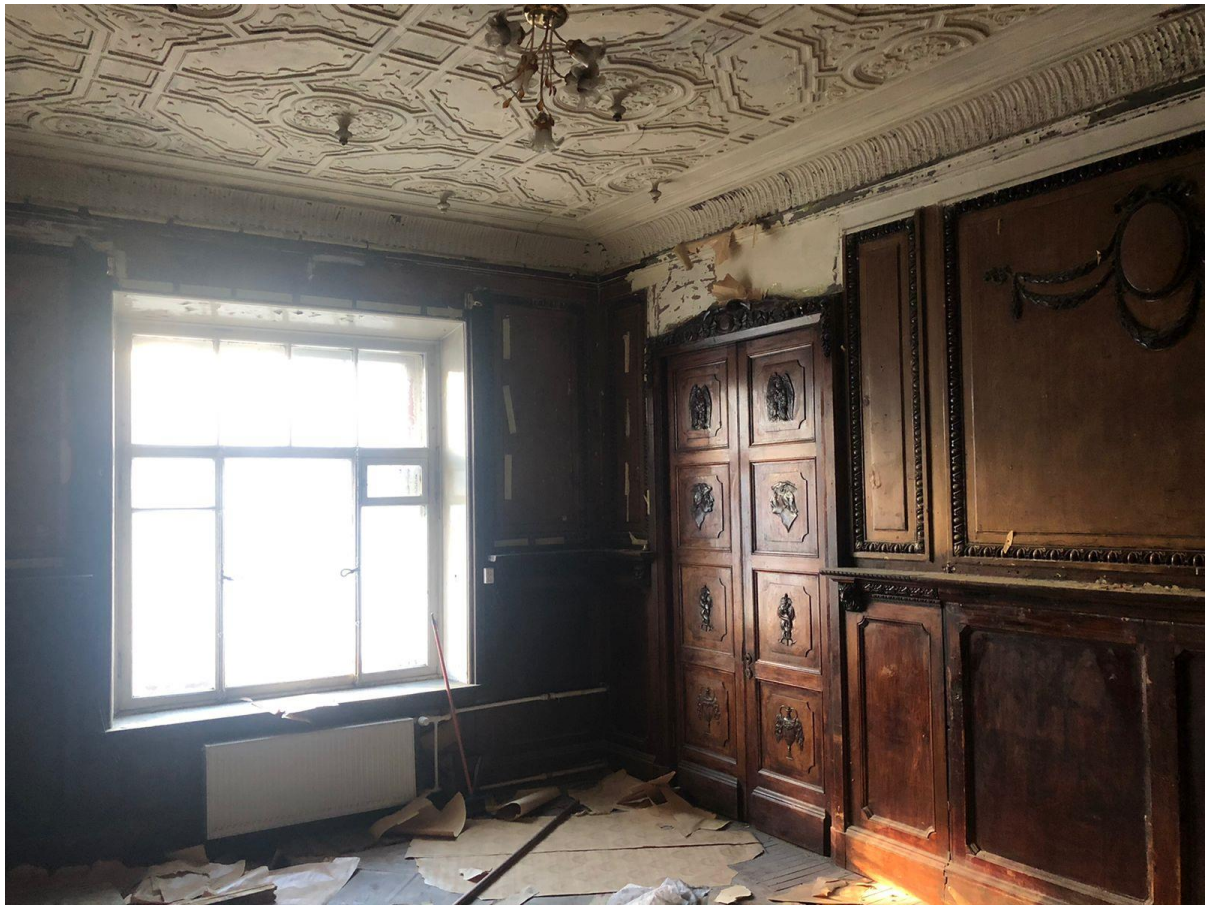
Фото 22. Помещение № 10. Вид на окно.
