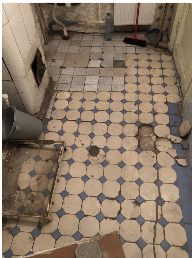
Фото 15. Помещение № 7. Пол в ванной.
