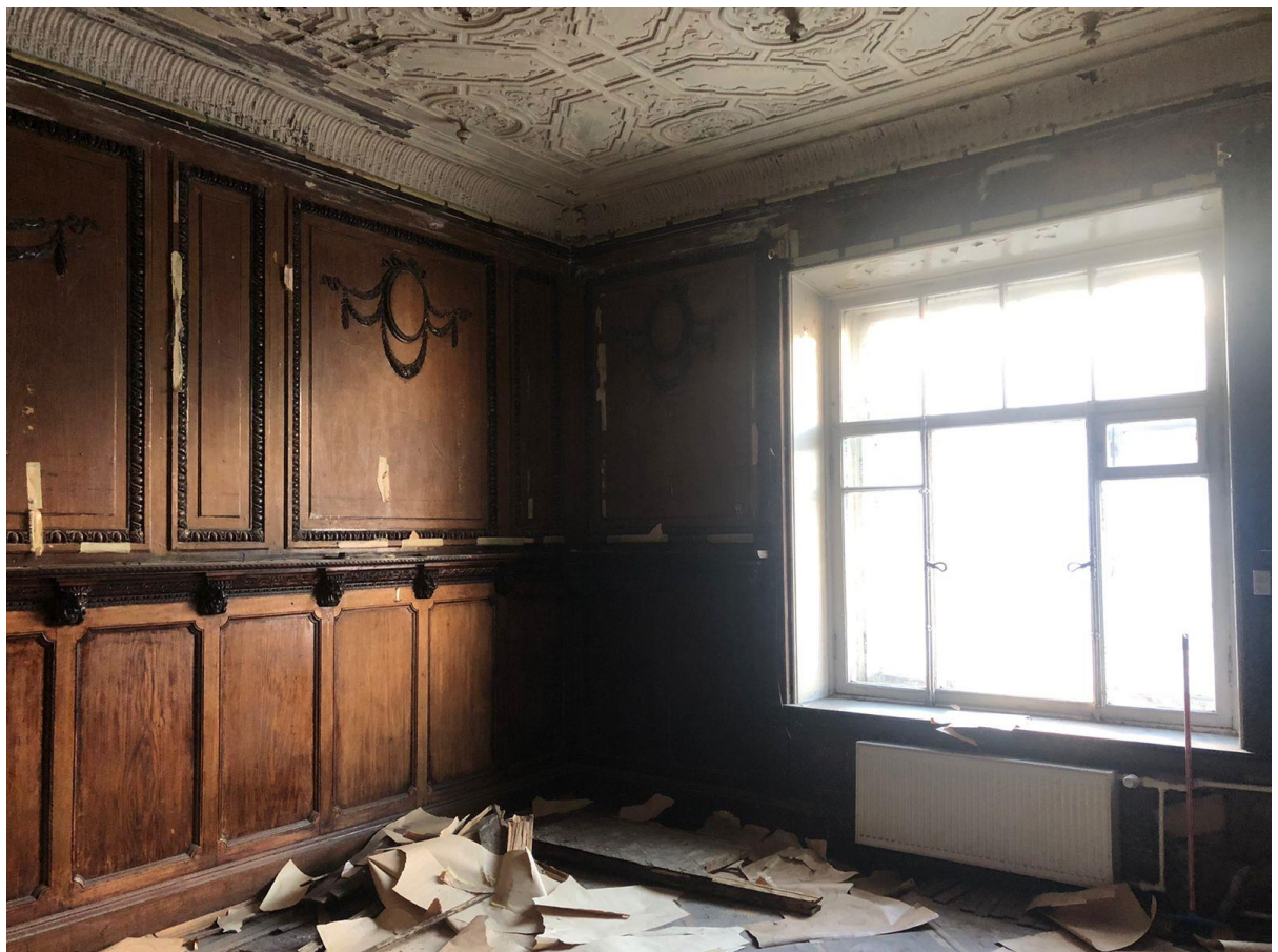
Фото 23. Помещение № 10. Вид на окно.
