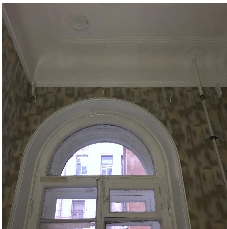
Фото 7. Помещение № 2. Карниз. Часть окна.
