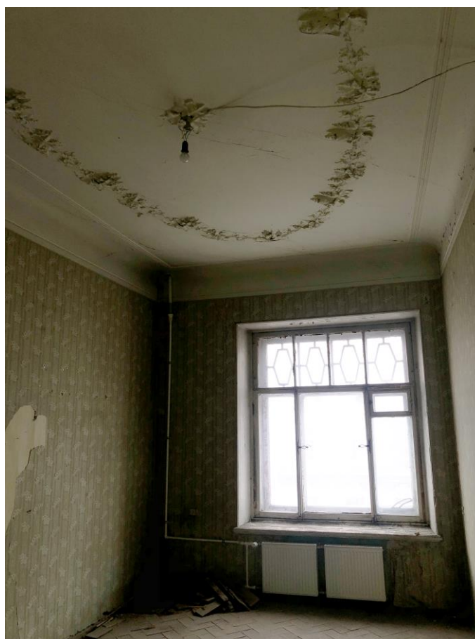
Фото 17. Помещение № 9. Вид на окно.
