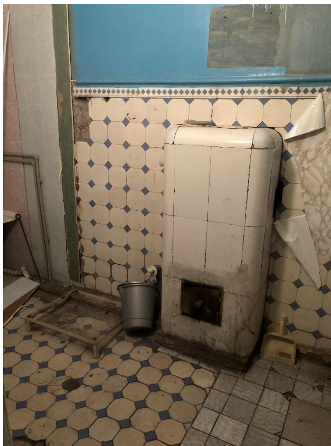
Фото 14. Помещение № 7. Ванная. Вид на печь.
