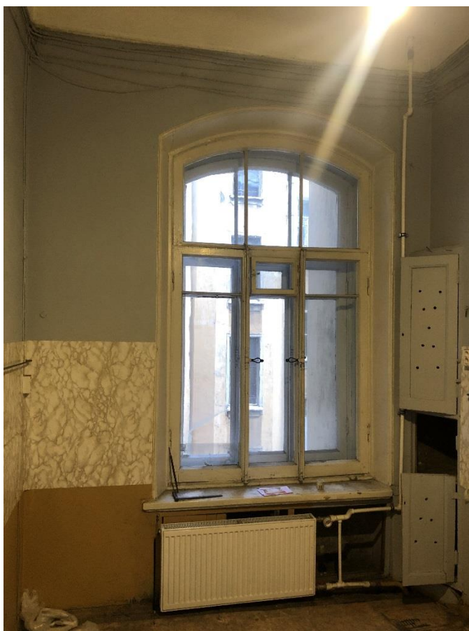
Фото 11. Помещение № 4. Кухня. Окно.
