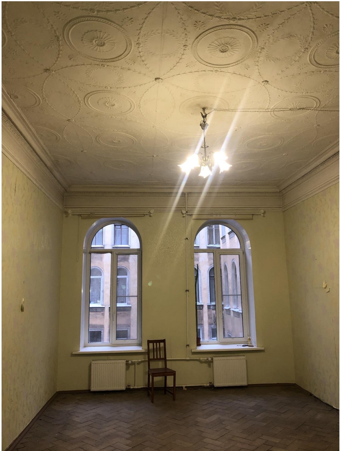
Фото 1. Помещение № 1. Вид на окна.
