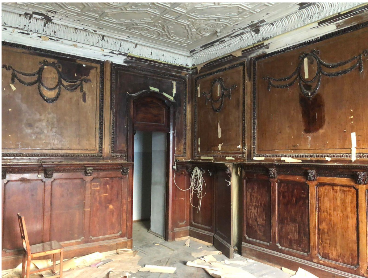
Фото 20. Помещение № 10. Вид на входную дверь.
