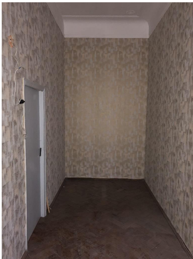
Фото 8. Помещение № 2. Вид на стену, противоположную стене с окном.
