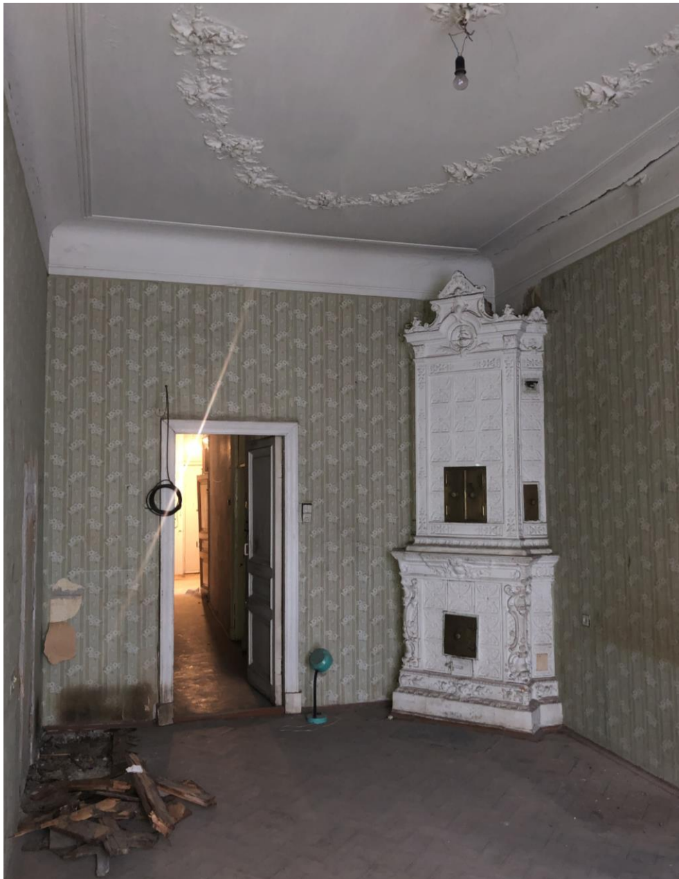
Фото 18. Помещение № 9. Вид на входную дверь.
