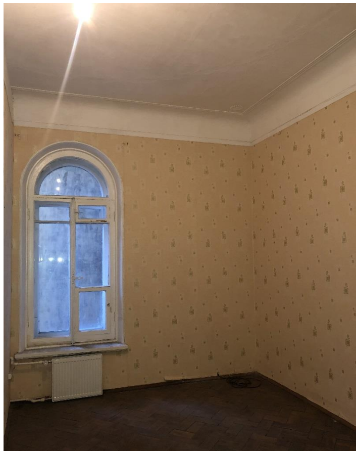
Фото 5. Помещение № 2. Вид в сторону окна.
