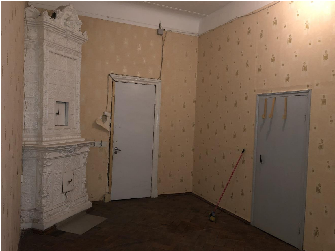
Фото 4. Помещение № 2. Вид на камин и двери.
