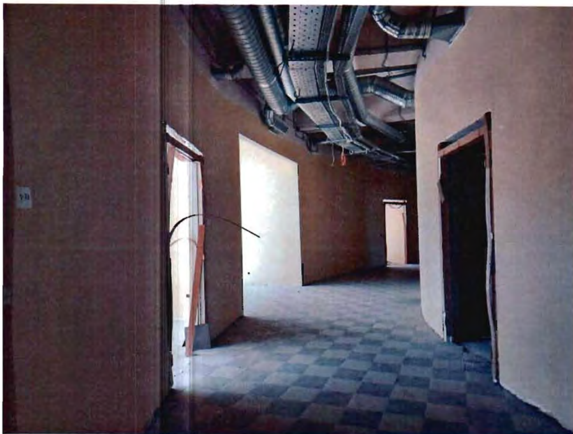
8. Интерьеры объекта культурного наследия. 2 этаж
