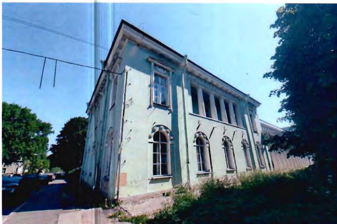
2. Вид на фрагмент южного фасада объекта культурного наследия. Западная часть фасада
