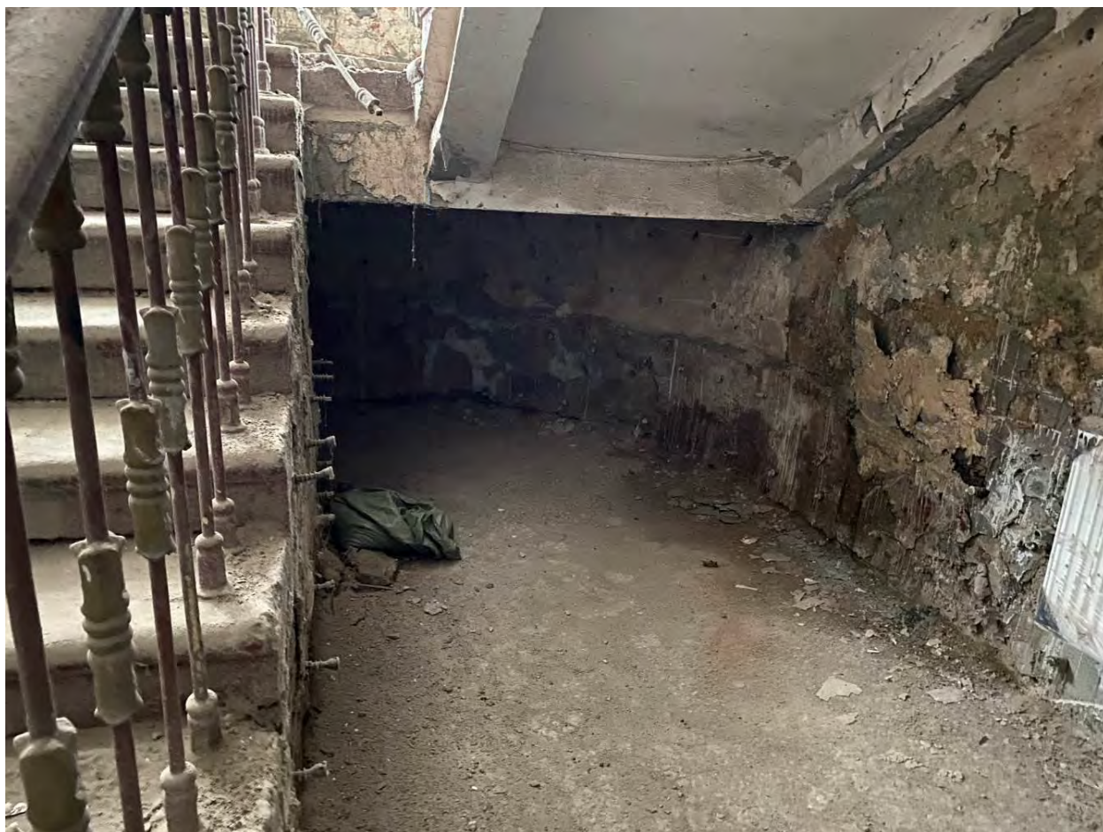
67. Объект культурного наследия федерального значения «Оранжерея Большая» по адресу: Санкт-Петербург, город Пушкин, Садовая ул., дом 14, литера А Помещение цокольного этажа Дата съемки: 29 апреля 2022 года
