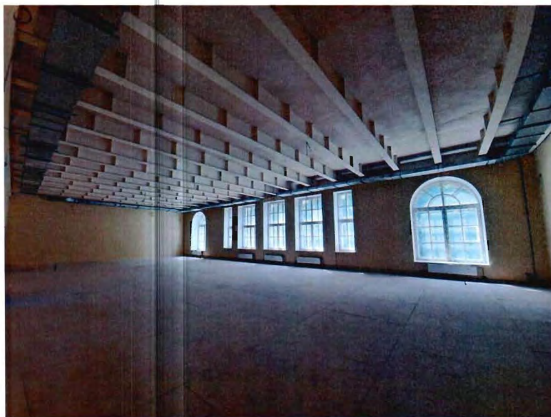
7. Интерьеры объекта культурного наследия. 1 этаж
