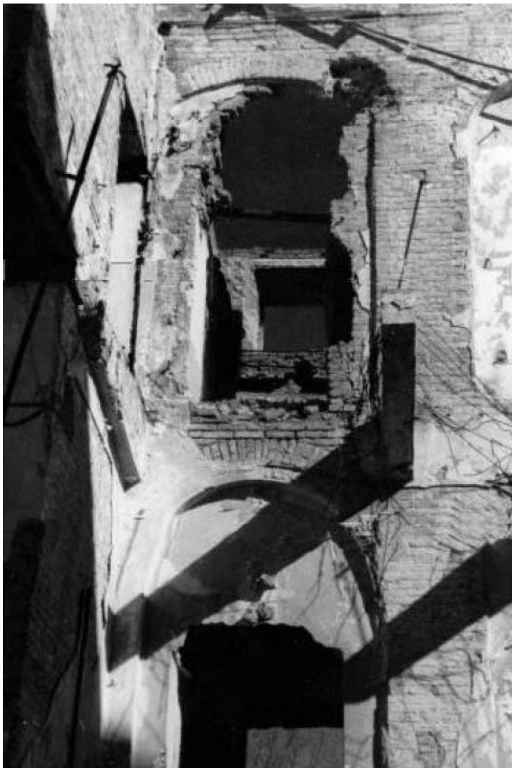
99. Вид разрушенного здания, где ранее находился Ленинградский институт инженеров молочной промышленности Январь 1949 г. Фото из музея Аграрного университета
