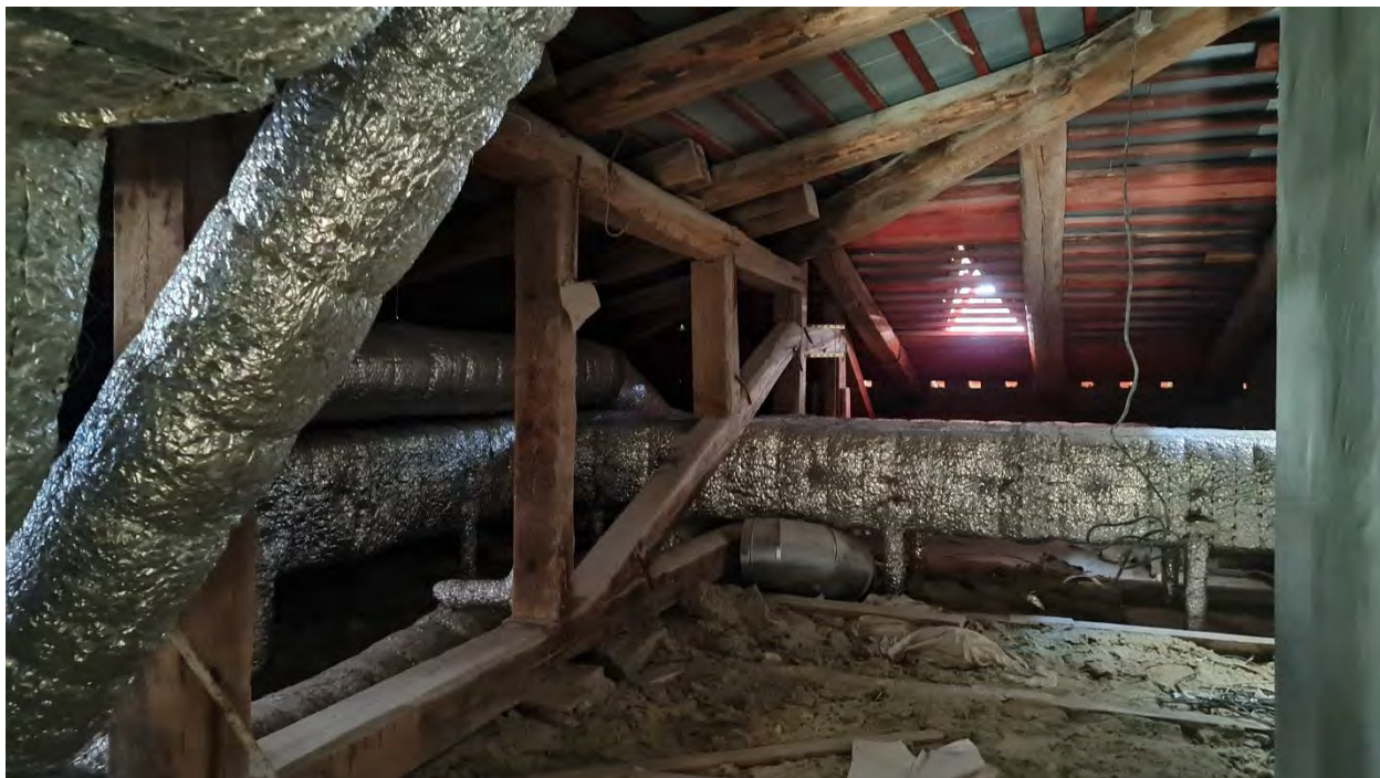
192. Объект культурного наследия федерального значения «Оранжерея Большая» по адресу: Санкт-Петербург, город Пушкин, Садовая ул., дом 14, литера А Помещение чердака корпуса по Оранжерейной улице Дата съемки: 29 апреля 2022 года
