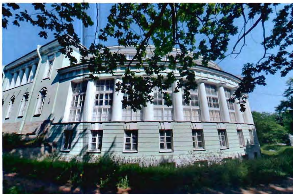
3. Вид на фрагмент южного фасада объекта культурного наследия. Восточная часть фасада
