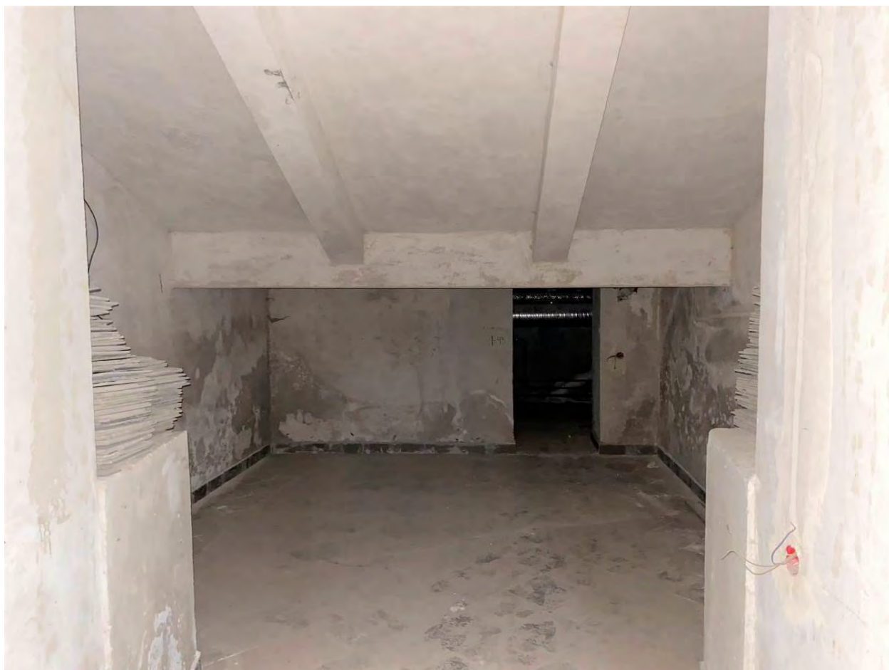
66. Объект культурного наследия федерального значения «Оранжерея Большая» по адресу: Санкт-Петербург, город Пушкин, Садовая ул., дом 14, литера А Помещение цокольного этажа Дата съемки: 29 апреля 2022 года
