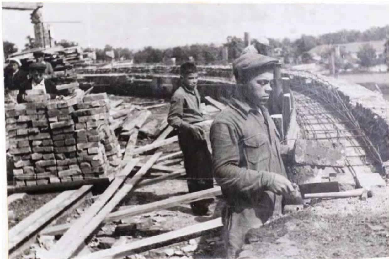
111. Строительные работы по восстановлению полуциркульного корпуса. 1953 г. Фото из музея Аграрного университета.
