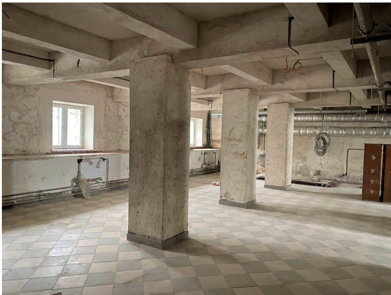
65. Объект культурного наследия федерального значения «Оранжерея Большая» по адресу: Санкт-Петербург, город Пушкин, Садовая ул., дом 14, литера А Помещение цокольного этажа Дата съемки: 29 апреля 2022 года
