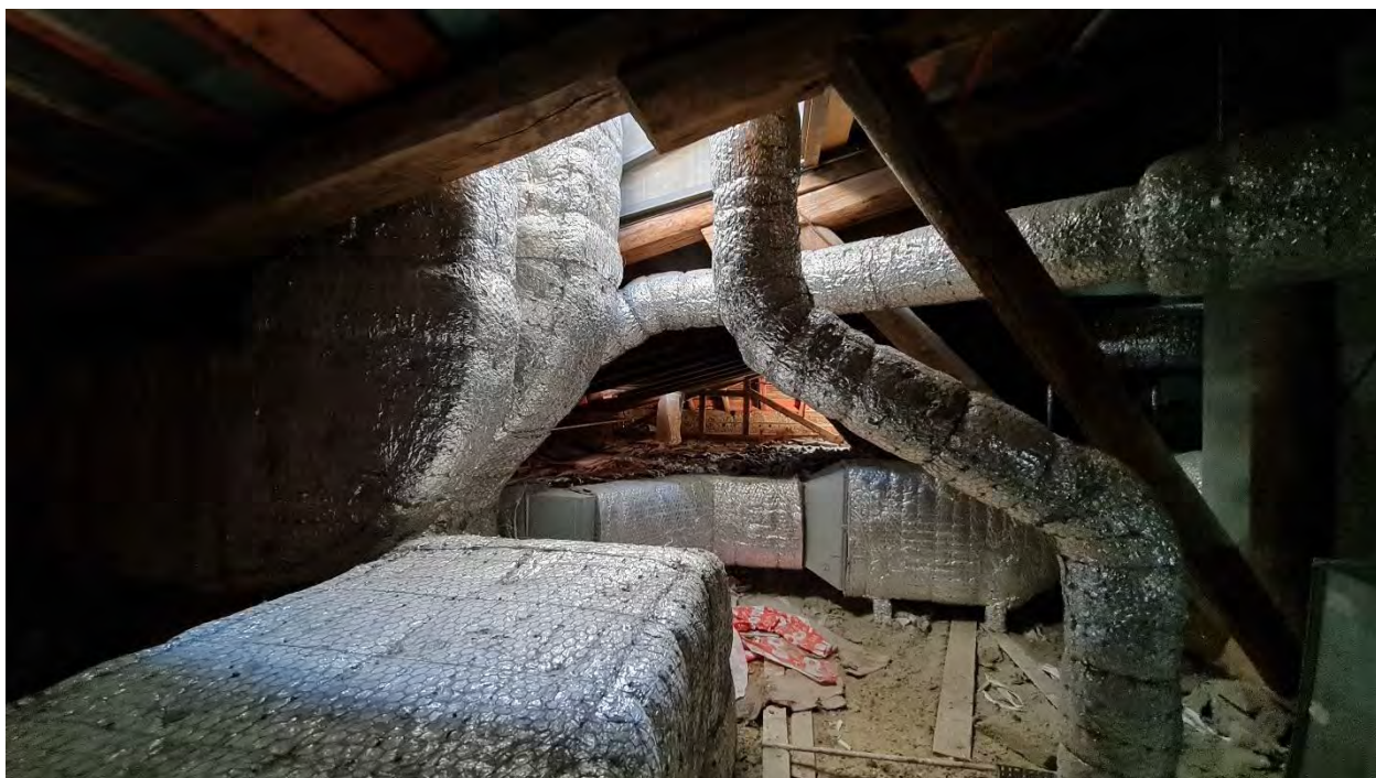
193. Объект культурного наследия федерального значения «Оранжерея Большая» по адресу: Санкт-Петербург, город Пушкин, Садовая ул., дом 14, литера А Помещение чердака корпуса по Оранжерейной улице Дата съемки: 29 апреля 2022 года
