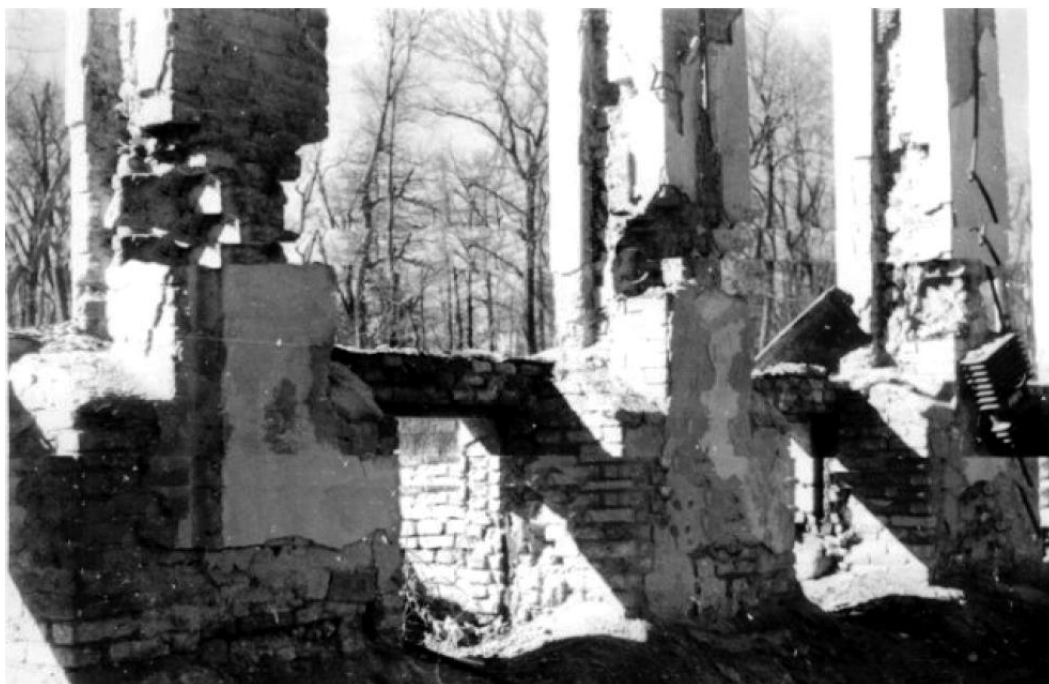
106. Вид разрушенного здания, где ранее находился Ленинградский институт инженеров молочной промышленности 1949г ЦГАКФФД Ар 202620
