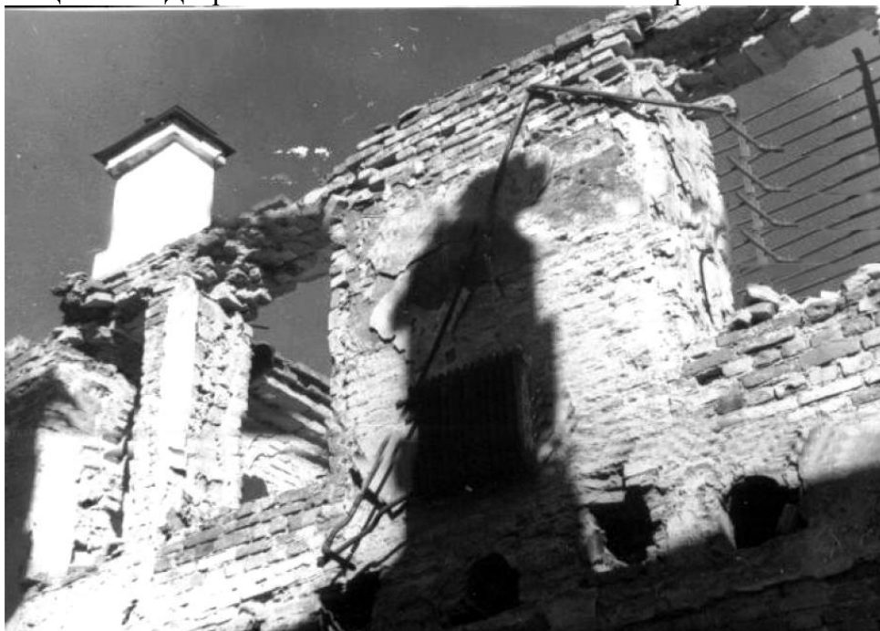
103. Вид разрушенного здания, где ранее находился Ленинградский институт инженеров молочной промышленности 1949г. ЦГАКФФД Ар 202617
