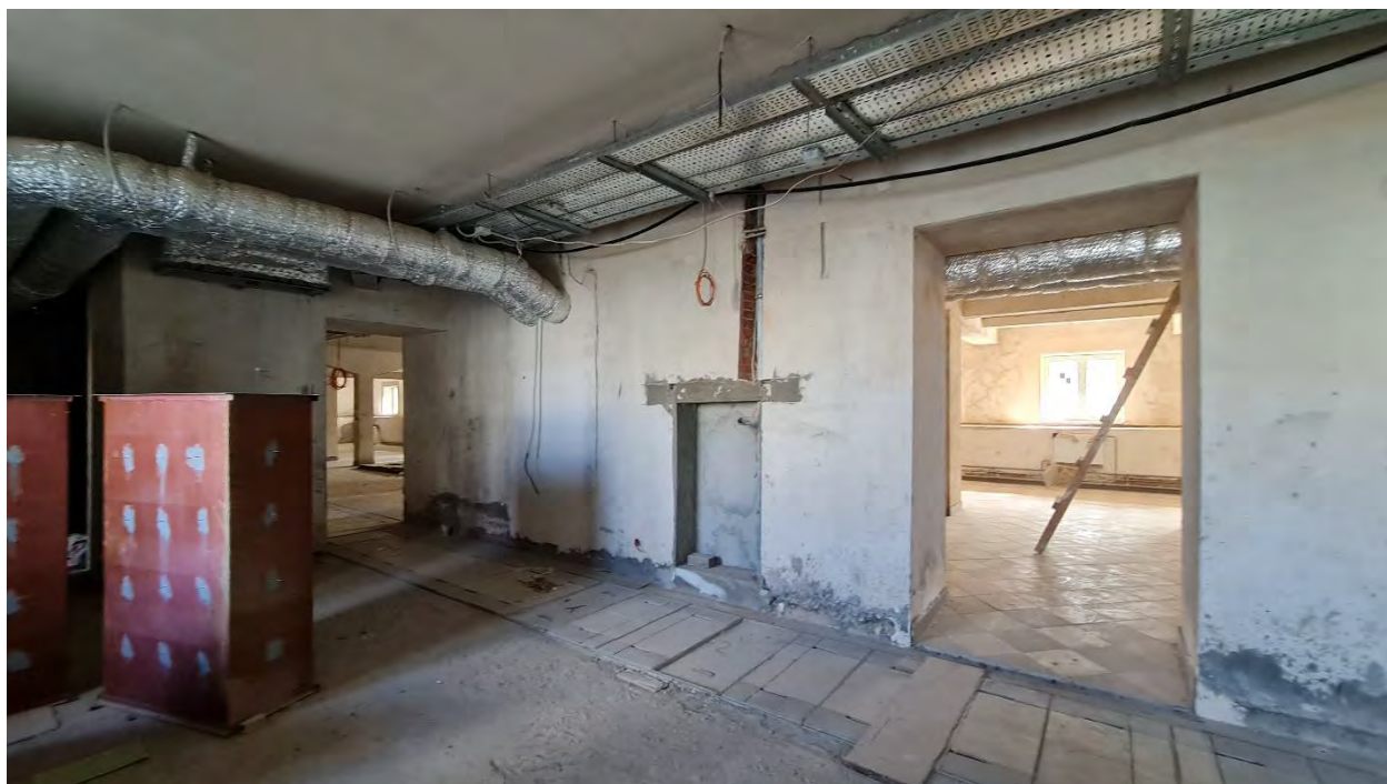
64. Объект культурного наследия федерального значения «Оранжерея Большая» по адресу: Санкт-Петербург, город Пушкин, Садовая ул., дом 14, литера А Помещение цокольного этажа Дата съемки: 29 апреля 2022 года
