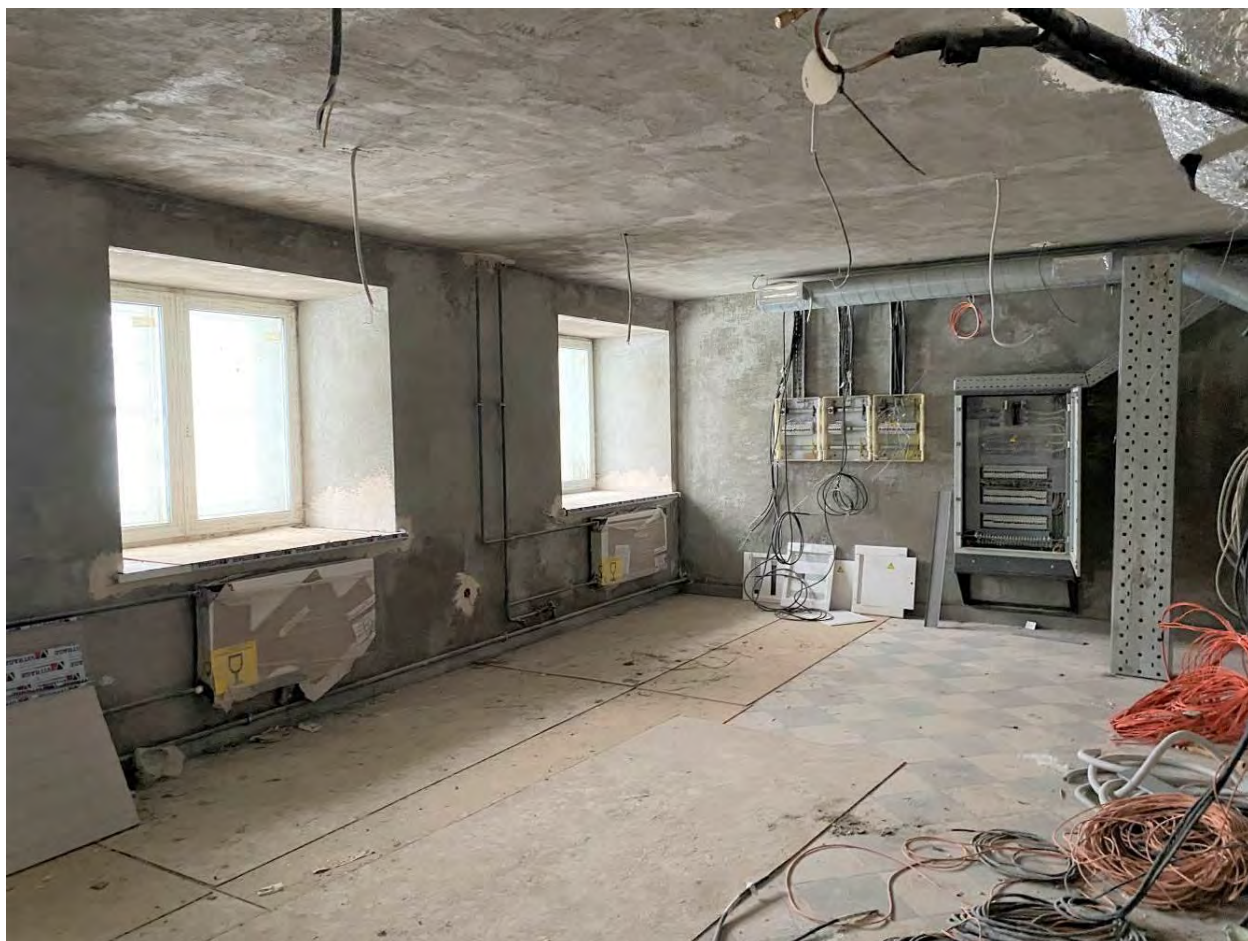
70. Объект культурного наследия федерального значения «Оранжерея Большая» по адресу: Санкт-Петербург, город Пушкин, Садовая ул., дом 14, литера А Помещение цокольного этажа Дата съемки: 29 апреля 2022 года
