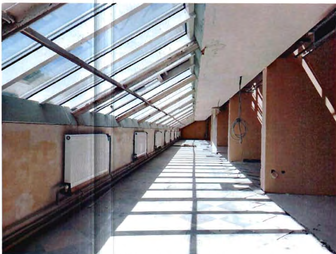
9. Интерьеры объекта культурного наследия. 3 этаж
