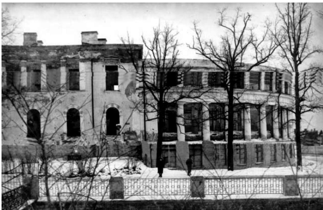
96. Вид разрушенного здания института на Комсомольской площади. 1945 г. Фото. ЦГАКФФД Пр 1046 сн. 9
