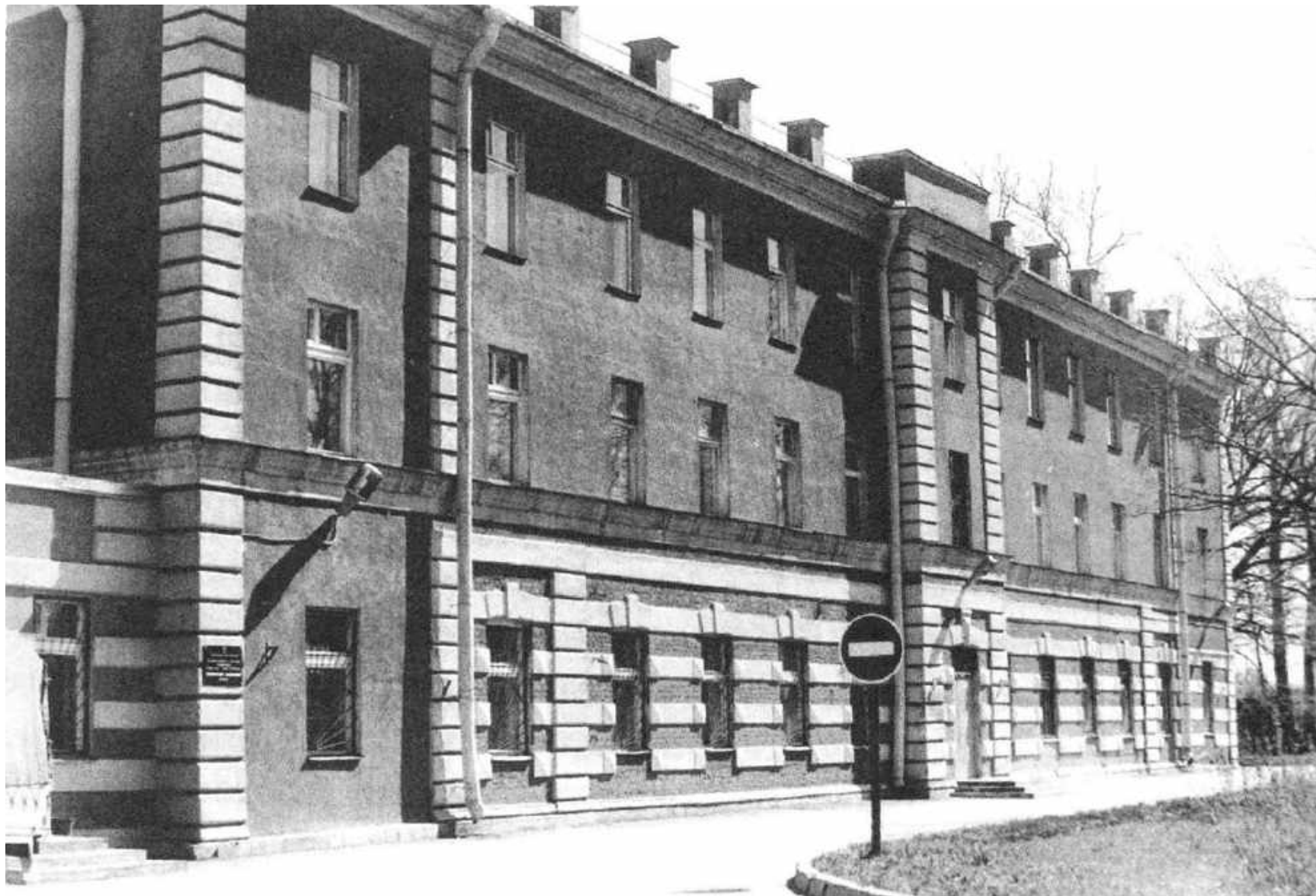
5. Пушкин (Царское Село). Очистная биологическая станция на Фильтровском шоссе, 7. 1997–1998 гг. Автор: Т.П. Калуга. С.Я. Ласточкин, Ю.Ф. Рубежанский. Царское Село – резиденция российских монархов. Архитектурный и военно-исторический очерк. СПб, ВИТУ. Издательство «Викторита», 1998. Источник: https://pastvu.com/p/136674
