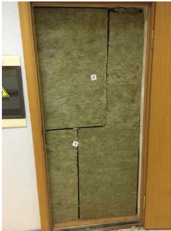
Фото 8. Заложенный дверной проем помещения № 79. Вид из помещения коридора № 75 (по плану ПИБ 2018 г.).
