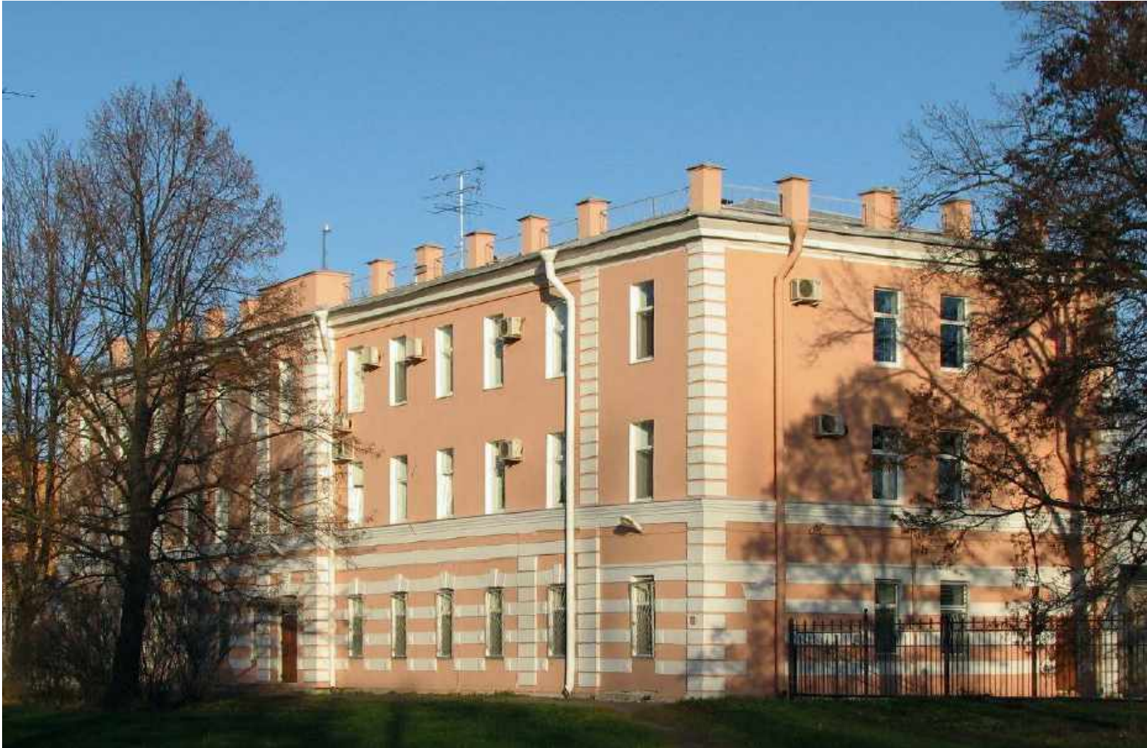
7. Выявленный объект культурного наследия «Дом для заведующего» (в составе ансамбля «Царскосельская очистная станция (3 здания)»), по адресу: Санкт-Петербург, пос. Тярлево, Филътровское шоссе, 7, лит. Б. Фото 09.11.2011 г.
