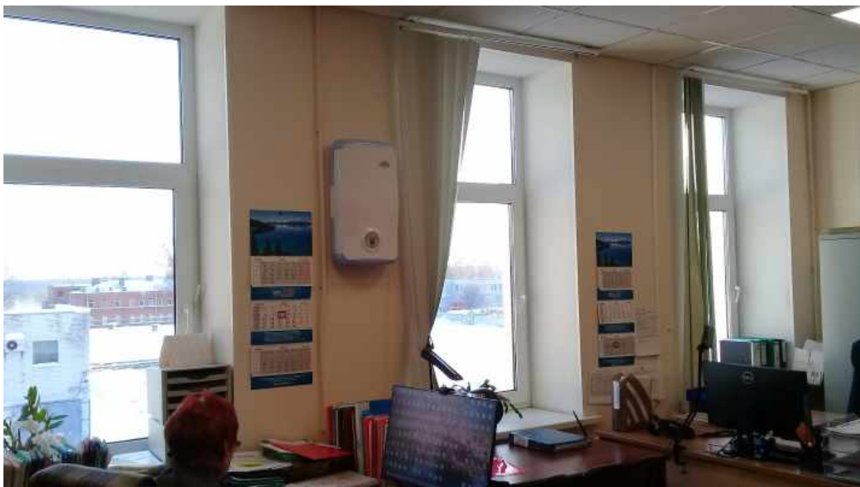
Фото 13. Оконные заполнения в помещении кабинета № 91 (по плану ПИБ 2018 г.).
