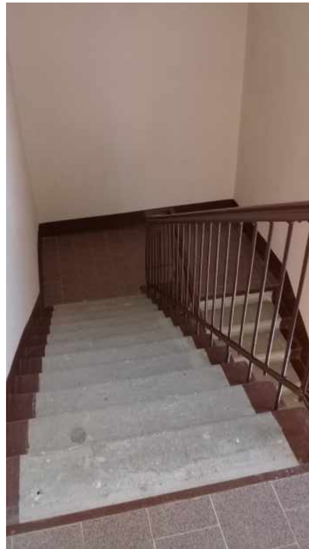
Фото 28. Помещение лестницы № 68 (по плану ПИБ 2018 г.)
