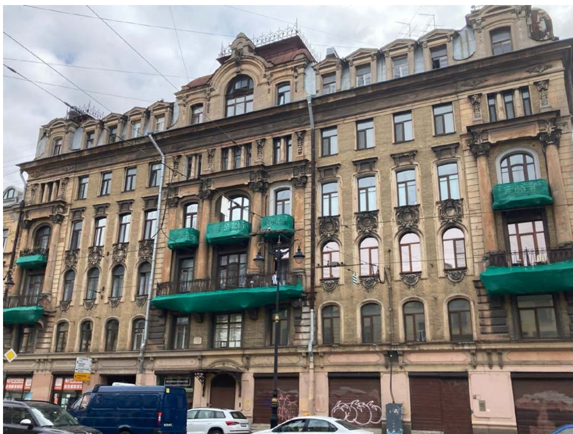
Фото 2. Лицевой фасад объекта культурного наследия регионального значения «Дом Единоверческой церкви Св. Николая».
