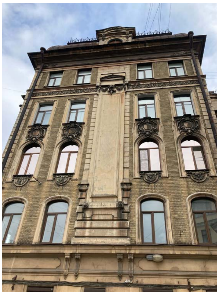
Фото 6. Фрагмент лицевого фасада объекта культурного наследия регионального значения «Дом Единоверческой церкви Св. Николая».
