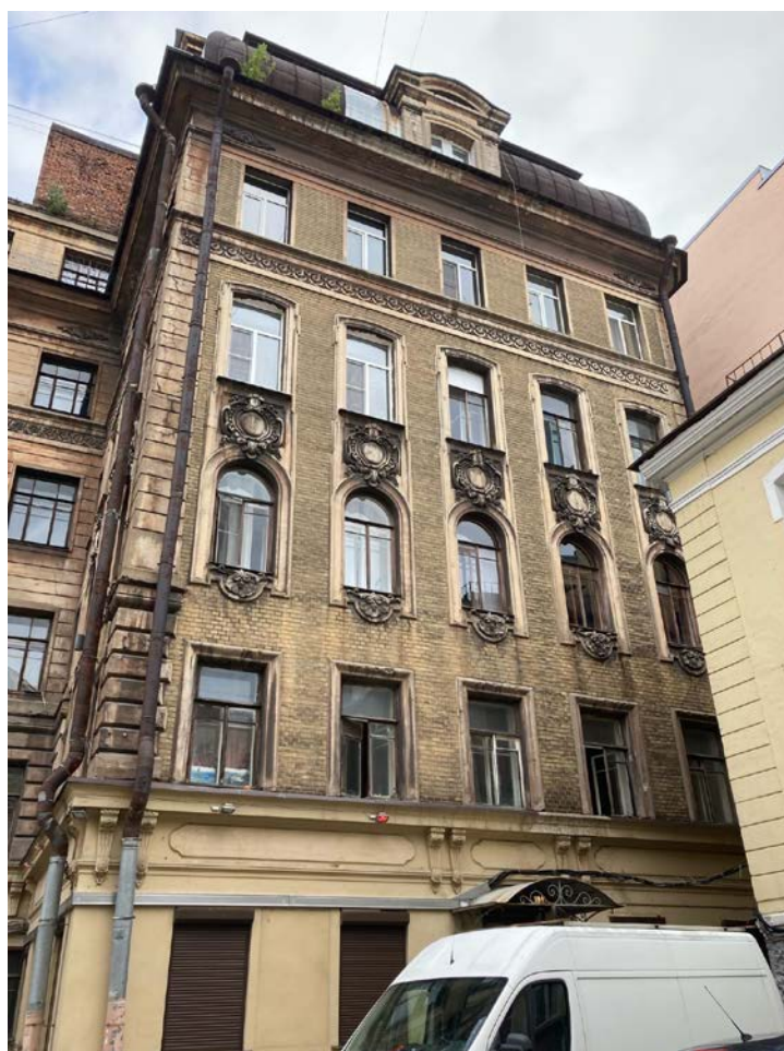
Фото 4. Фрагмент лицевого фасада объекта культурного наследия регионального значения «Дом Единоверческой церкви Св. Николая».
