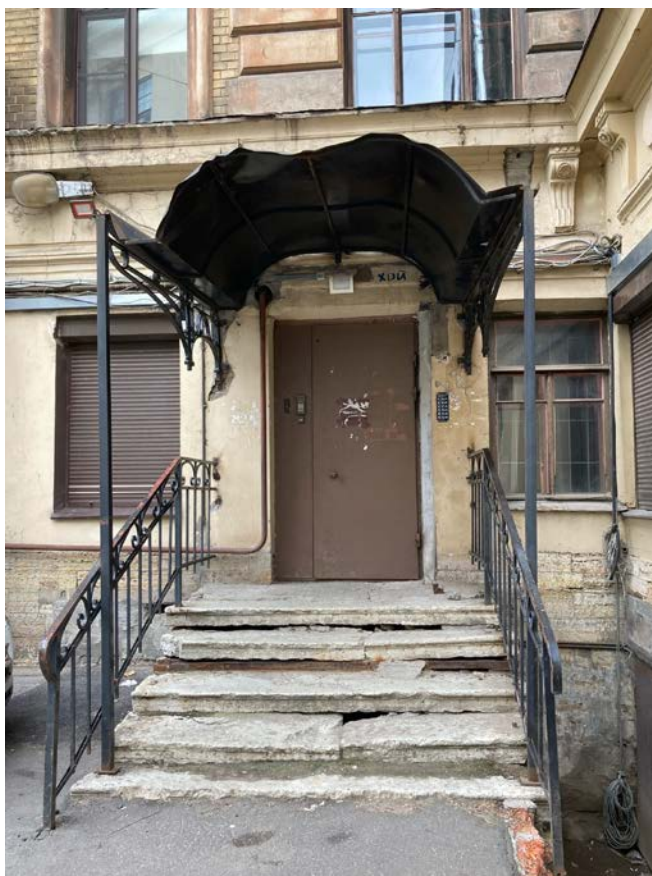
Фото 7. Фрагмент лицевого фасада объекта культурного наследия регионального значения «Дом Единоверческой церкви Св. Николая», вход в подъезд №7
