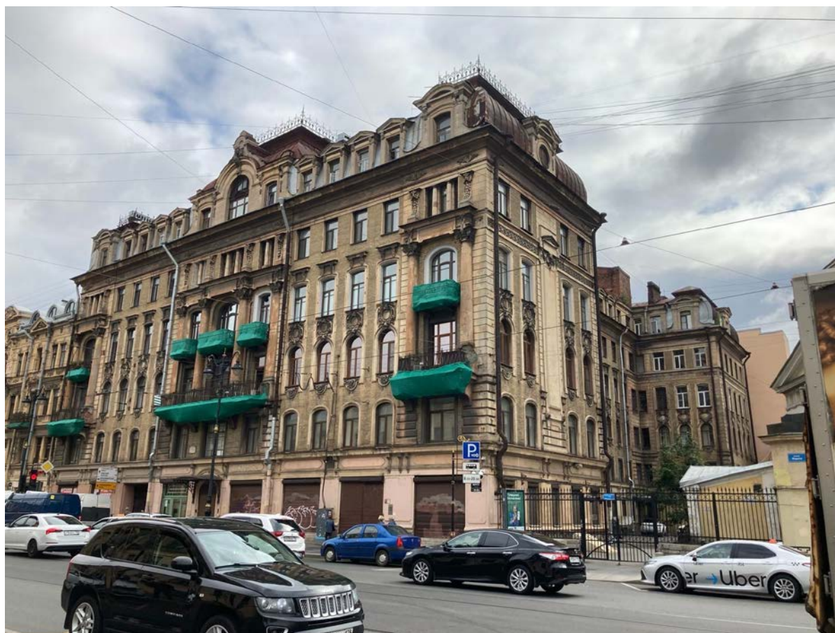
Фото 1. Лицевой фасад объекта культурного наследия регионального значения «Дом Единоверческой церкви Св. Николая».
