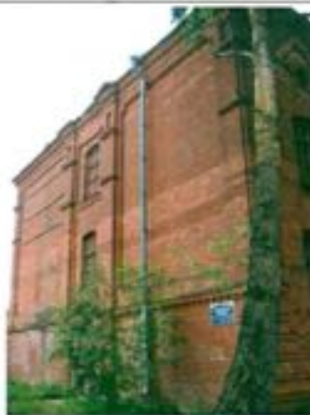
Фото 6. Южный фасад. Общий вид.
