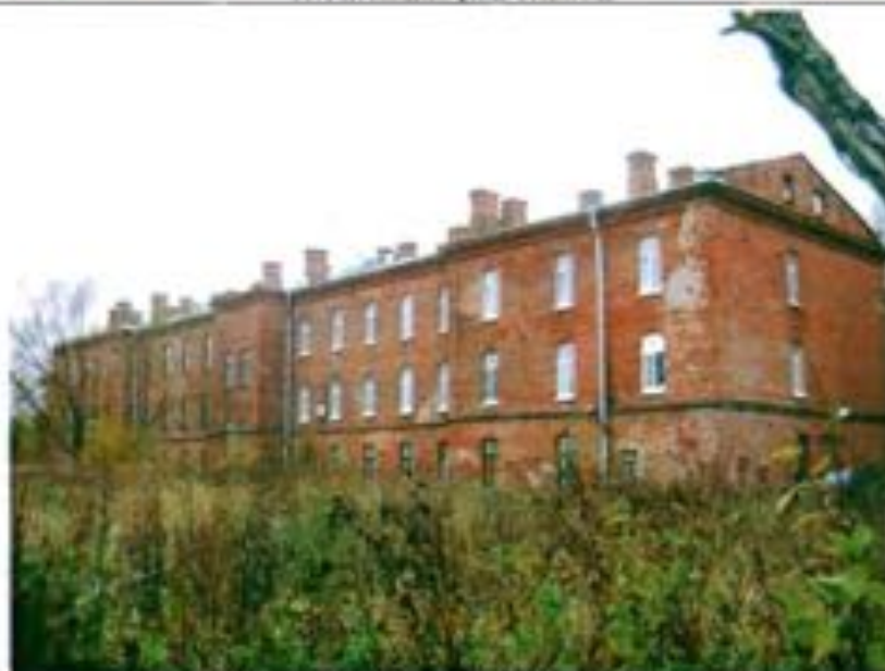
Фото 14. Восточный фасад. Общий вид.
