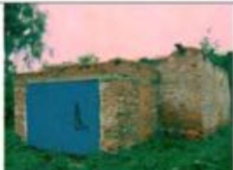
Фото 185. Восточный фасад. Общий вид.
