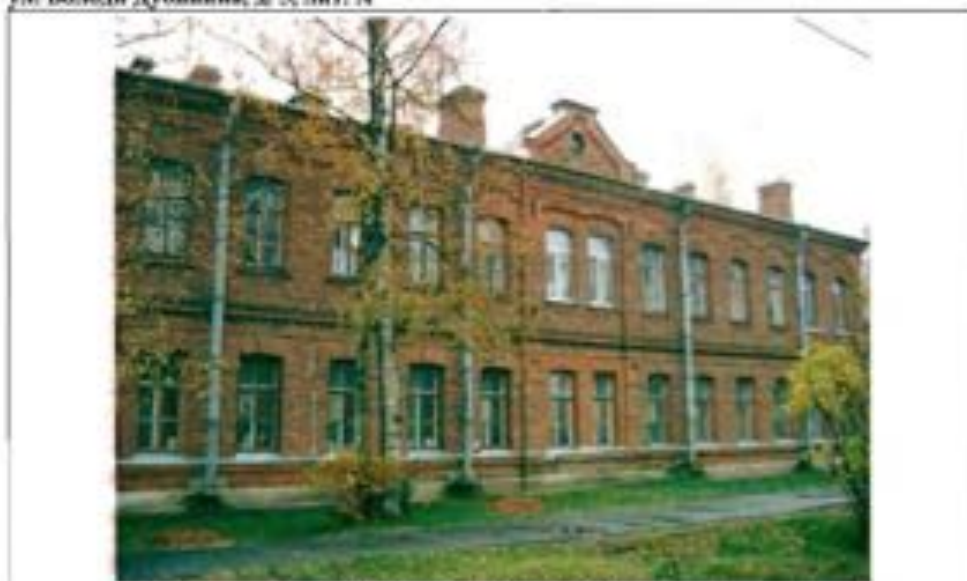
Фото 157. Западный фасад. Общий вид.
