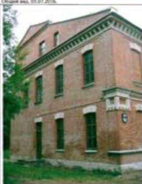
Фото 48. Восточный фасад. Общий вид.
