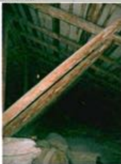
Фото 27. Конструкция крыши. Фрагмент.
