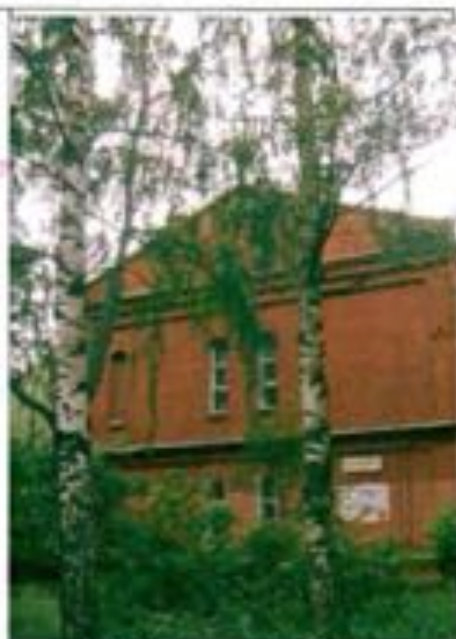
Фото 91. Западный фасад. Общий вид.
