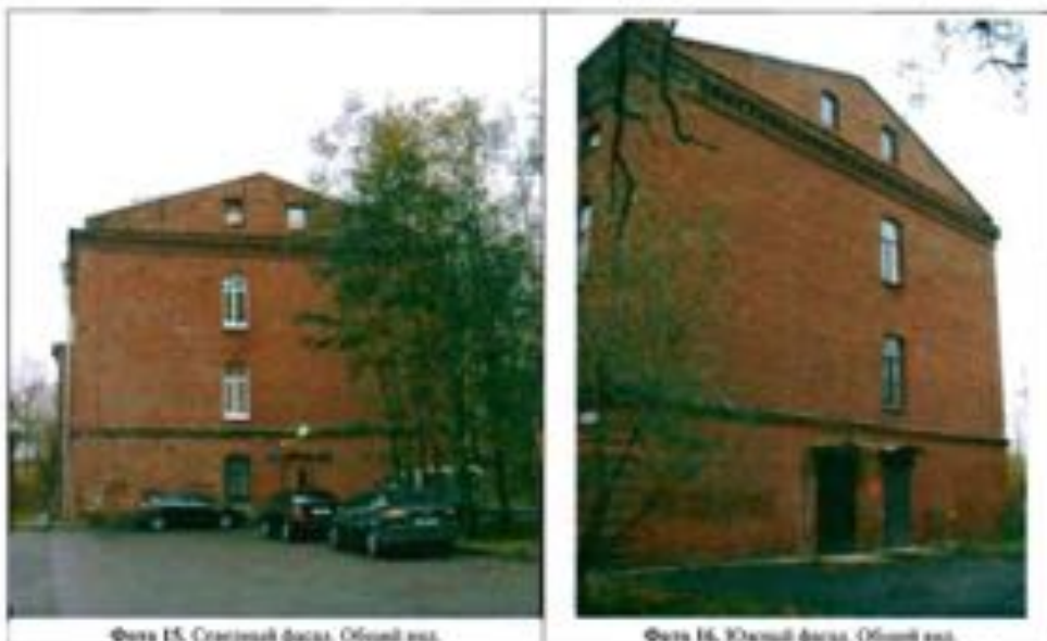
Фото 15. Сторонний фасад. Общий вид.
