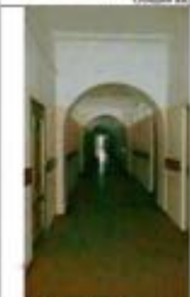
Фото 53. Лаборатор. Коридор в уровне 2-го этажа. Общий вид.
