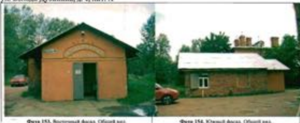
Фото 153. Восточный фасад. Общий вид.
