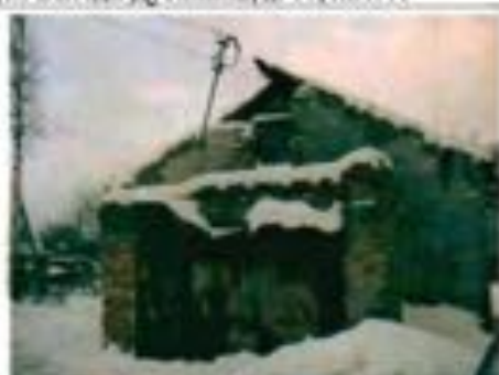
Фото 184. Восточный фасад. Общий вид. 14.01.2015.
