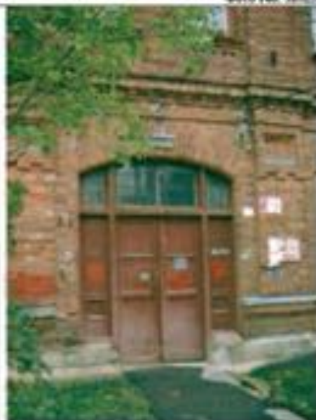
Фото 147. Дверной проем западного фасада. Общий вид.
