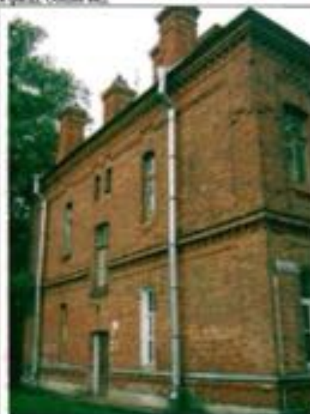
Фото 148. Северный фасад. Общий вид.
