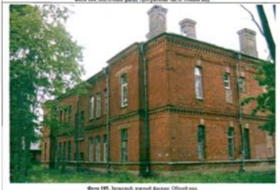
Фото 185. Угловой, южный фасад. Общий вид.
