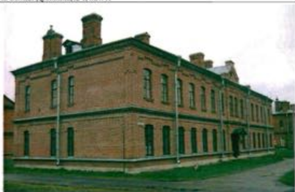
Фото 132. Западной северной фасады. Общий вид.
