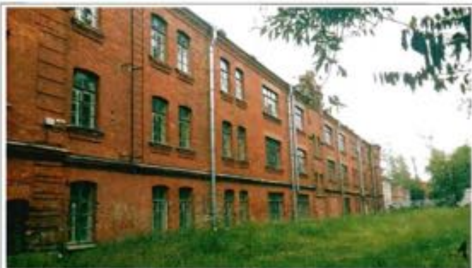
Фото 48. Западный фасад, Общий вид.
