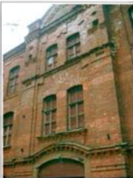
Фото 3. Западный фасад. Фрагмент центральной части фасада.
