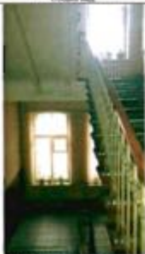
Фото 35. Интерьер. Лестница. Общий вид.
