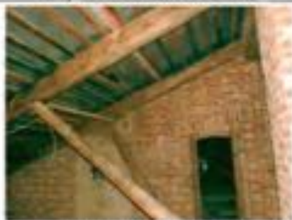
Фото 127. Конструкция крыши. Общий вид.
