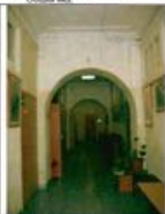
Фото 55. Лаборатор. Коридор в уровне 1-го этажа. Общий вид.
