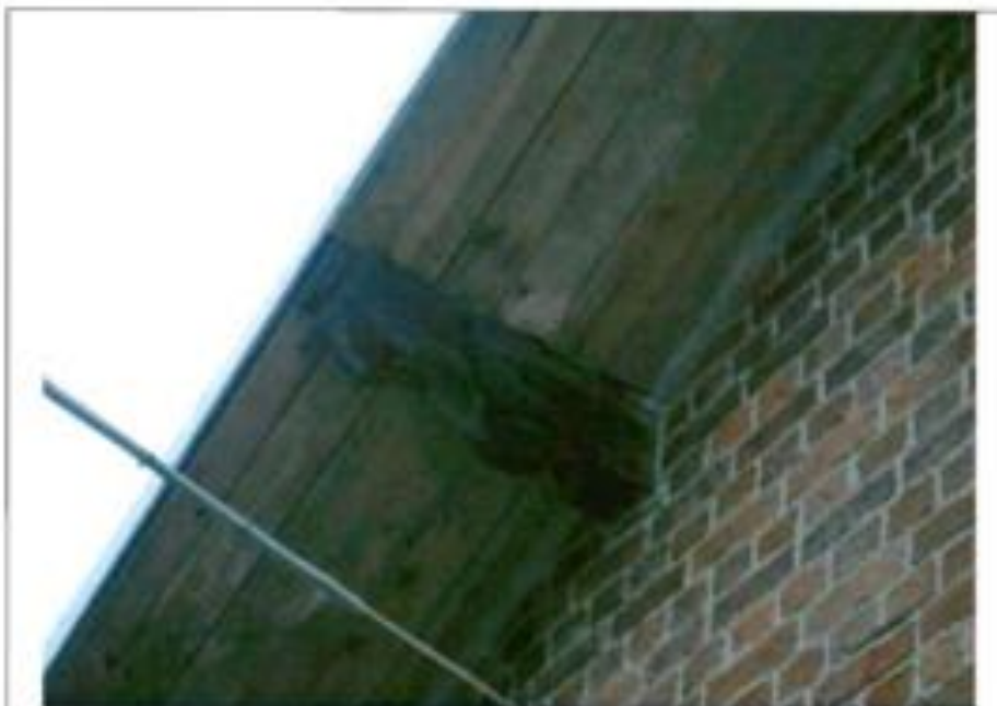
Деревянные кобылки. Съемка 20.11.2012, Воронцов Н.В.
