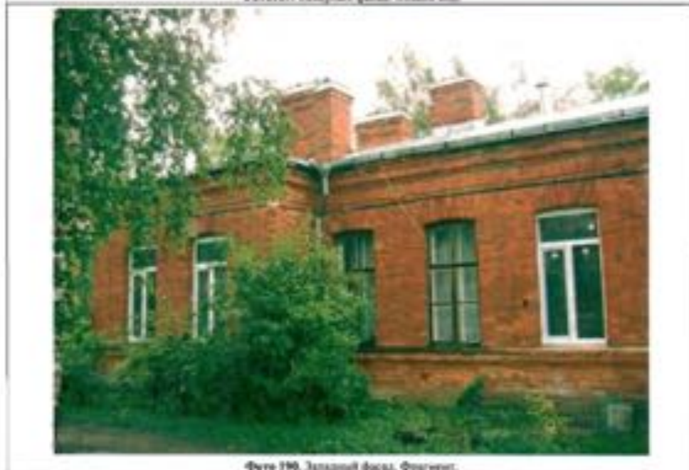
Фоты 190. Западный фасад. Фрагмент.
