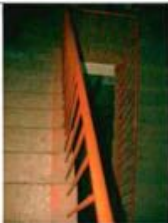
Фото 149. Лестница № 1 в северной части здания. Общий вид.
