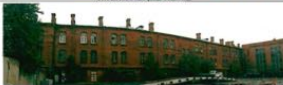
Фото 29. Западный фасад. Общий вид.
