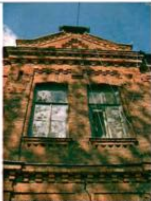
Фото 177. Восточный фасад. Центральная часть. Фрагмент.
