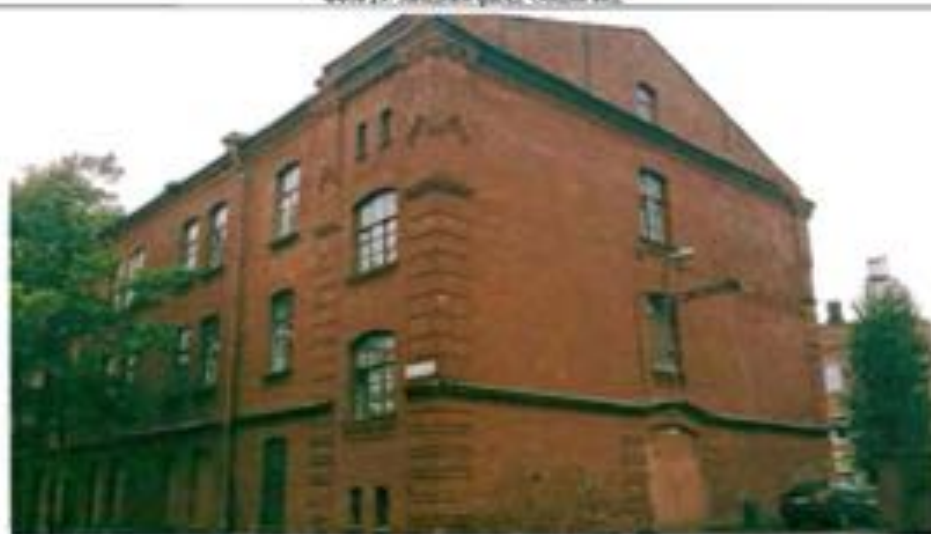
Фото 30. Северный фасад. Общий вид.
