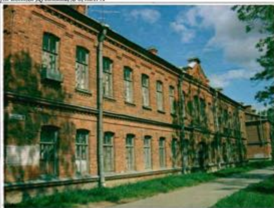
Фото 176. Восточный фасад. Общий вид.
