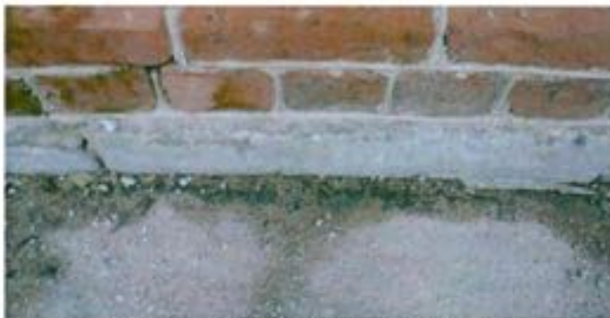
Цоколь, облицованный известняковой шубой. Съемка 20.11.2012, Воронин Н.В.
