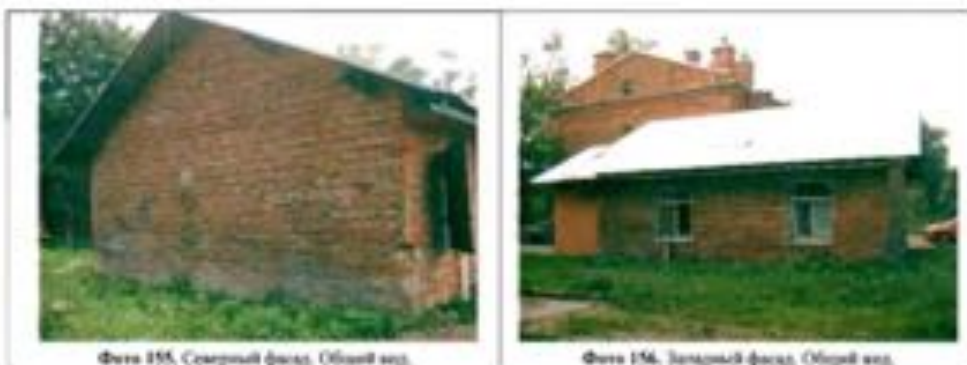
Фото 155. Северный фасад. Общий вид.
