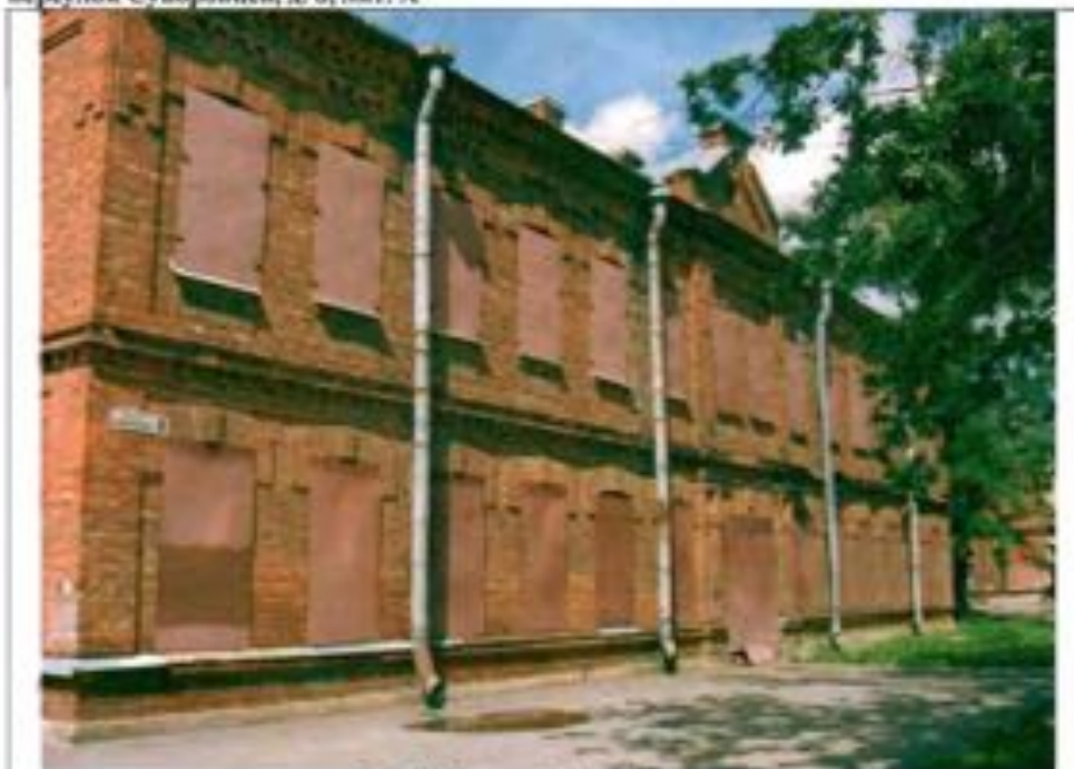
Фото 116. Восточный фасад. Общий вид.
