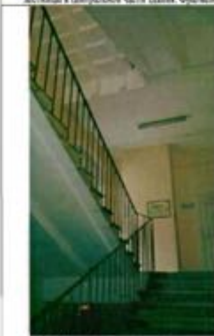
Фото 60. Интерьер. Лестница в южной части здания. Фрагмент.
