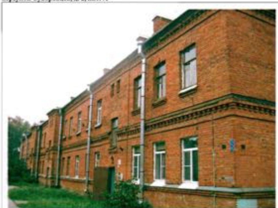
Фото 83. Северный фасад. Общий вид.
