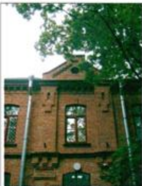
Фото 40. Восточный фасад. Фрагмент центральной части фасада.
