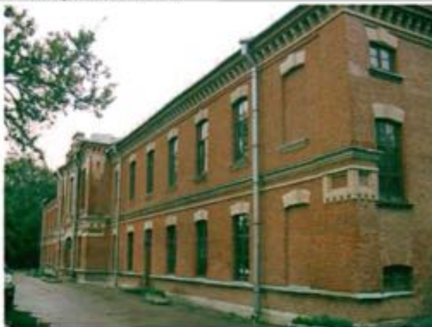
Фото 64. Створный фасад. Общий вид.
