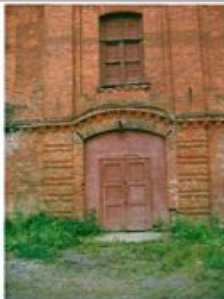
Фото 4. Западный фасад. Фрагмент центральной части фасада.
