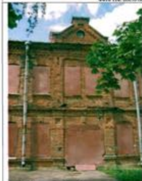
Фото 117. Восточный фасад. Фрагмент центральной части фасада.
