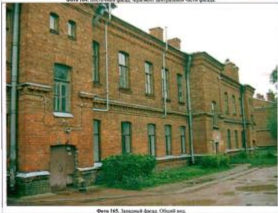
Фото 165. Западный фасад. Общий вид.
