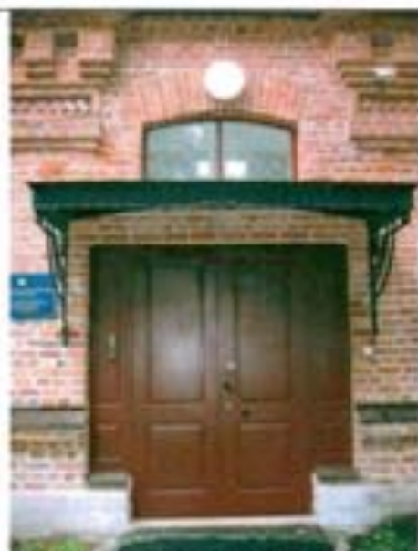
Фото 41. Деревянный проем восточного фасада. Общий вид.
