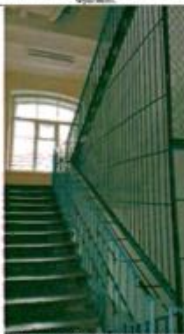
Фото 61. Интерьер. Лестница в южной части здания. Фрагмент.
