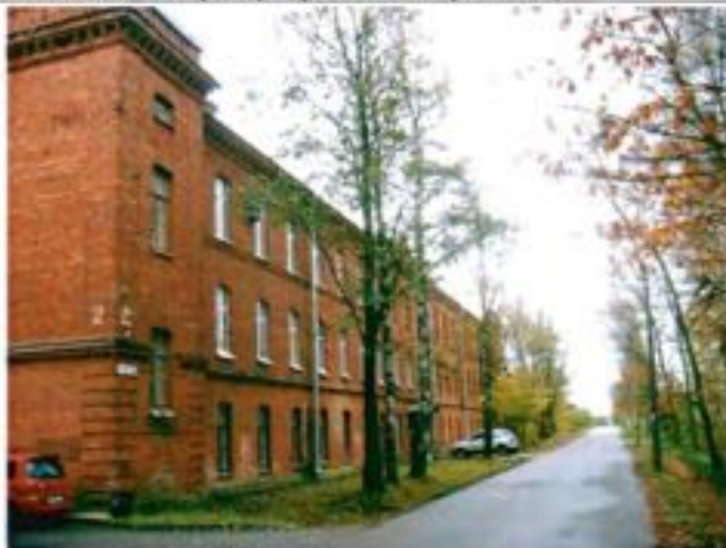
Фото 13. Южный фасад. Общий вид.
