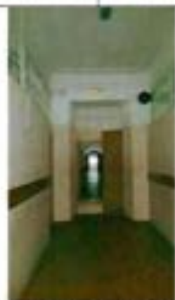
Фото 54. Лаборатор. Коридор в уровне 2-го этажа. Общий вид.
