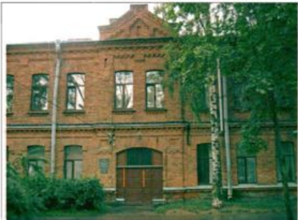
Фото 164. Восточный фасад. Фрагмент центральной части фасада.
