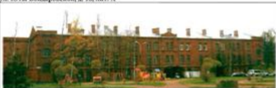
Фото 28. Восточный фасад. Общий вид.
