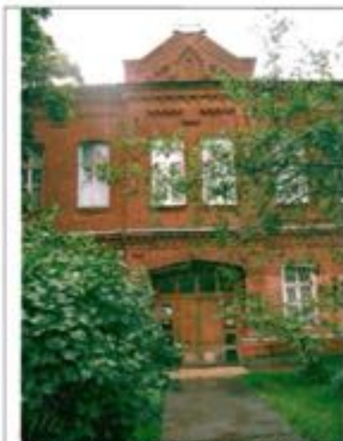
Фото 90. Восточный фасад. Центральная часть. Общий вид.
