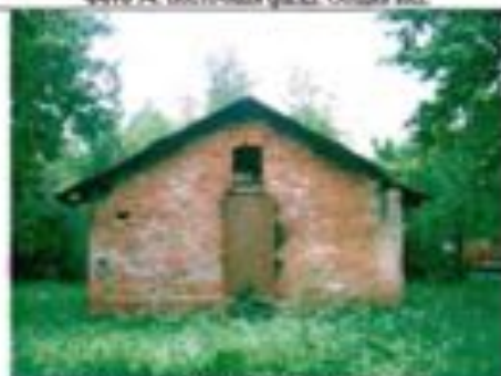
Фото 96. Западный фасад. Общий вид.
