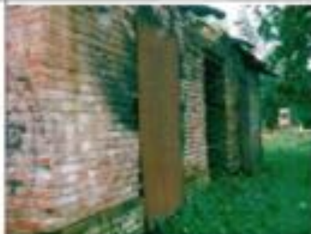
Фото 95. Восточный фасад. Общий вид.
