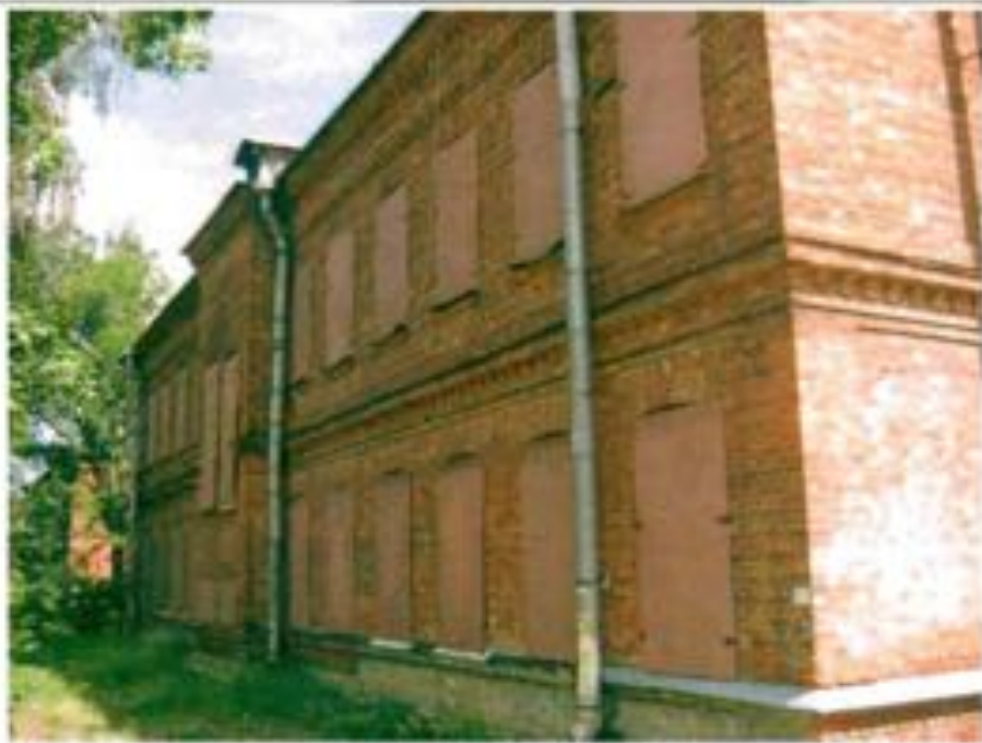
Фото 119. Западный фасад. Общий вид.
