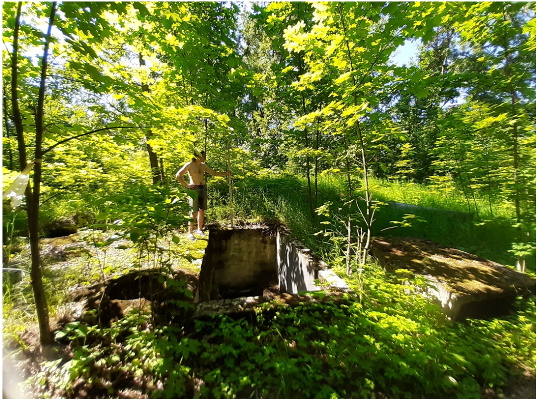
Рис. 23. Санкт-Петербург, «Строительство многоквартирного дома со встроенно-пристроенным подземным паркингом по адресу: СПб, Сестрорецк, ул. Воскова, д.2 литера Д» (кадастровый номер: 78:38:1111101:13)». Общий вид участка. Точка съемки 6. Вид на запад.
