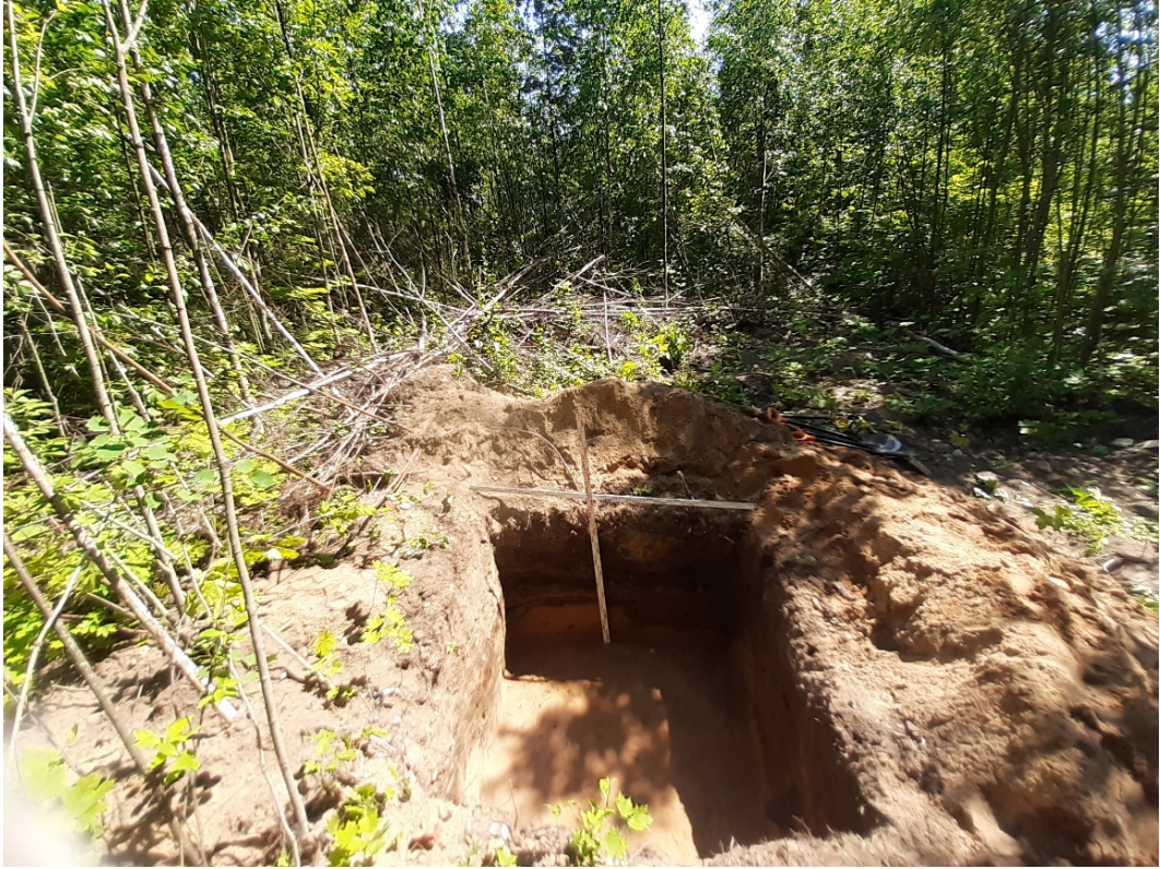
Рис. 41. Санкт-Петербург, «Строительство многоквартирного дома со встроенно-пристроенным подземным паркингом по адресу: СПб, Сестрорецк, ул. Воскова, д.2 литера Д» (кадастровый номер: 78:38:1111101:13)». Шурф 1. Общий вид на восток.
