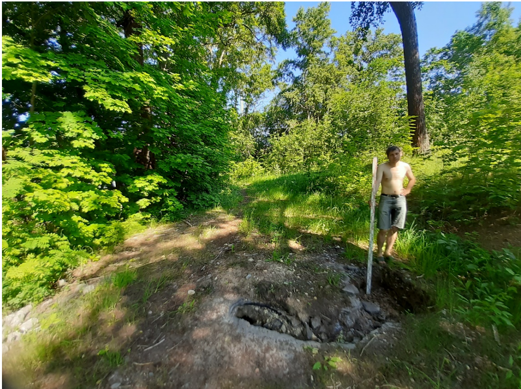
Рис. 19. Санкт-Петербург, «Строительство многоквартирного дома со встроенно-пристроенным подземным паркингом по адресу: СПб, Сестрорецк, ул. Воскова, д.2 литера Д» (кадастровый номер: 78:38:1111101:13)». Общий вид участка. Точка съемки.2. Вид на север.
