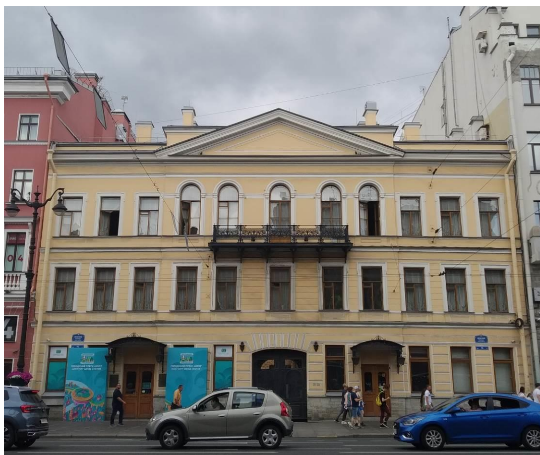
4. Дом Сухозанета И.О. Лицевой фасад. Штиглиц М.С. 18.06.2021.
