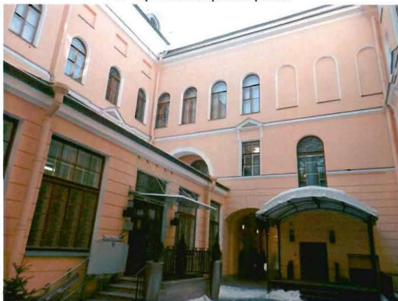
3. Фрагмент дворового фасада
