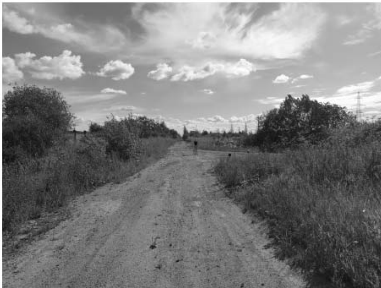
Точка фотофиксации 3. Западный участок магистрали № 1, вид на существующую дорогу с ССВ.
