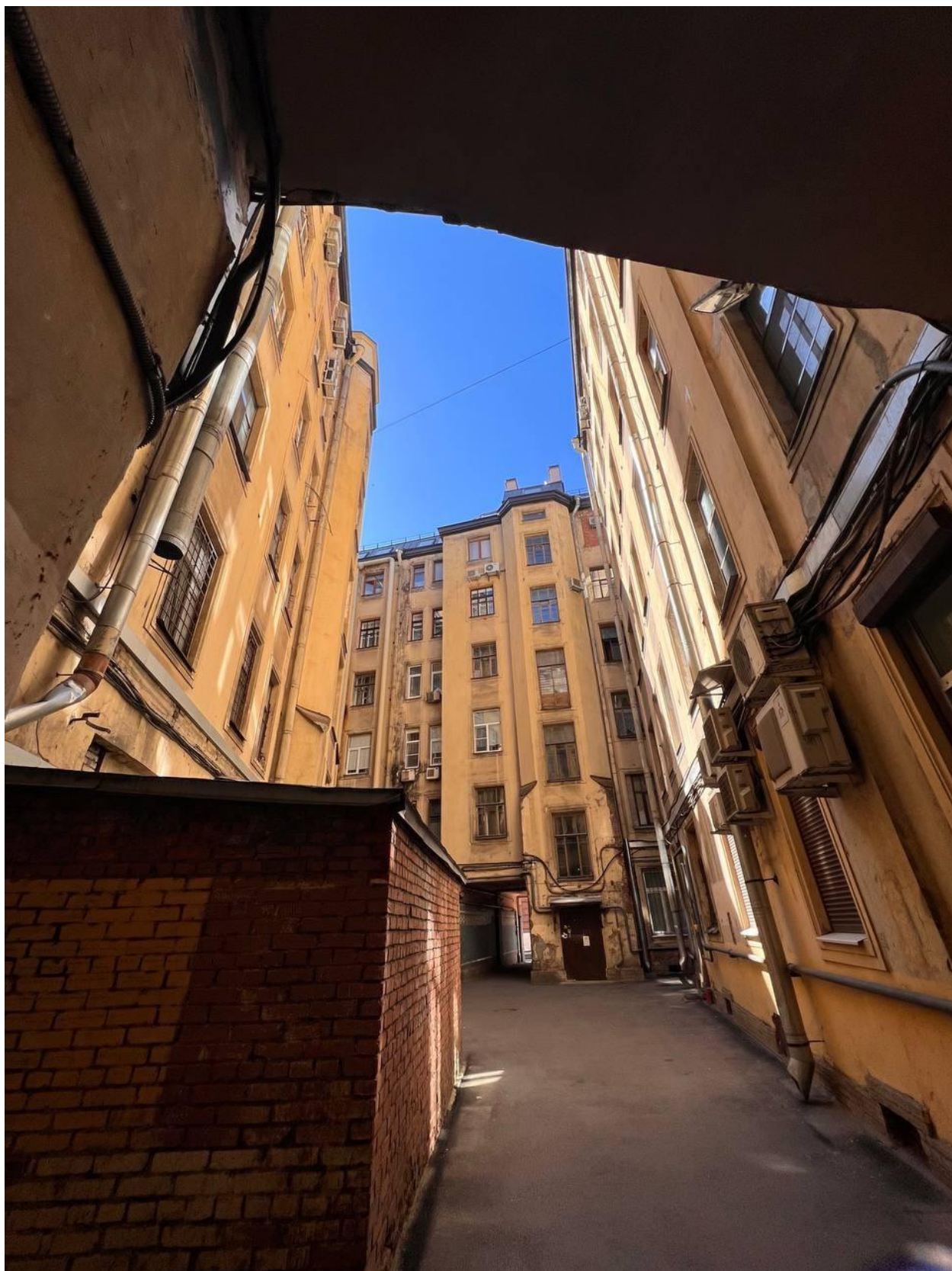
Фото 4. Вид на внутренний северный дворовый фасад.
