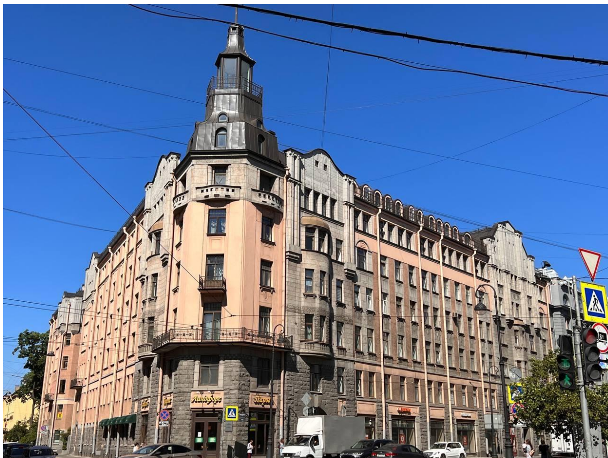
Фото 1. Вид на угловую часть объекта с юго-востока.
