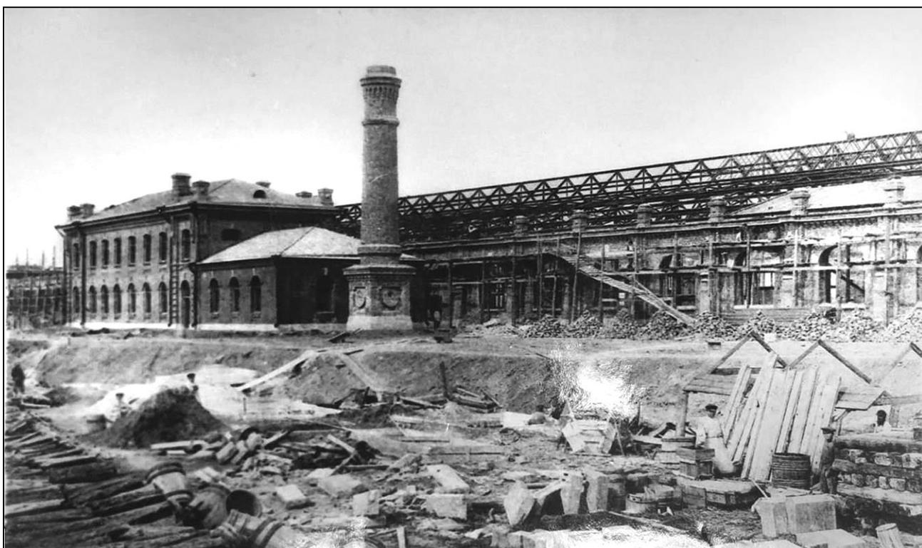
Илл. 17. «Общий вид сарая для Императорских поездов и пристройки к нему. Приготовление цементно-бетонных облицовочных камней». 1897 – 1898 гг.
