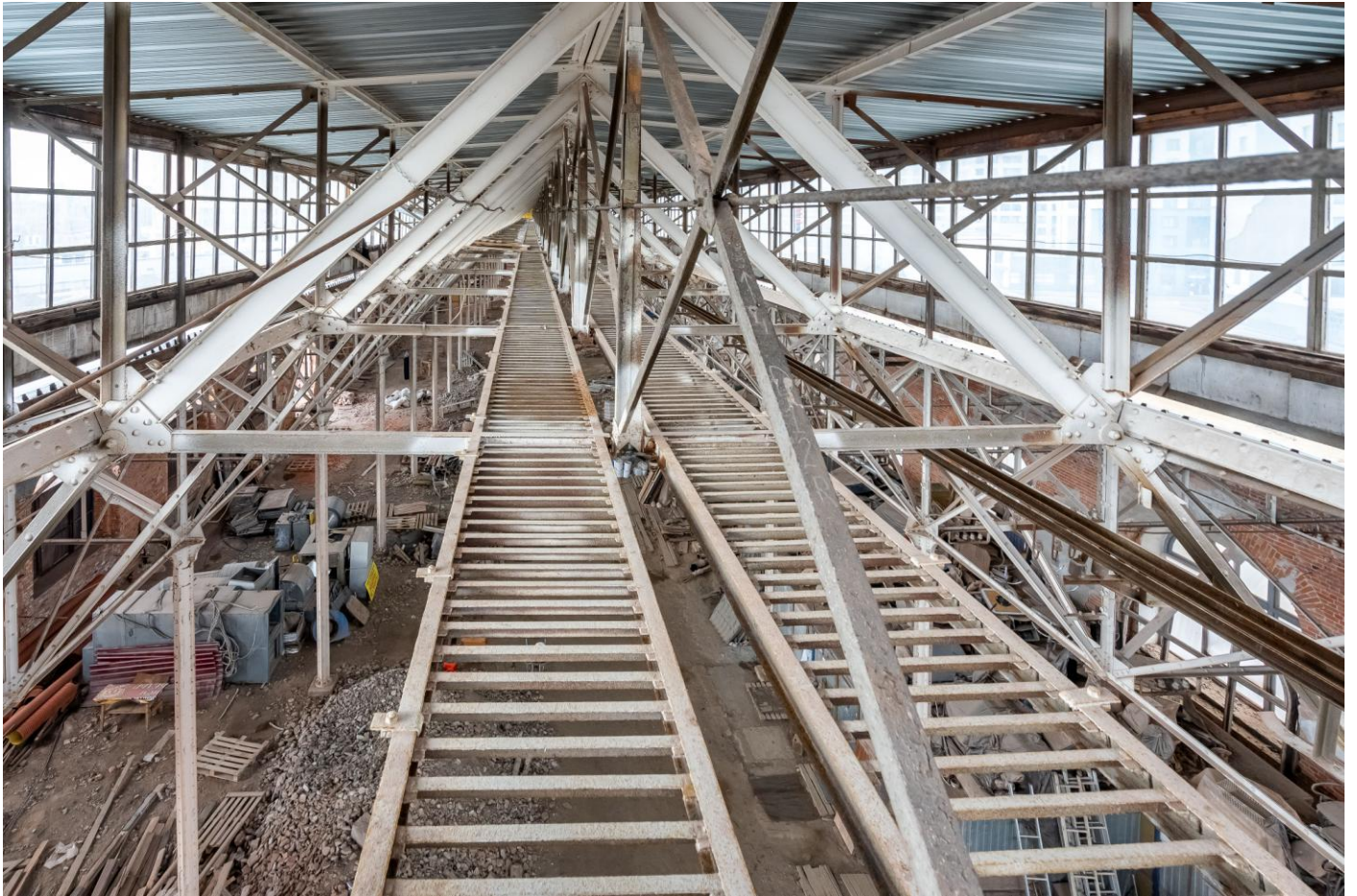
11. Конструкции фонаря верхнего освещения.
