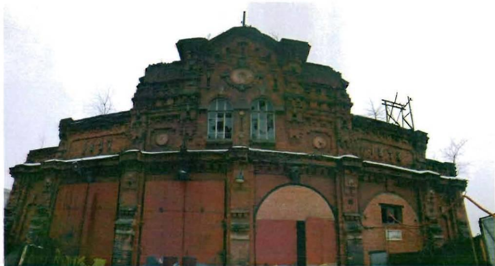
2. Северо-западный торцевой фасад.
