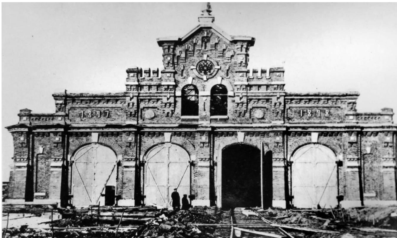
Илл. 16. «Главный фасад сарая для Императорских поездов. Укладка рельсовых путей». 1897-1898 гг. Акт по результатам государственной историко-культурной экспертизы... 2013 г. Приложение № 2, илл. 33.
