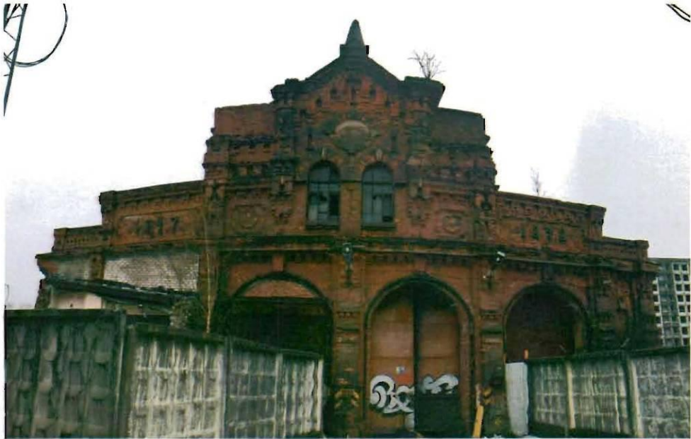
1. Юго-восточный торцевой фасад.
