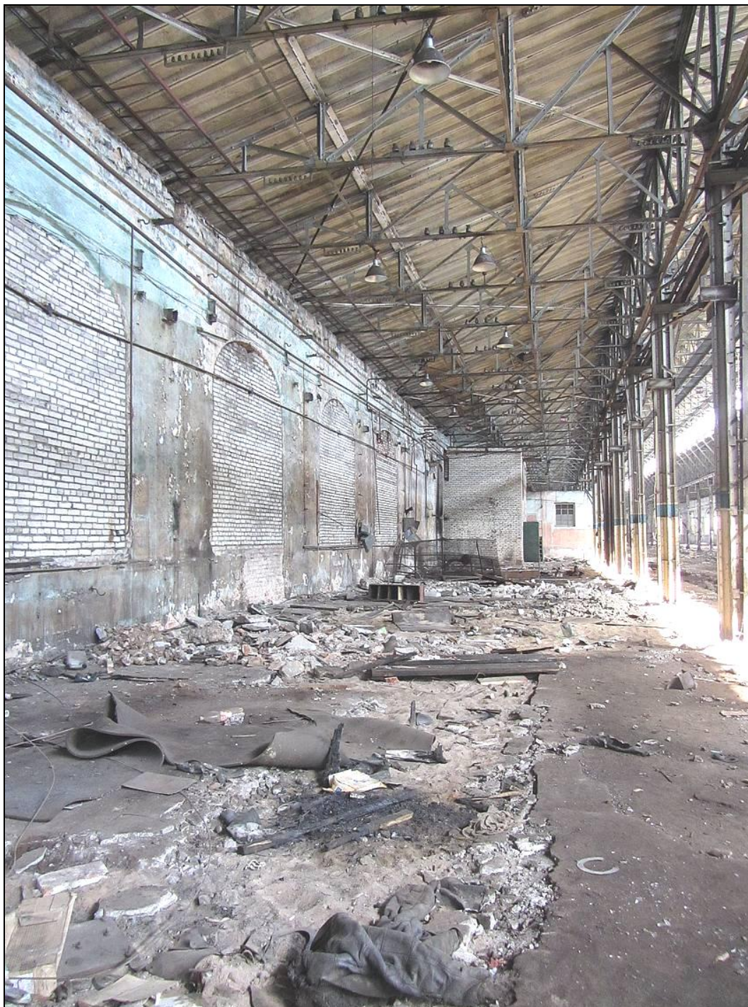
Илл. 36. Внутренне пространство здания. Вид на наружную юго-западную стену. Фото 2014 г.
