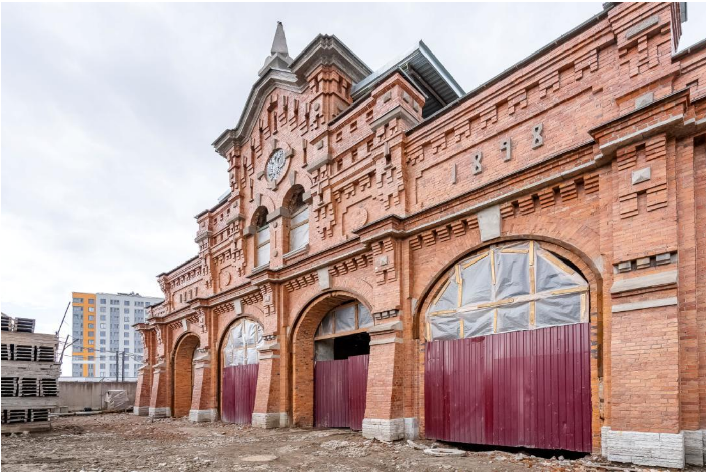
2. Торцевой (юго-восточный) фасад-портал. Общий вид.
